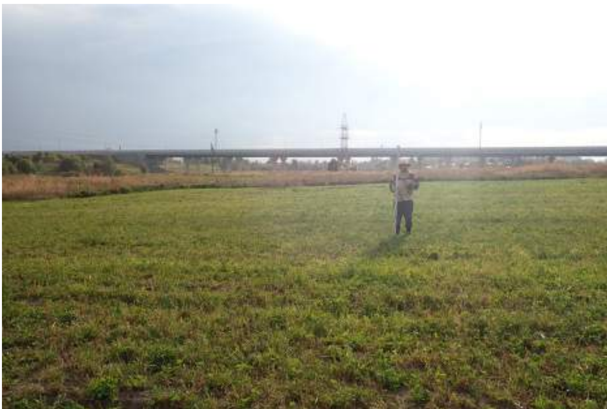
Рис. 32. Ленинградская область. Тосненский район. Тельмановское сельское поселение. Точка фотофиксации 2. Общий вид трассы газопровода на участке левого берега р. Славянки. Вид с СВ.
