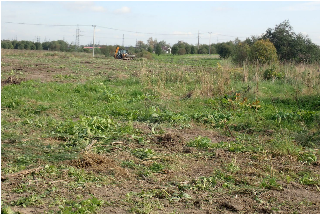
Рис. 15. Ленинградская область. Всеволожский район. Участок к\н 47:07:1044001:82046. Работа землеройной техники на участке.. Вид с СЗ.
