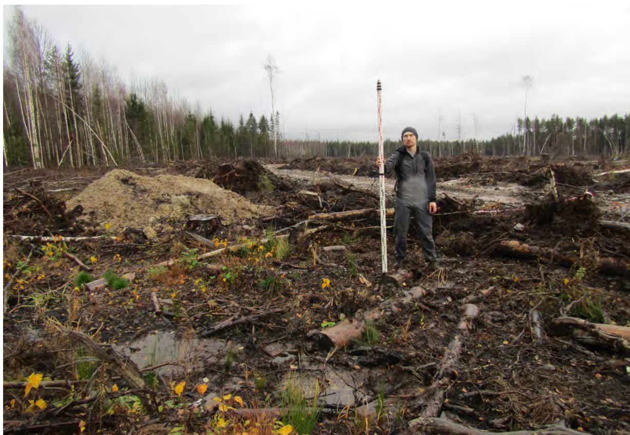
Рисунок 59. «Строительство многоэтажных жилых домов со встроенно-пристроенными помещениями и дошкольной образовательной организации на 235 мест в городе Мурино». Точка фотофиксации № 12. Вид с запада.
