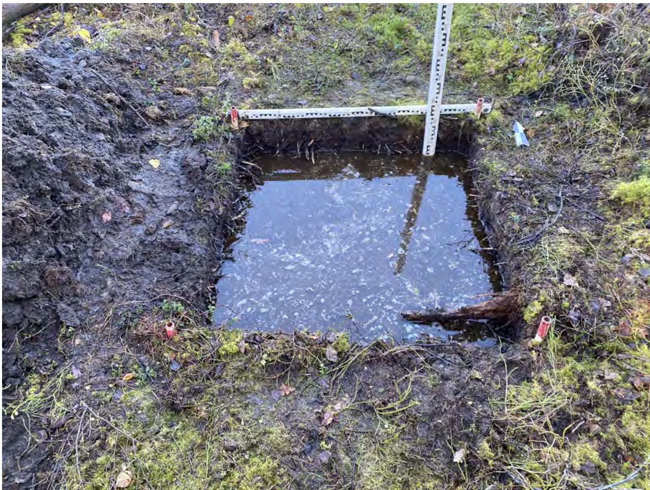
Рисунок 112. «Строительство многоэтажных жилых домов со встроенно-пристроенными помещениями и дошкольной образовательной организации на 235 мест в городе Мурино». Шурф № 5. Вид на северную стенку и дно шурфа. Вид с юга.
