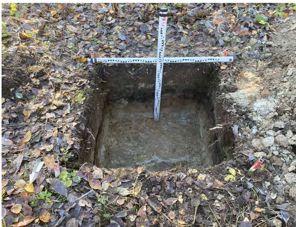
Рисунок 133. «Строительство многоэтажных жилых домов со встроенно-пристроенными помещениями и дошкольной образовательной организации на 235 мест в городе Мурино». Шурф № 7. Вид на южную стенку и дно шурфа. Вид с севера.
