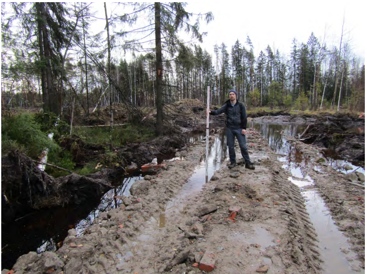
Рисунок 51. «Строительство многоэтажных жилых домов со встроенно-пристроенными помещениями и дошкольной образовательной организации на 235 мест в городе Мурино». Точка фотофиксации № 10. Вид с запада.
