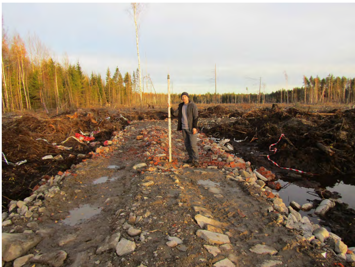
Рисунок 27. «Строительство многоэтажных жилых домов со встроенно-пристроенными помещениями и дошкольной образовательной организации на 235 мест в городе Мурино». Точка фотофиксации № 4. Вид с запада.
