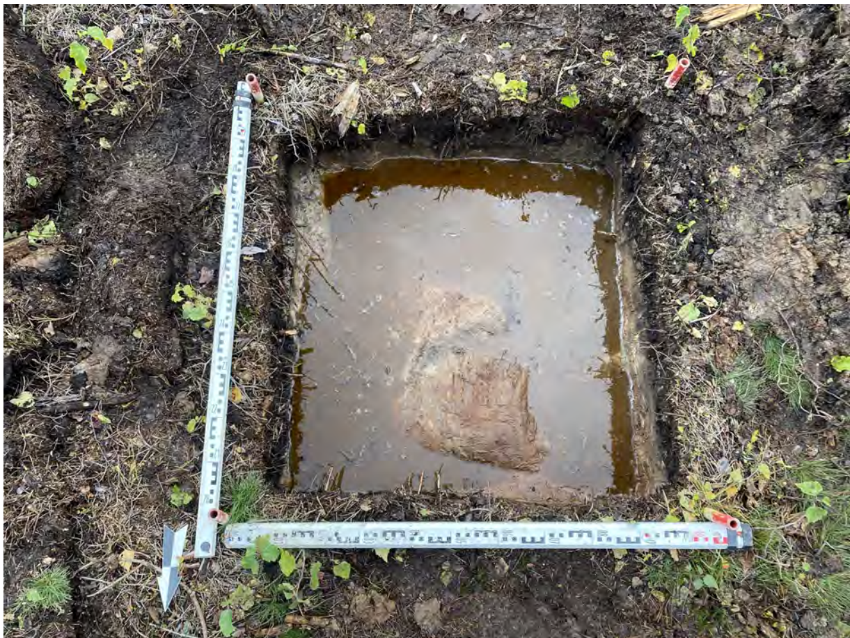
Рисунок 82. «Строительство многоэтажных жилых домов со встроенно-пристроенными помещениями и дошкольной образовательной организации на 235 мест в городе Мурино». Шурф № 2. Вид на раскопанный шурф. Вид с севера.
