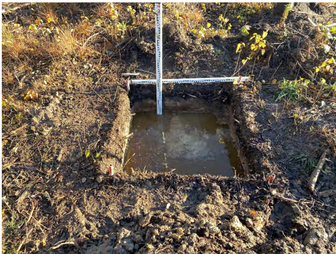
Рисунок 101. «Строительство многоэтажных жилых домов со встроенно-пристроенными помещениями и дошкольной образовательной организации на 235 мест в городе Мурино». Шурф № 4. Вид на восточную стенку и дно шурфа. Вид с запада.
