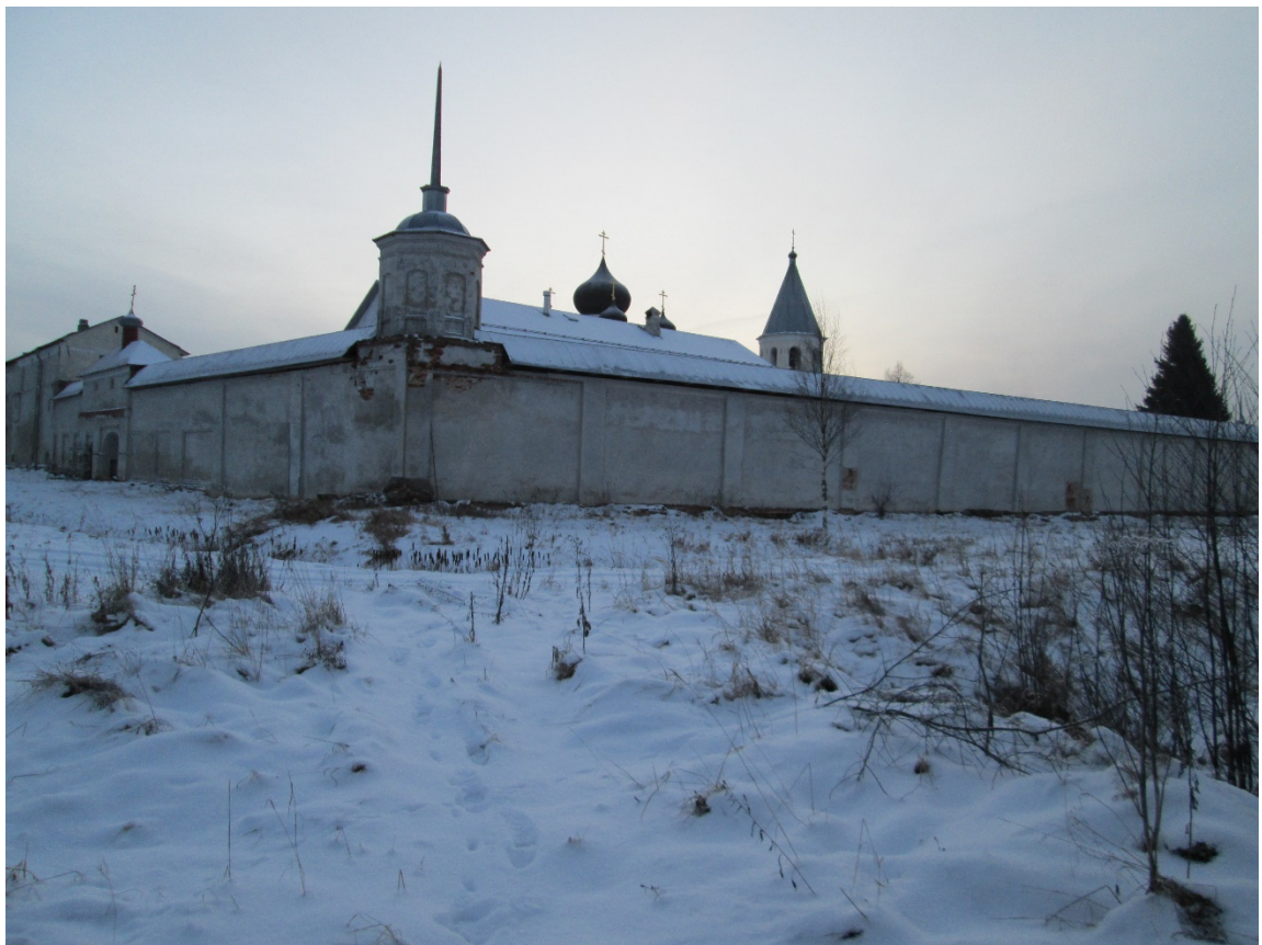
Фото 12. Точка фотофиксации Ф4. Вид с северо-запада на трассу проектируемого газопровода, защитную зону и территорию ОКН, северо-западный угол монастыря.
