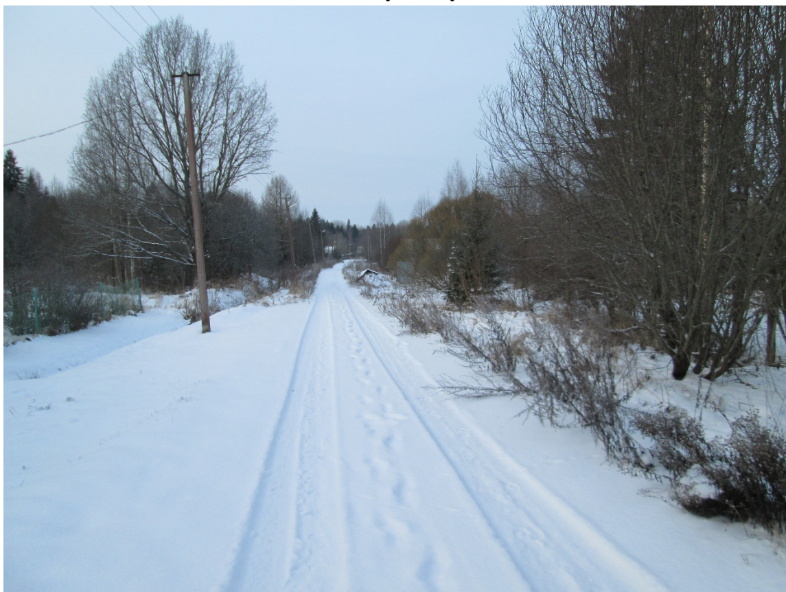
Фото 30. Точка фотофиксации Ф11. Вид с северо-востока на трассу проектируемого газопровода.
