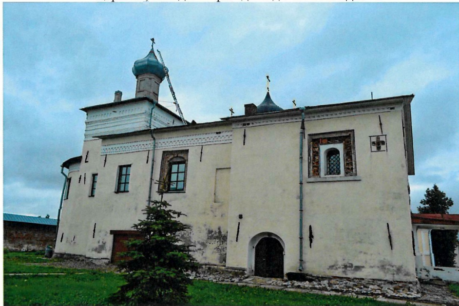
Фото 12. Ленинградская область, Волховский район, пос.Зеленец д.27а. Благовещенская церковь, северный фасад. Вид с юго-запада.
