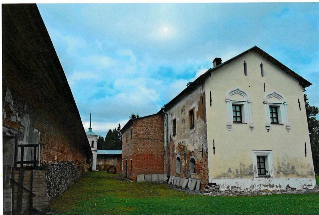
Фото 17. Ленинградская область, Волховский район, пос.Зеленец д.27а. Южная келья. Южный и восточный фасады. Вид с юго-востока.
