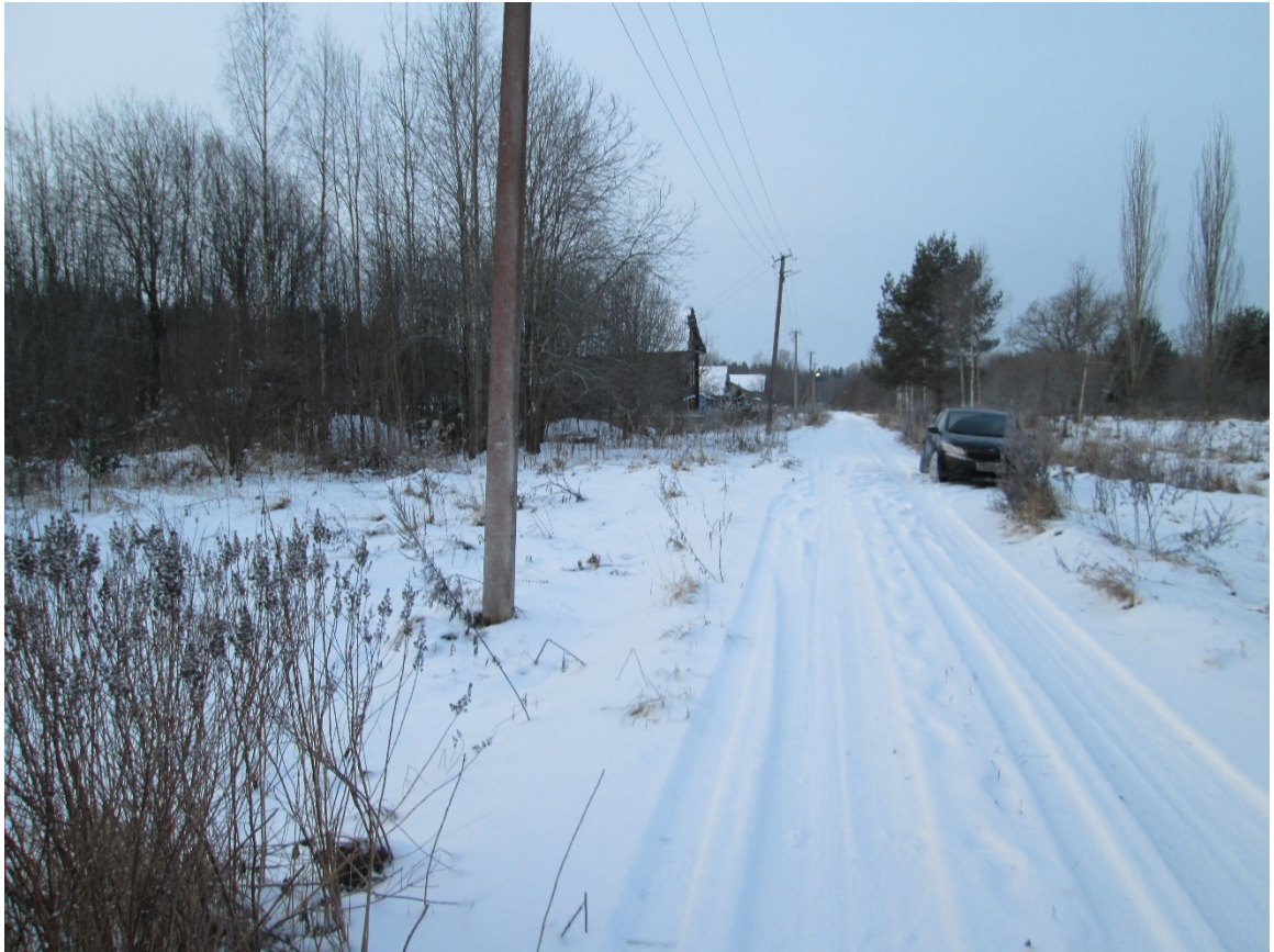
Фото 19. Точка фотофиксации Ф7. Вид с северо-востока на трассу проектируемого газопровода защитную зону и территорию ОКН.
