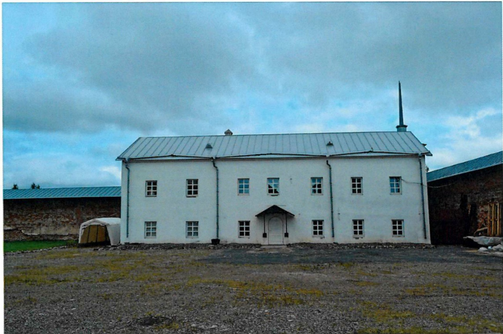
Фото 20. Ленинградская область, Волховский район, пос.Зеленец д.27а. Западная келья. Восточный фасад. Вид с востока.
