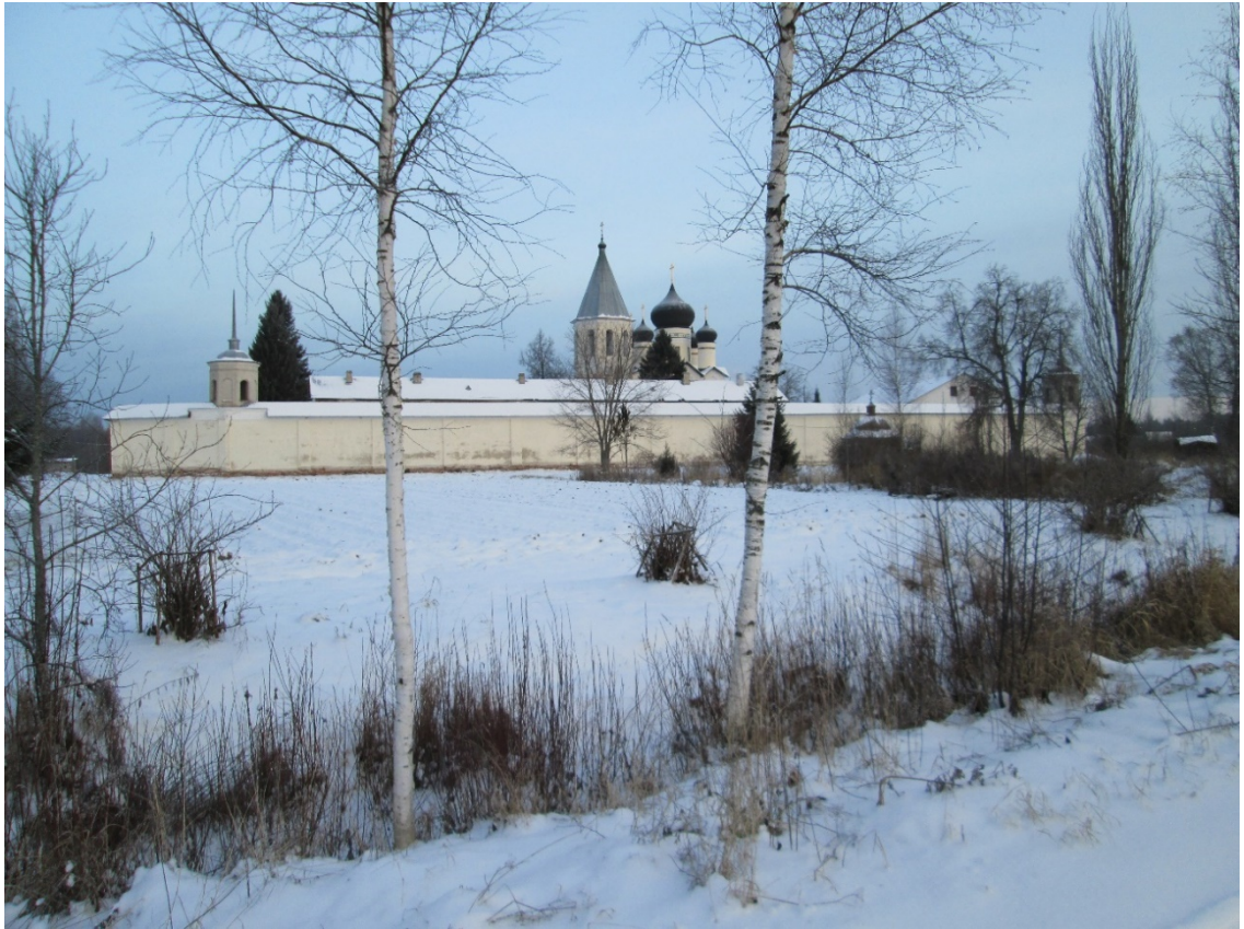
Фото 27. Точка фотофиксации Ф10. Вид с юго-запада на трассу проектируемого газопровода, защитную зону и территорию ОКН.
