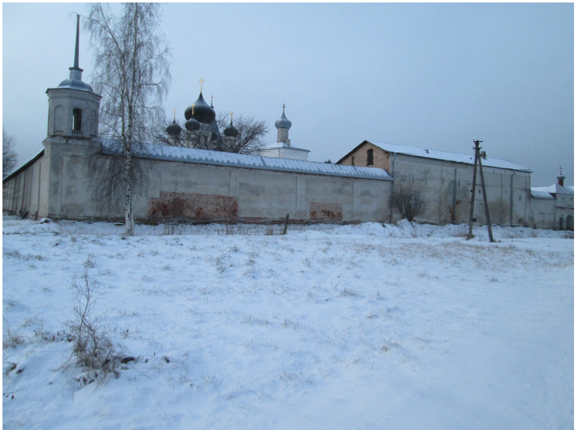
Фото 5. Точка фотофиксации Ф2. Вид с северо-востока на трассу проектируемого газопровода, защитную зону и территорию ОКН.
