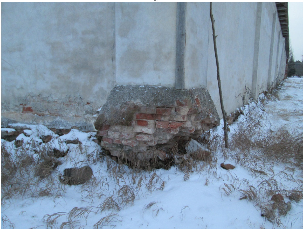
Фото 14. Точка фотофиксации Ф5. Северо-западный угол ограды монастыря. Вид с северо-запада.
