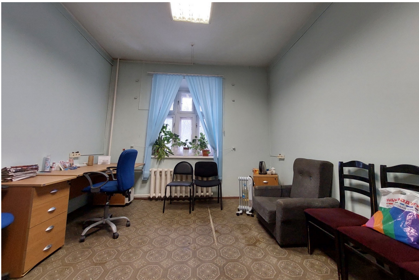
44 Выявленный ОКН «Здание Госбанка» г. Кингисепп, пр. Карла Маркса, д. 25/2 2 этаж. Помещение 81 (см. «Схема точки фотофиксации» на основе планов БТИ) Дата съемки: 10.01.2025 г.
