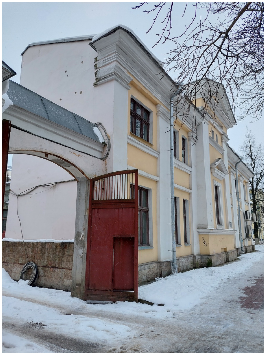
9 Выявленный ОКН «Здание Госбанка» г. Кингисепп, пр. Карла Маркса, д. 25/2 Северо-западный фасад рассматриваемого строения по ул. Воровского Дата съемки: 10.01.2025 г.
