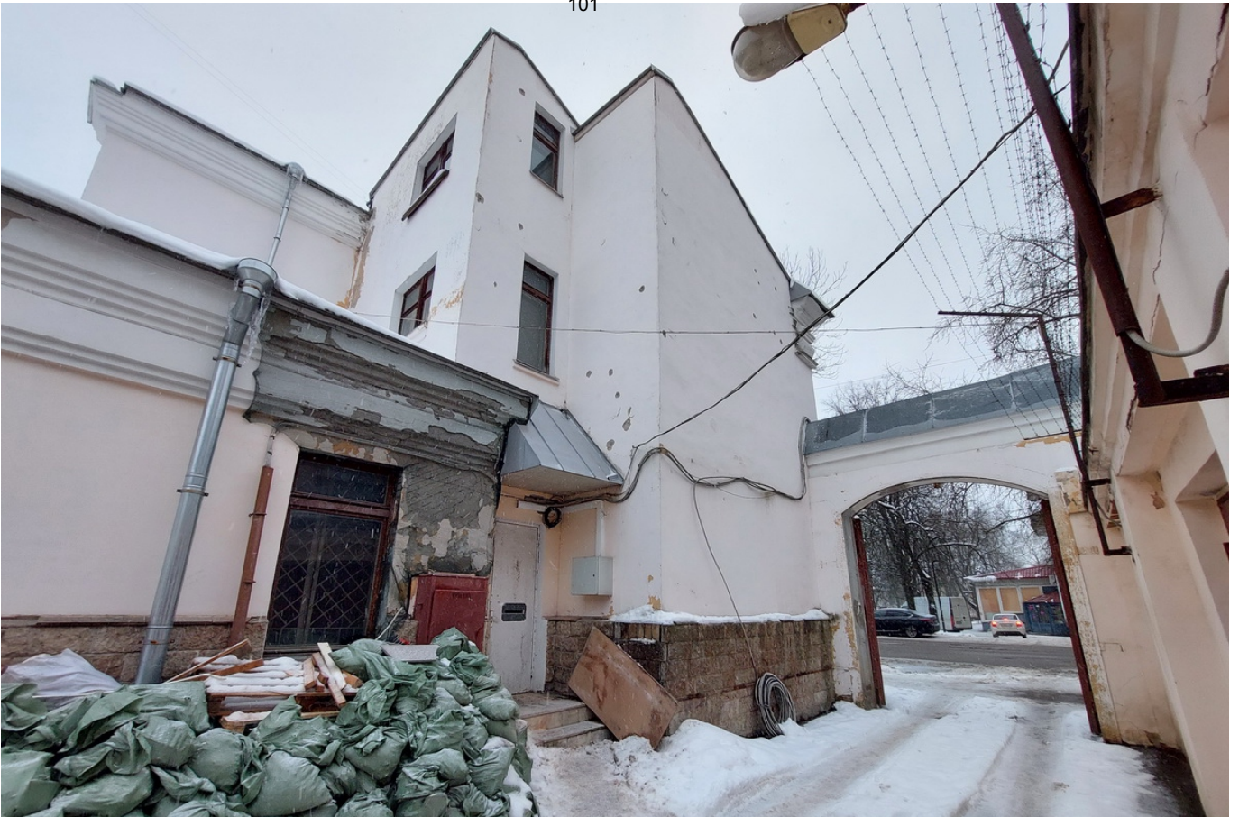
11 Выявленный ОКН «Здание Госбанка» г. Кингисепп, пр. Карла Маркса, д. 25/2 Северо-восточный дворовый фасад рассматриваемого строения Дата съемки: 10.01.2025 г.
