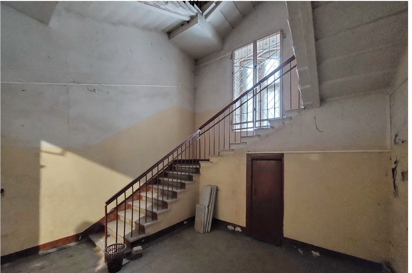
35 Выявленный ОКН «Здание Госбанка» г. Кингисепп, пр. Карла Маркса, д. 25/2 Помещение 8. Лестничная клетка. 1 этаж (см. «Схема точки фотофиксации» на основе планов БТИ) Дата съемки: 10.01.2025 г.
