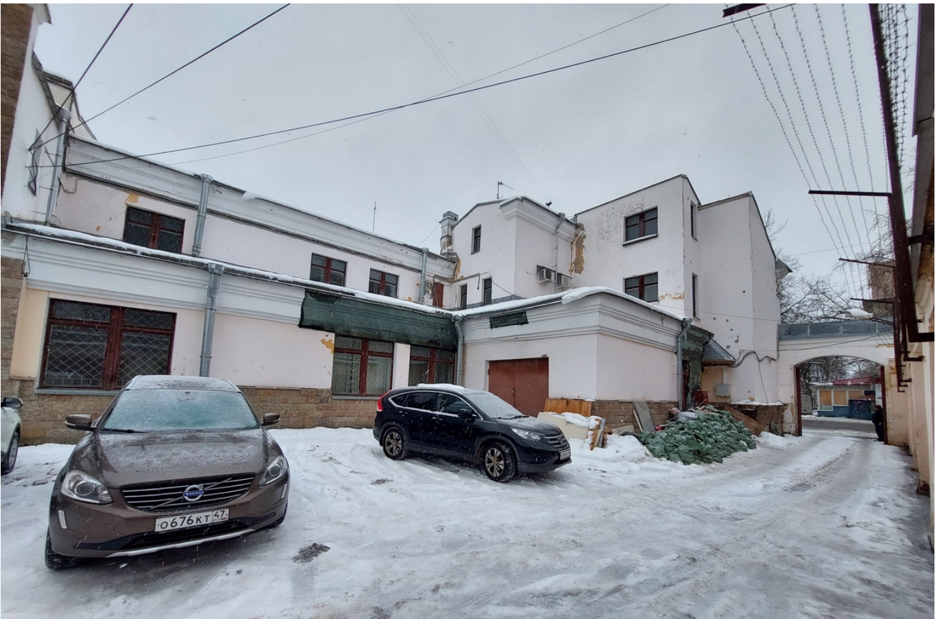
12 Выявленный ОКН «Здание Госбанка» г. Кингисепп, пр. Карла Маркса, д. 25/2 Северо-восточный дворовый фасад рассматриваемого строения Дата съемки: 10.01.2025 г.
