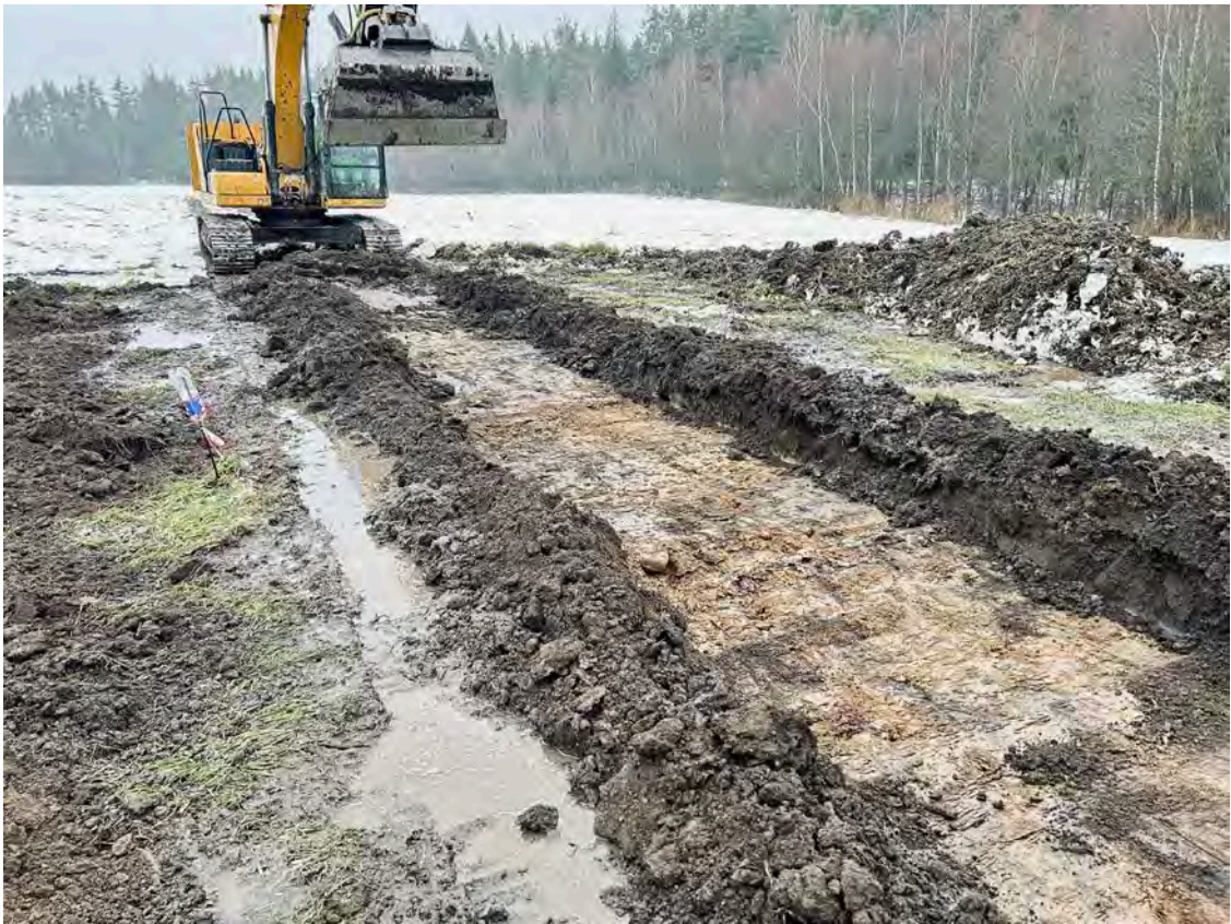
Рис. 16. Ленинградская область, Выборгский муниципальный район, Первомайское сельское поселение, уч. Сухочево. Точка фотофиксации 1 (ТФ1). Земляные работы вдоль восточной границы участка обследования. Вид с юга.
