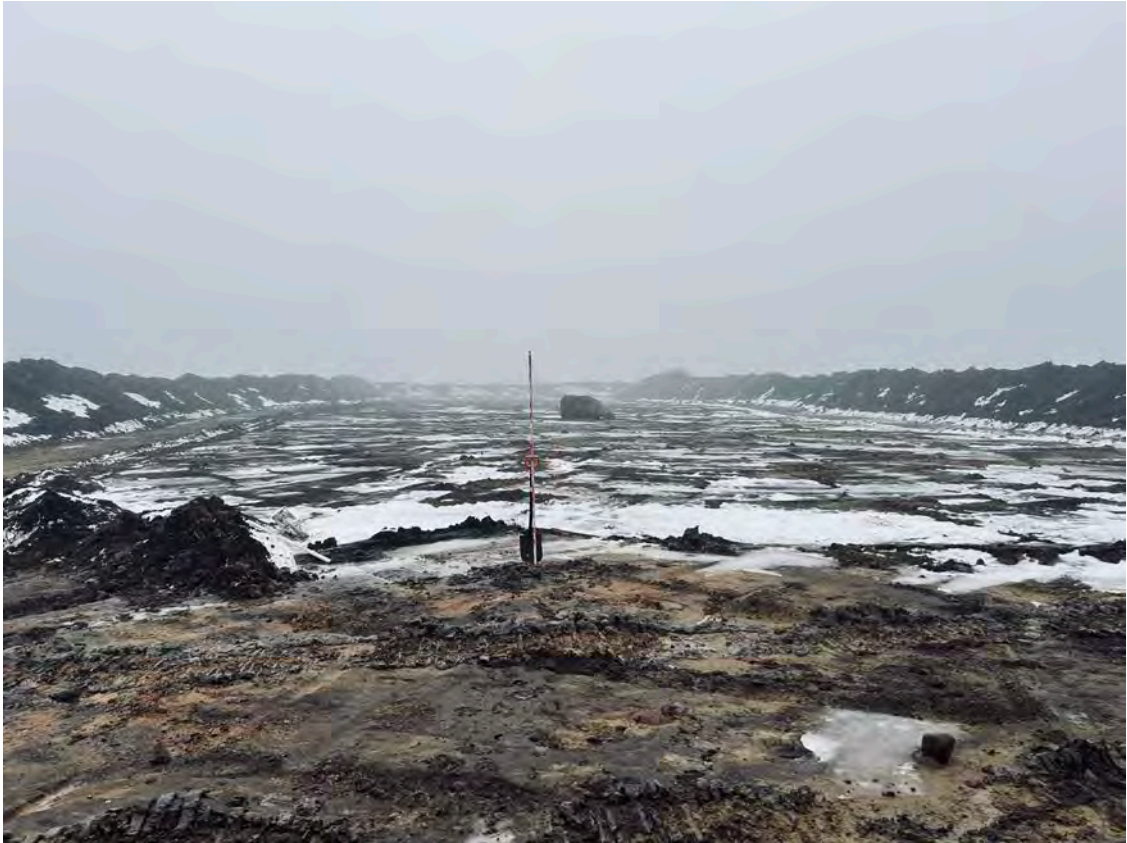
Рис. 44. Ленинградская область, Выборгский муниципальный район, Первомайское сельское поселение, уч. Сухочево. ТФ20. Вид с севера, северо-запада.
