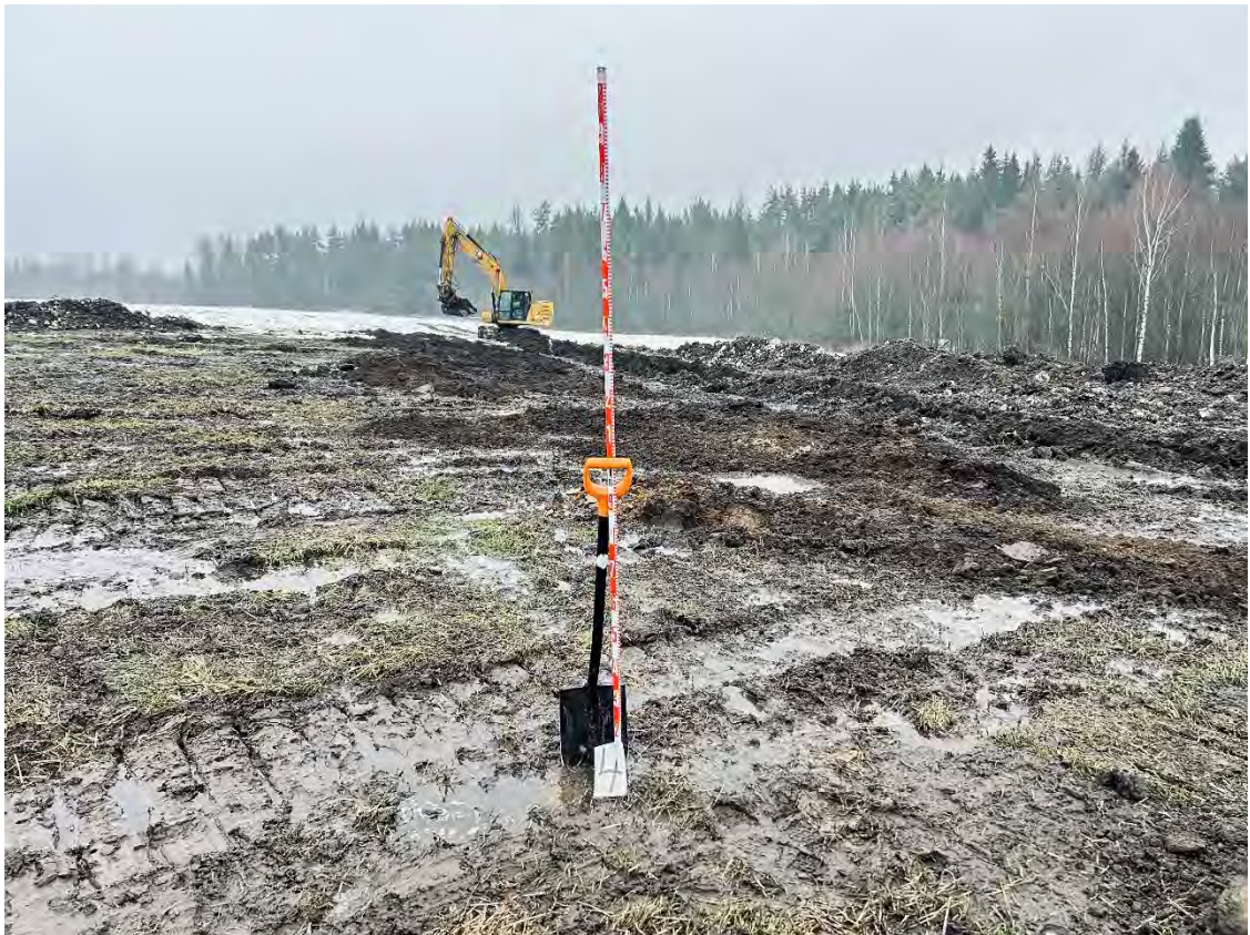
Рис. 78. Ленинградская область, Выборгский муниципальный район, Первомайское сельское поселение, уч. Сухочево. Шурф 4. Вид до начала работ с юга.
