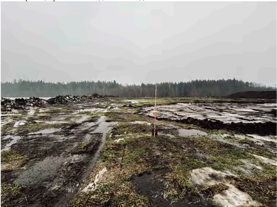
Рис. 17. Ленинградская область, Выборгский муниципальный район, Первомайское сельское поселение, уч. Сухочево. ТФ2. Вид с запада, юго-запада.
