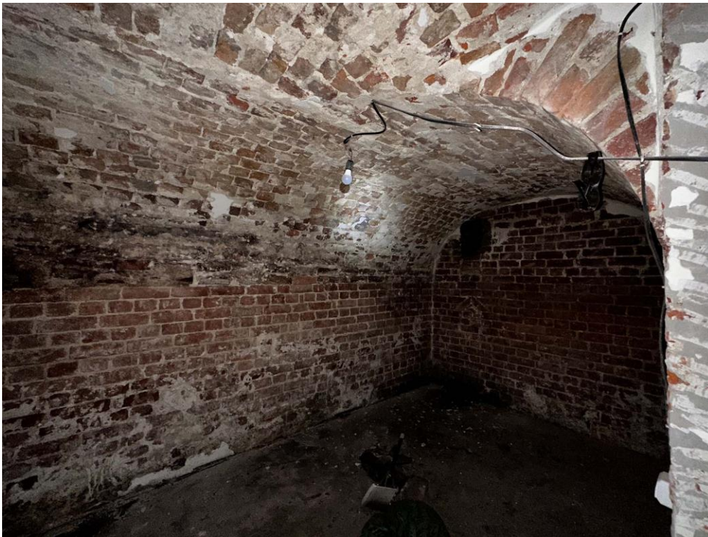
Фото 4. Пом.0.1. Вид на северо-восточную часть помещения с юго-запада. Дата съемки: 23.01.2025 г. Автор съемки: Глинская Н.Б.
