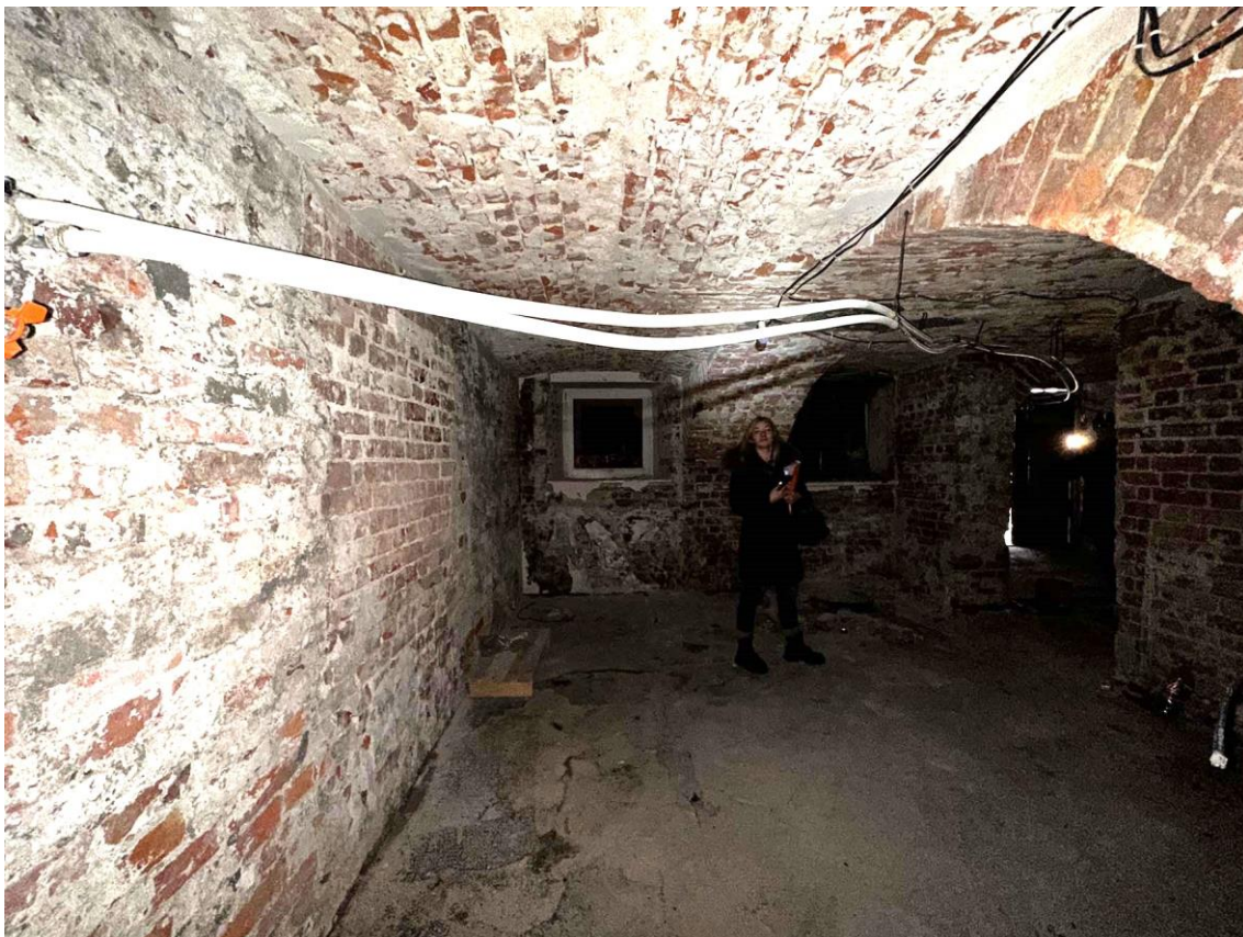
Фото 8. Пом.0.2. Общий вид помещения с северо-запада. Дата съемки: 23.01.2025 г. Автор съемки: Глинская Н.Б.
