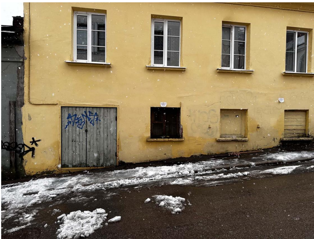
Фото 2. Фрагмент уличного северо-западного фасада здания, соответствующего обследуемым помещениям. Дата съемки: 23.01.2025 г. Автор съемки: Глинская Н.Б.
