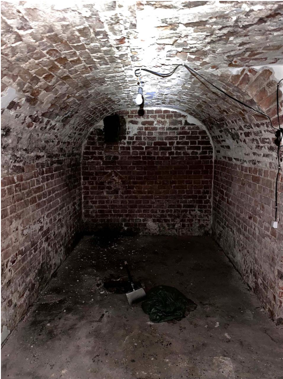
Фото 3. Пом. 0.1. Общий вид помещения с северо-запада. Дата съемки: 23.01.2025 г. Автор съемки: Глинская Н.Б.
