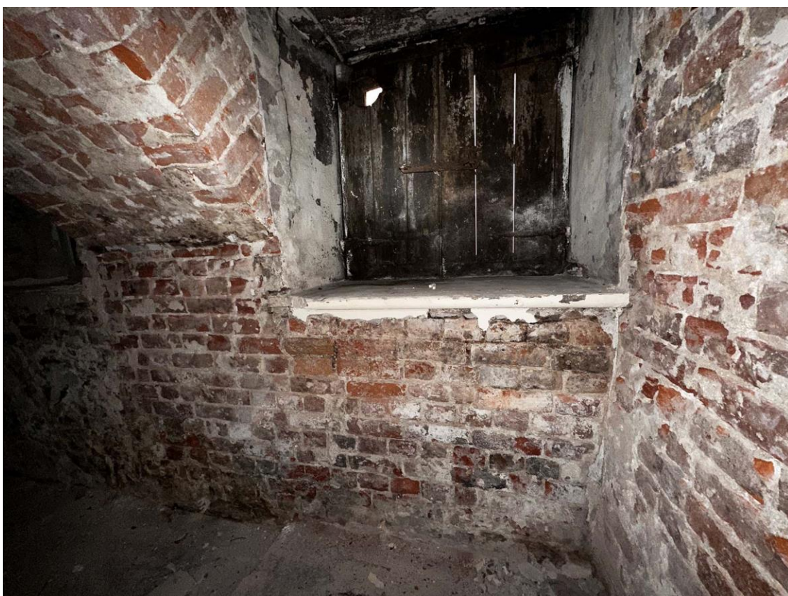
Фото 9. Пом. 0.2. Фрагмент северо-западной наружной стены с оконным проемом. Дата съемки: 23.01.2025 г. Автор съемки: Глинская Н.Б.
