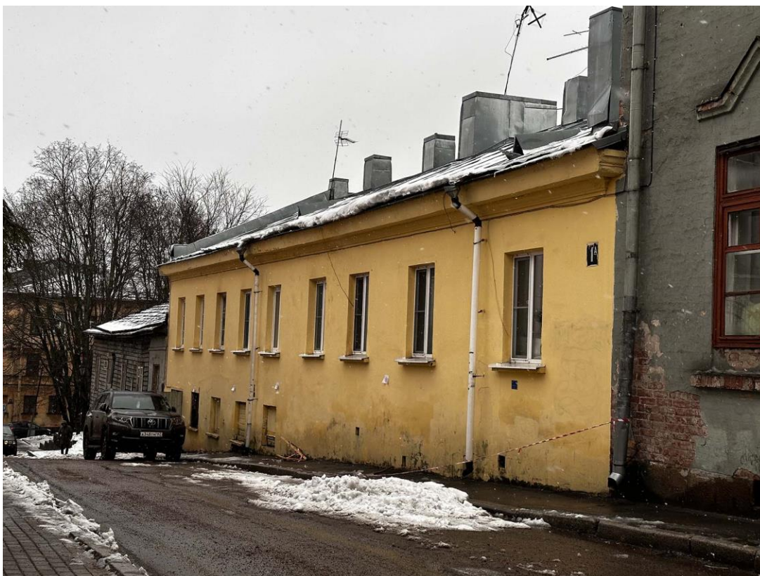
Фото 1. Общий вид уличного фасада здания с ул. Краснофлотской, с юго-запада. Дата съемки: 23.01.2025 г. Автор съемки: Глинская Н.Б.
