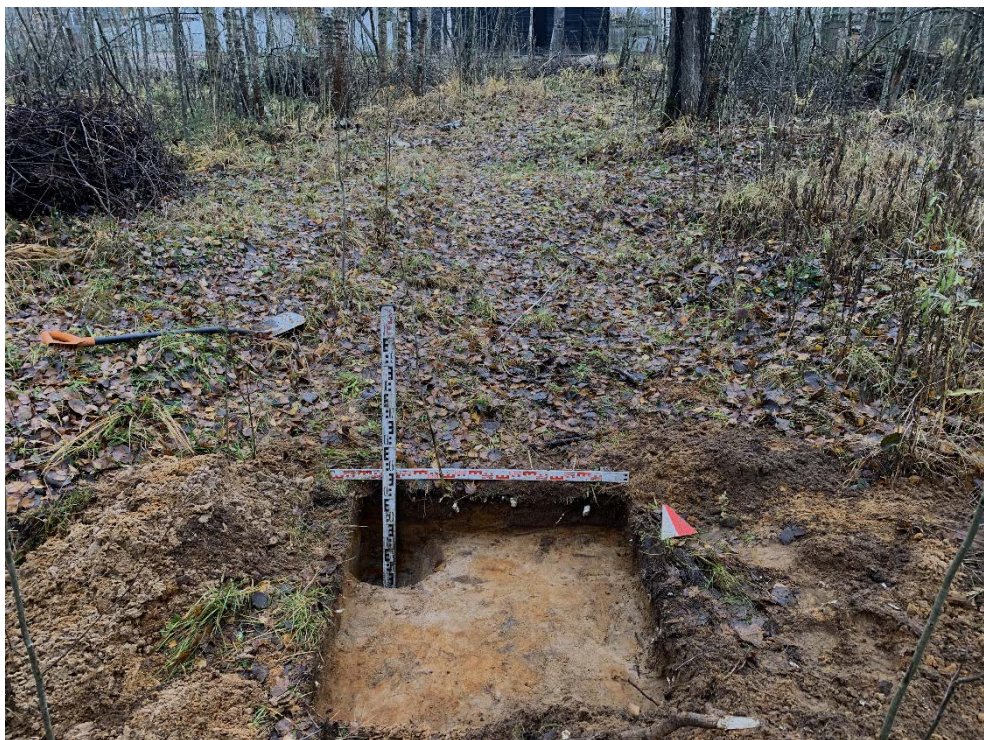
Илл. 57. Ленинградская область, Всеволожский район, 2023 г. «Межпоселковый газопровод от д. Коккореево до п.ст. Ладожское Озеро Всеволожского района Ленинградской области». Шурф №5. Зачистка по материке. Общий вид с Ю.
