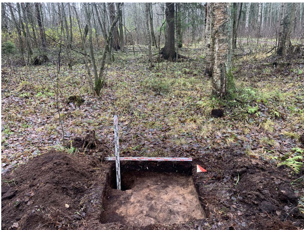
Илл. 20. Ленинградская область, Всеволожский район, 2023 г. «Межпоселковый газопровод от д. Коккорево до п.ст. Ладожское Озеро Всеволожского района Ленинградской области». Шурф №1. Зачистка по материк. Общий вид с Ю.
