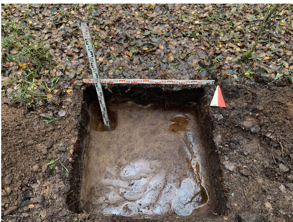
Илл. 41. Ленинградская область, Всеволожский район, 2023 г. «Межпоселковый газопровод от д. Коккорево до п.ст. Ладожское Озеро Всеволожского района Ленинградской области». Шурф №3. Материк. Предметный вид с Ю.
