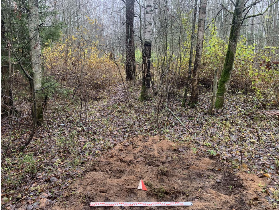
Илл. 32. Ленинградская область, Всеволожский район, 2023 г. «Межпоселковый газопровод от д. Коккорево до п.ст. Ладожское Озеро Всеволожского района Ленинградской области». Шурф №2. Рекультивация. Вид с Ю.
