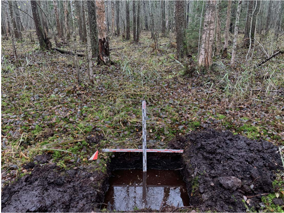
Илл. 50. Ленинградская область, Всеволожский район, 2023 г. «Межпоселковый газопровод от д. Коккорево до п.ст. Ладожское Озеро Всеволожского района Ленинградской области». Шурф №4. Уровень грунтовых вод. Общий вид с Ю.
