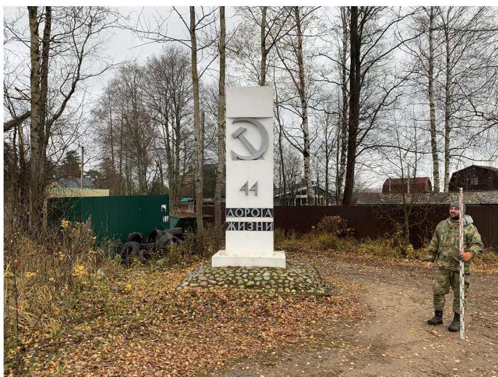
Илл. 61. Ленинградская область, Всеволожский район, 2023 г. «Межпоселковый газопровод от д. Коккорево до п.ст. Ладожское Озеро Всеволожского района Ленинградской области». Точка фотофиксации №12. Вид с ЮЗ на «Памятный километровый столб на «Дороге Жизни» (44 км).
