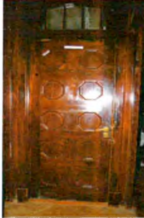
Дверь в подвал.
