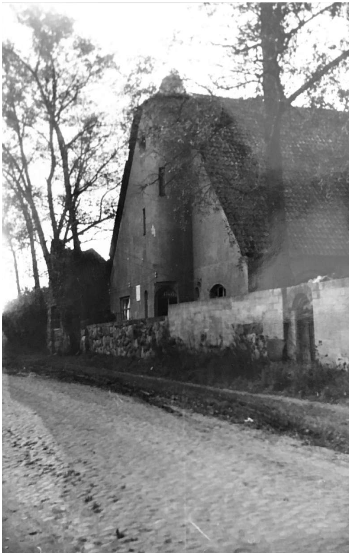
22. 1961 г. Дом П.Е. Щербова. Восточный фасад и каменная ограда. Архив ККЛО
