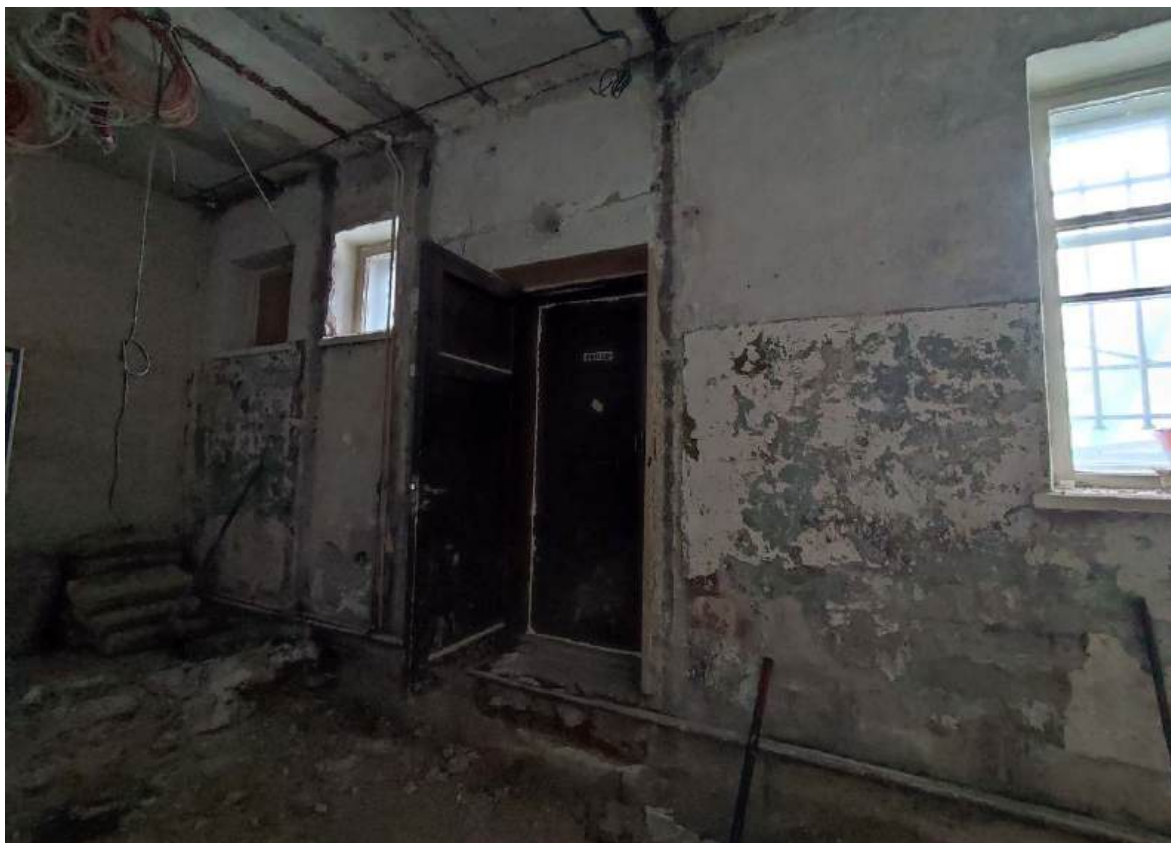
7. Помещения 2, 17-19. Дата съемки 28.02.2024.
