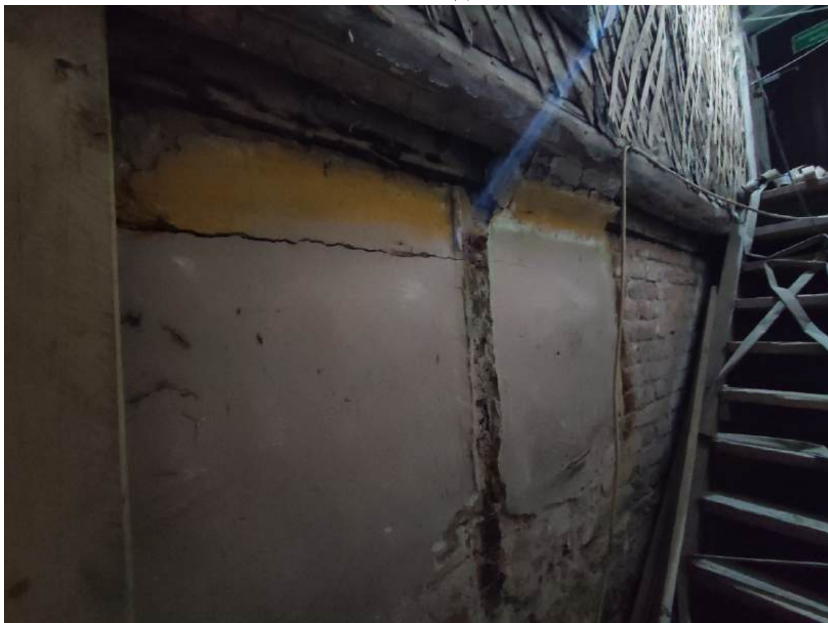
61. Помещение 30. Дата съемки 28.02.2024.
