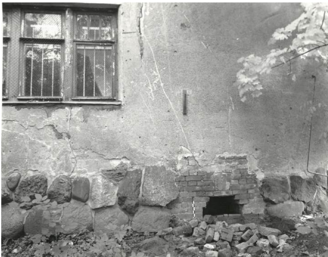
49. 1984 г. Дом П.Е. Щербова. Северо-западный фасад. Дворовый камин. «Спецпроектреставрация».
