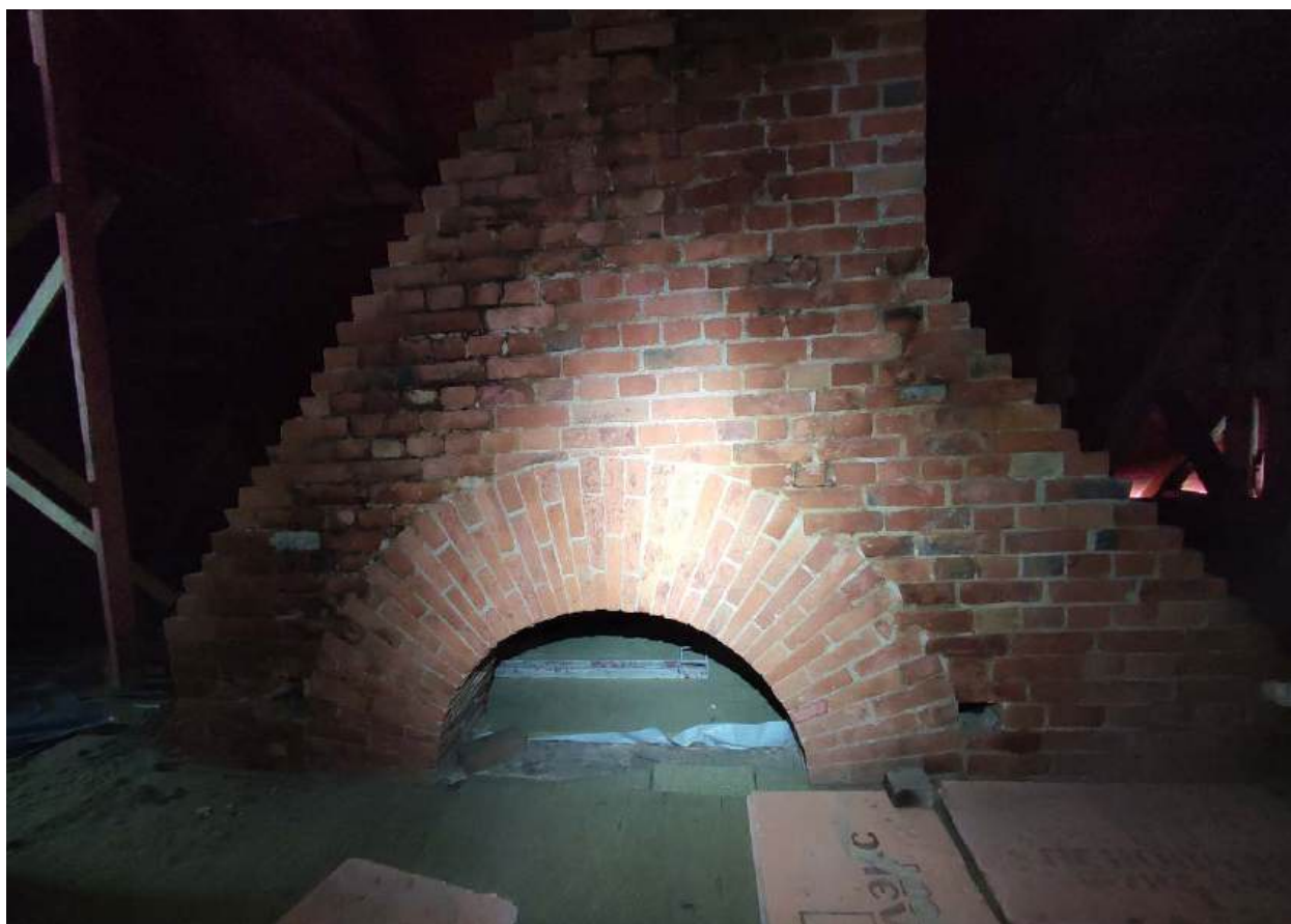
49. Помещение 28. Дата съемки 28.02.2024.
