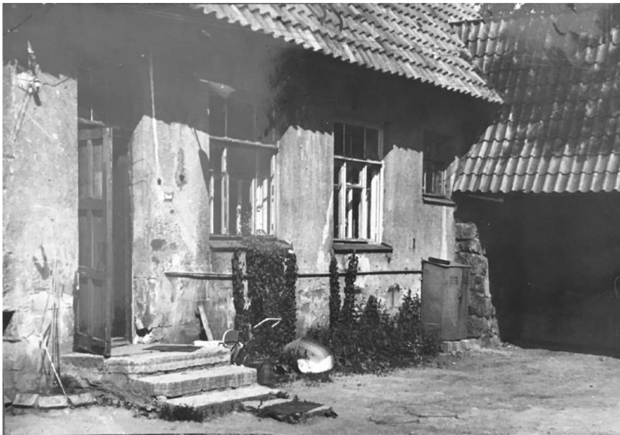
26. 1968 г. Дом П.Е. Щербова. Вид двора. Архив ККЛЮ
