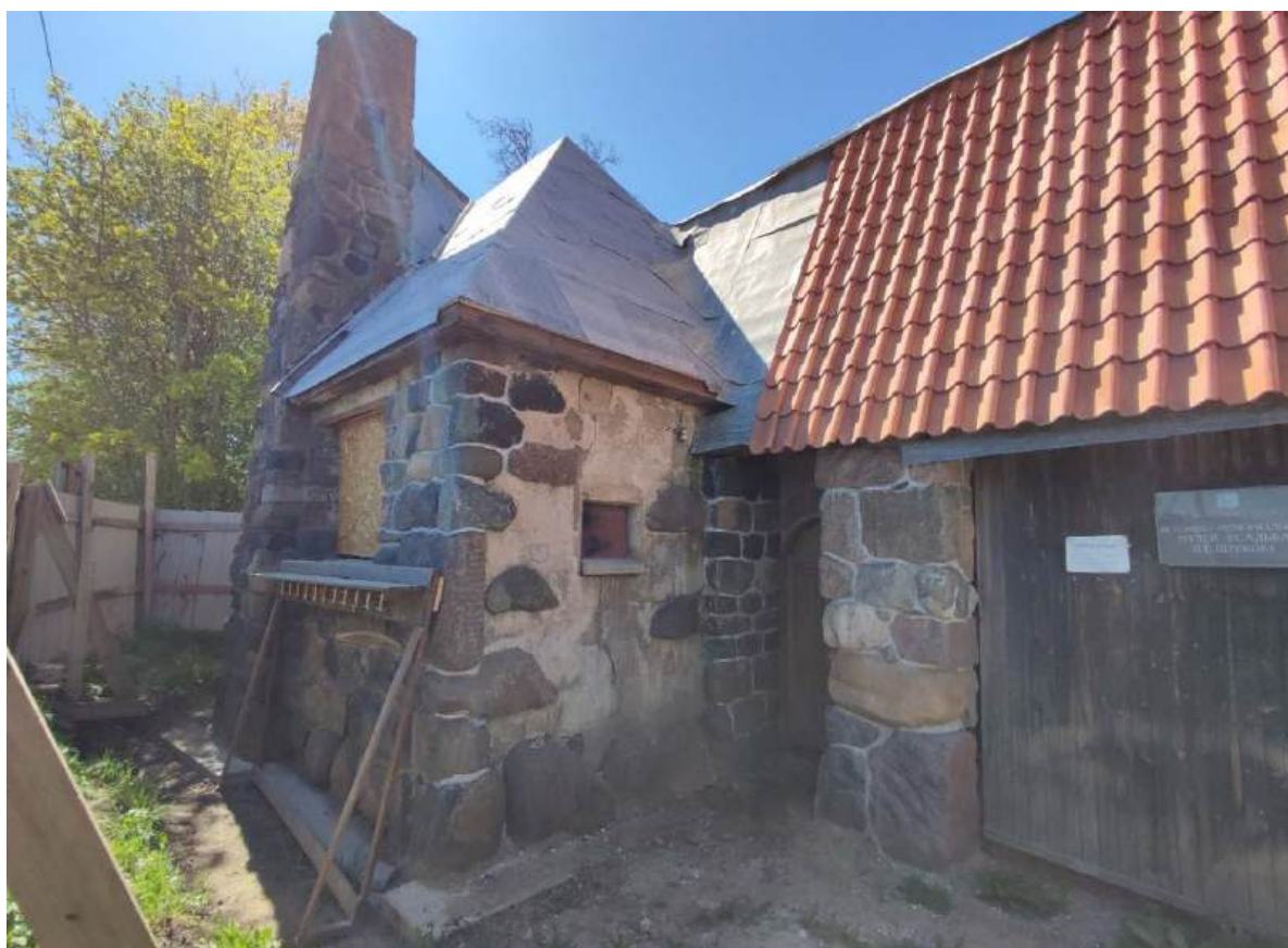
14. Вид на северо-восточный угол дворницкой. Дата съемки 16.05.2024.
