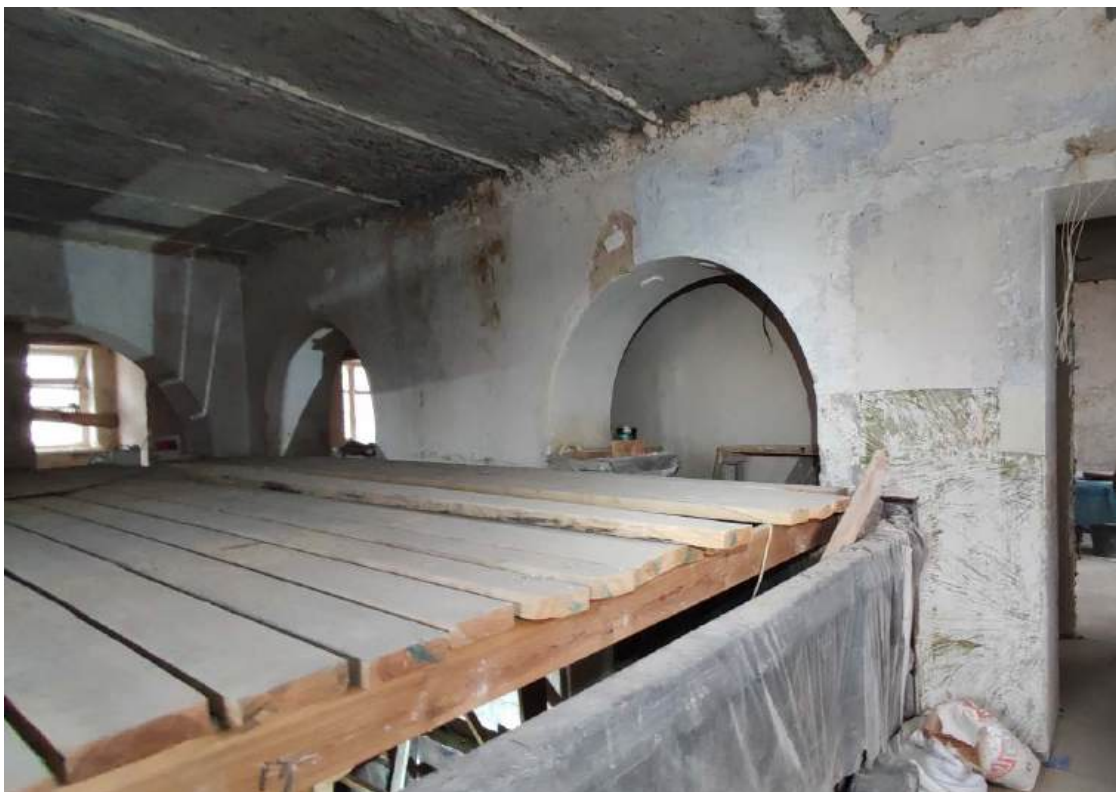
34. Помещение 1. Дата съемки 28.02.2024.
