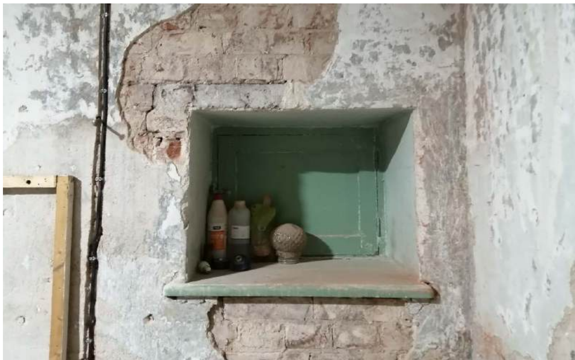
11. Помещение 3. Дата съемки 16.05.2024.
