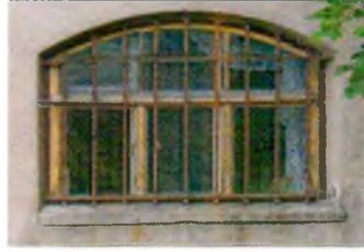
Подоконники из блоков известняка.
