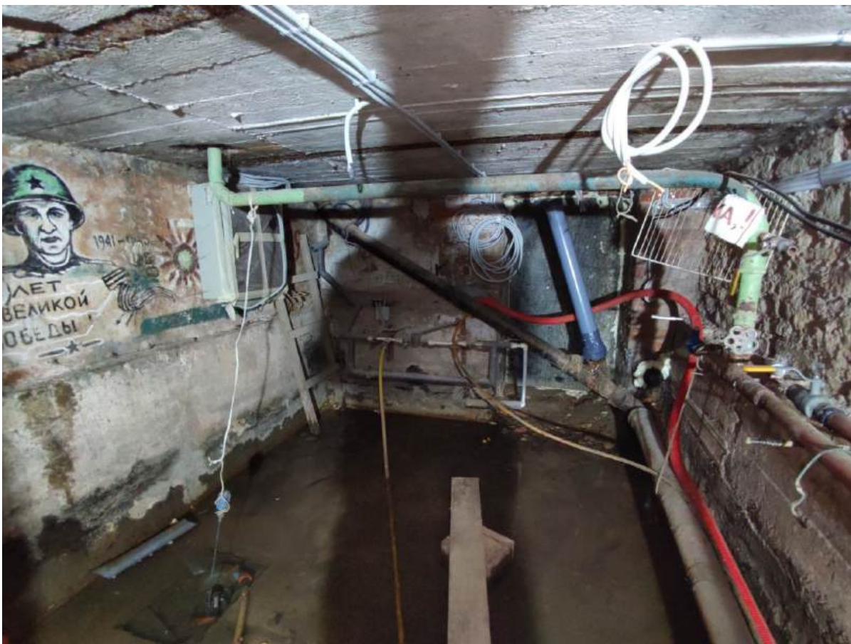
60. Помещение 32.1. Дата съемки 28.02.2024.
