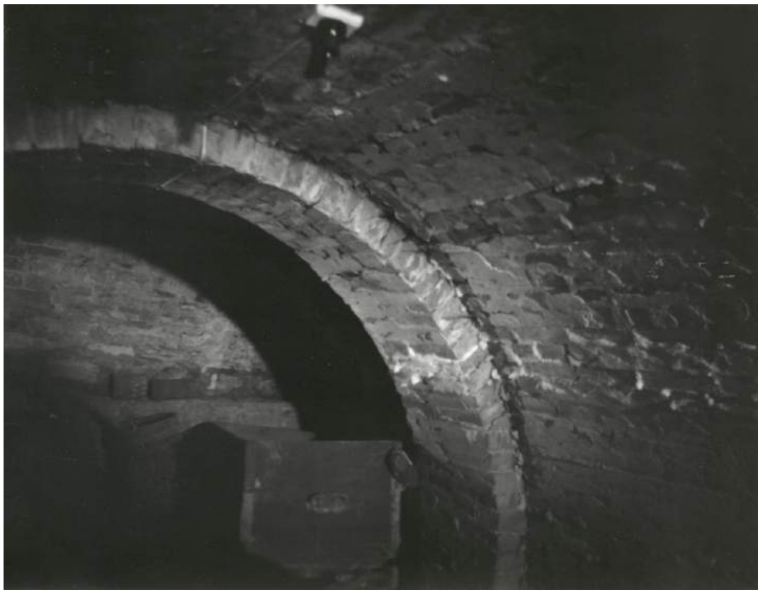
59. 1984 г. Дом П.Е. Щербова. Своды подвального помещения. «Спецпроектреставрация».
