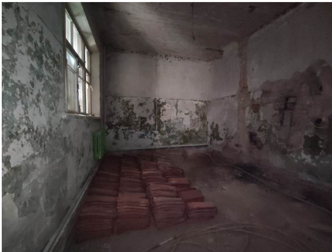
6. Помещения 2, 17-19. Дата съемки 16.05.2024.
