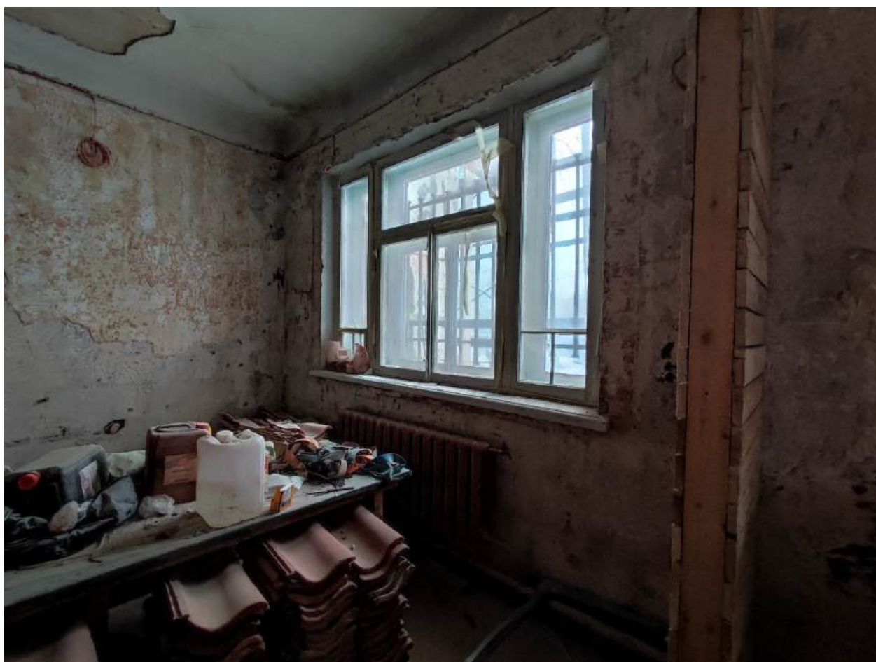
33. Помещение 7. Дата съемки 28.02.2024.
