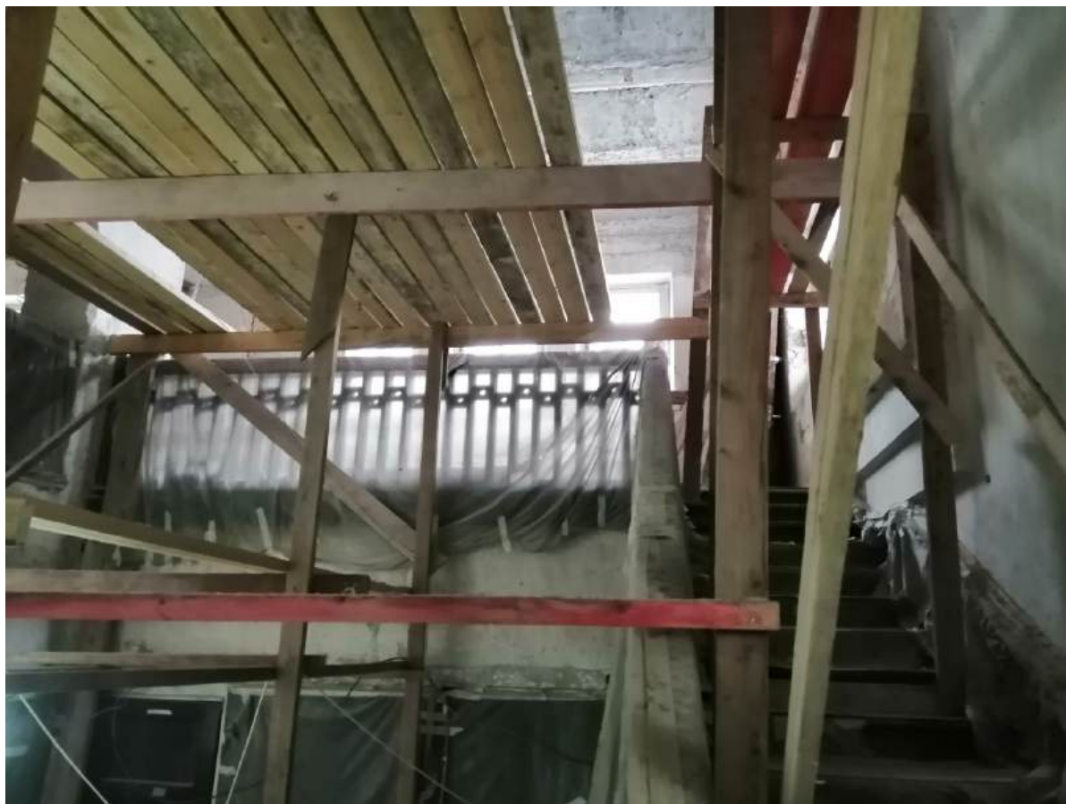
3. Помещение 1. Дата съемки 28.02.2024.
