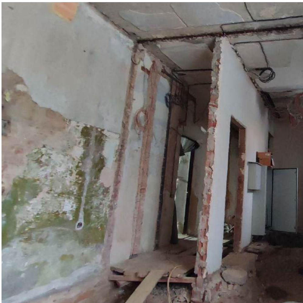
9. Помещения 2, 17-19. Дата съемки 28.02.2024.
