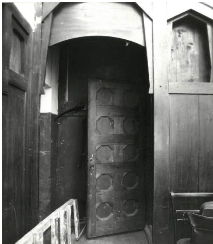
57. 1984 г. Дом П.Е. Щербова. Фрагмент холла. «Спецпроектреставрация».
