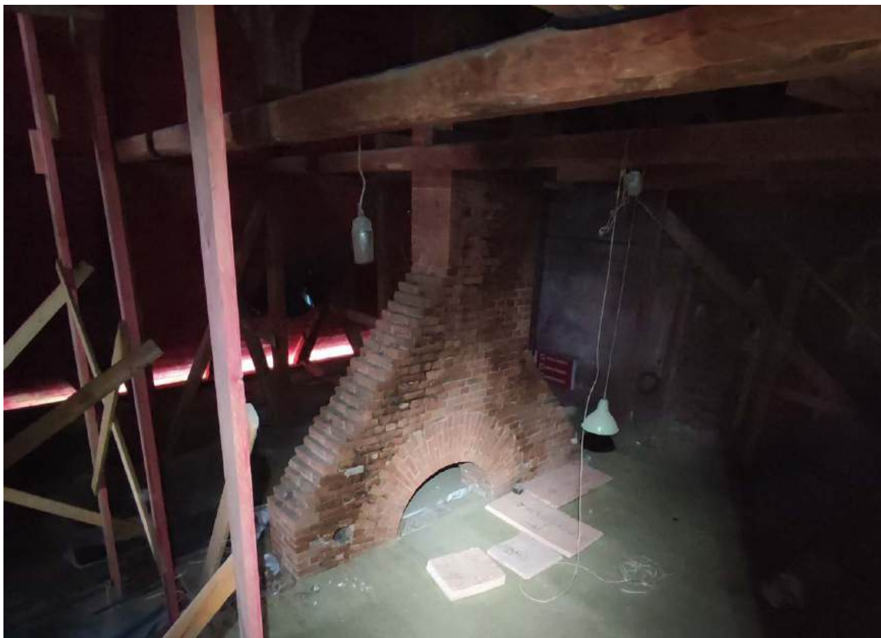
52. Помещение 28. Дата съемки 28.02.2024.
