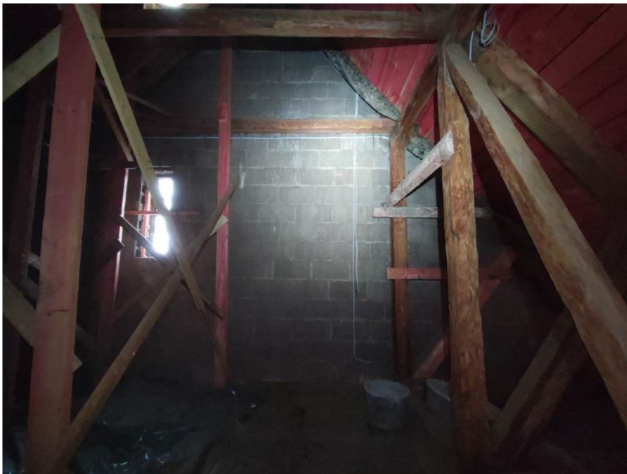
50. Помещение 28. Дата съемки 28.02.2024.
