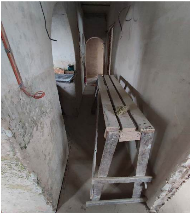
42. Помещение 21. Дата съемки 28.02.2024.
