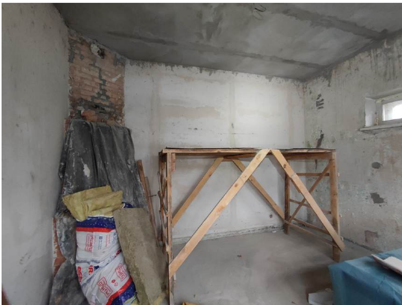
37. Помещение 22. Дата съемки 28.02.2024.
