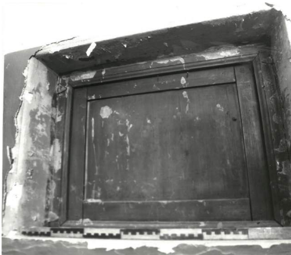
53. 1984 г. Дом П.Е. Щербова. Деревянное оконного заполнения подачи пищи в помещении столовой. «Спецпроектреставрация»
