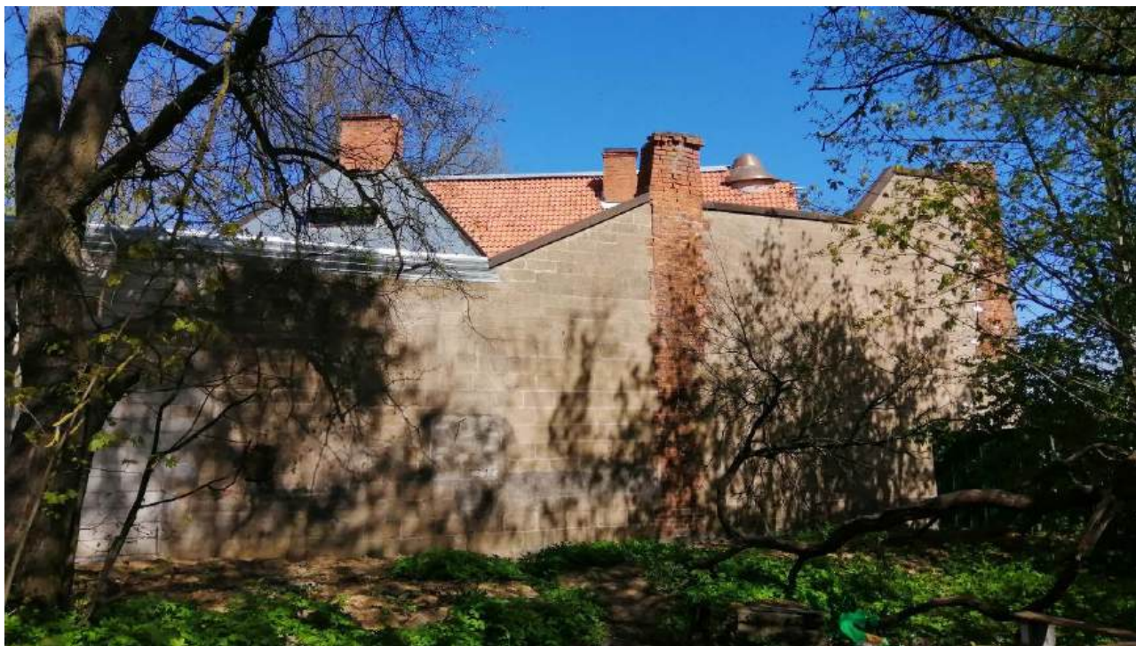
12. Вид с юго-востока на брандмауэр дворницкой. Дата съемки 16.05.2024.
