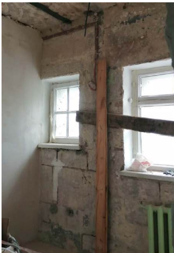
41. Помещение 25. Дата съемки 28.02.2024.
