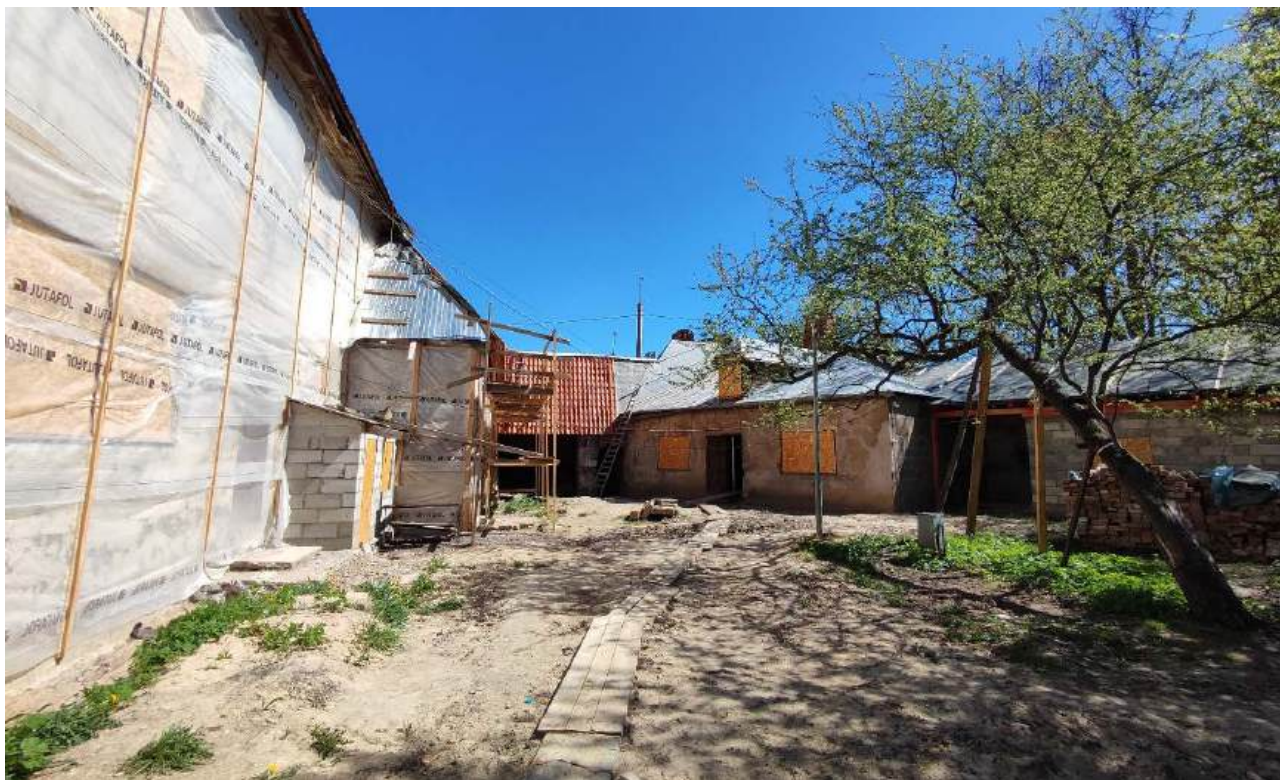
31. Вид с запада в сторону дворового фасада дворницкой. Дата съемки 16.05.2024.
