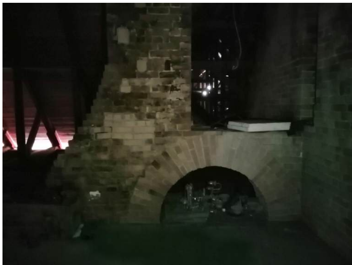
55. Помещение 29. Дата съемки 28.02.2024.
