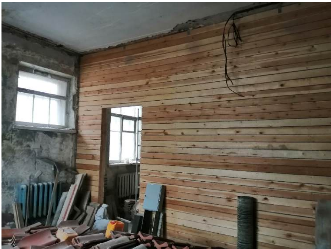
25. Помещение 11. Дата съемки 28.02.2024.
