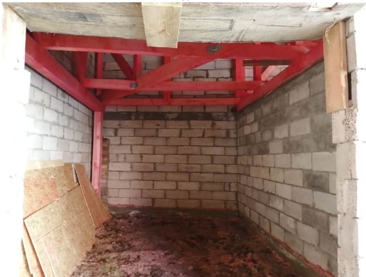
12. Помещение 10. Дата съемки 16.05.2024.
