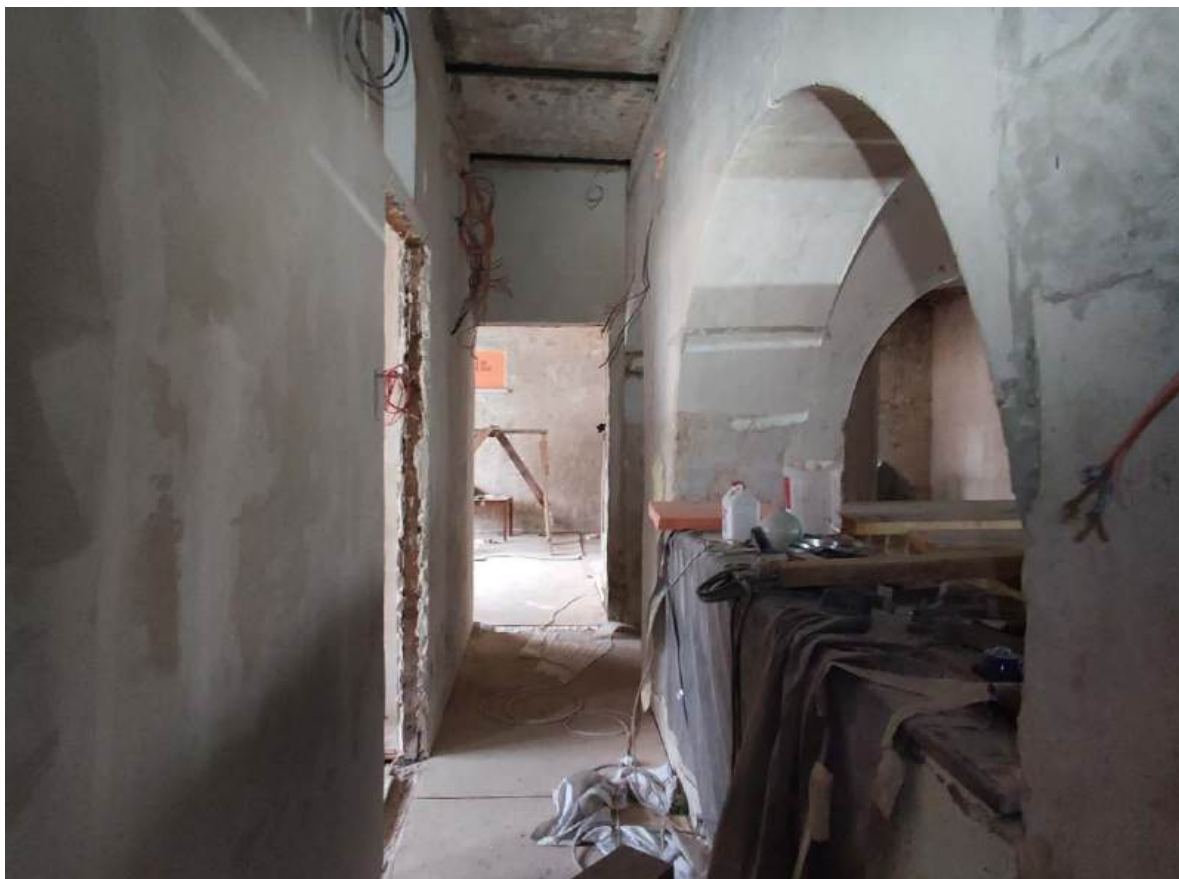
44. Помещение 21. Дата съемки 28.02.2024.
