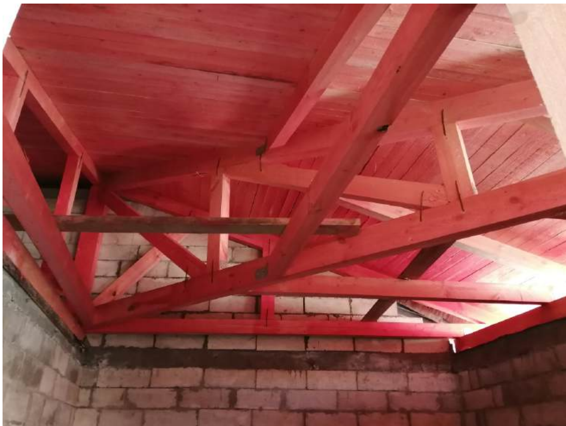
13. Помещение 11-14. Дата съемки 16.05.2024.
