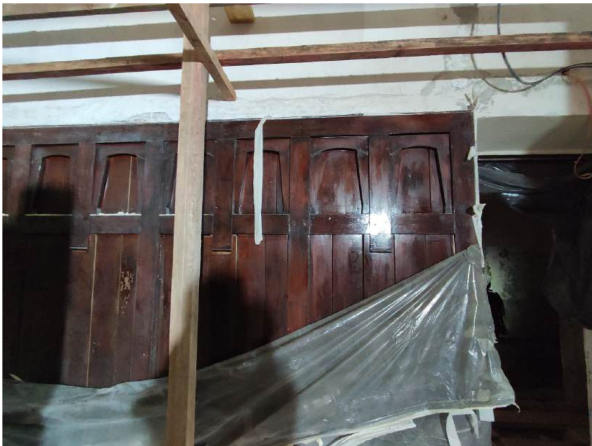
5. Помещение 1. Дата съемки 16.05.2024.
