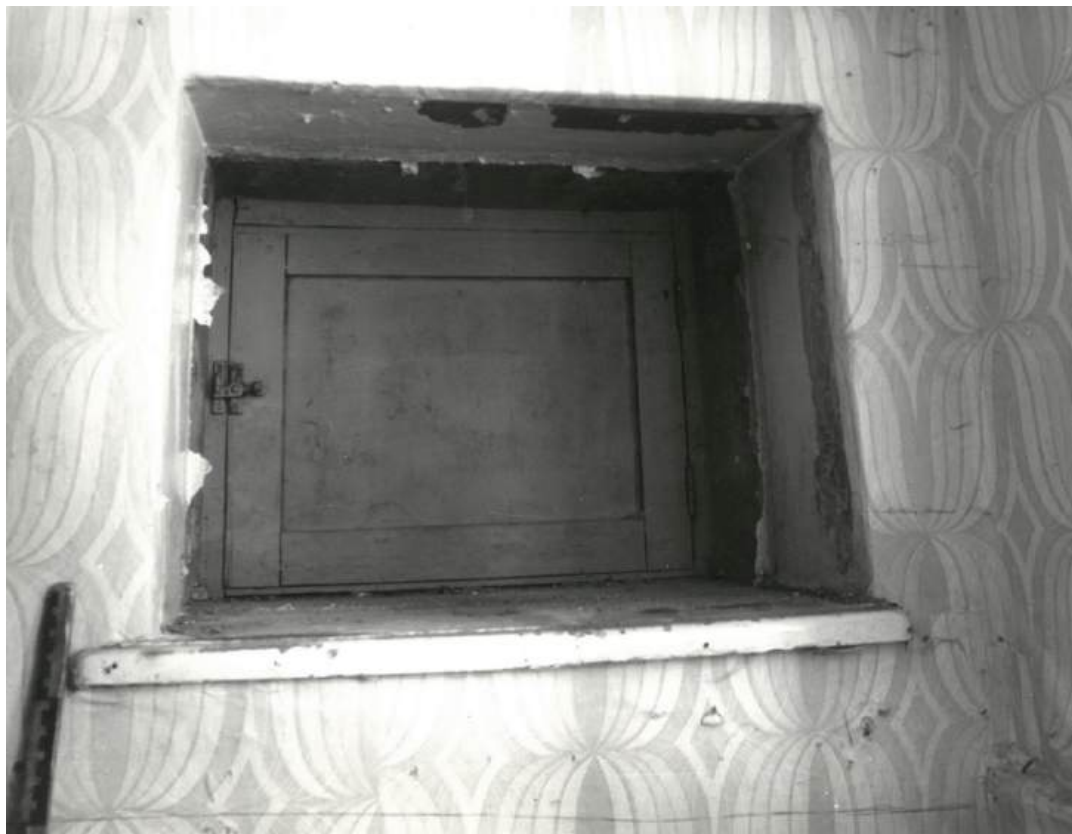
54. 1984 г. Дом П.Е. Щербова. Деревянное оконного заполнения подачи пищи в помещении столовой. «Спецпроектреставрация»
