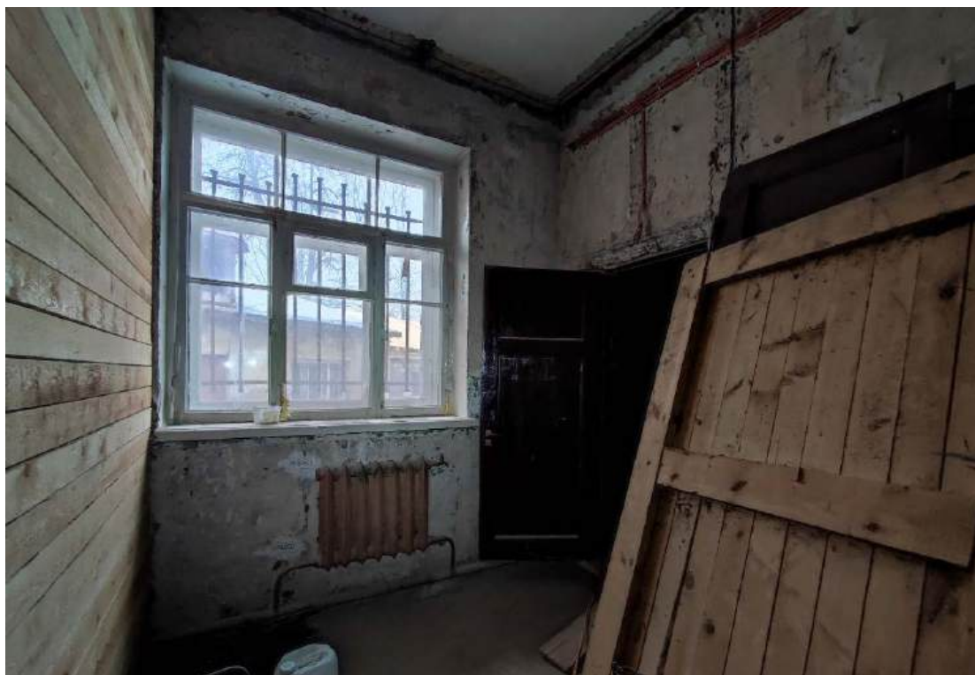
20. Помещение 13. Дата съемки 28.02.2024.
