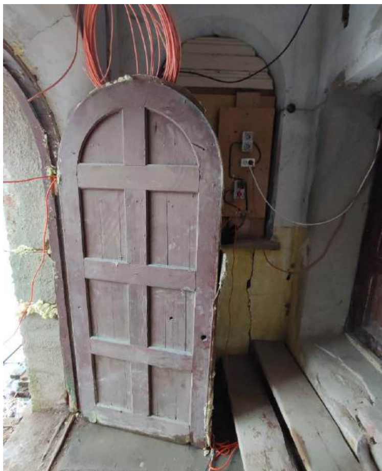
16. Помещение 6. Дата съемки 28.02.2024.
