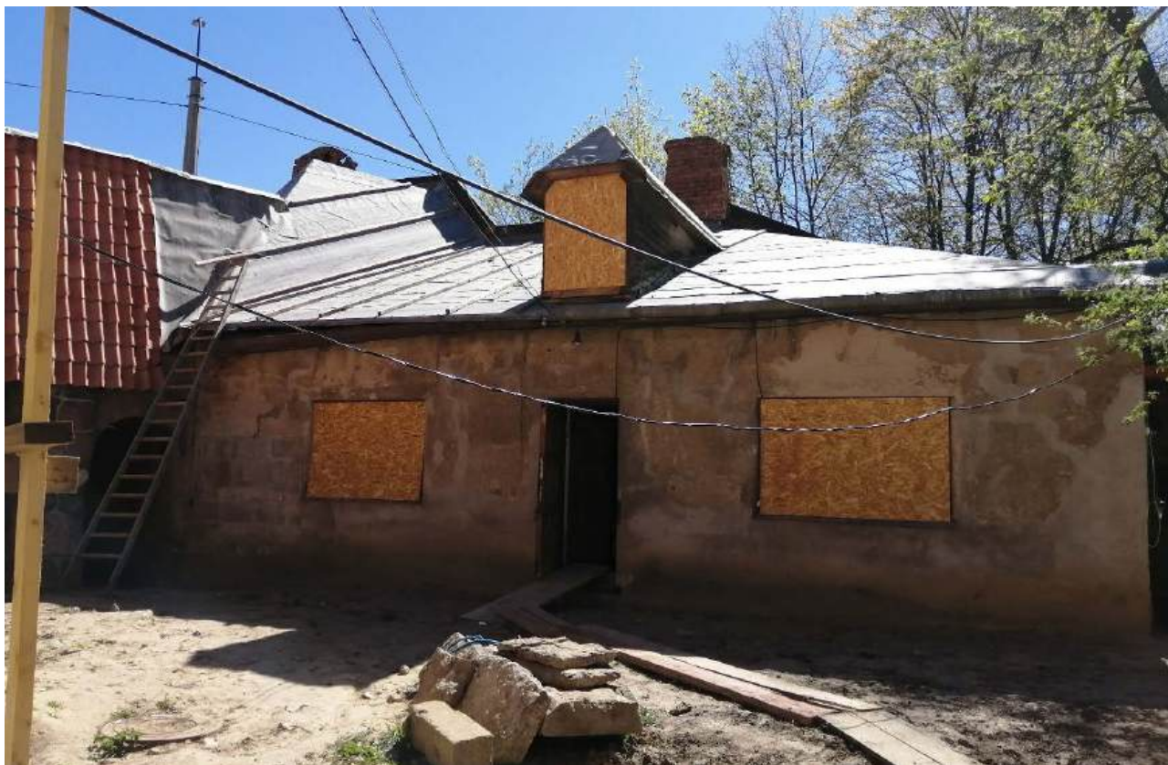
33. Вид дворового фасада дворницкой. Дата съемки 16.05.2024.
