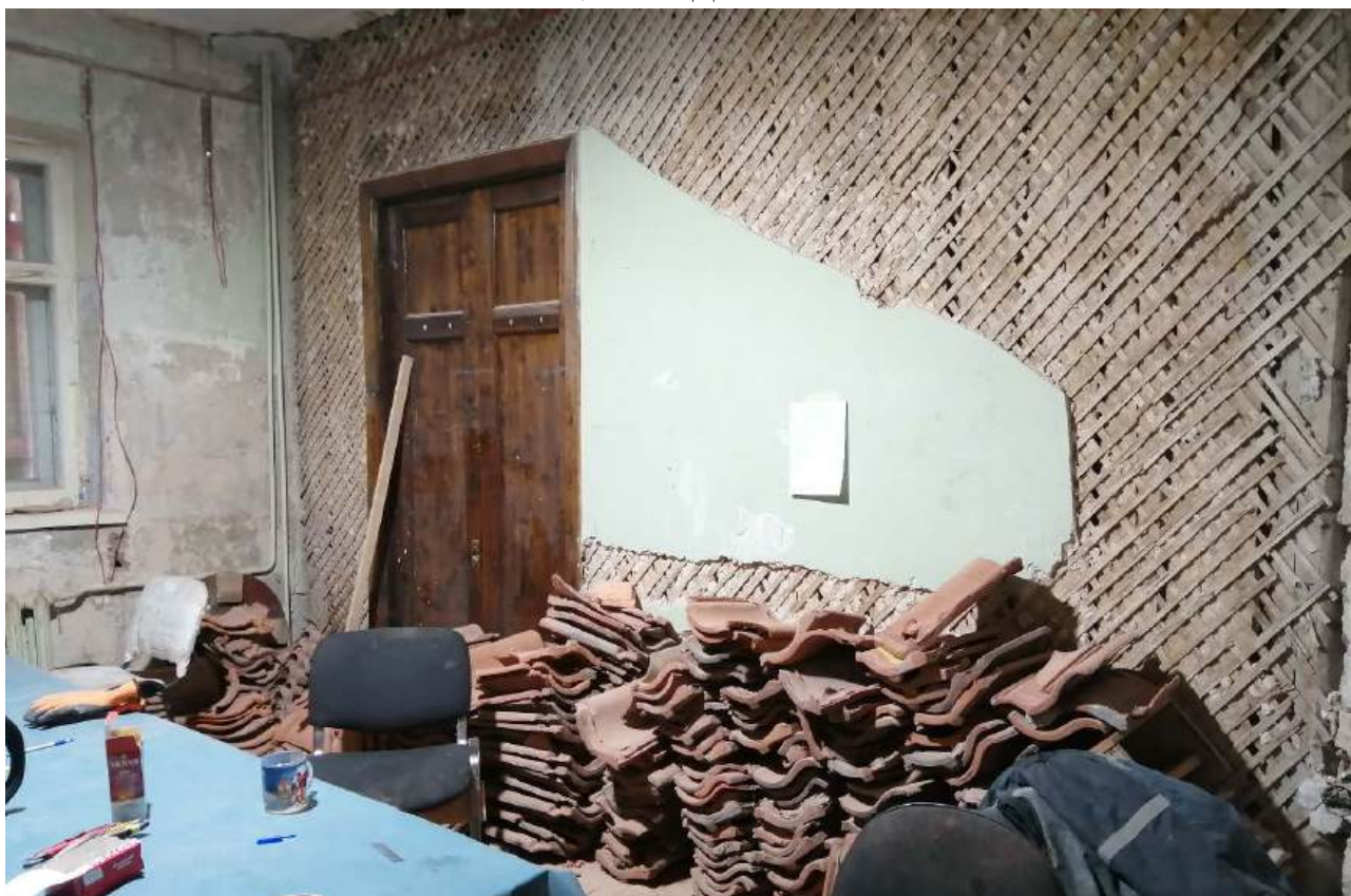
10. Помещение 3. Дата съемки 16.05.2024.
