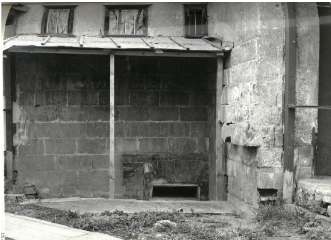
46. 1984 г. Дом П.Е. Щербова. Южный фасад. Место входа в подвал. «Спецпроектреставрация»
