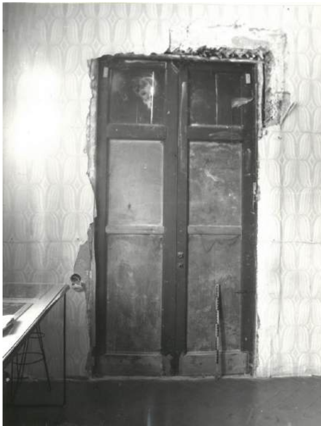
55. 1984 г. Дом П.Е. Щербова. Дверной проема с двустворчатым заполнением из столовой в соседнее помещение. «Спецпроектреставрация».
