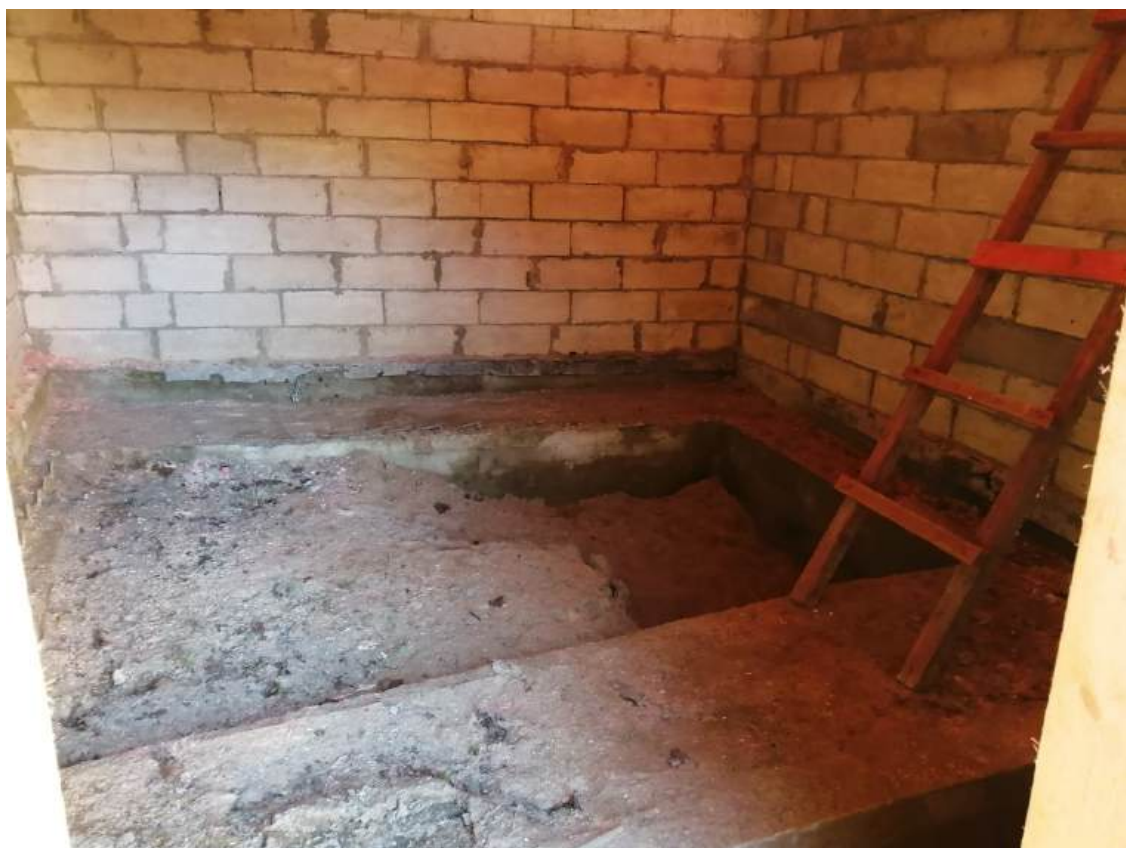
14. Помещение 11-14. Дата съемки 16.05.2024.
