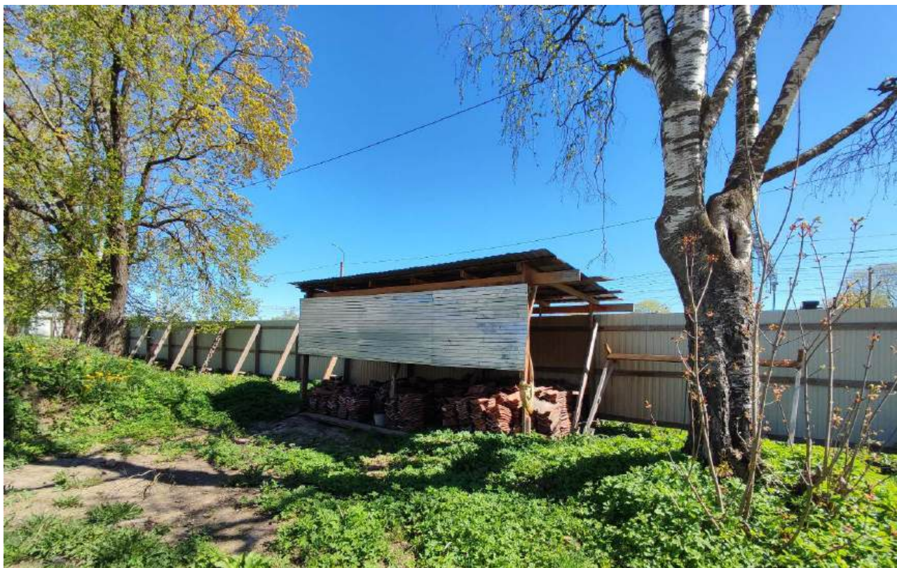
21. Вид на северо-восточную часть территории. Дата съемки 16.05.2024.
