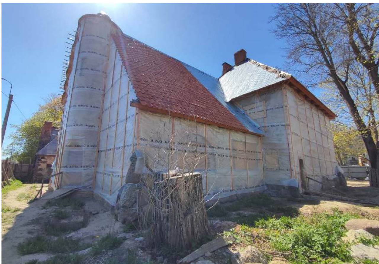
18. Общий вид жилого дома с северо-востока. Дата съемки 16.05.2024.
