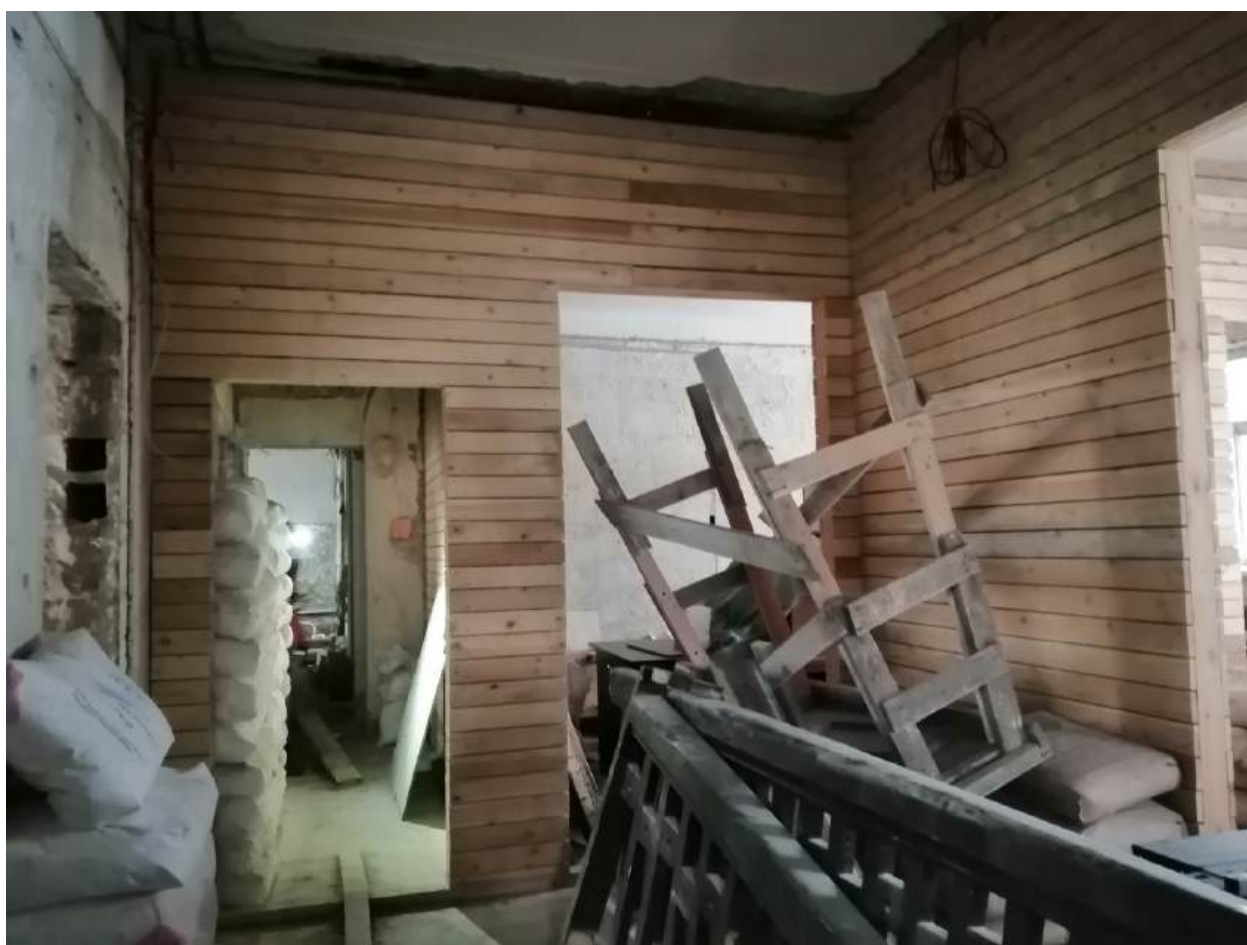
28. Помещение 9. Дата съемки 28.02.2024.
