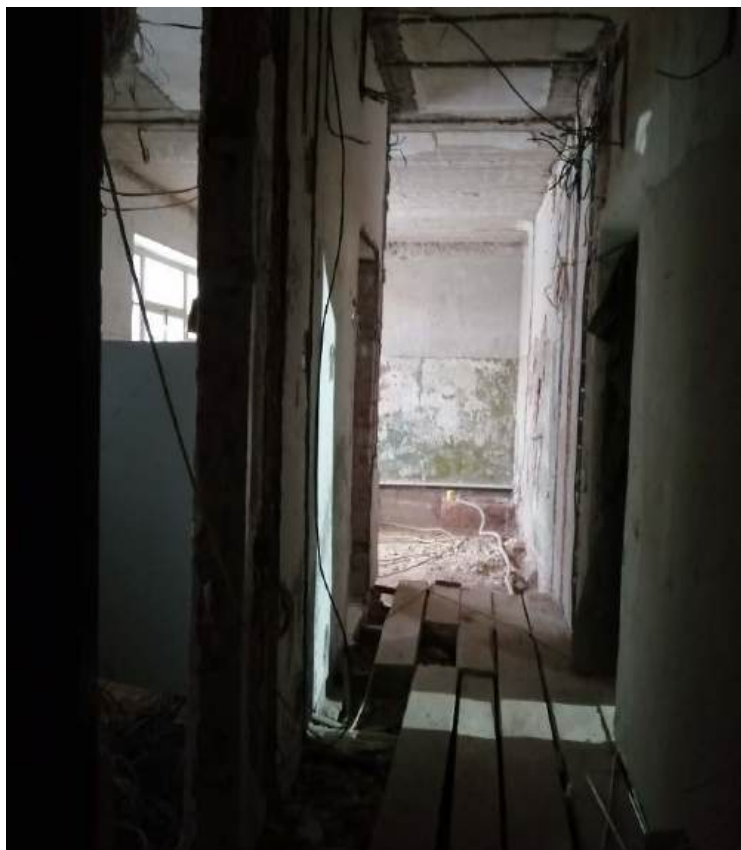
17. Помещение 20.2. Дата съемки 28.02.2024.
