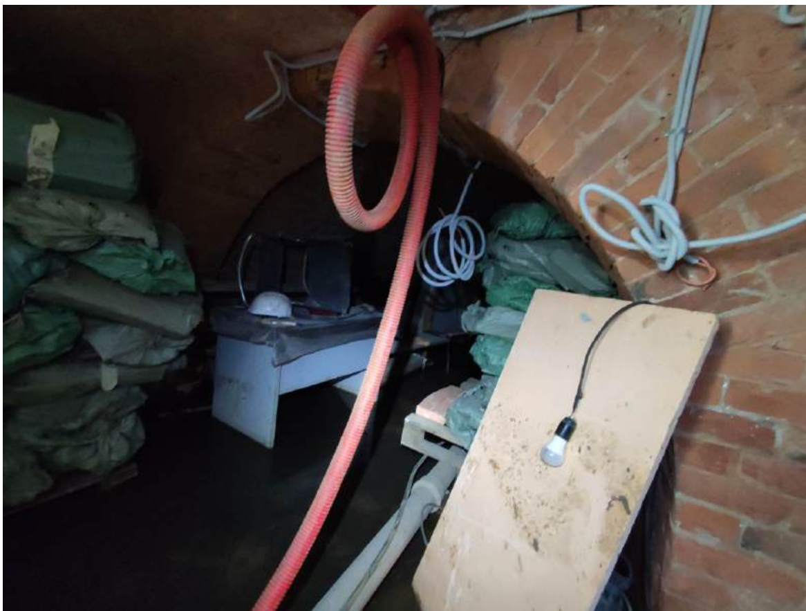
58. Помещение 31. Дата съемки 28.02.2024.
