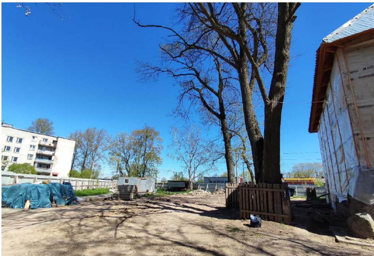
24. Общий вид прилегающей территории с севера (парковая зона) к жилому дому. Направление съёмки с запада. Дата съёмки 16.05.2024.
