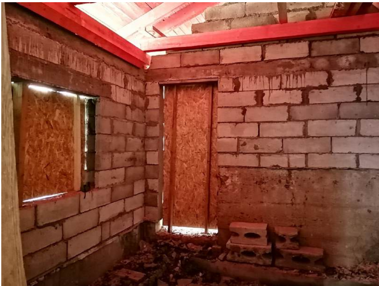
7. Помещение8. Дата съемки 16.05.2024.
