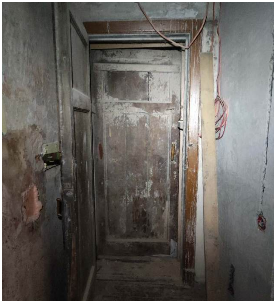
46. Помещение 27. Дата съемки 28.02.2024.
