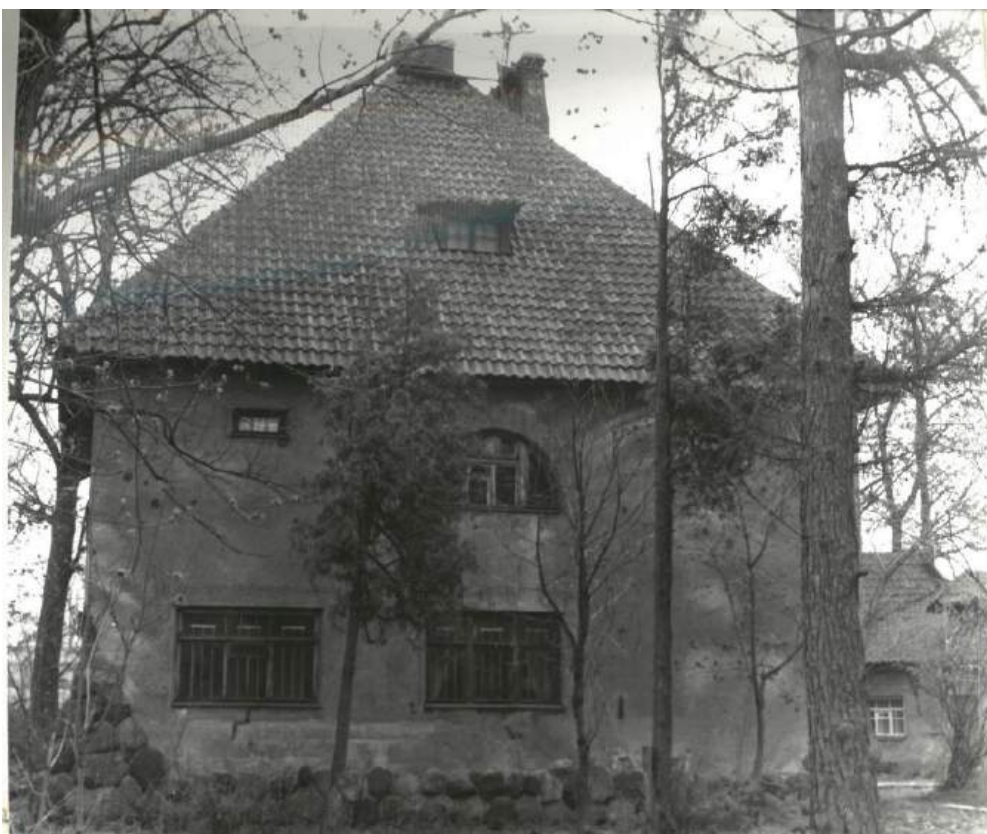
43. 1984 г. Дом П.Е. Щербова. Западный фасад. «Спецпроектреставрация»
