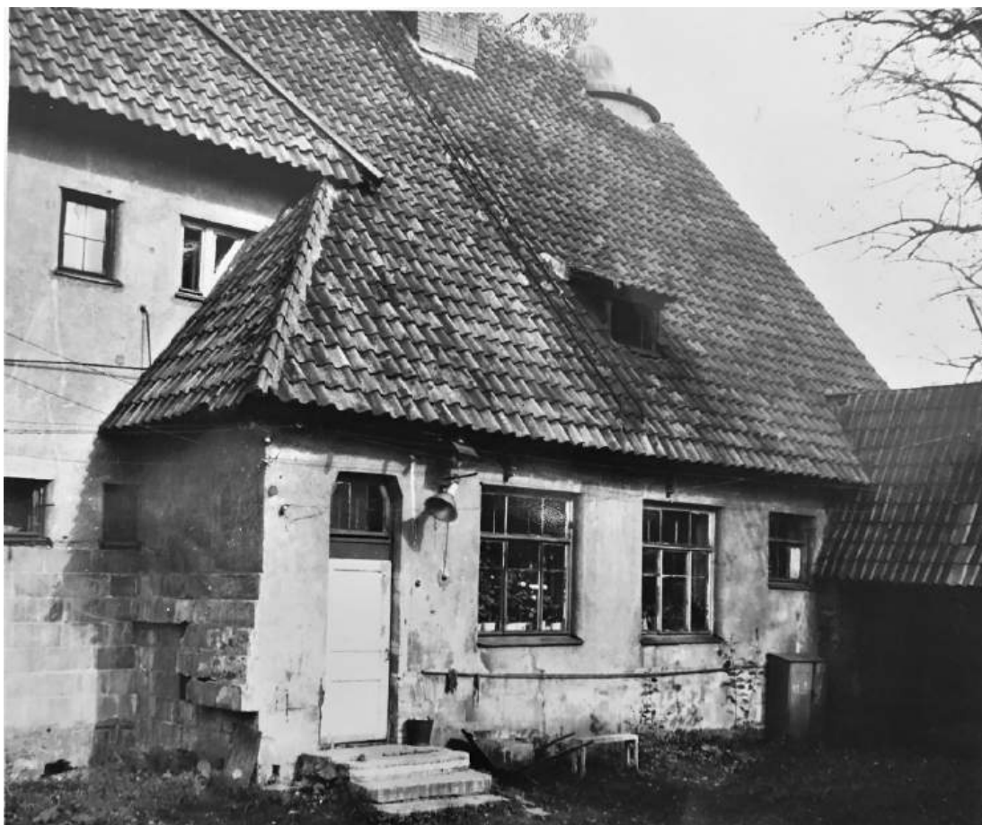
39. 1980 г. Дом П.Е. Щербова. Часть южного фасада. Фото В.А. Коренькова. Архив ККЛО
