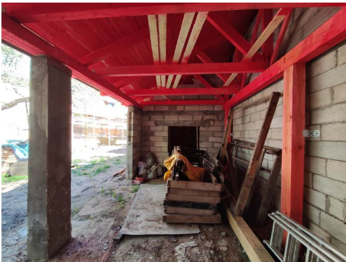
10. Помещение 9. Дата съемки 16.05.2024.
