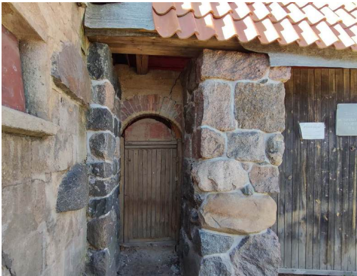
15. Вид калитки воротного проезда с ул. Чехова. Дата съемки 16.05.2024.
