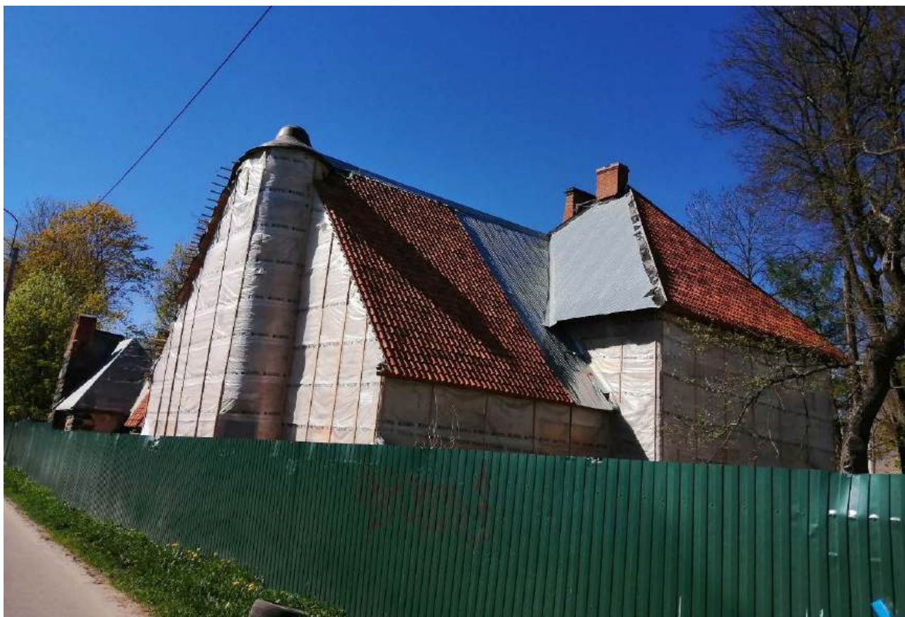
4. Общий вид жилого дома с ул. Чехова. Направление съёмки на юго-запад. Дата съёмки 16.05.2024.
