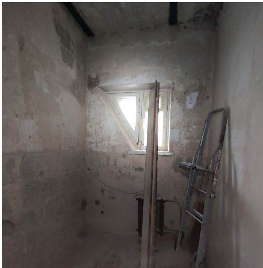
45. Помещение 26. Дата съемки 28.02.2024.
