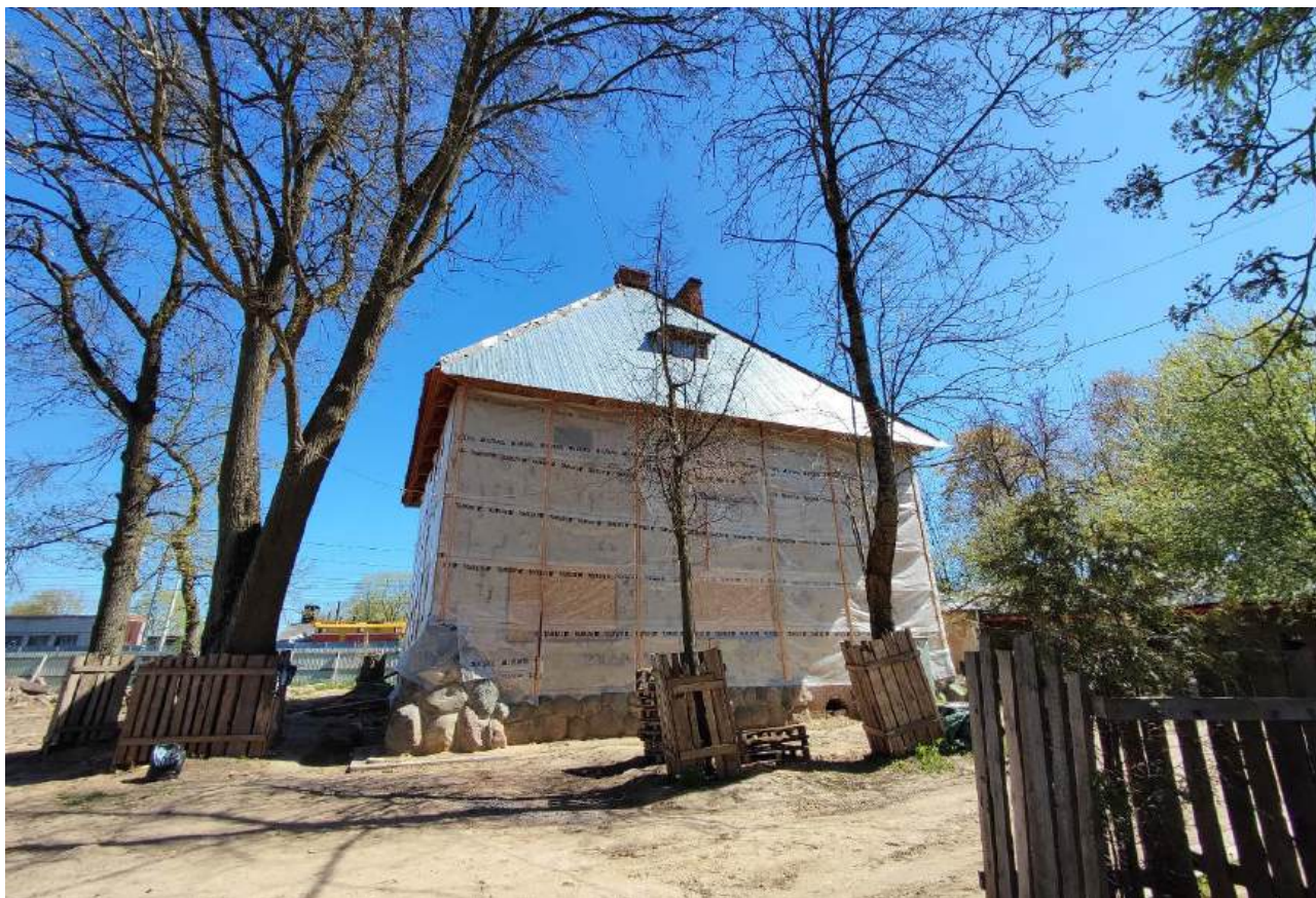
27. Общий вид западного фасада жилого дома. Дата съемки 16.05.2024.
