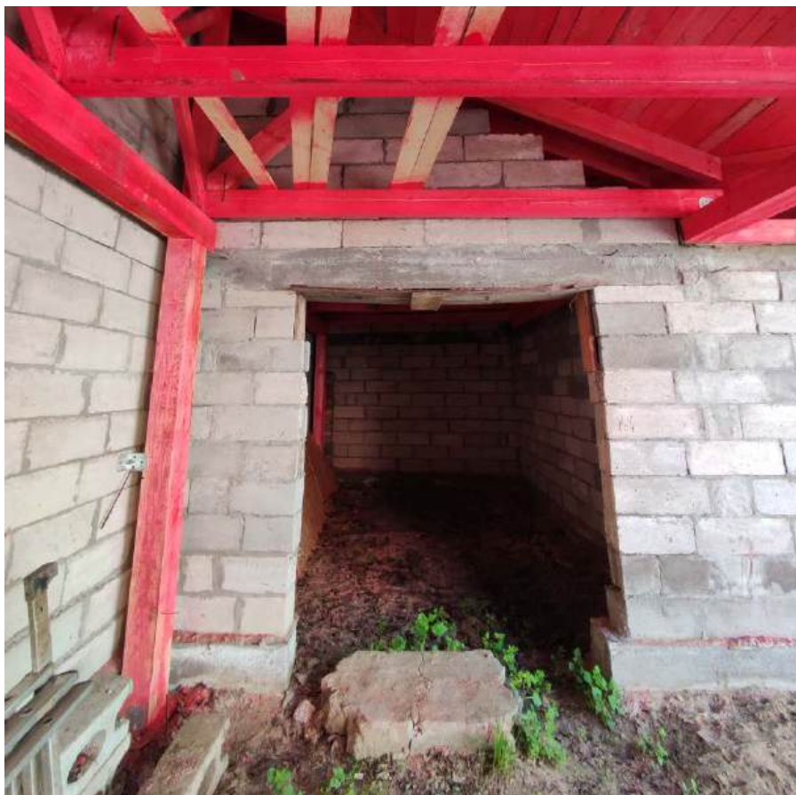
11. Помещение 9. Дата съемки 16.05.2024.
