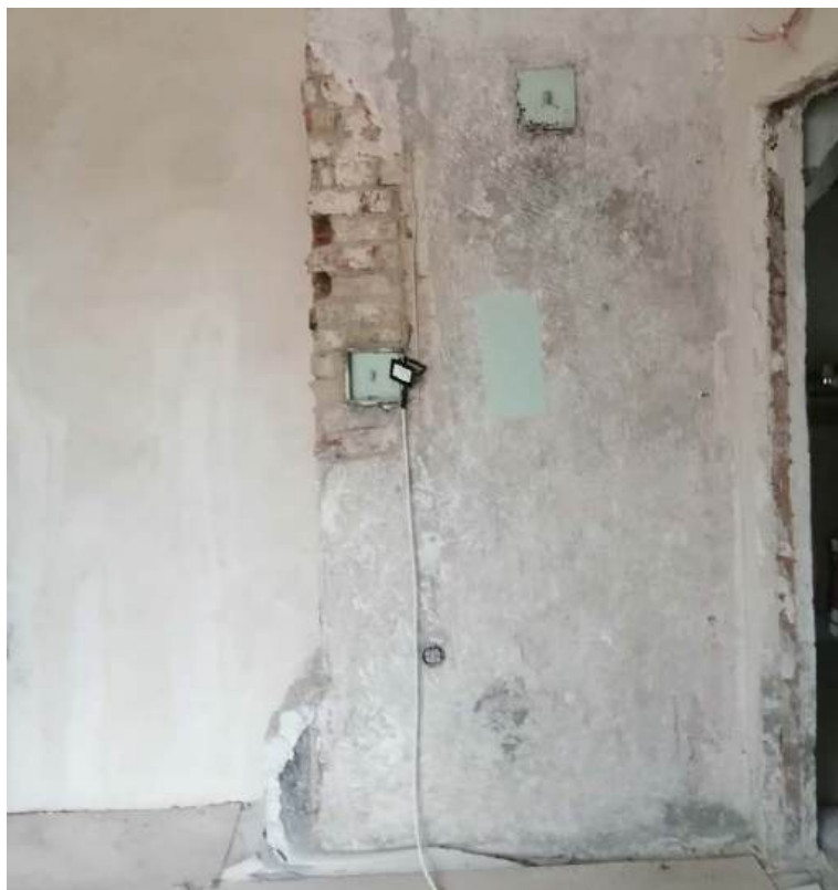
40. Помещение 24. Дата съемки 28.02.2024.
