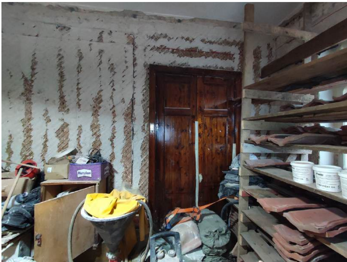
13. Помещение 4. Дата съемки 28.02.2024.
