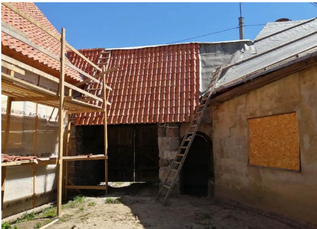
32. Вид западного фасада воротного проезда. Дата съемки 16.05.2024.
