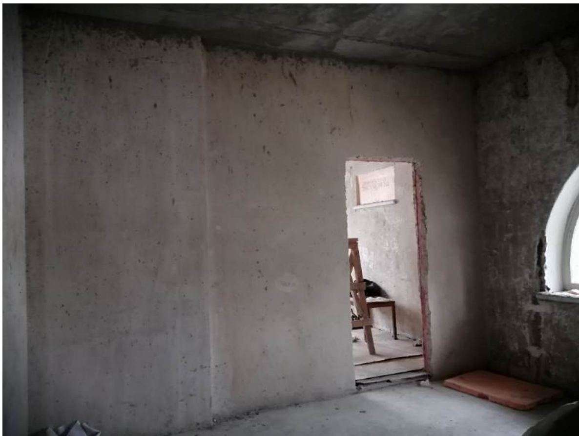
38. Помещение 23. Дата съемки 28.02.2024.
