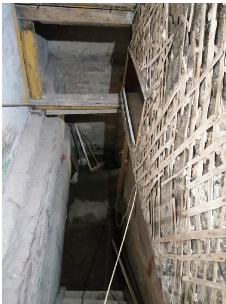
57. Помещение 30. Дата съемки 28.02.2024.
