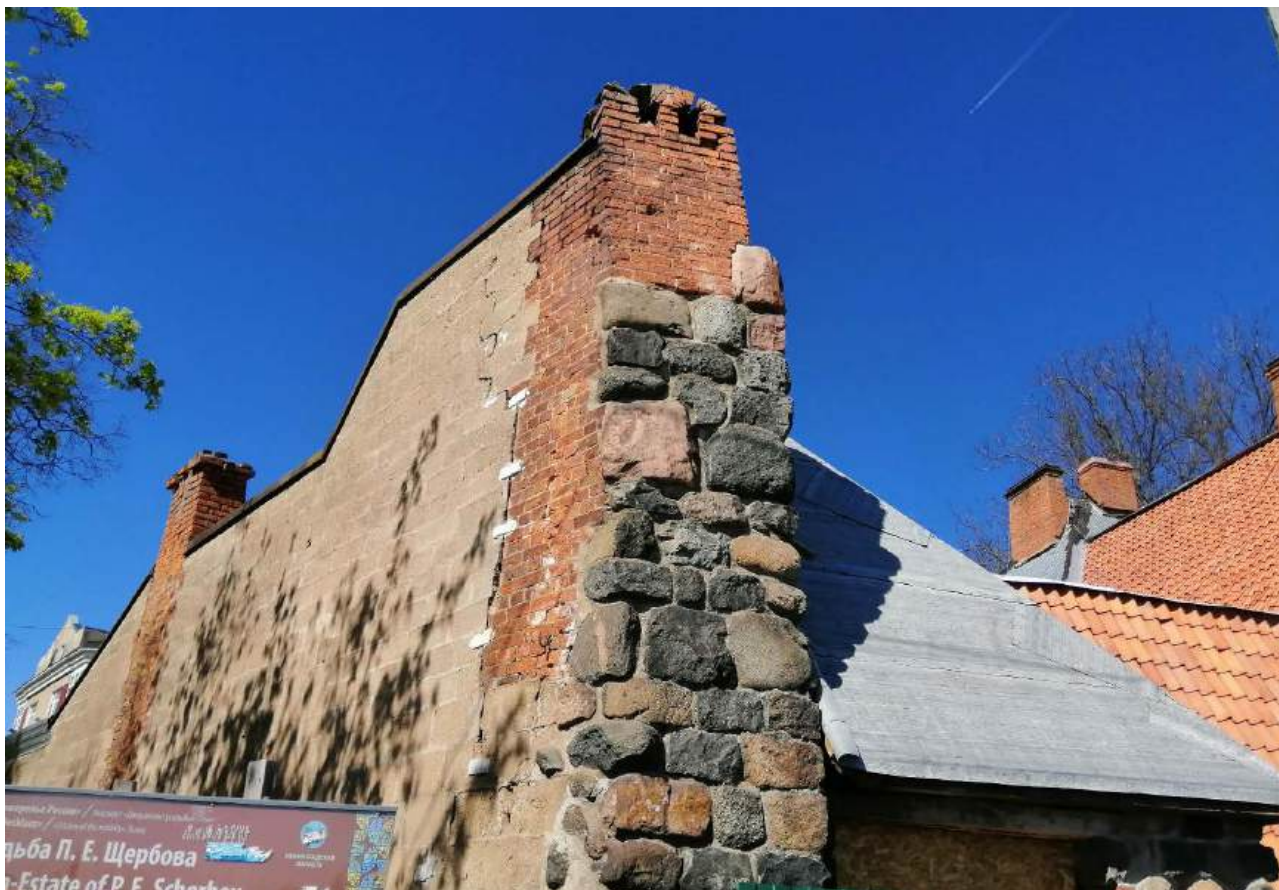
13. Вид на юго-восточный угол дворницкой. Дата съемки 16.05.2024.
