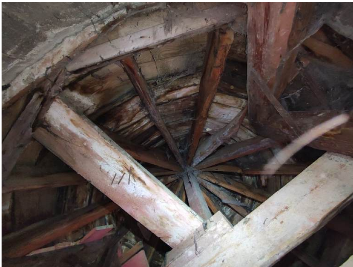
54. Помещение 28. Дата съемки 28.02.2024.
