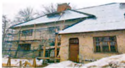
Южный (дворовый) фасад.
