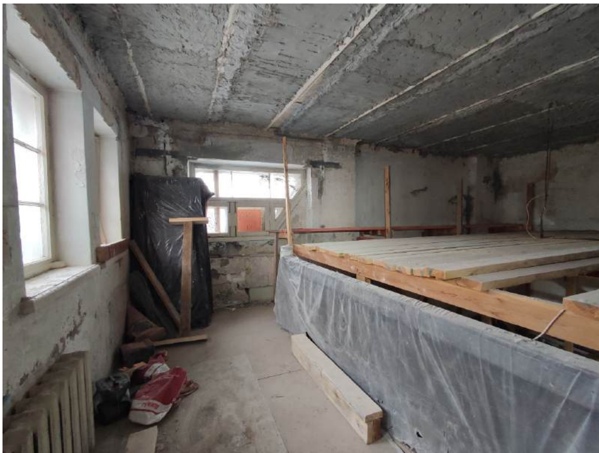
35. Помещение 1. Дата съемки 28.02.2024.
