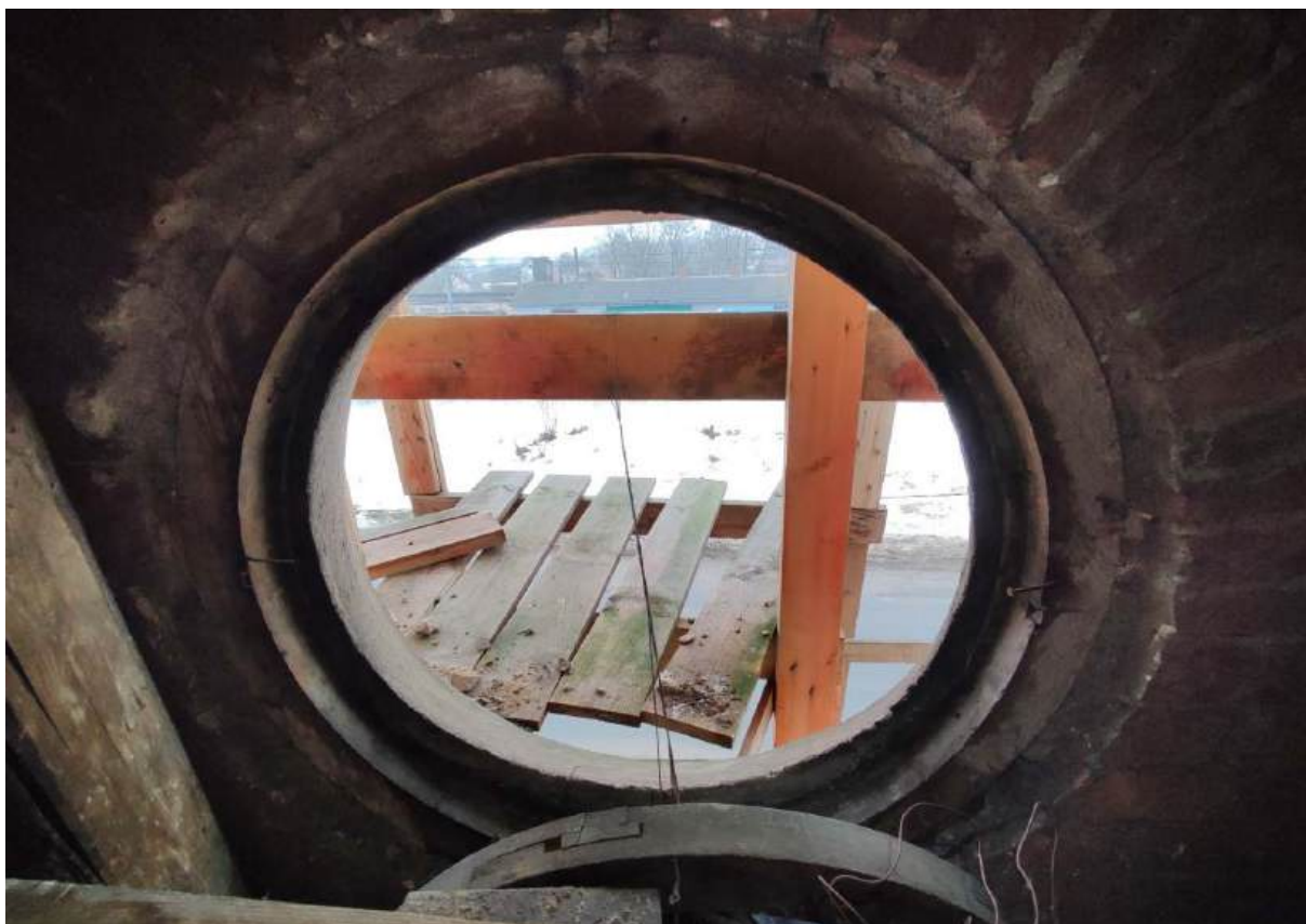
53. Помещение 28. Дата съемки 28.02.2024.
