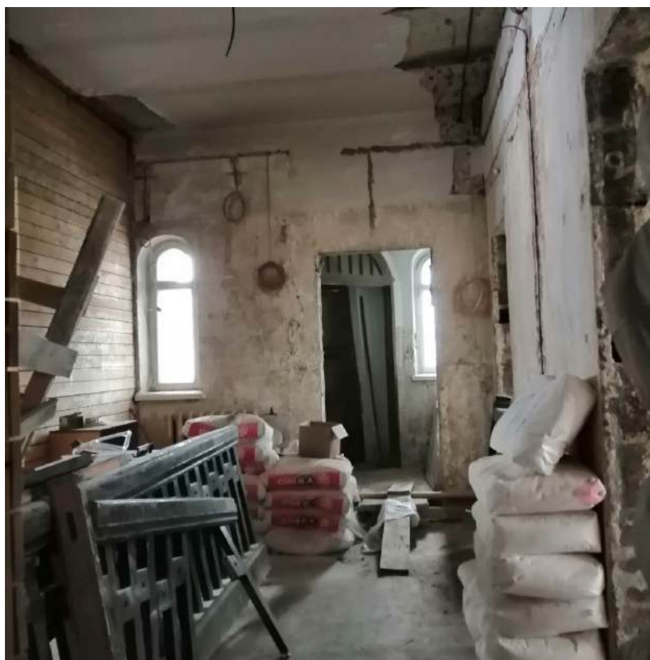
26. Помещение 9. Дата съемки 28.02.2024.
