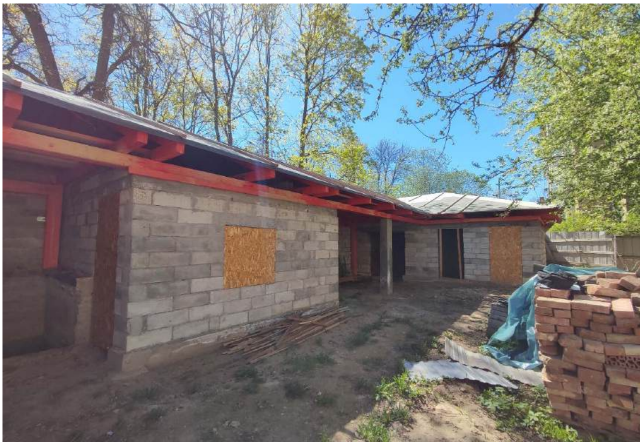
35. Вид с северо-востока на дворовый фасад служебных построек. Дата съемки 16.05.2024.
