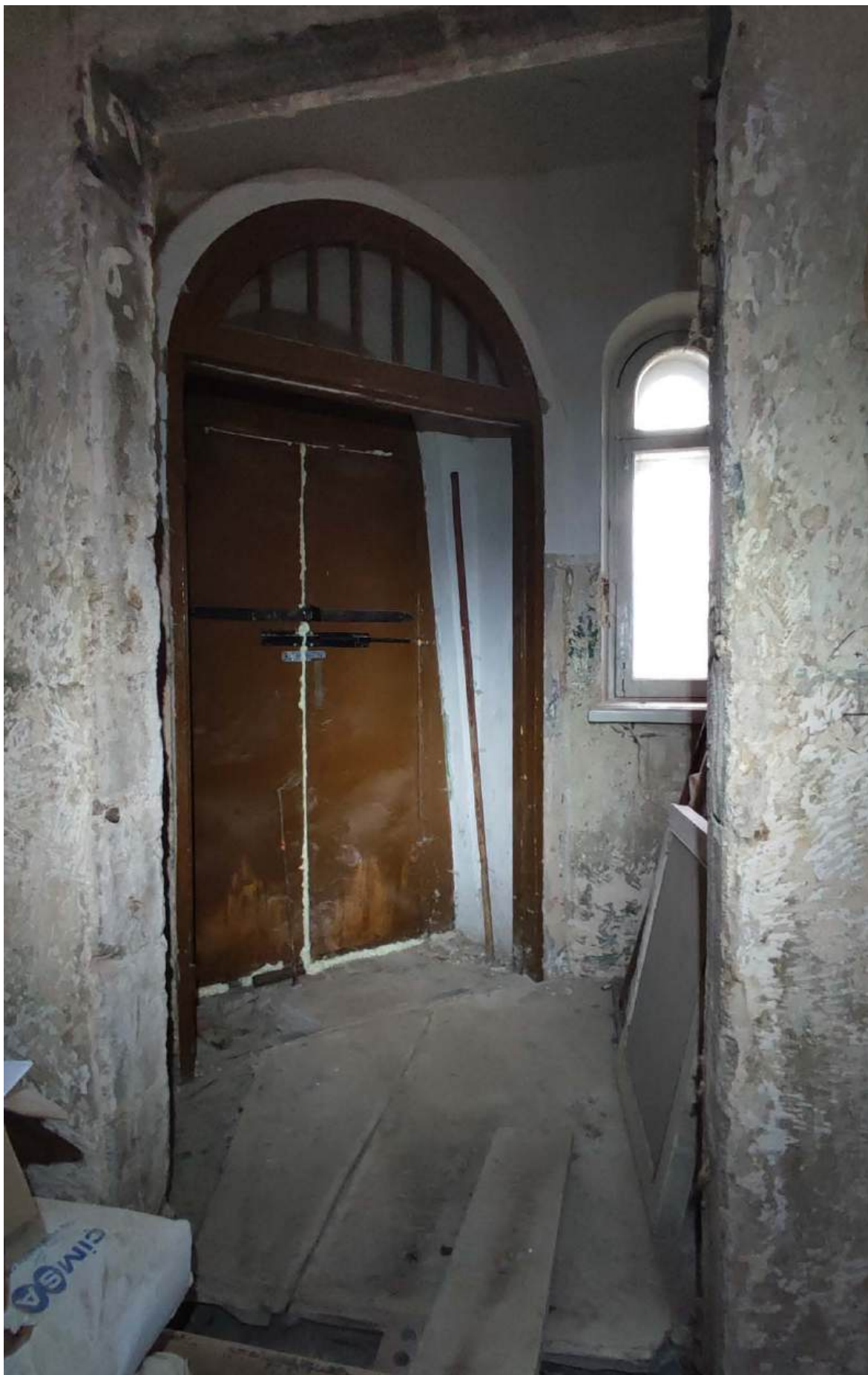
29. Помещение 9. Дата съемки 28.02.2024.
