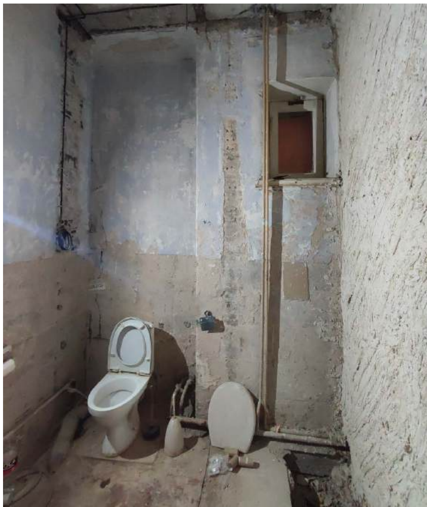
19. Помещение 15-16. Дата съемки 28.02.2024.
