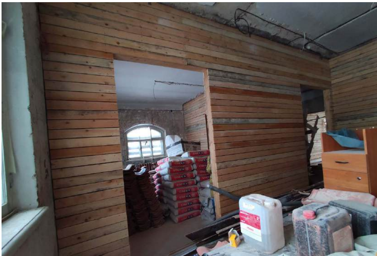
32. Помещение 7. Дата съемки 28.02.2024.
