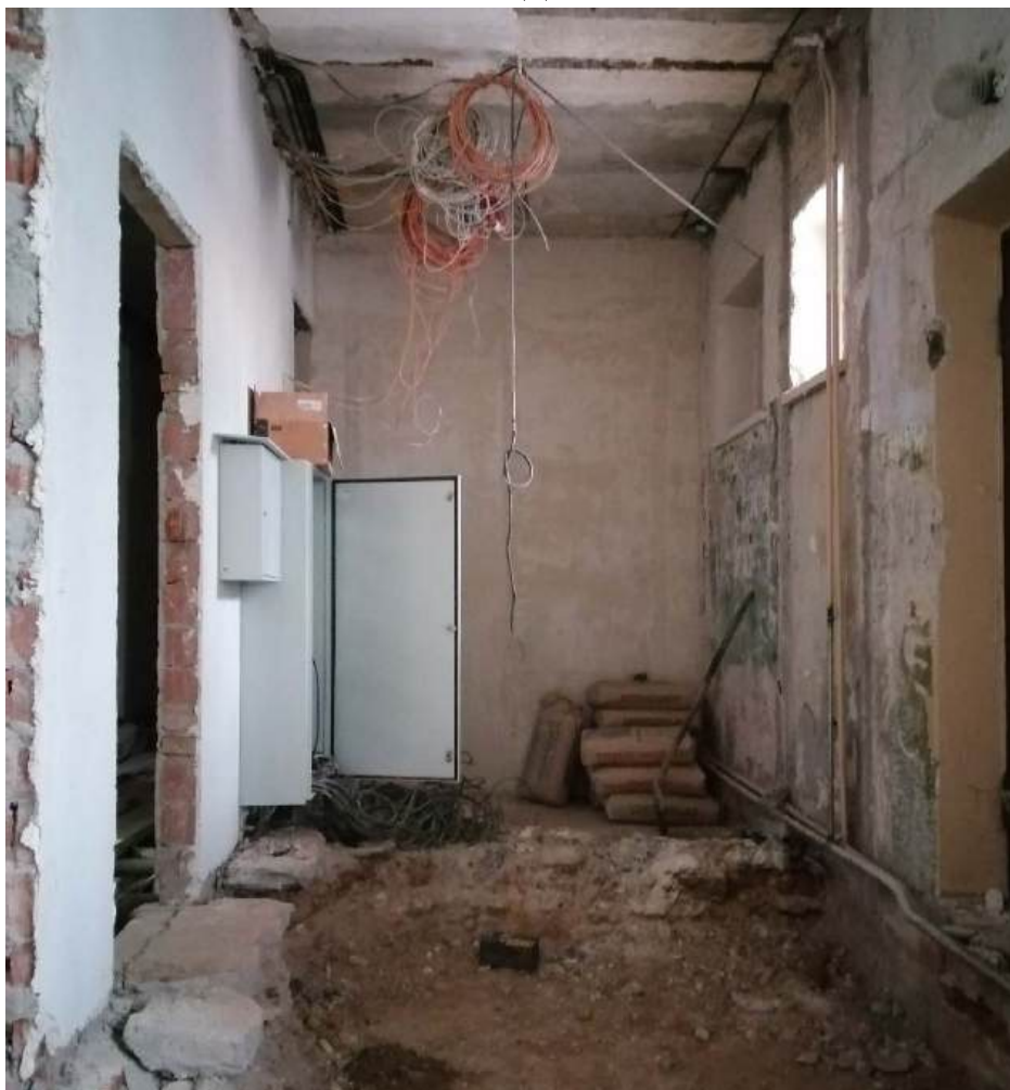
8. Помещения 2, 17-19. Дата съемки 28.02.2024.
