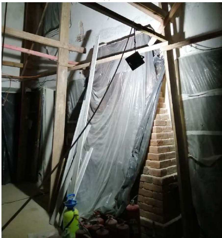
2. Помещение 1. Дата съемки 28.02.2024.
