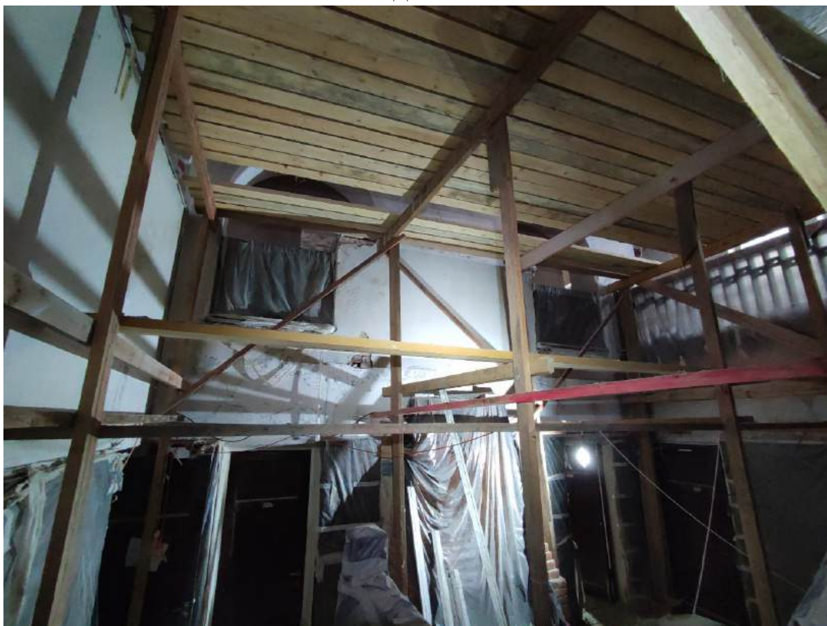
4. Помещение 1. Дата съемки 28.02.2024.
