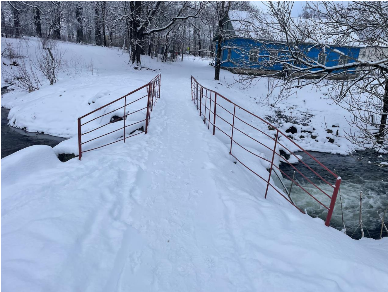
Фото № 5. Место производства работ. Фото Рябкова В. А. (03.02.2025 г.)
