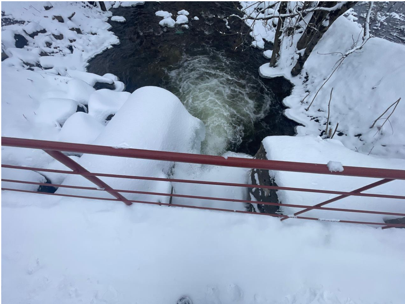
Фото № 6. Место производства работ. Фото Рябкова В. А. (03.02.2025 г.)
