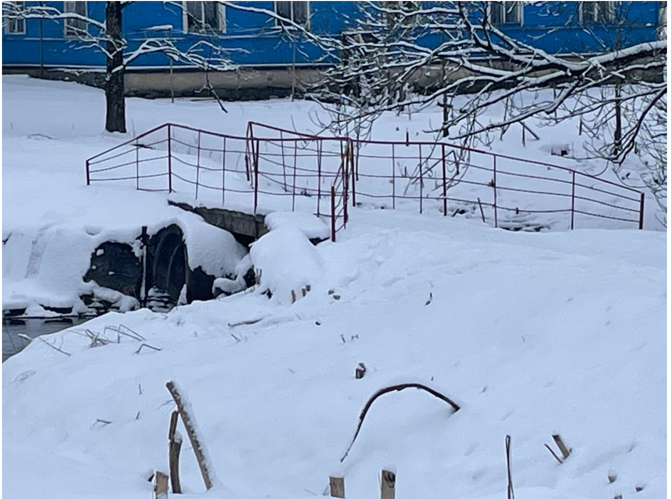
Фото № 2. Место производства работ. Фото Рябкова В. А. (03.02.2025 г.)
