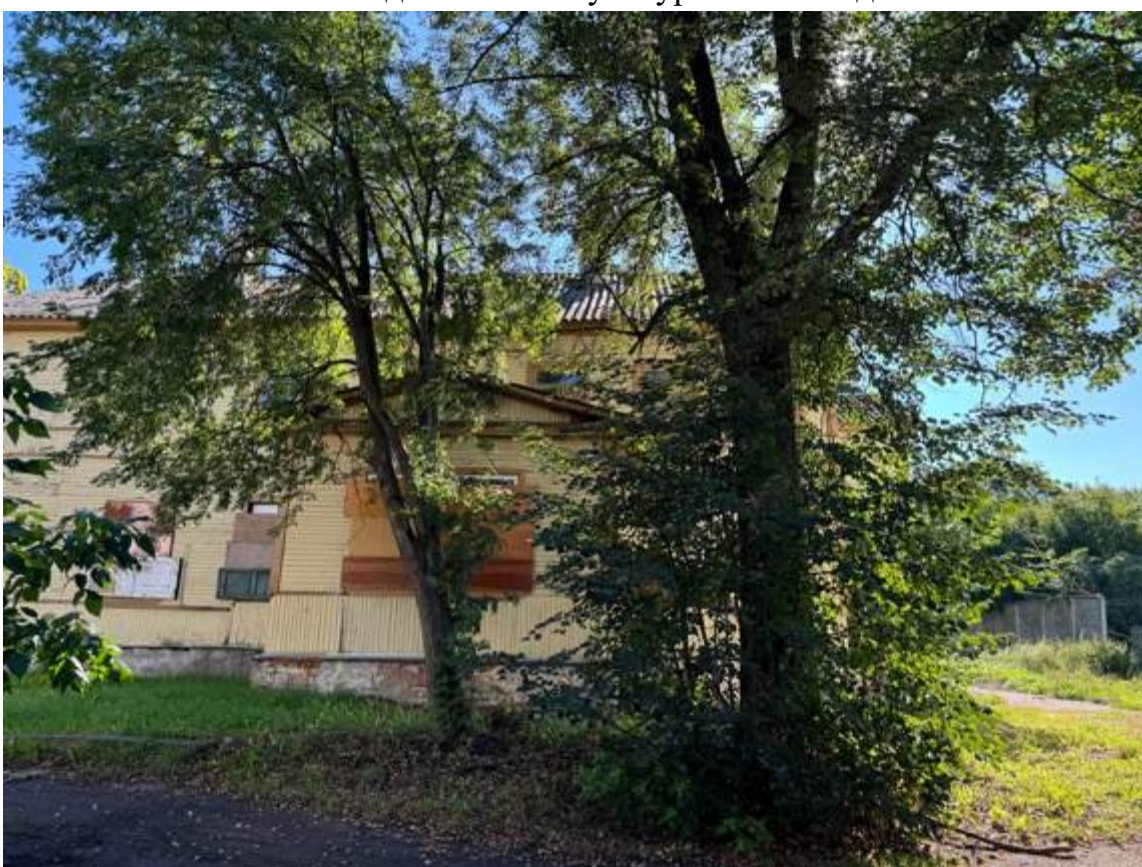
12. Вид на объект культурного наследия
