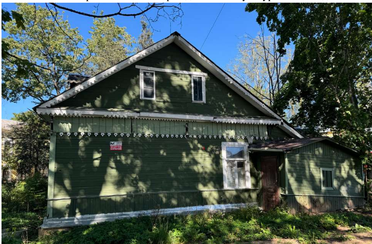
Фото 14. Фрагмент южного фасада объекта культурного наследия.
