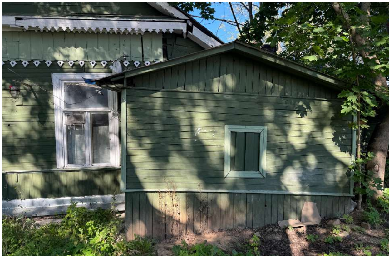
Фото 13. Фрагмент южного фасада объекта культурного наследия.
