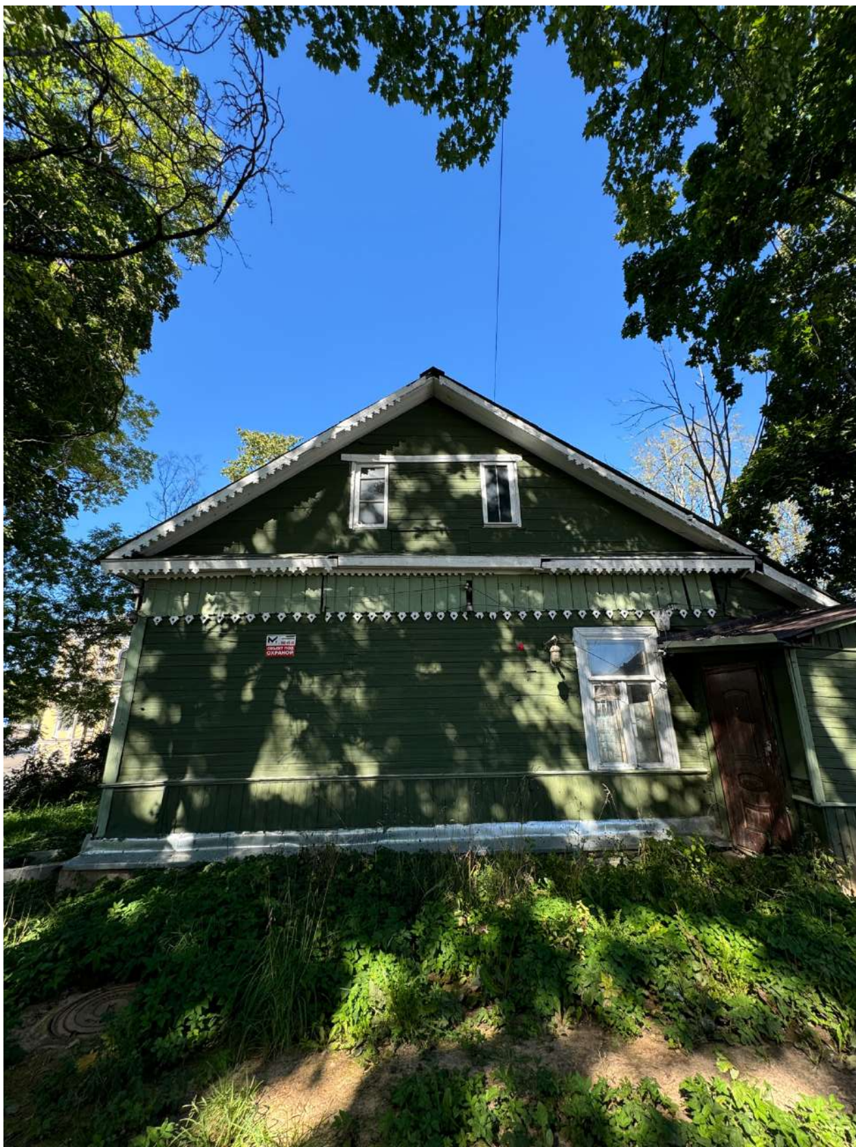
Фото 16. Фрагмент южного фасада объекта культурного наследия.
