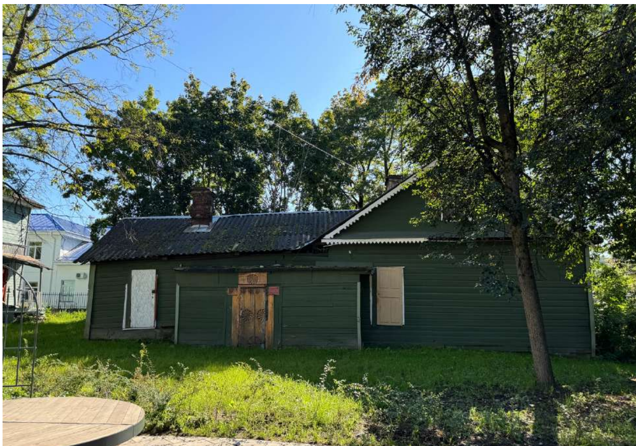
Фото 3. Общий вид северного фасада объекта культурного наследия.
