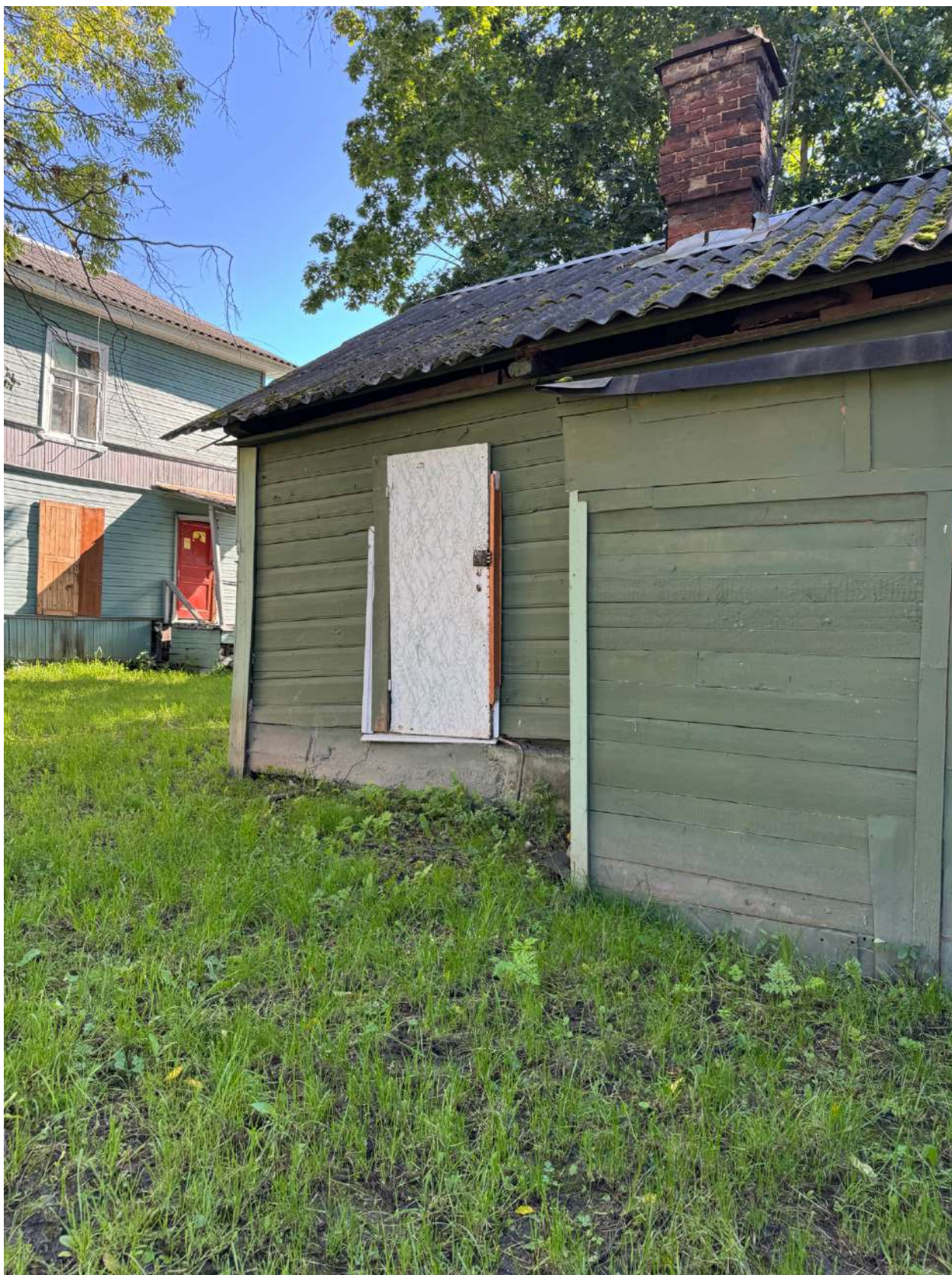
Фото 6. Фрагмент северного фасада объекта культурного наследия.
