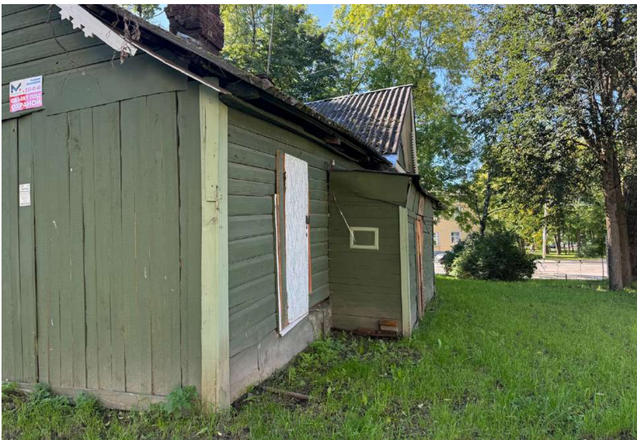
Фото 7. Фрагмент восточного и северного фасадов объекта культурного наследия.
