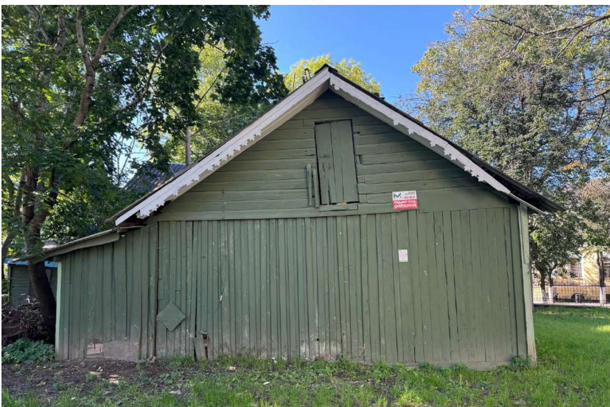
Фото 8. Общий вид восточного фасада объекта культурного наследия.
