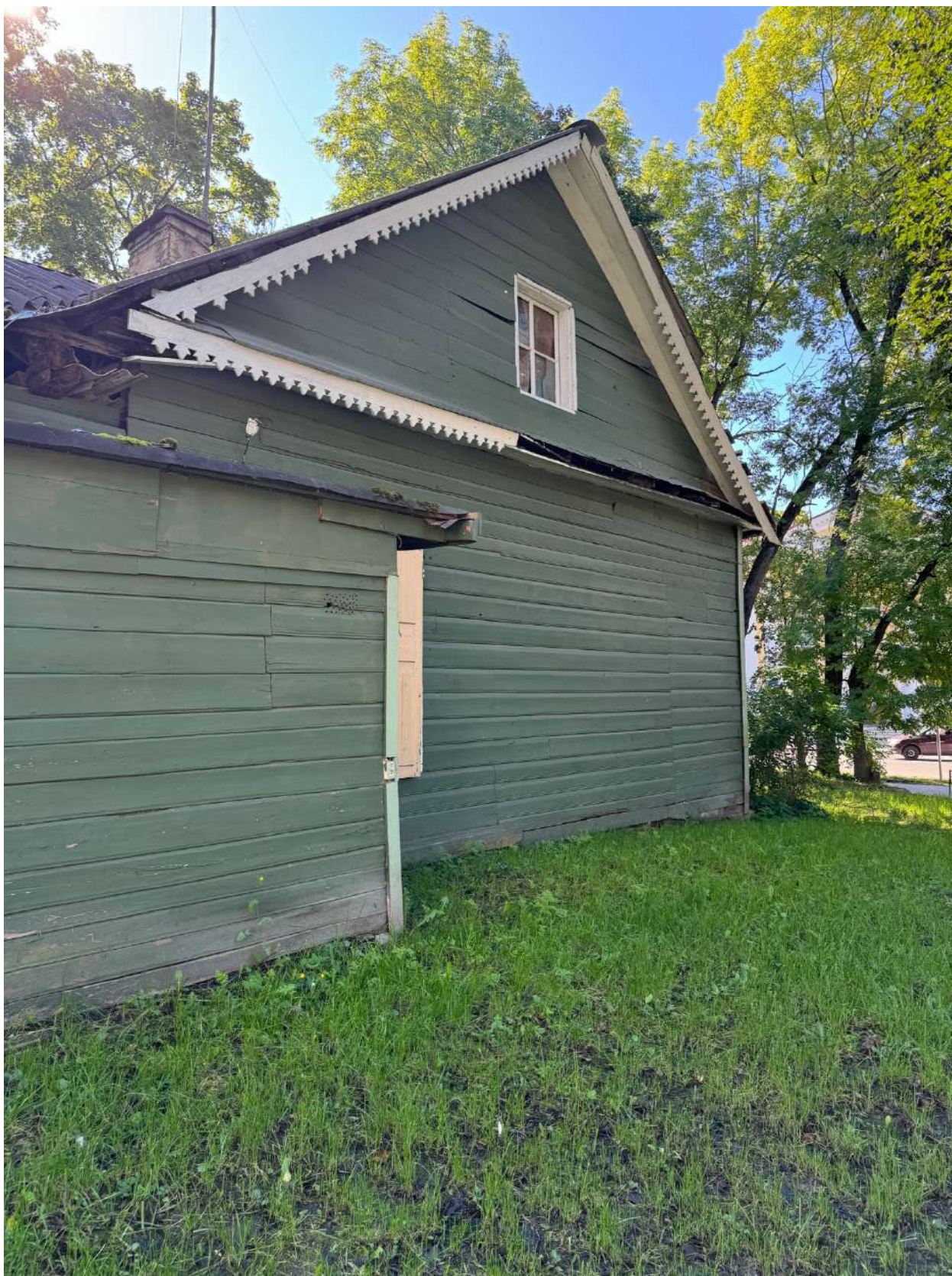
Фото 5. Фрагмент северного фасада объекта культурного наследия.
