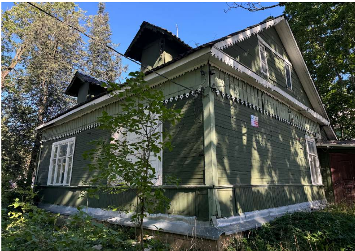
Фото 15. Вид с юга на фасады объекта культурного наследия.
