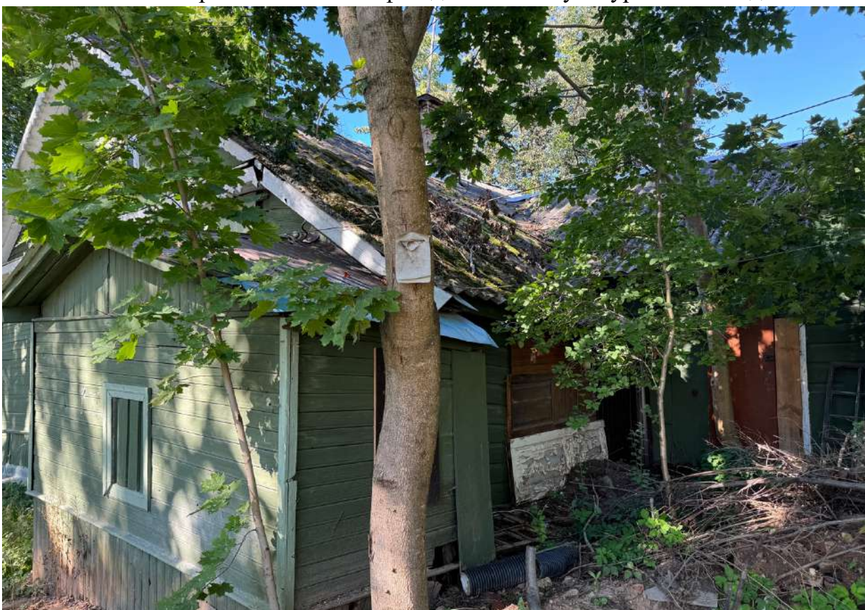
Фото 12. Фрагмент южного фасада объекта культурного наследия.
