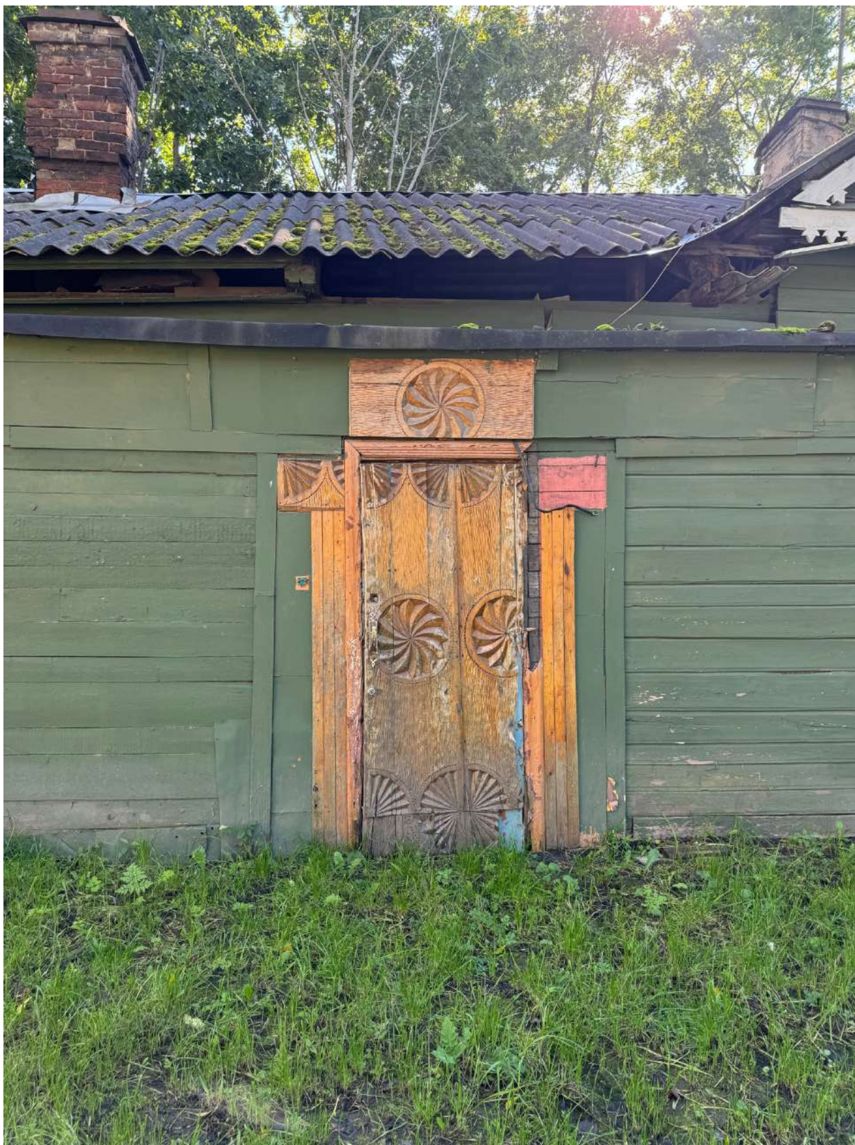
Фото 4. Фрагмент северного фасада объекта культурного наследия.
