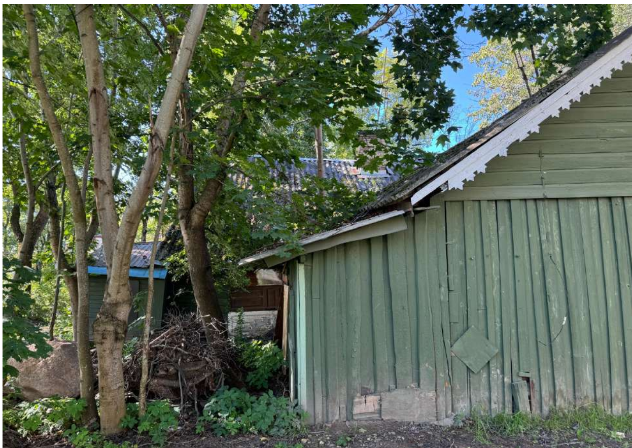
Фото 9. Фрагмент восточного фасада объекта культурного наследия.
