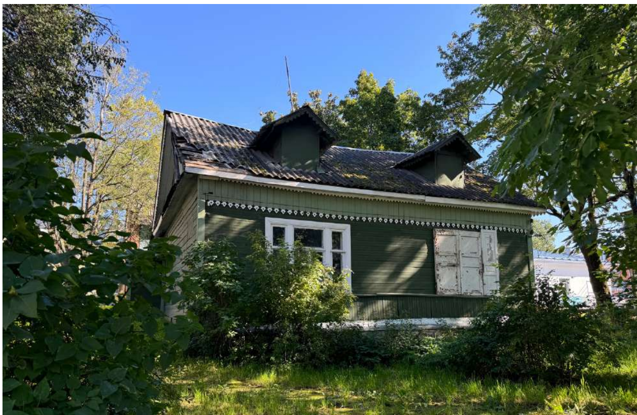
Фото 1. Общий вид западного фасада объекта культурного наследия.
