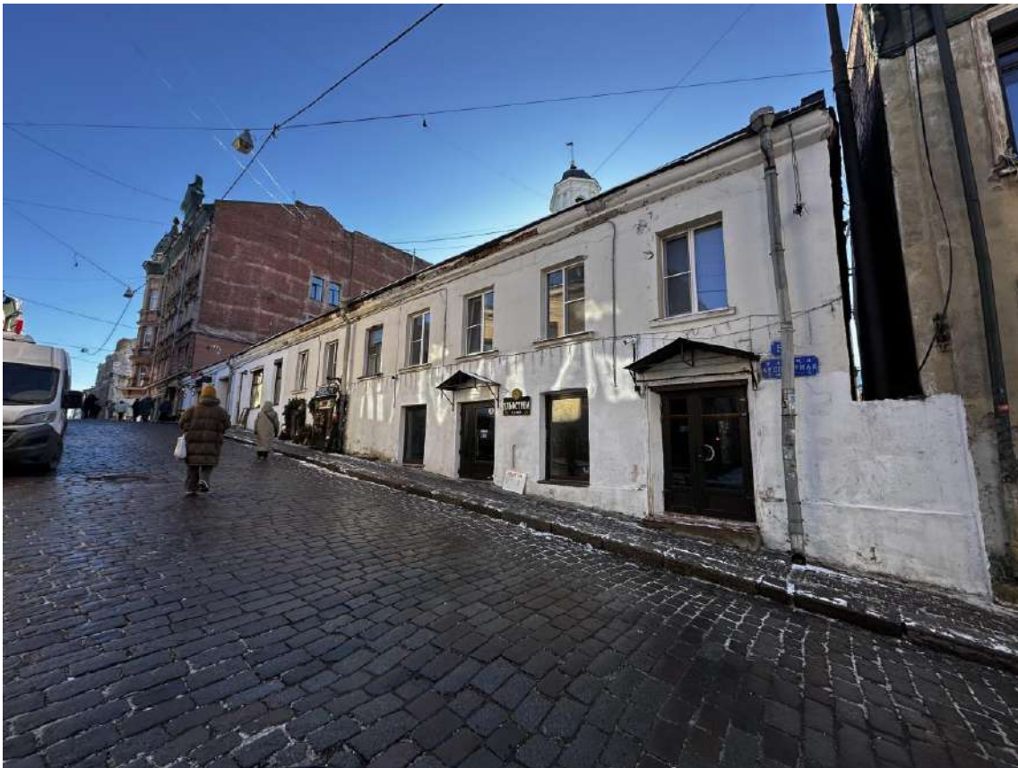
Фото 1. Общий вид здания с севера, с ул. Крепостной. Дата съемки: 20.04.2024 г. Автор съемки: Глинская Н.Б.
