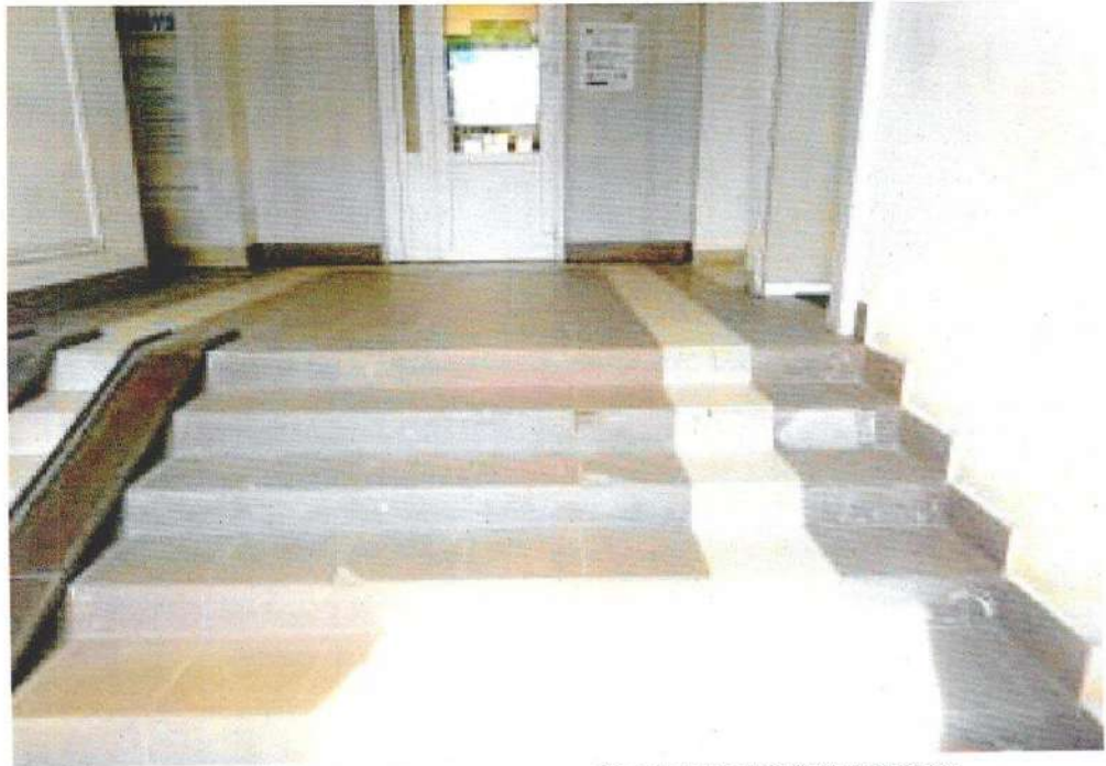
Фото 8. Ступени главного входа в объект культурного наследия
