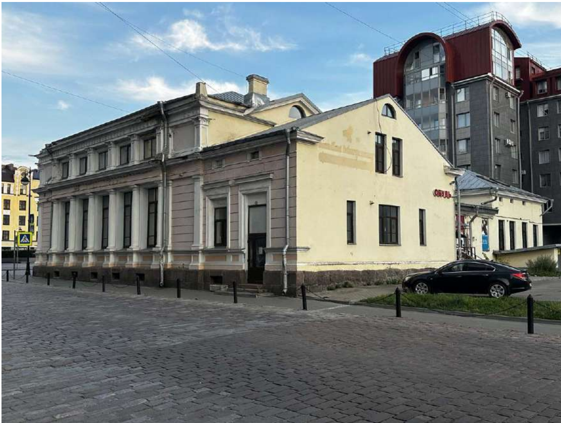
Фото 3. Общий вид здания с ул. Северной, с севера. Дата съемки: 25.09.2024 г. Автор съемки: Куваева Ю.П.
