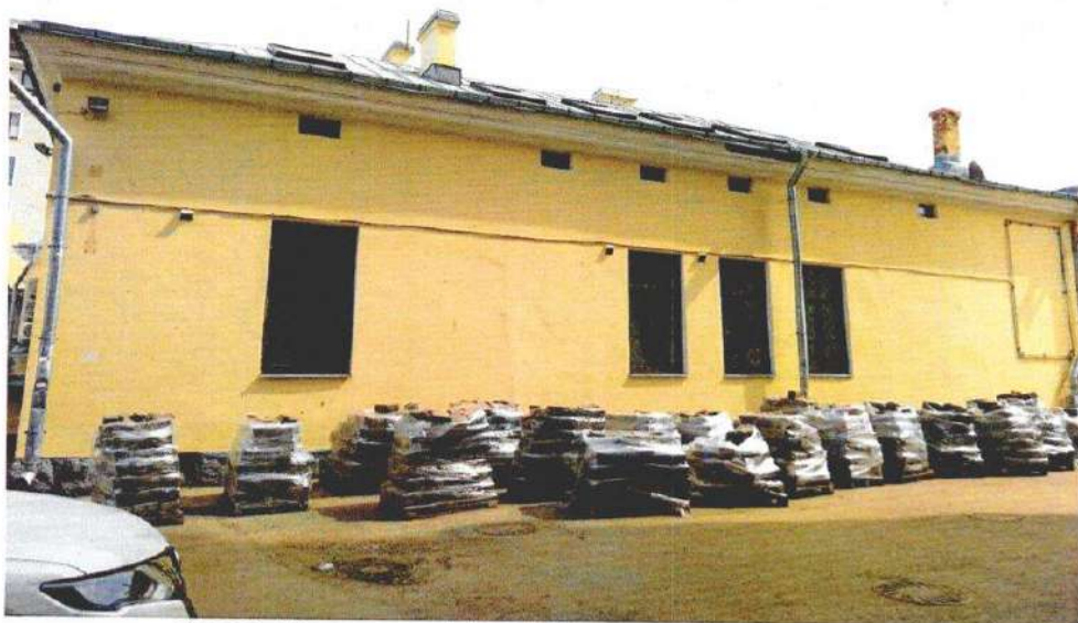
Фото 6. Юго-западный фасад объекта культурного наследия
