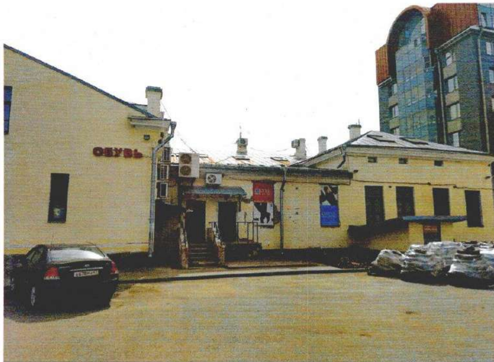
Фото 5. Северо-западный (дворовый) фасад объекта культурного наследия
