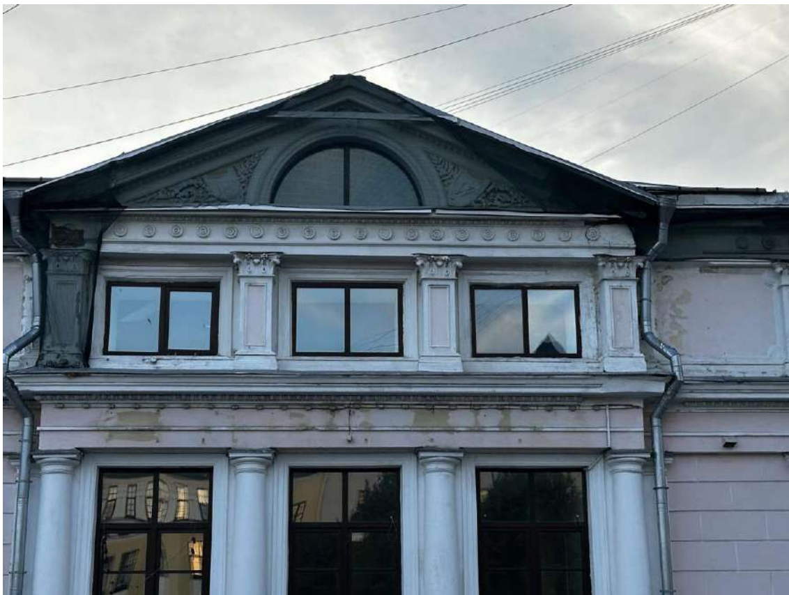
Фото 10. Фрагмент повышенной правой части лицевого юго-восточного фасада. Дата съемки: 25.09.2024 г. Автор съемки: Куваева Ю.П.
