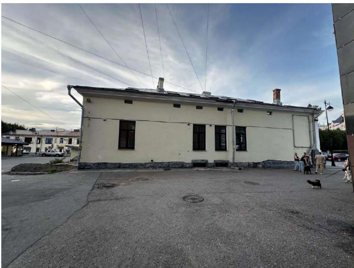
Фото 23. Общий вид бокового юго-западного фасада здания. Дата съемки: 25.09.2024 г. Автор съемки: Куваева Ю.П.
