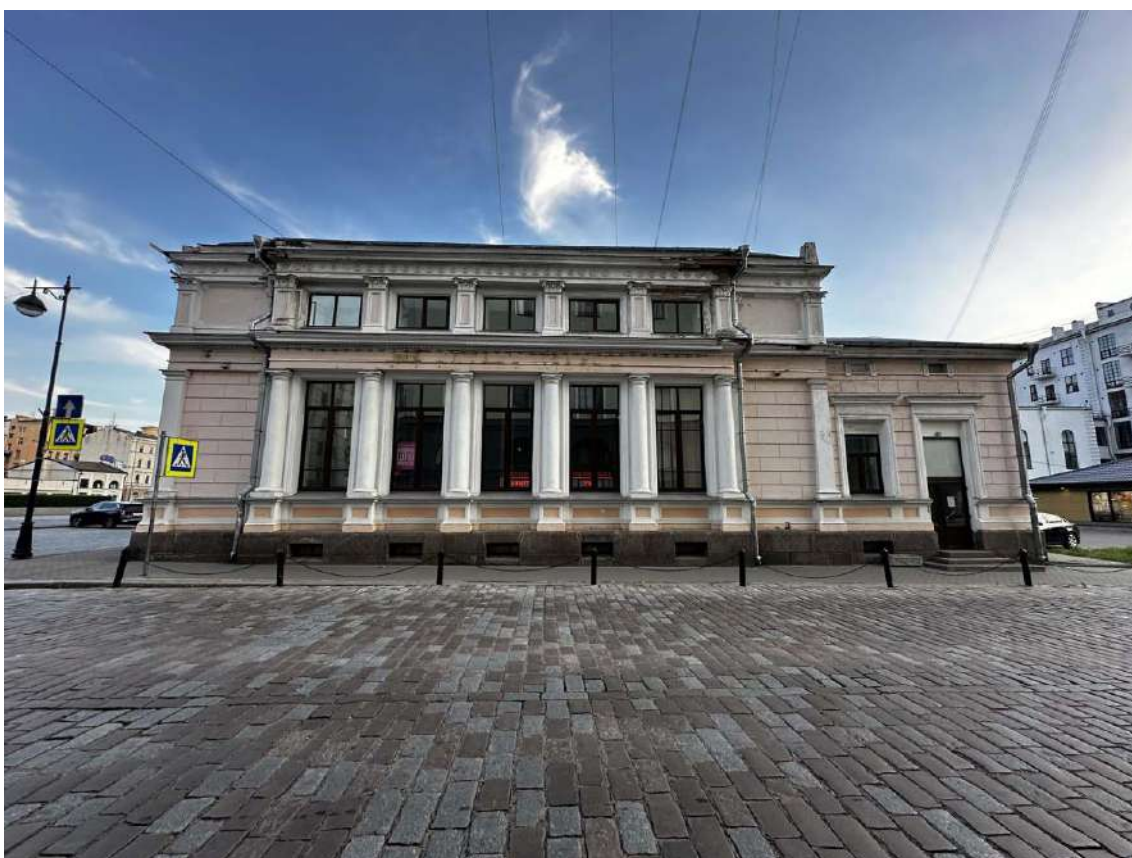
Фото 11. Общий вид уличного северо-восточного фасада здания. Дата съемки: 25.09.2024 г. Автор съемки: Куваева Ю.П.
