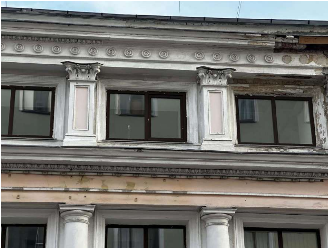
Фото 14. Фрагмент повышенной правой части уличного северо-восточного фасада здания. Дата съемки: 25.09.2024 г. Автор съемки: Куваева Ю.П.
