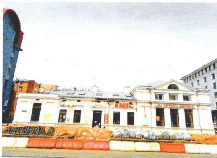
Фото 2. Вид на объект культурного наследия с улицы Ушакова
