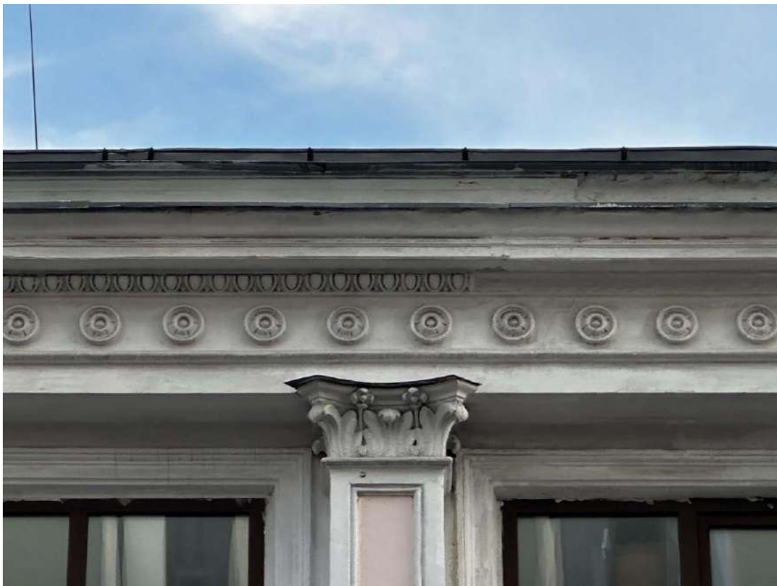
Фото 16. Фрагмент повышенной правой части уличного северо-восточного фасада здания. Дата съемки: 25.09.2024 г. Автор съемки: Куваева Ю.П.
