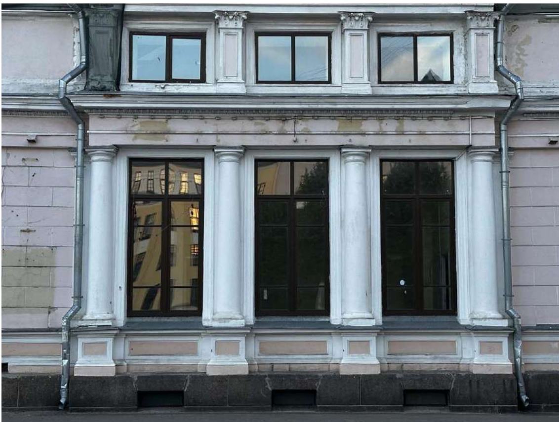
Фото 9. Фрагмент повышенной правой части лицевого юго-восточного фасада. Дата съемки: 25.09.2024 г. Автор съемки: Куваева Ю.П.
