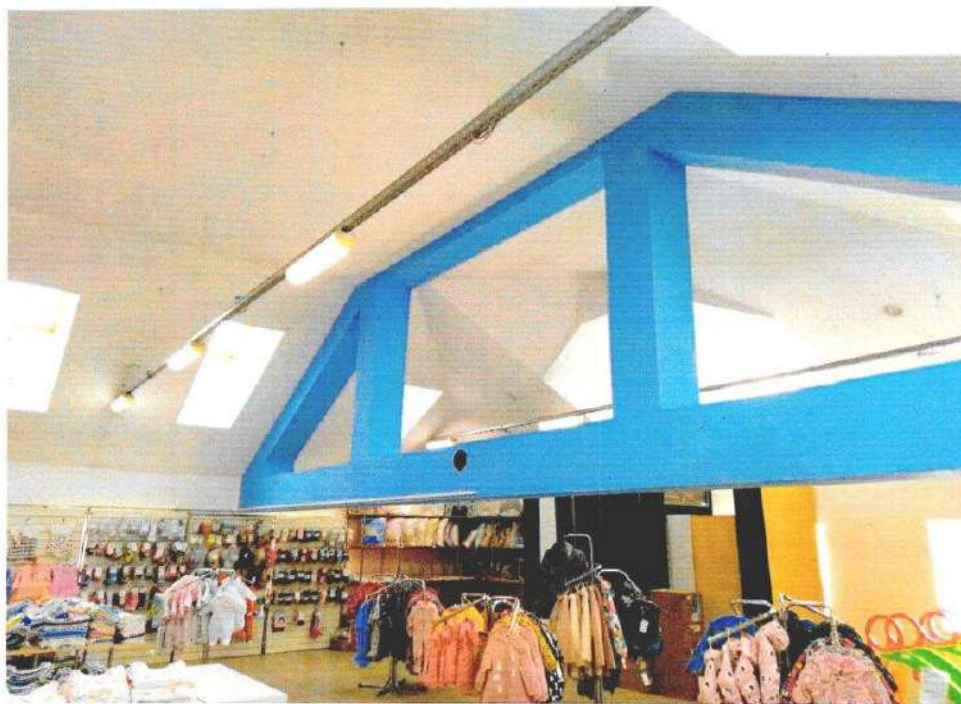
Фото 9. Мансардное помещение объекта культурного наследия
