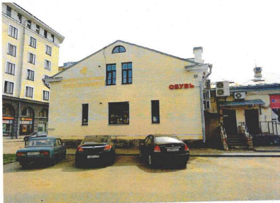
Фото 4. Северо-западный (дворовый) фасад объекта культурного наследия
