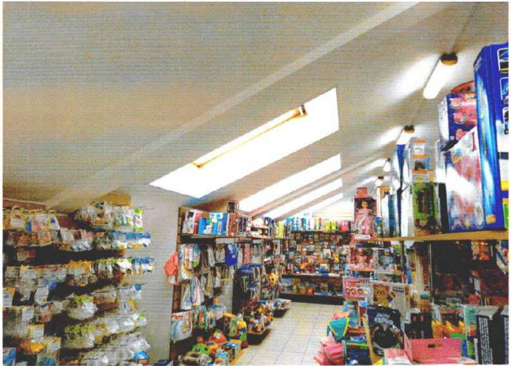
Фото 7. Интерьер объекта культурного наследия (устройство мансардных окон)
