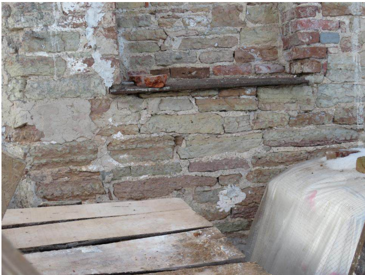
Фото 6. Фрагмент каменной кладки, оконная ниша северо-восточного угла четверика. Чугунные подоконные доски. Церковь во имя св. А.Невского. 08.02.2025г.
