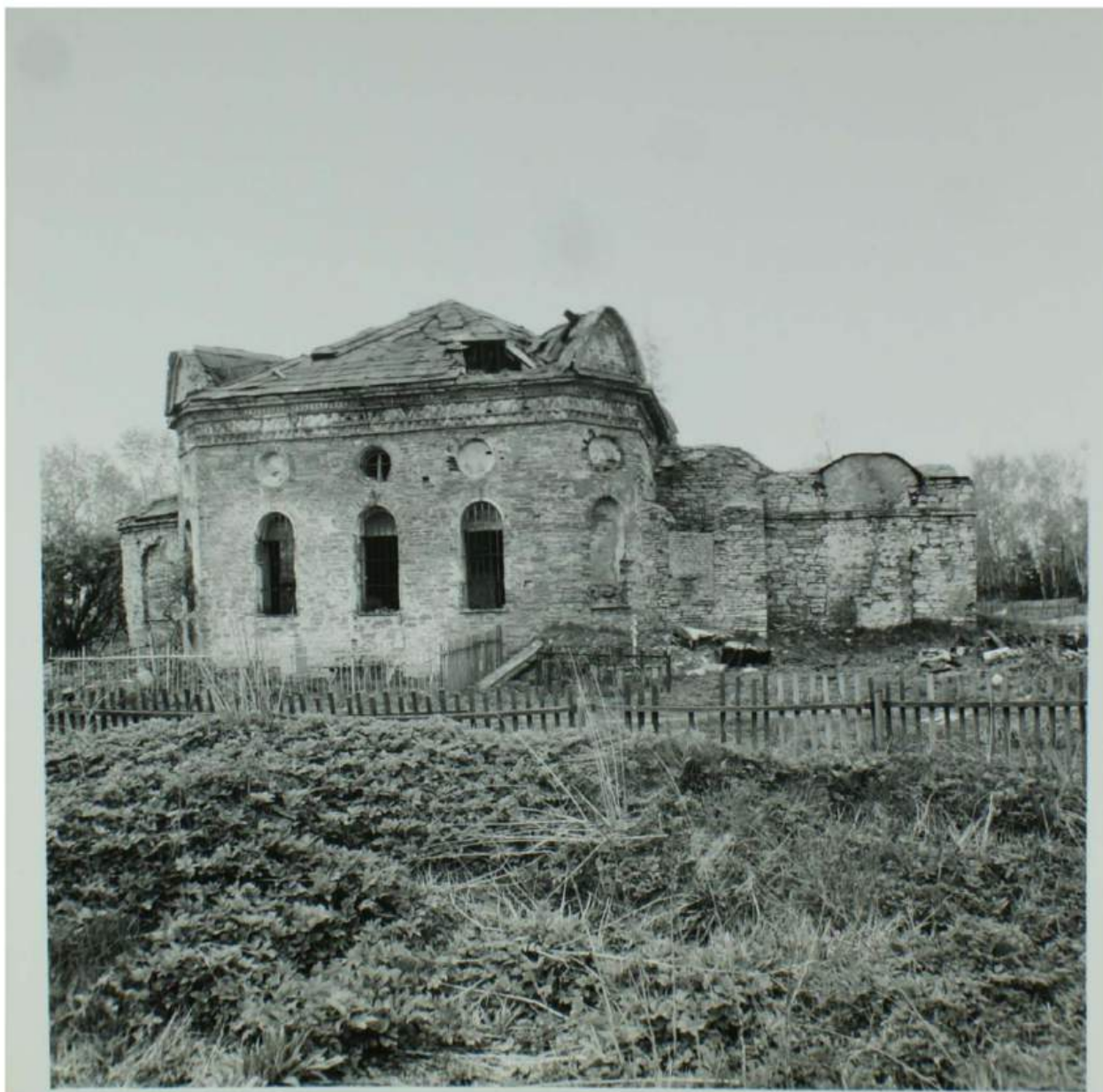
Ленинградская обл, Гатчинский район, Деревня Александровка, Церковь Александра Невского, 1790-1794 гг. Вид с северо-запада. Фото 1990 г. В.Я. Никифорова.
