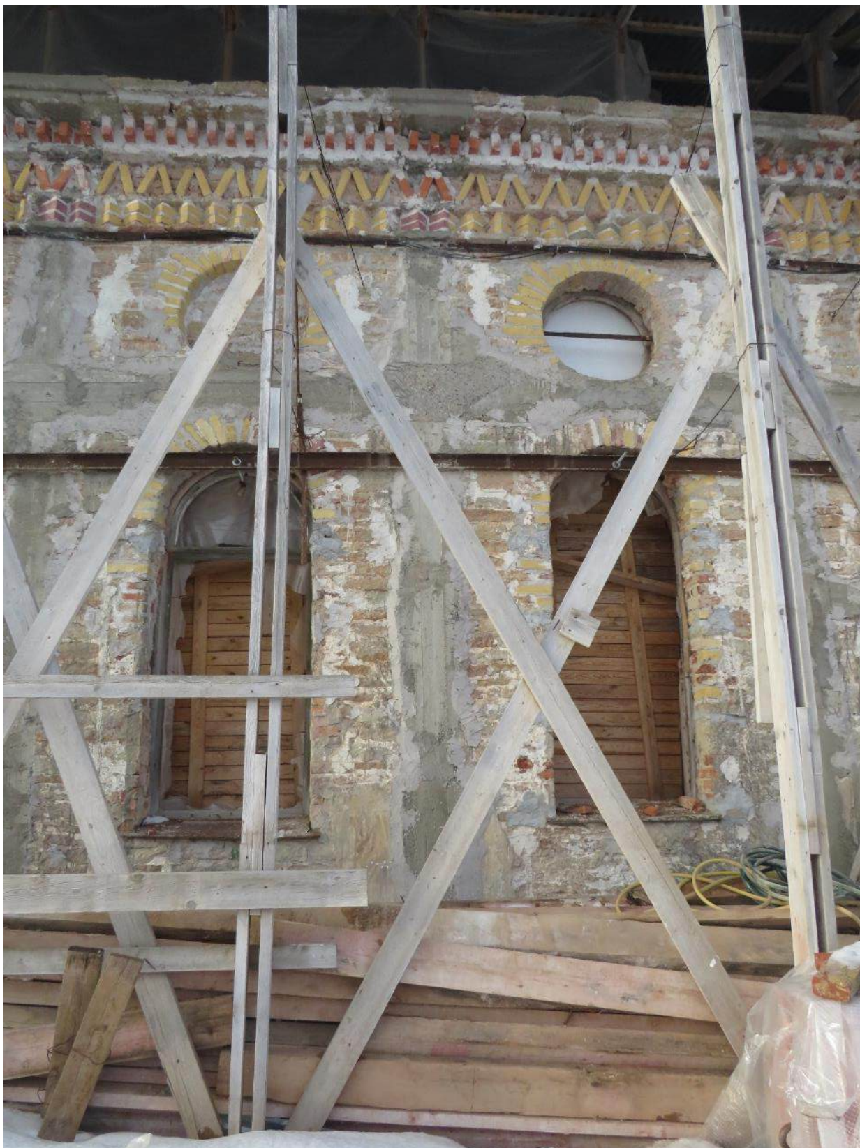
Фото 5. Фрагмент северного фасада. Усиление ж/б балками. Церковь во имя св. А.Невского. 08.02.2025г.
