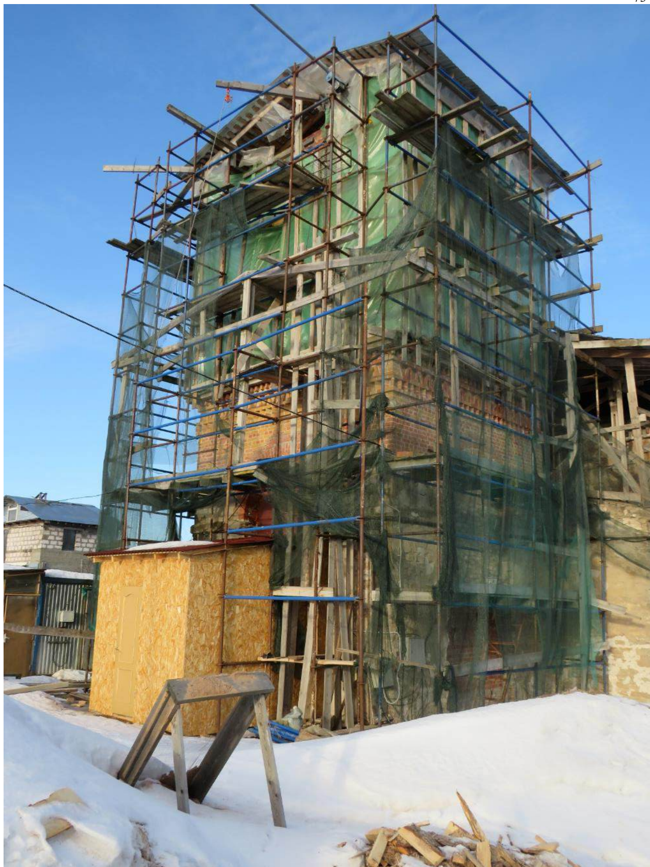
Фото 4. Западный фасад. Церковь во имя св. А.Невского. 08.02.2025г.
