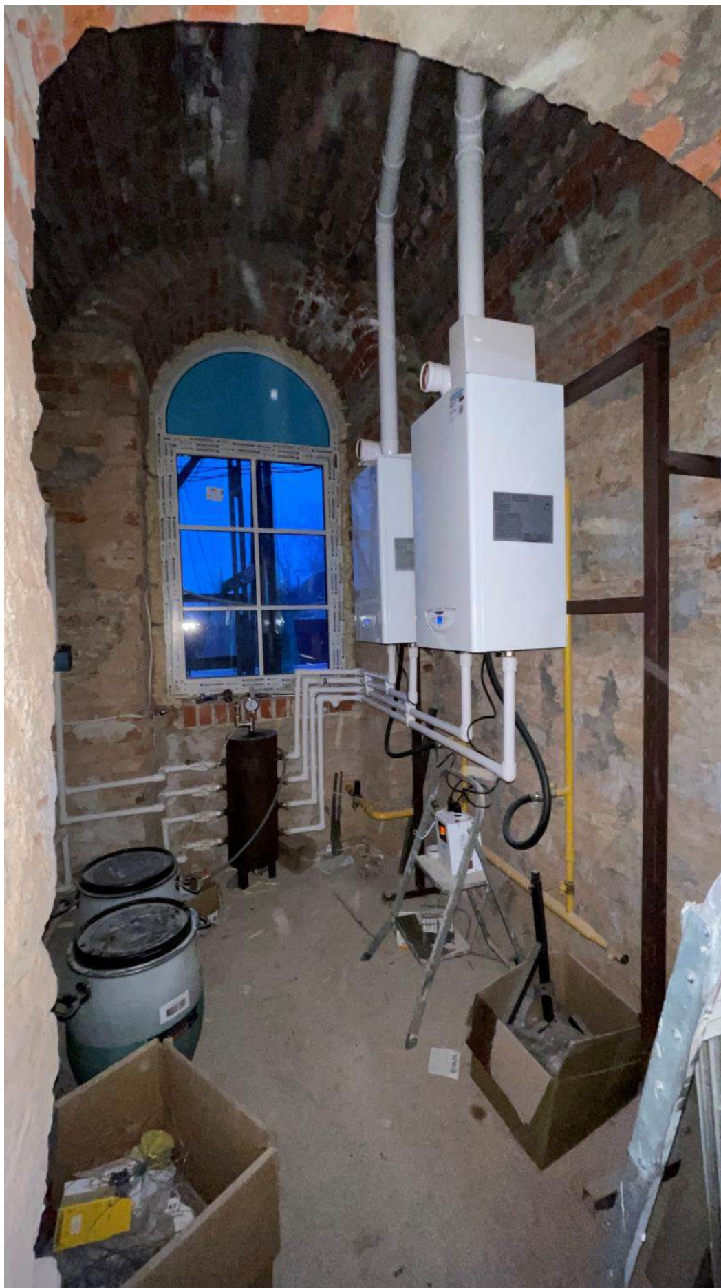
Фото 11. Внутреннее помещение в осях 2-3/В-Е Церковь во имя св. А.Невского. 08.02.2025г.
