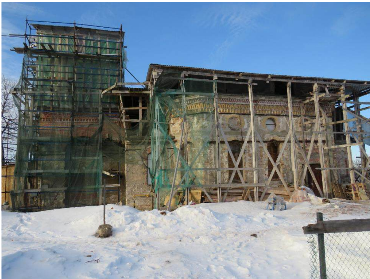
Фото 2. Южный фасад. Церковь во имя св. А.Невского. 08.02.2025г.
