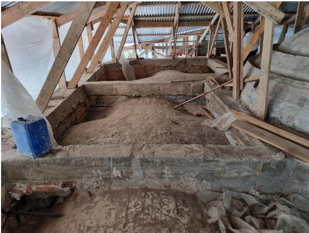
Фото 18. Подкровельное пространство центрального четверика. Церковь во имя св. А.Невского. 08.02.2025г.
