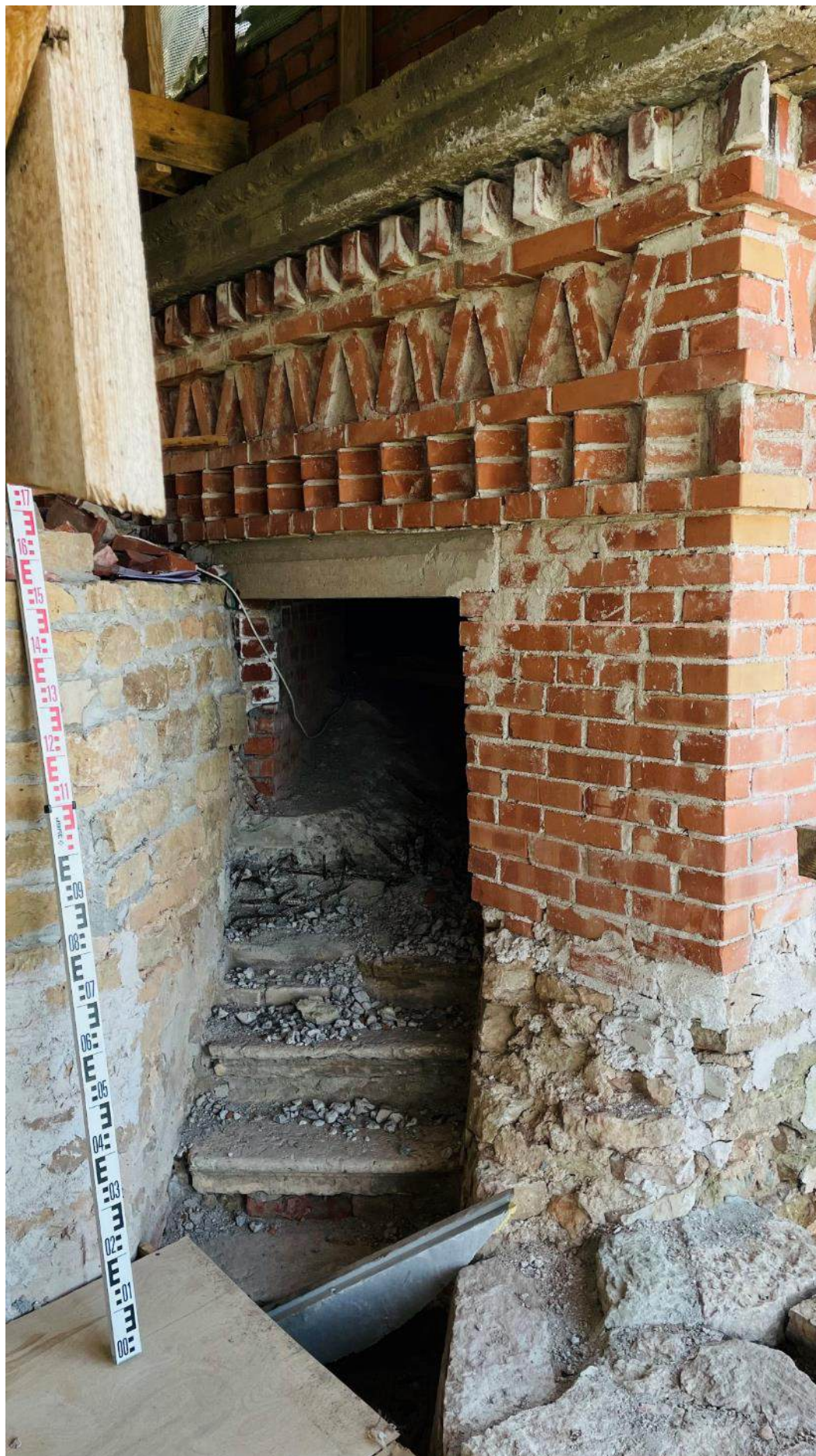
Фото 17. Внутренняя лестница переход в колокольню. Церковь во имя св. А.Невского. 08.02.2025г.
