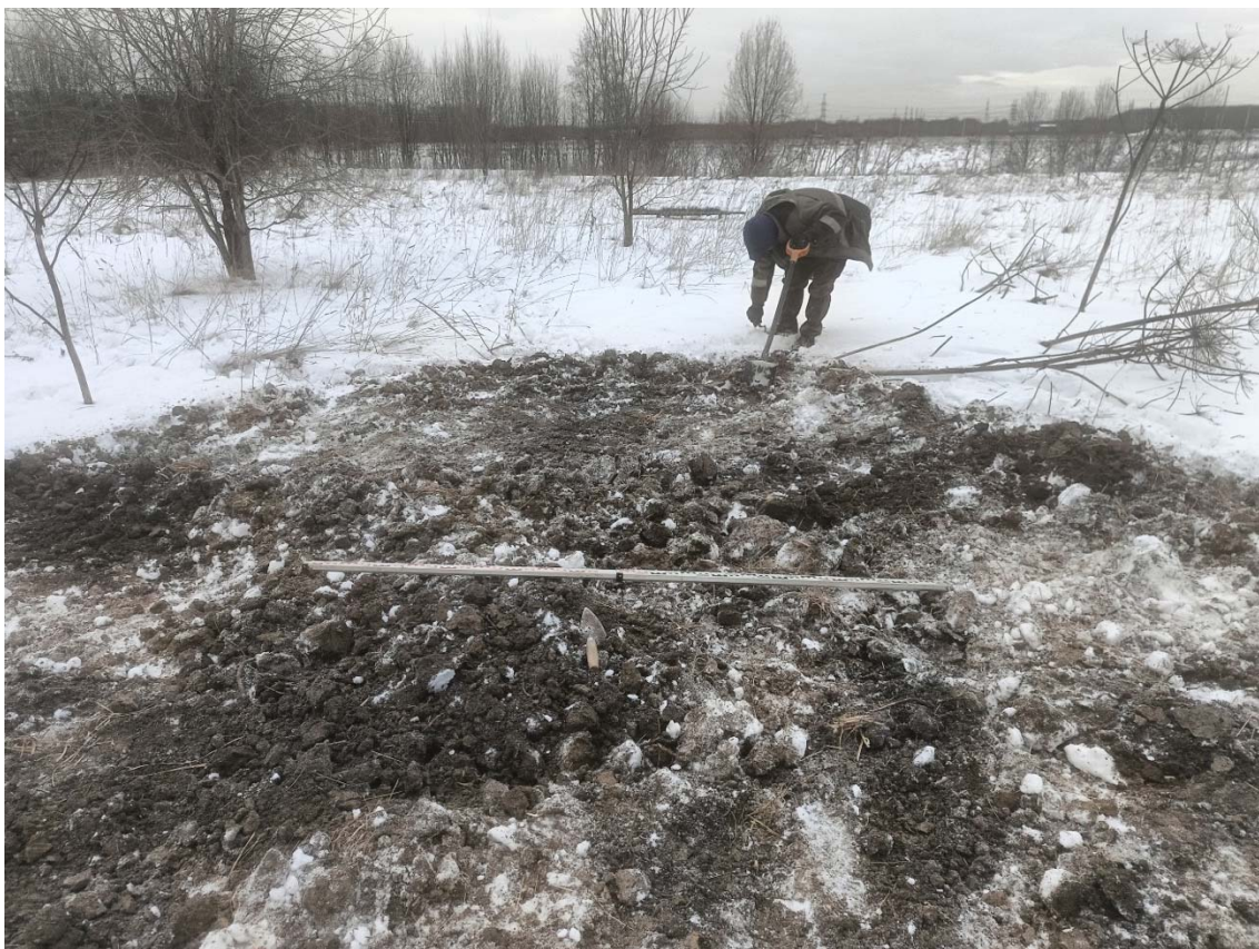
Рис. 64. ЛО-2025. Новосергиевка. КН: 47:07:1044001:81261. Шурф 4 после рекультивации, вид с востока.
