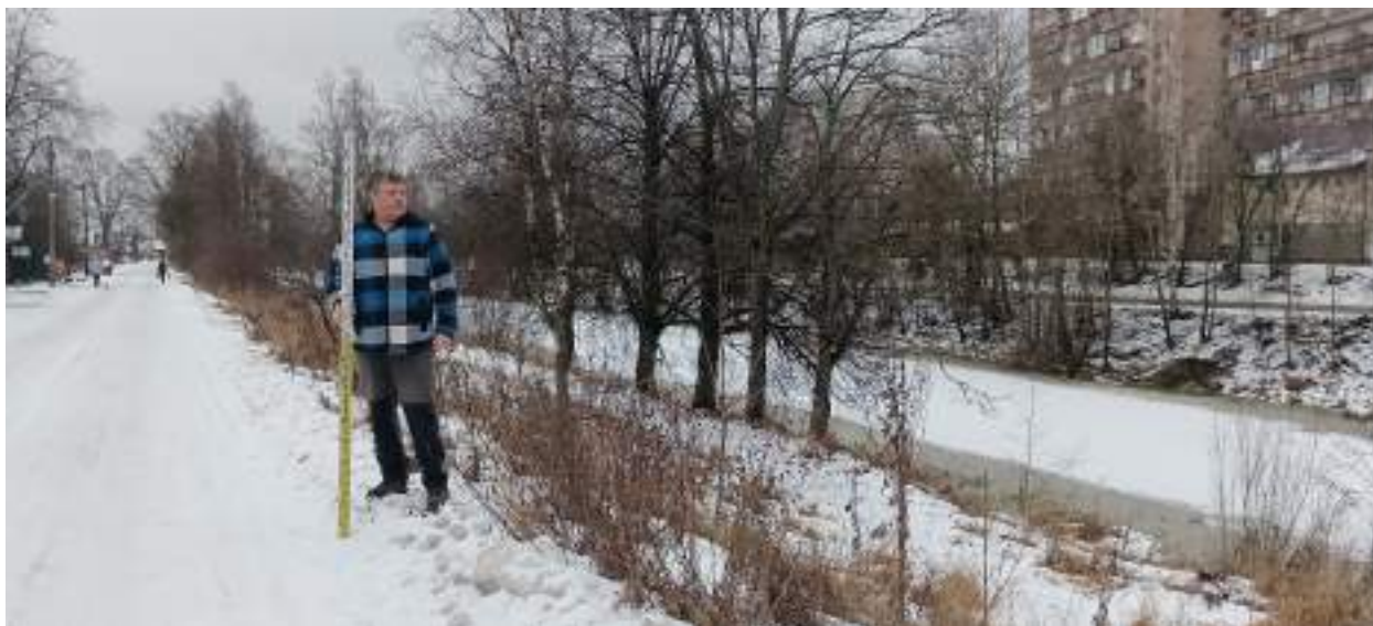
ТФ 2.1. Ленинградская область, г. Шлиссельбург. «Распределительный газопровод и газопроводы-вводы по г. Шлиссельбург (2-й этап)». Контур (отрезок) №2. Общий вид на место расположения технологического приемка. 1ПК5+43,00. Вид с СЗ.
