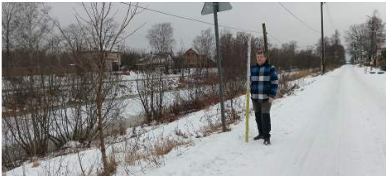
ТФ 2.7. Ленинградская область, г. Шлиссельбург. «Распределительный газопровод и газопроводы-вводы по г. Шлиссельбург (2-й этап)». Контур (отрезок) №2. Общий вид на место расположения технологического приямка. 2ПК6+88,50. Вид с ЮЮВ.
