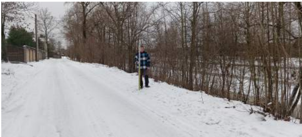
ТФ 3.1. Ленинградская область, г. Шлиссельбург. «Распределительный газопровод и газопроводы-вводы по г. Шлиссельбург (2-й этап)». Контур (отрезок) №3. Общий вид на место расположения технологического приемка. ЗПК4+13.50. Вид с ССЗ.
