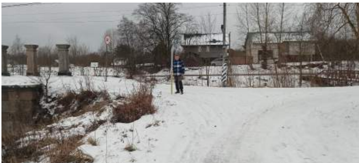
ТФ 3.2. Ленинградская область, г. Шлиссельбург. «Распределительный газопровод и газопроводы-вводы по г. Шлиссельбург (2-й этап)». Контур (отрезок) №3. Общий вид на место расположения технологического прямка. ЗПК2+91,50. Вид с ВСВ.
