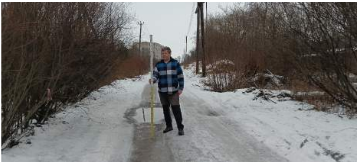
ТФ 1.2. Ленинградская область, г. Шлиссельбург. «Распределительный газопровод и газопроводы-вводы по г. Шлиссельбург (2-й этап)». Контур (отрезок) №1. Общий вид на место расположения технологического приемка. ПК2+97,50. Вид с ЮЗ.
