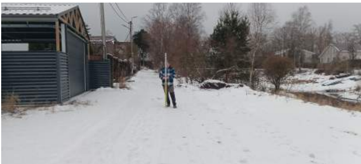
ТФ 4.2. Ленинградская область, г. Шлиссельбург. «Распределительный газопровод и газопроводы-вводы по г. Шлиссельбург (2-й этап)». Контур (отрезок) №4. Общий вид на место расположения технологического прямка. 4ПК1+56,00. Вид с ВСВ.
