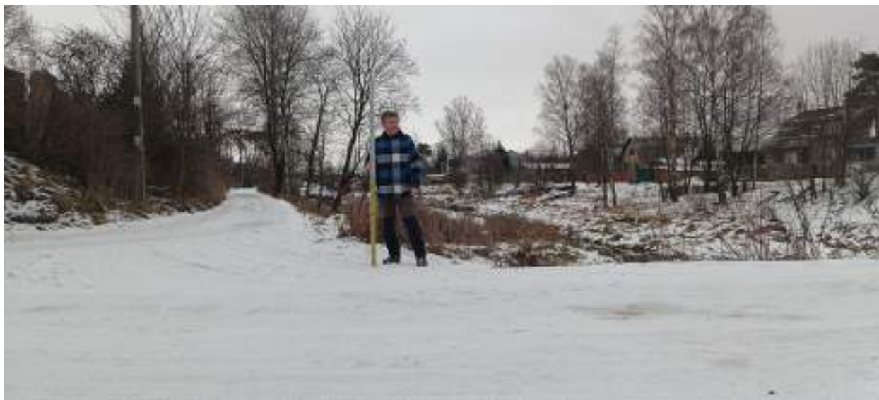
ТФ 3.2. Ленинградская область, г. Шлиссельбург. «Распределительный газопровод и газопроводы-вводы по г. Шлиссельбург (2-й этап)». Контур (отрезок) №3. Общий вид на место расположения технологического прямка. ЗПК2+91,50. Вид с ЗЮЗ.
