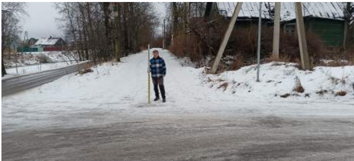
ТФ 1.4. Ленинградская область, г. Шлиссельбург. «Распределительный газопровод и газопроводы-вводы по г. Шлиссельбург (2-й этап)». Контур (отрезок) №1. Общий вид на место расположения технологического приямка. ПК6+98,50. Вид с СЗ.
