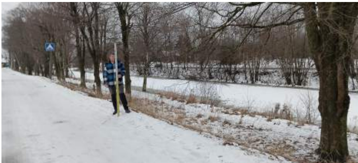
ТФ 2.2. Ленинградская область, г. Шлиссельбург. «Распределительный газопровод и газопроводы-вводы по г. Шлиссельбург (2-й этап)». Контур (отрезок) №2. Общий вид на место расположения технологического приемка. 1ПК3+16,50. Вид с СЗ.
