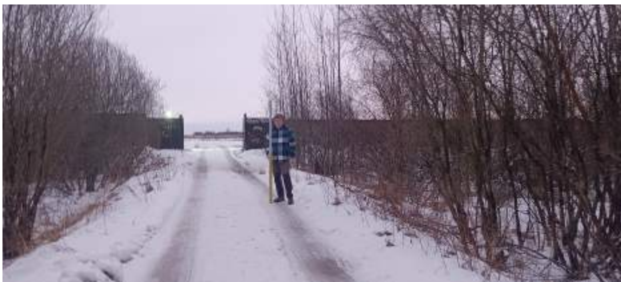
ТФ 4.10. Ленинградская область, г. Шлиссельбург. «Распределительный газопровод и газопроводы-вводы по г. Шлиссельбург (2-й этап)». Контур (отрезок) №4. Общий вид на место расположения технологического приемка. 5ПК1+66,50. Вид с ЮЗ.
