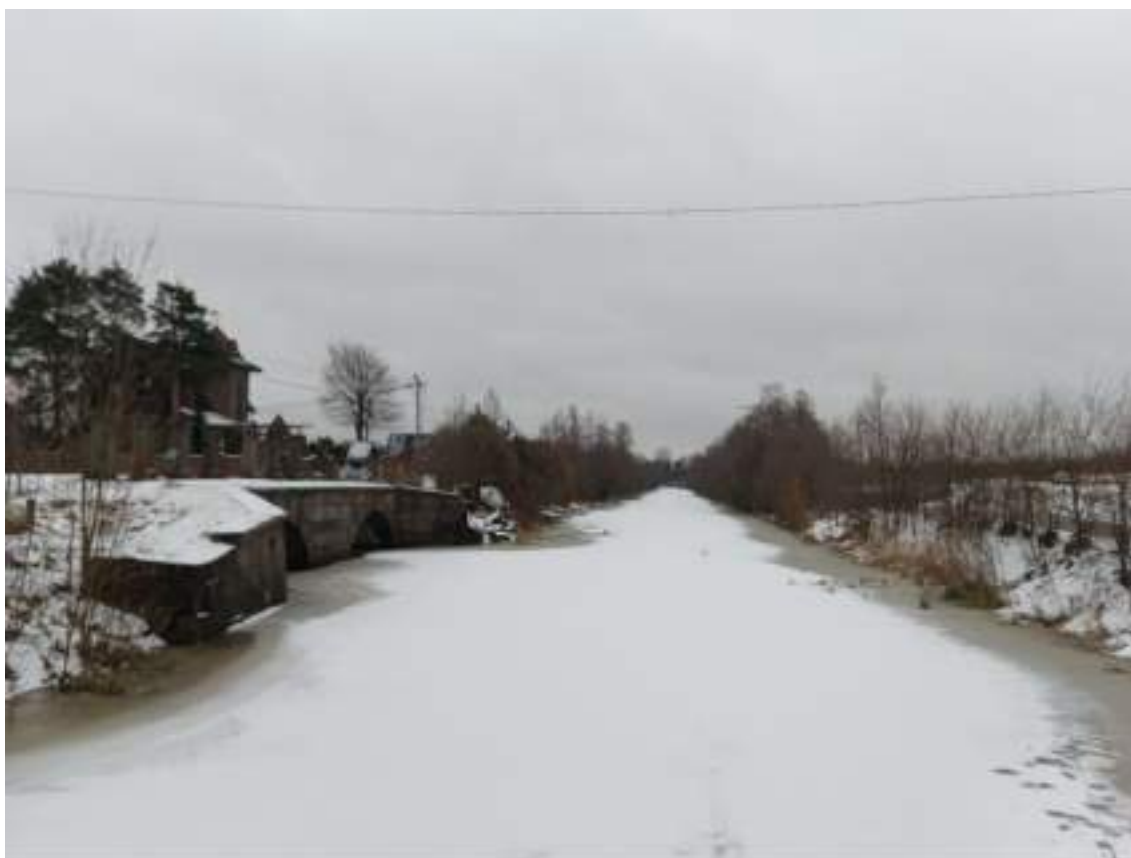
ТФ 3.0. Ленинградская область, г. Шлиссельбург. «Распределительный газопровод и газопроводы-вводы по г. Шлиссельбург (2-й этап)». Общий вид на Петровский канал у Шандорного моста в районе контуров (отрезков) №№3-4. Вид с ССЗ.
