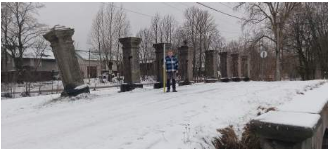
ТФ 4.4. Ленинградская область, г. Шлиссельбург. «Распределительный газопровод и газопроводы-вводы по г. Шлиссельбург (2-й этап)». Общий вид на Шандорный мост (Предмет охраны: «Мост шлюзовый», XVIII в.) со стороны контура (отрезка) №4 . Вид с ЮВ.
