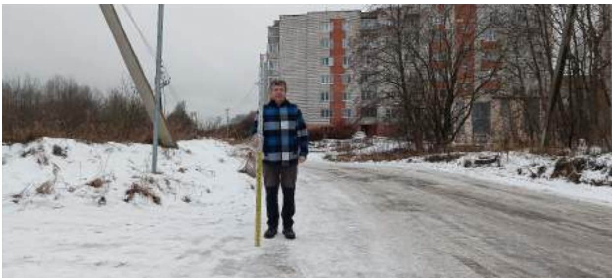
ТФ 1.4. Ленинградская область, г. Шлиссельбург. «Распределительный газопровод и газопроводы-вводы по г. Шлиссельбург (2-й этап)». Контур (отрезок) №1. Общий вид на место расположения технологического приемка. ПК6+98,50. Вид с СВ.
