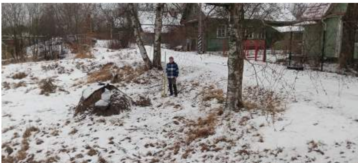
ТФ 3.5. Ленинградская область, г. Шлиссельбург. «Распределительный газопровод и газопроводы-вводы по г. Шлиссельбург (2-й этап)». Контур (отрезок) №3 . Общий вид на место расположения технологического прямка. ЗПК1+32,50 . Вид с ВСВ.
