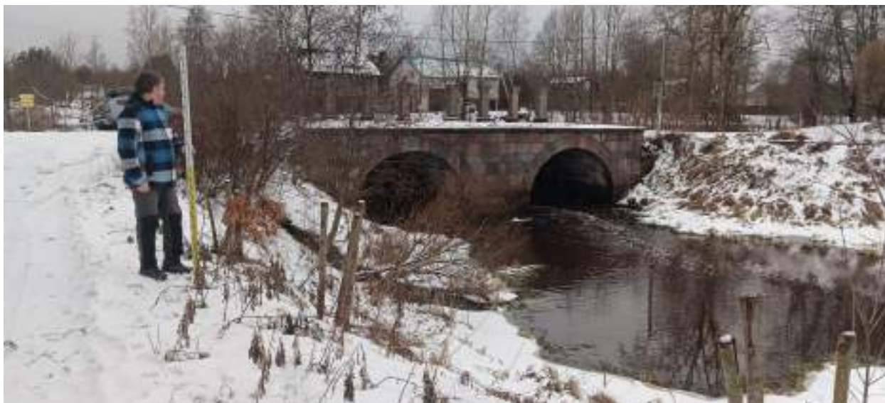
ТФ 4.3. Ленинградская область, г. Шлиссельбург. «Распределительный газопровод и газопроводы-вводы по г. Шлиссельбург (2-й этап)». Общий вид на Шандорный мост (Предмет охраны: «Мост шлюзовый», XVIII в.) со стороны контура (отрезка) №4 . Вид с ВЮВ.
