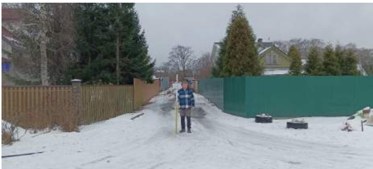
ТФ 2.4. Ленинградская область, г. Шлиссельбург. «Распределительный газопровод и газопроводы-вводы по г. Шлиссельбург (2-й этап)». Контур (отрезок) №2. Общий вид на место расположения технологического приемка. 1ПК0. Вид с СВ.
