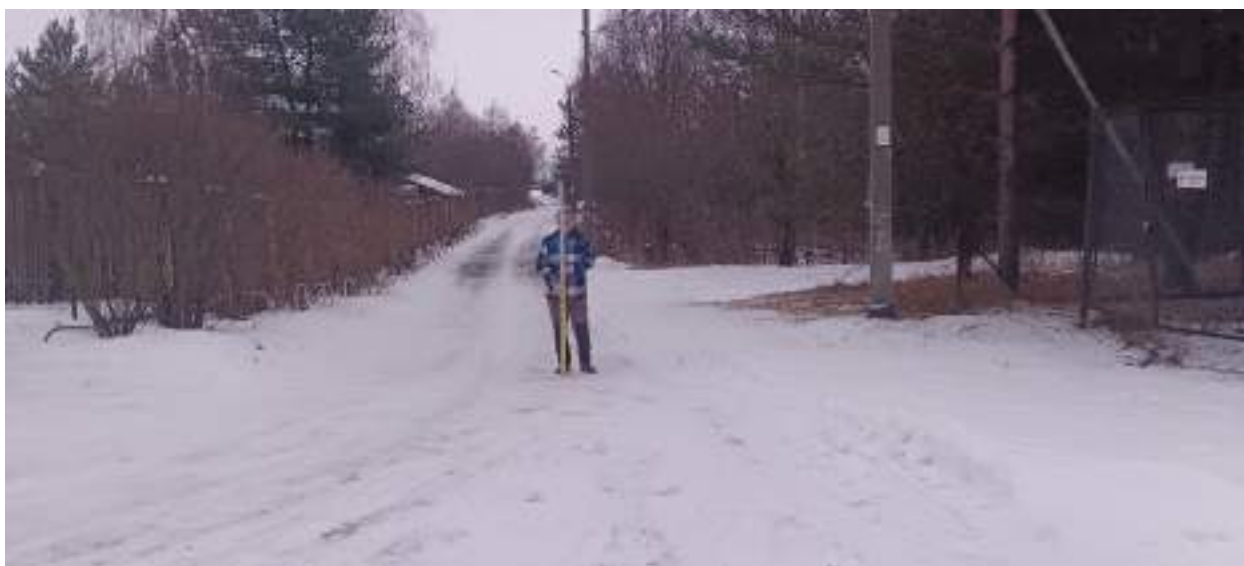
ТФ 4.9. Ленинградская область, г. Шлиссельбург. «Распределительный газопровод и газопроводы-вводы по г. Шлиссельбург (2-й этап)». Контур (отрезок) №4. Общий вид в сторону технологического приемка 5ПК1+66,50 от приемка 4ПК12+14,00.. Вид с ЮЗ.
