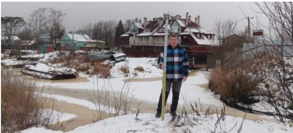
ТФ 3.8. Ленинградская область, г. Шлиссельбург. «Распределительный газопровод и газопроводы-вводы по г. Шлиссельбург (2-й этап)». Контур (отрезок) №3. Общий вид на место расположения технологического приямка. ЗПК0. Вид с ЮВ с противоположного берега Ладожской речки.
