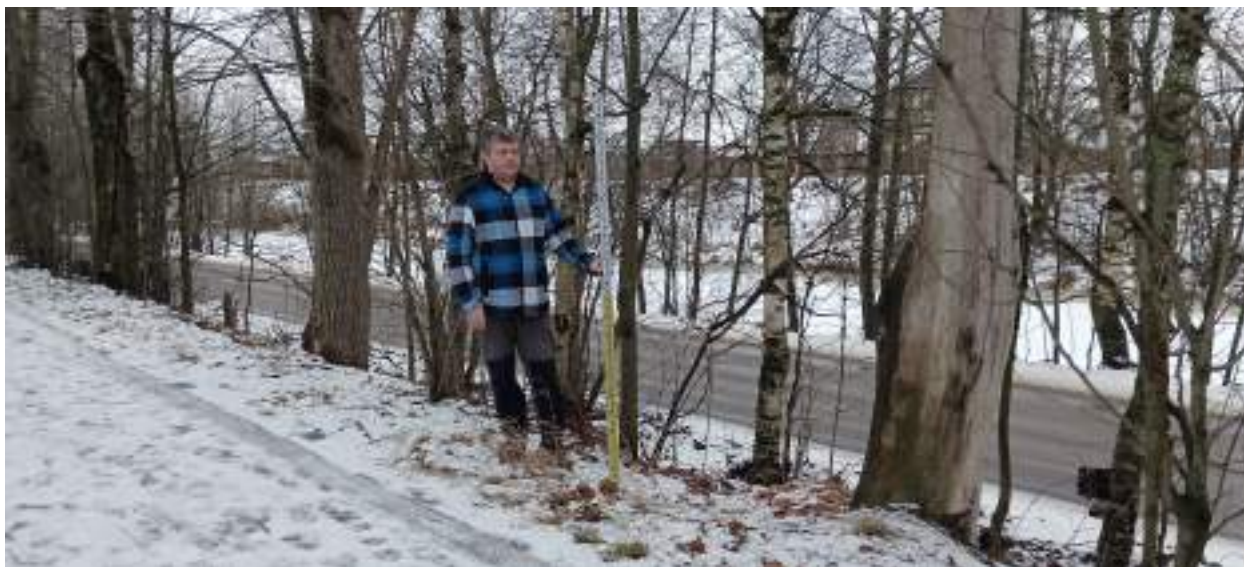
ТФ 1.9. Ленинградская область, г. Шлиссельбург. «Распределительный газопровод и газопроводы-вводы по г. Шлиссельбург (2-й этап)». Контур (отрезок) №1. Общий вид на место расположения технологического приемка. ПК15+38,50. Вид с ЮЮВ.
