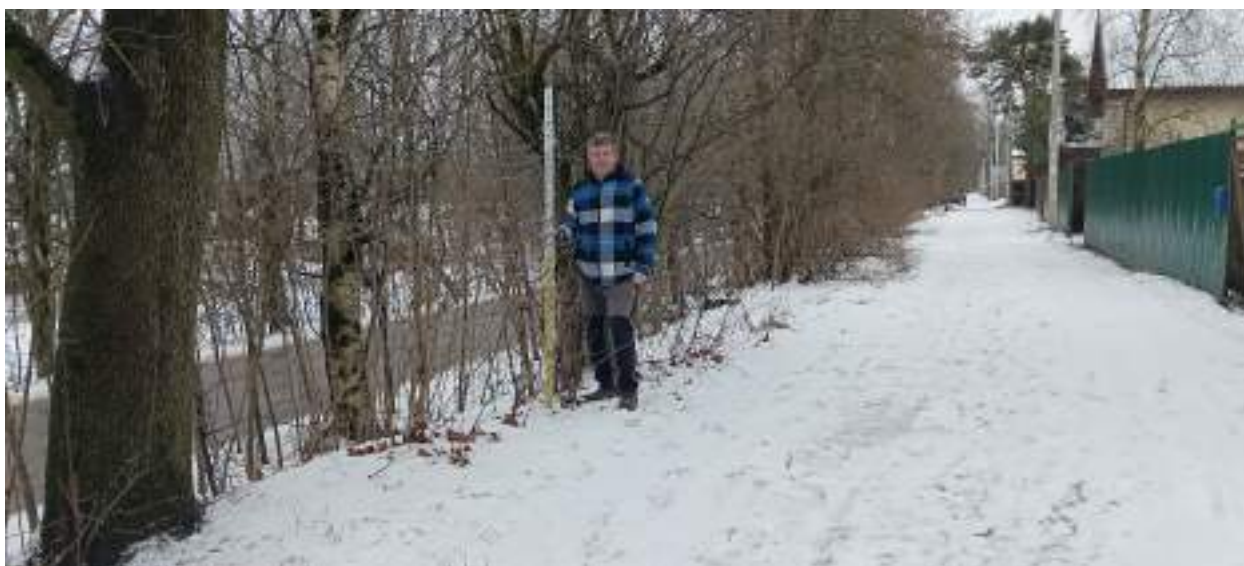
ТФ 1.7. Ленинградская область, г. Шлиссельбург. «Распределительный газопровод и газопроводы-вводы по г. Шлиссельбург (2-й этап)». Контур (отрезок) №1. Общий вид на место расположения технологического приямка. 2ПК10+1,50. Вид с ССЗ.
