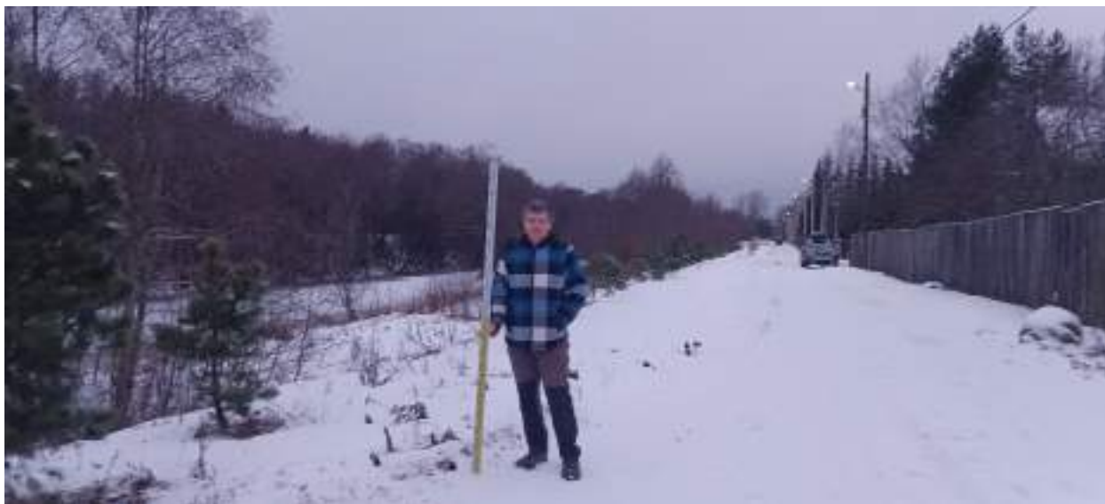
ТФ 4.11. Ленинградская область, г. Шлиссельбург. «Распределительный газопровод и газопроводы-вводы по г. Шлиссельбург (2-й этап)». Контур (отрезок) №4. Конец трассы обследования. Общий вид на место расположения технологического приемка. 4ПК13+34,50. Вид с ЮВ.
