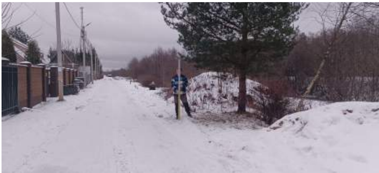
ТФ 4.8. Ленинградская область, г. Шлиссельбург. «Распределительный газопровод и газопроводы-вводы по г. Шлиссельбург (2-й этап)». Контур (отрезок) №4. Общий вид на место расположения технологического приемка. 4ПК10+48,50. Вид с СЗ.
