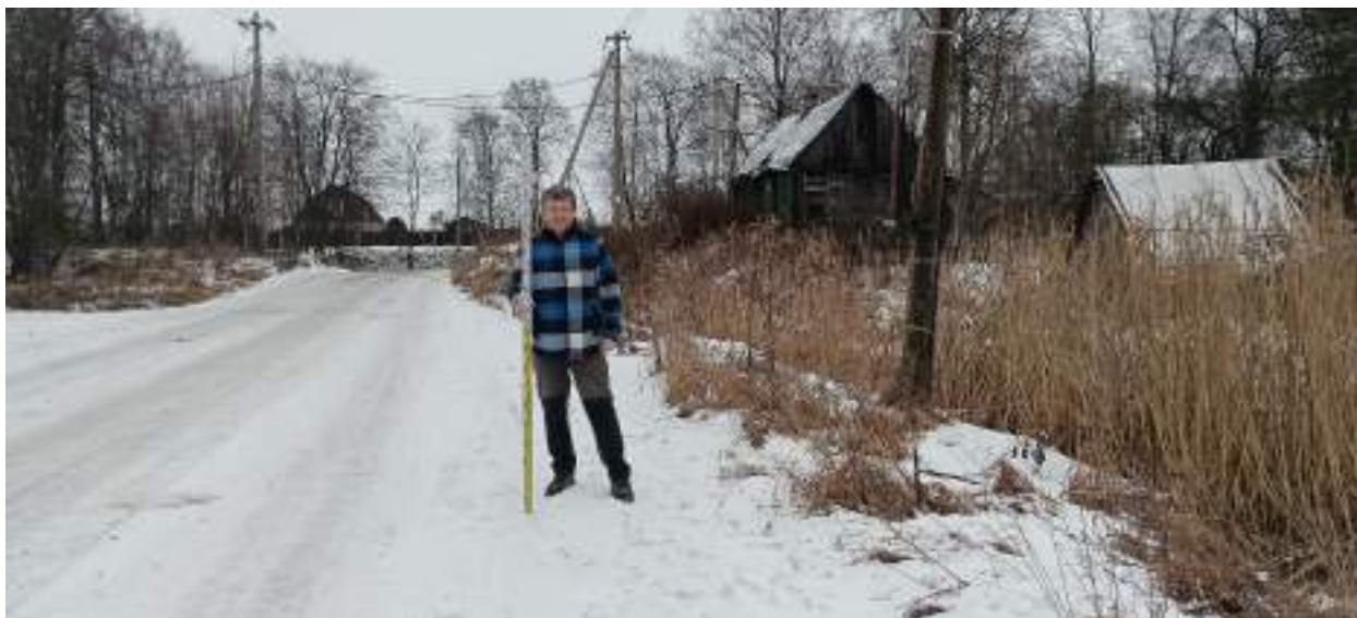
ТФ 1.3. Ленинградская область, г. Шлиссельбург. «Распределительный газопровод и газопроводы-вводы по г. Шлиссельбург (2-й этап)». Контур (отрезок) №1. Общий вид на место расположения технологического приемка. ПК6+52,00. Вид с ЮЗ.
