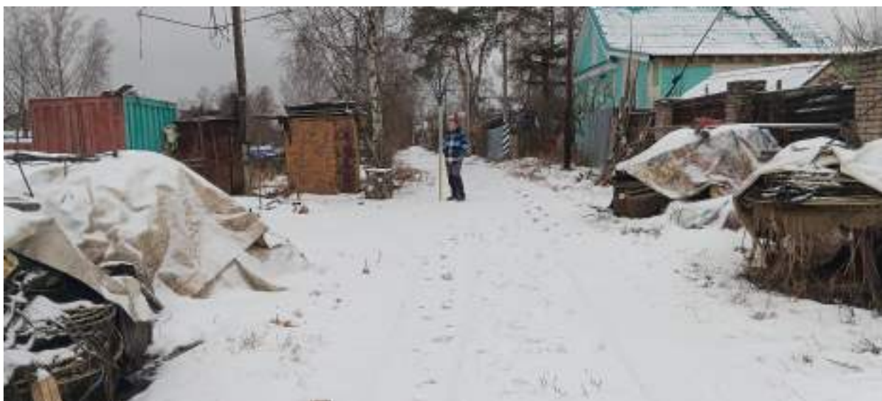
ТФ 3.6. Ленинградская область, г. Шлиссельбург. «Распределительный газопровод и газопроводы-вводы по г. Шлиссельбург (2-й этап)». Контур (отрезок) №3. Общий вид на место расположения технологического приемка. ЗПК0+32,00. Вид с ВСВ.
