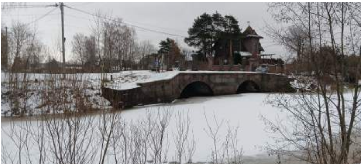
ТФ 4.0. Ленинградская область, г. Шлиссельбург. «Распределительный газопровод и газопроводы-вводы по г. Шлиссельбург (2-й этап)». Контур (отрезки) №№3-4. Общий вид на Шандорный мост (Предмет охраны: «Мост шлюзовый», XVIII в.). Вид с З.
