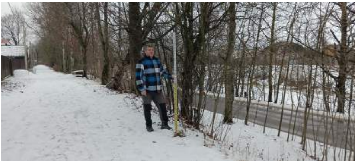
ТФ 1.7. Ленинградская область, г. Шлиссельбург. «Распределительный газопровод и газопроводы-вводы по г. Шлиссельбург (2-й этап)». Контур (отрезок) №1. Общий вид на место расположения технологического приямка. 2ПК10+1,50. Вид с ЮЮВ.
