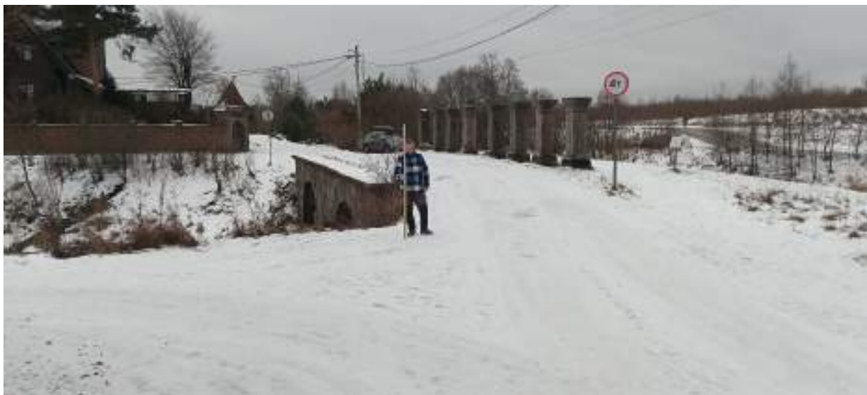
ТФ 3.2. Ленинградская область, г. Шлиссельбург. «Распределительный газопровод и газопроводы-вводы по г. Шлиссельбург (2-й этап)». Контур (отрезок) №3. Общий вид на место расположения технологического приямка на ЗПК2+91,50 и Шандорный мост (Предмет охраны: «Мост шлюзовый», XVIII в.). Вид с ССЗ.
