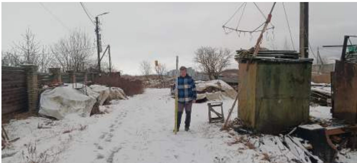
ТФ 3.6. Ленинградская область, г. Шлиссельбург. «Распределительный газопровод и газопроводы-вводы по г. Шлиссельбург (2-й этап)». Контур (отрезок) №3. Общий вид на место расположения технологического прямка. ЗПК0+32,00. Вид с ЗЮЗ.
