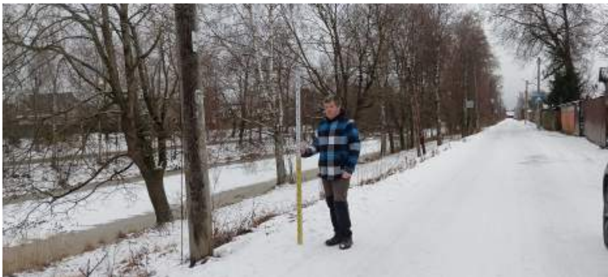
ТФ 2.6. Ленинградская область, г. Шлиссельбург. «Распределительный газопровод и газопроводы-вводы по г. Шлиссельбург (2-й этап)». Контур (отрезок) №2. Общий вид на место расположения технологического приемка. 2ПК4+47,00. Вид с ЮЮВ.
