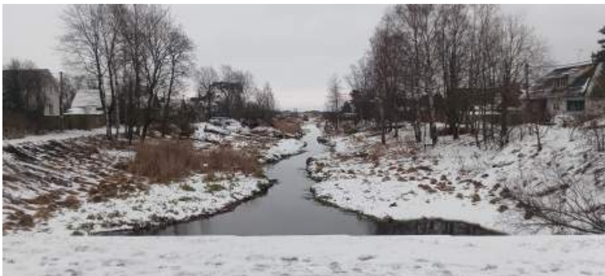
ТФ 3.3. Ленинградская область, г. Шлиссельбург. «Распределительный газопровод и газопроводы-вводы по г. Шлиссельбург (2-й этап)». Общий вид с Шандорного моста на берега Ладужской речки ( условный участок №3 – слева; условный участок №4 – справа ). Вид с ЗЮЗ.
