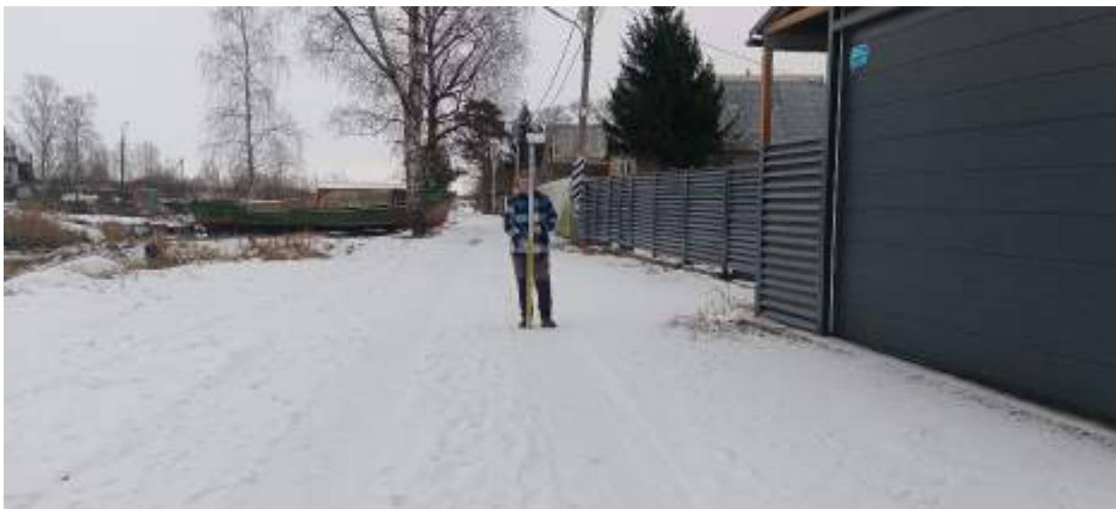
ТФ 4.2. Ленинградская область, г. Шлиссельбург. «Распределительный газопровод и газопроводы-вводы по г. Шлиссельбург (2-й этап)». Контур (отрезок) №4. Общий вид на место расположения технологического прямка. 4ПК1+56,00. Вид с ЗЮЗ.
