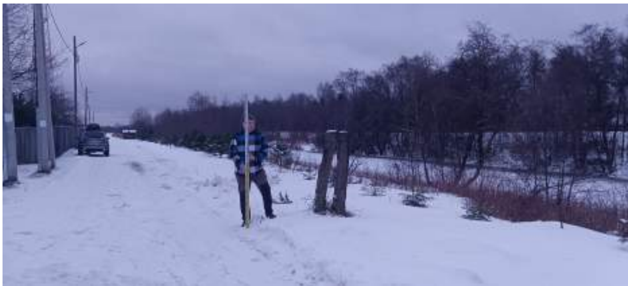
ТФ 4.9. Ленинградская область, г. Шлиссельбург. «Распределительный газопровод и газопроводы-вводы по г. Шлиссельбург (2-й этап)». Контур (отрезок) №4. Общий вид на место расположения технологического приемка. 4ПК12+14,00. Вид с СЗ.
