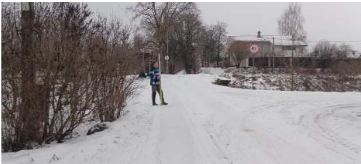
ТФ 4.4. Ленинградская область, г. Шлиссельбург. «Распределительный газопровод и газопроводы-вводы по г. Шлиссельбург (2-й этап)». Контур (отрезок) №4. Общий вид на место расположения технологического прямка. 4ПКЗ+1,00. Вид с ЮЮВ.
