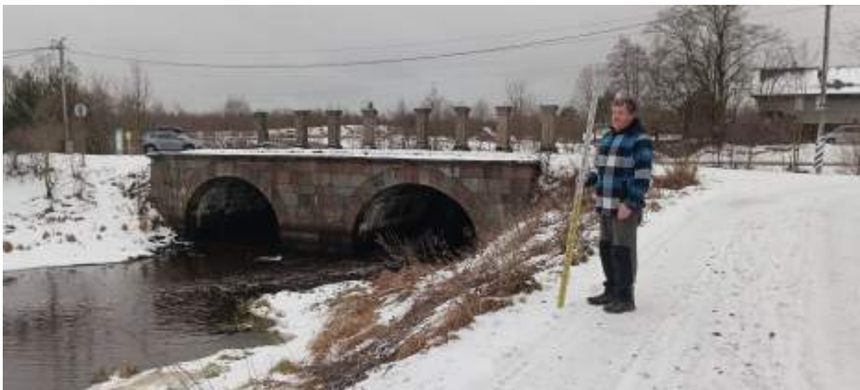
ТФ 3.4. Ленинградская область, г. Шлиссельбург. «Распределительный газопровод и газопроводы-вводы по г. Шлиссельбург (2-й этап)». Общий вид на Шандорный мост (Предмет охраны: «Мост шлюзовый», XVIII в.) со стороны контура (отрезка) №3 . Вид с СВ.
