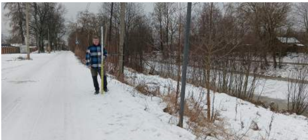
ТФ 2.7. Ленинградская область, г. Шлиссельбург. «Распределительный газопровод и газопроводы-вводы по г. Шлиссельбург (2-й этап)». Контур (отрезок) №2. Общий вид на место расположения технологического приямка. 2ПК6+88,50. Вид с ССЗ.
