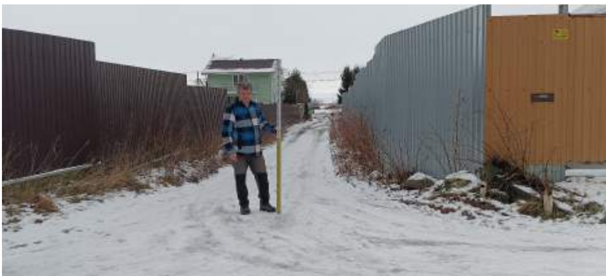
ТФ 2.3. Ленинградская область, г. Шлиссельбург. «Распределительный газопровод и газопроводы-вводы по г. Шлиссельбург (2-й этап)». Контур (отрезок) №2. Общий вид на отрезок к технологическому приемку на 1ПК0 от приемков №№2-3, 2-5. Вид с ЮЗ.
