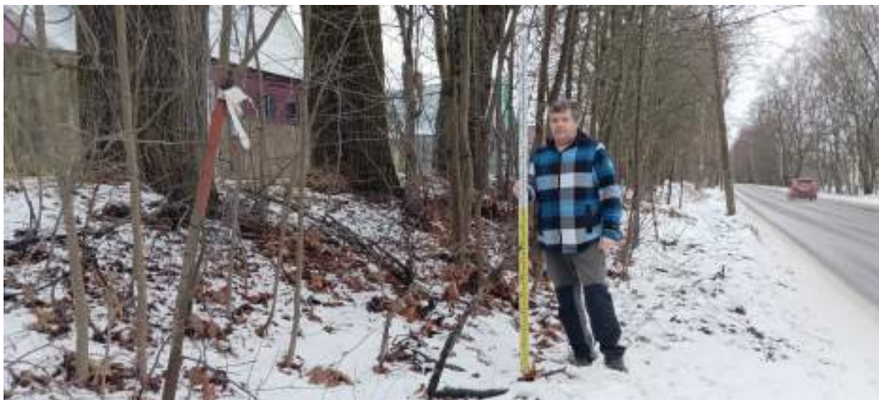
ТФ 1.8. Ленинградская область, г. Шлиссельбург. «Распределительный газопровод и газопроводы-вводы по г. Шлиссельбург (2-й этап)». Контур (отрезок) №1. Общий вид на место расположения технологического приемка. 2ПК12+49,00. Вид с ЮЮВ.
