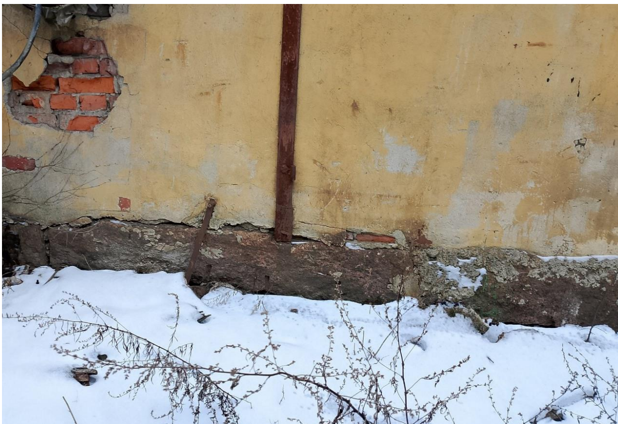
26. Юго-восточный (торцевой) фасад здания мебельной фабрики. Гранитный цоколь.
