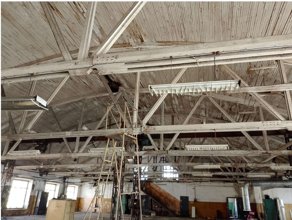
42. Производственная часть. Помещение в уровне 2 этажа, вид на юг. Деревянные фермы, установленные при ремонте крыши в середине XX в.
