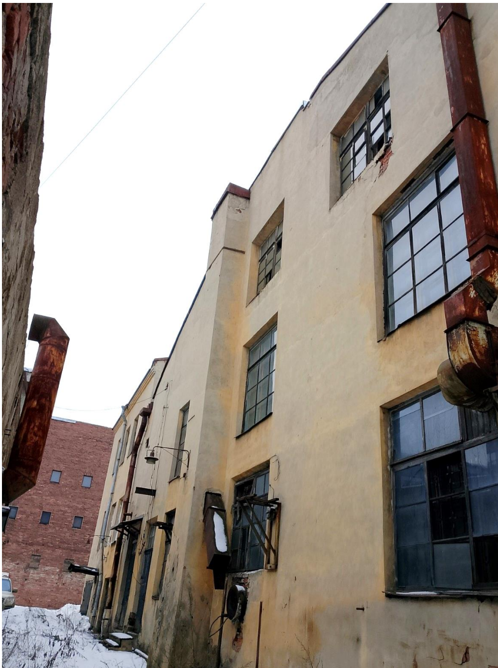
24. Юго-восточный (торцевой) фасад здания фабрики и пристройки, вид с востока. Конфигурация фронтона искажена при замене конструкции крыши.
