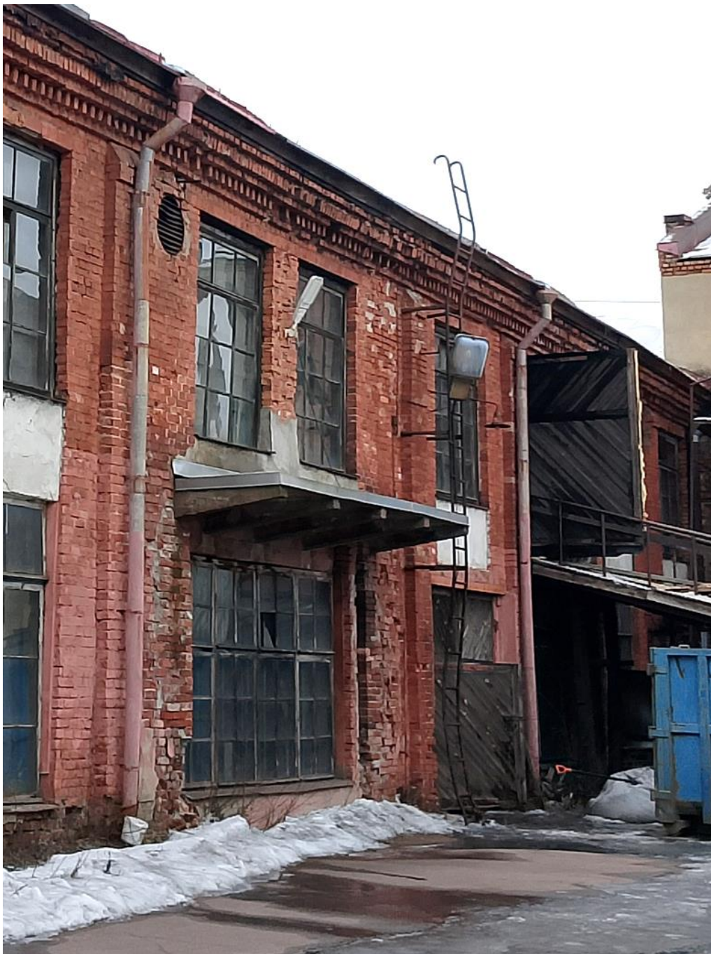
18. Юго-западный (дворовый) фасад. Бетонный козырёк над историческим воротным проёмом.
