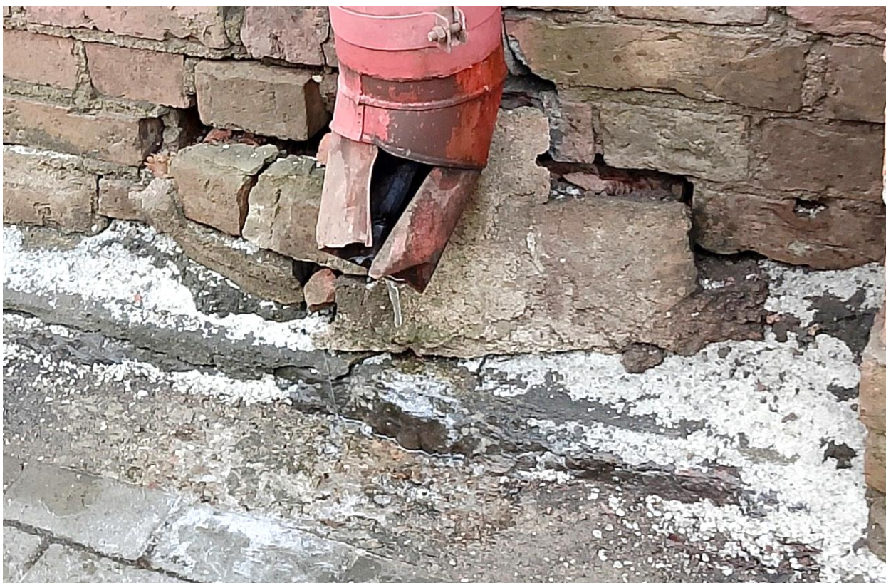
10. Северо-восточный фасад, северная часть. Фрагмент исторического гранитного цоколя под разрушенной поздней отмосткой.
