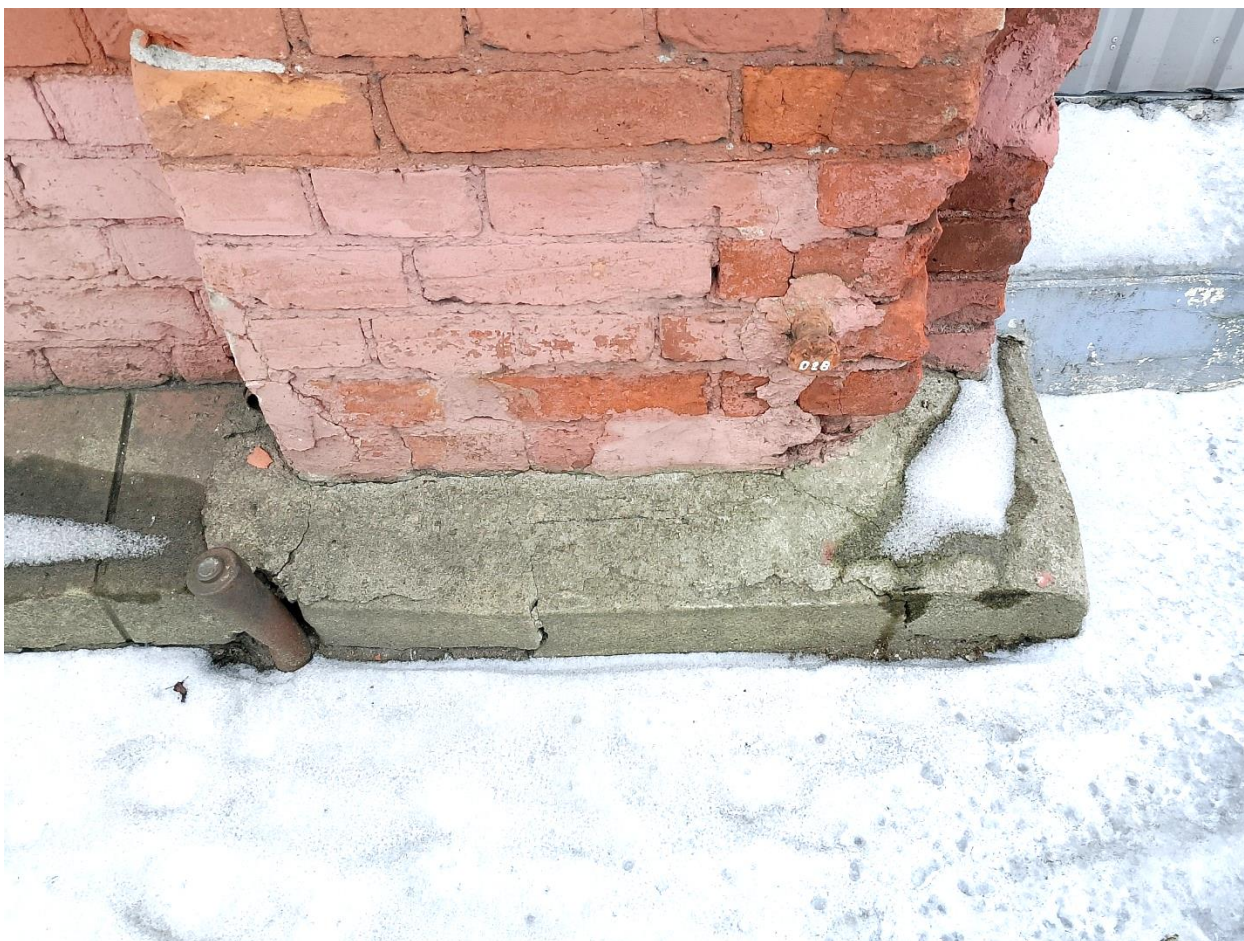
14. Западный угол здания. Поздний бетонный цоколь.
