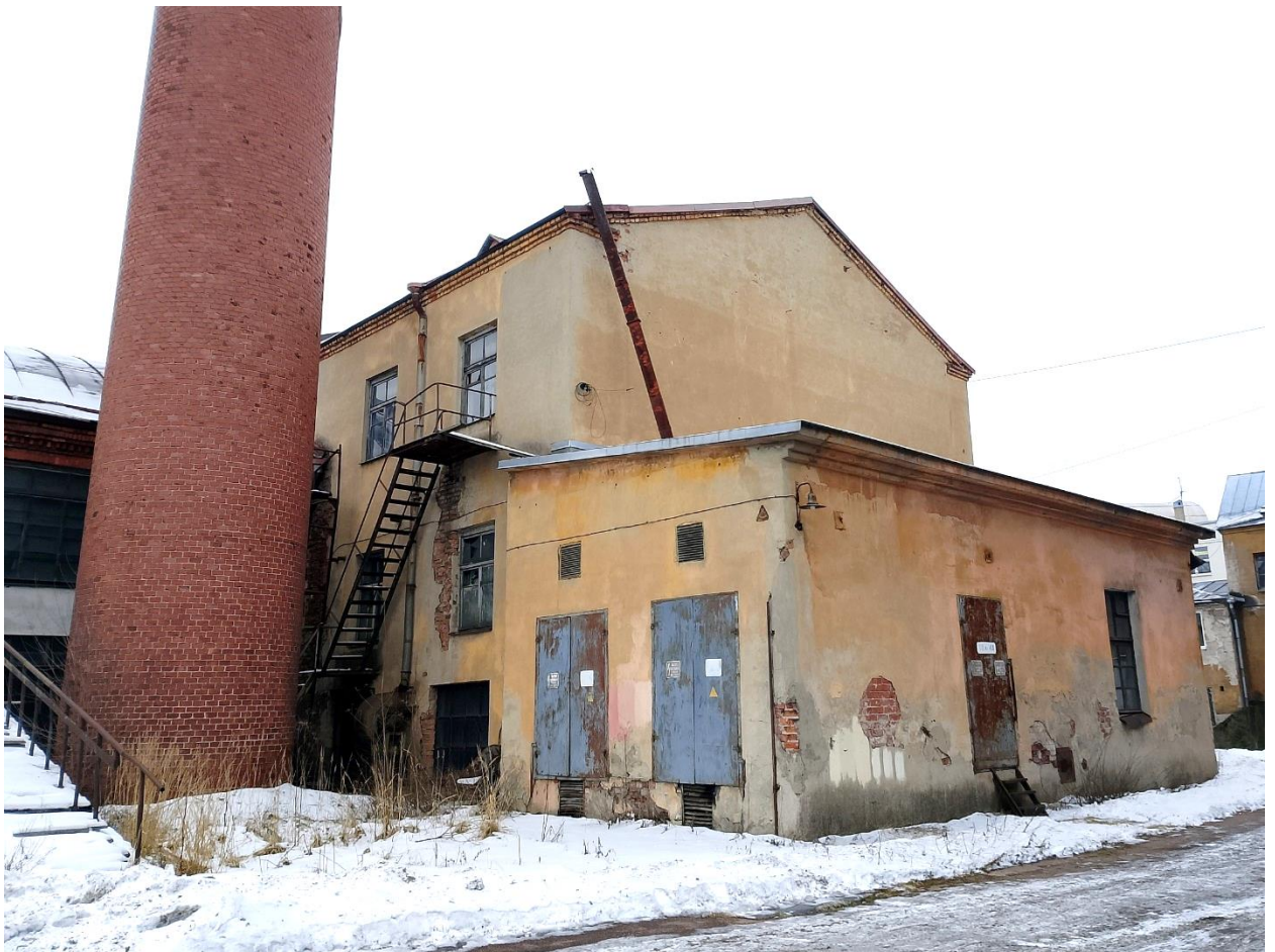
20. Пристройка к южной части западного фасада. Одноэтажный объём приспособлен под трансформаторную подстанцию с перебивкой проёмов.
