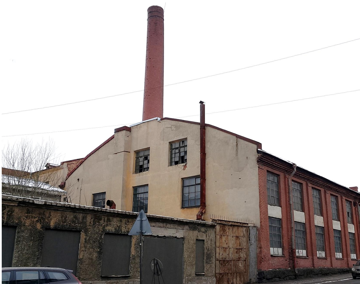
4. . Юго-восточный (торцевой) фасад. Поздние проёмы в уровне чердачного пространства.
