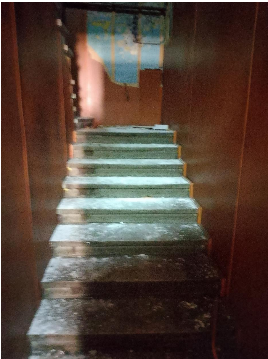
37. Лестница в уровне 2-3 этажа в административной части.
