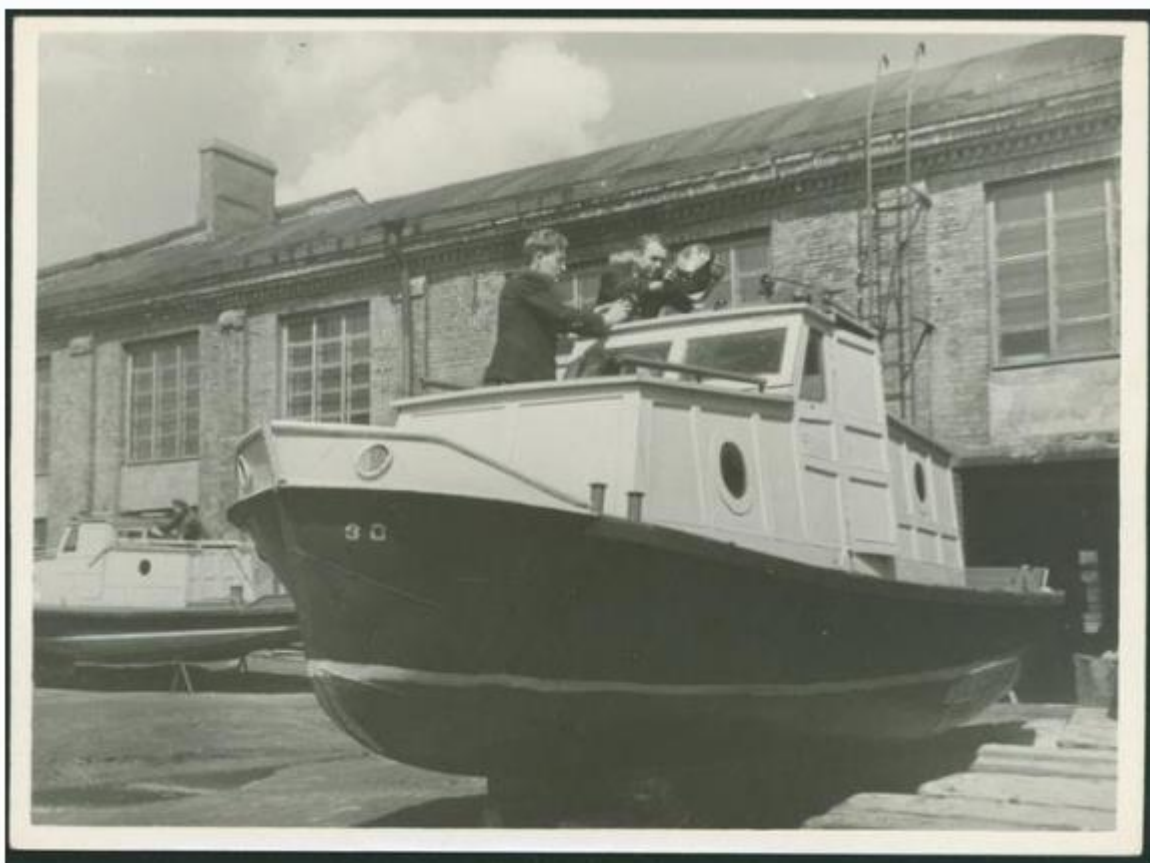
35. Выборгский судомеханический завод. Электромонтажники В.Р. Жолтиков и В.А. Ханаев за установкой арматуры освещения на рыболовецком катере. Автор фото – В. Капустин. 1953. Государственное бюджетное учреждение культуры Ленинградской области "Выборгский объединенный музей-заповедник". Инв. № ВКМ ОФ КП-1867/28. Эл. доступ: https://goskatalog.ru/portal/#/collections?id=27650958 .
