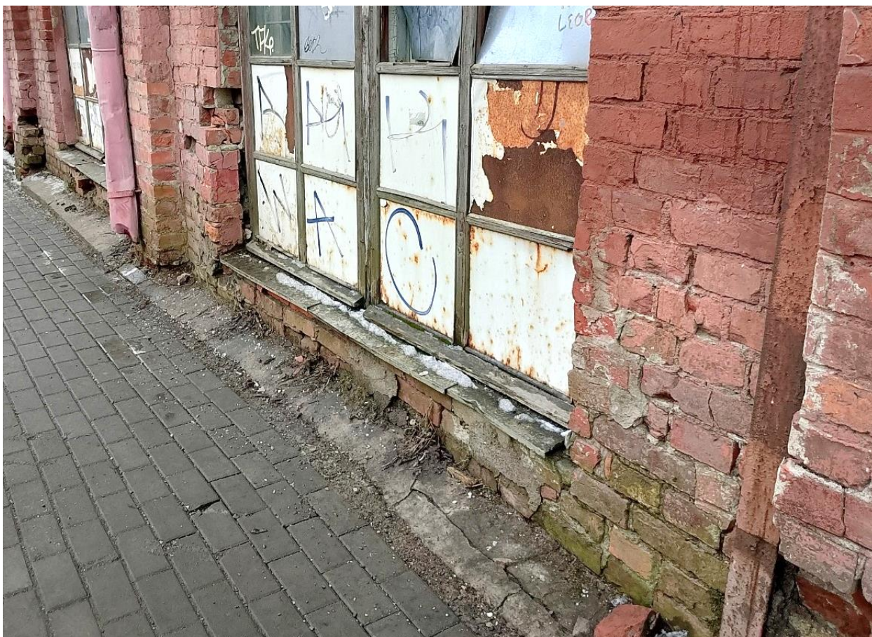
9. Северо-восточный фасад, северная часть. Бетонная отмастка поверх утепленного в культурном слое цоколя.
