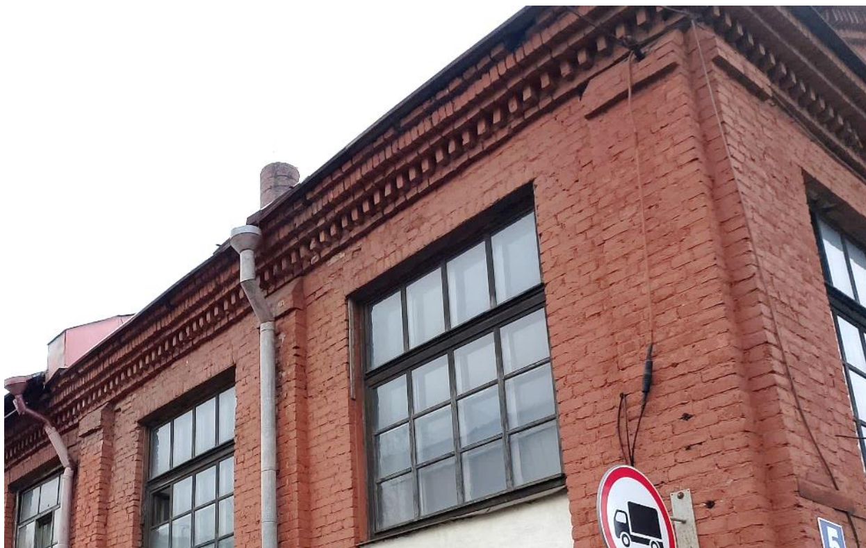
8. Северо-восточный фасад, северная часть. Зубчатый карниз.
