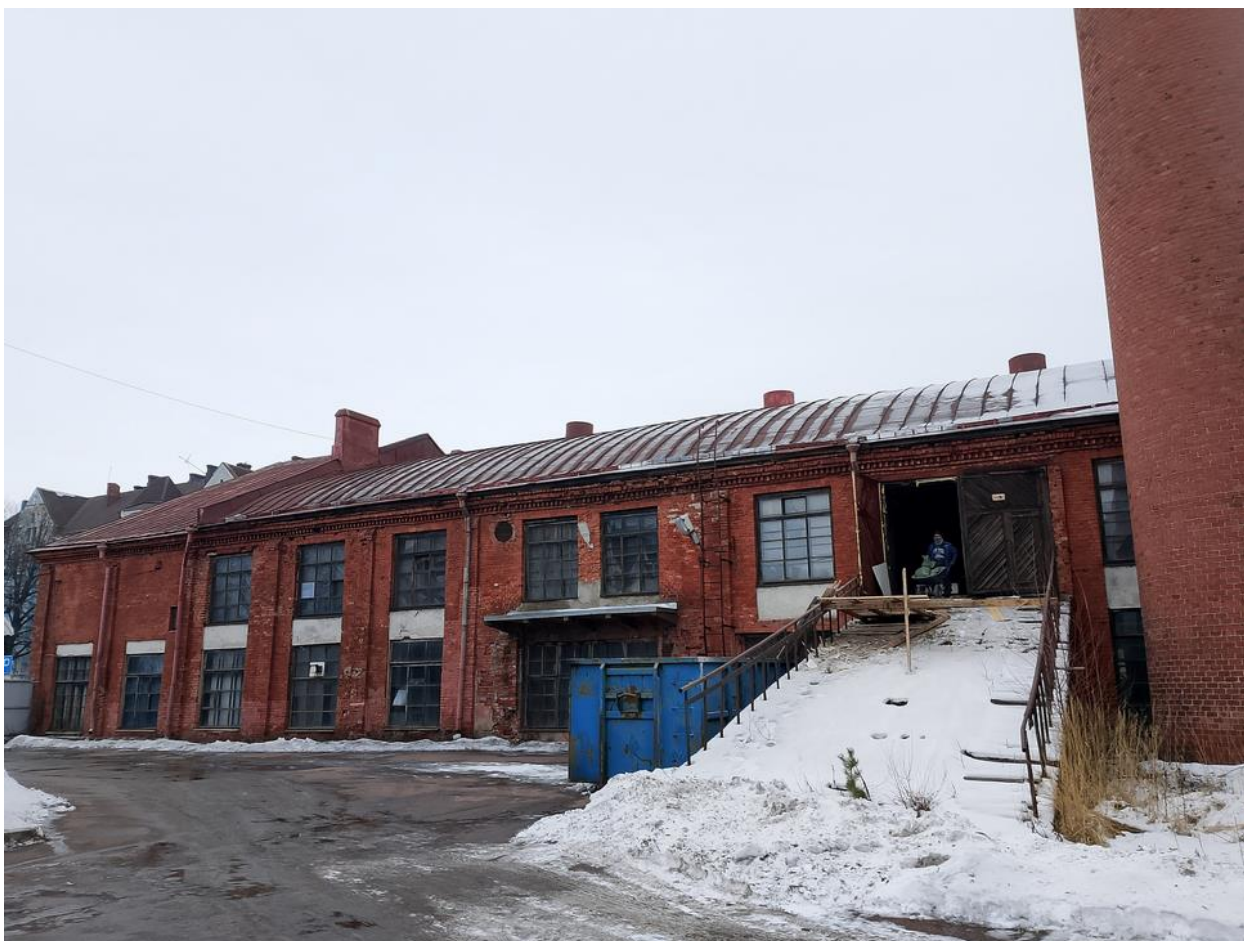
19. Юго-западный (дворовый) фасад, общий вид. Крыша по 1-2 световой оси сохранила историческую (двускатную) конфигурацию.
