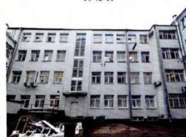
С-З фасад дворового корпуса
