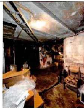
Уличный корпус. Подвал. Пом. 0.21. Монолитное перекрытие
