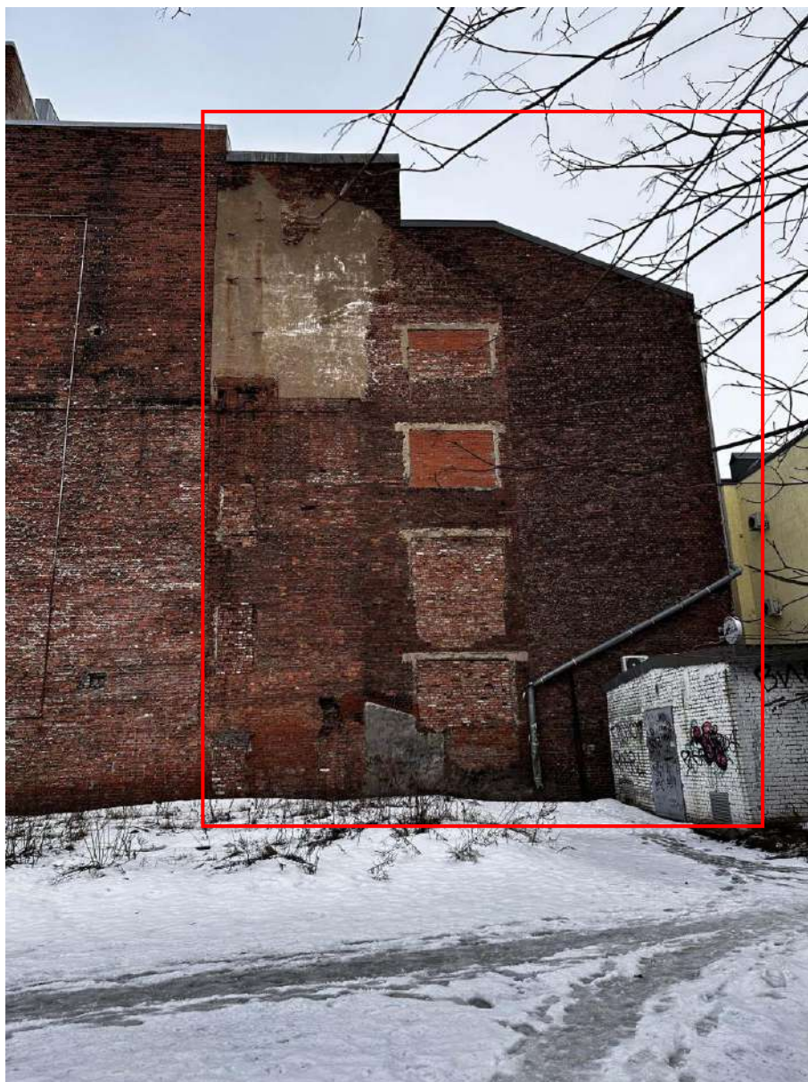
Фото 11. Юго-западная брандмауэрная стена юго-западного крыла дворового корпуса, являющегося неотъемлемой частью объекта культурного наследия регионального значения «Гостиница и контора типографии», г. Выборг, Ленинградский пр., 19 (офиц. адрес: ул. Димитрова, 4). Дата съемки: 03.02.2025 г. Автор съемки: Глинская Н.Б.
