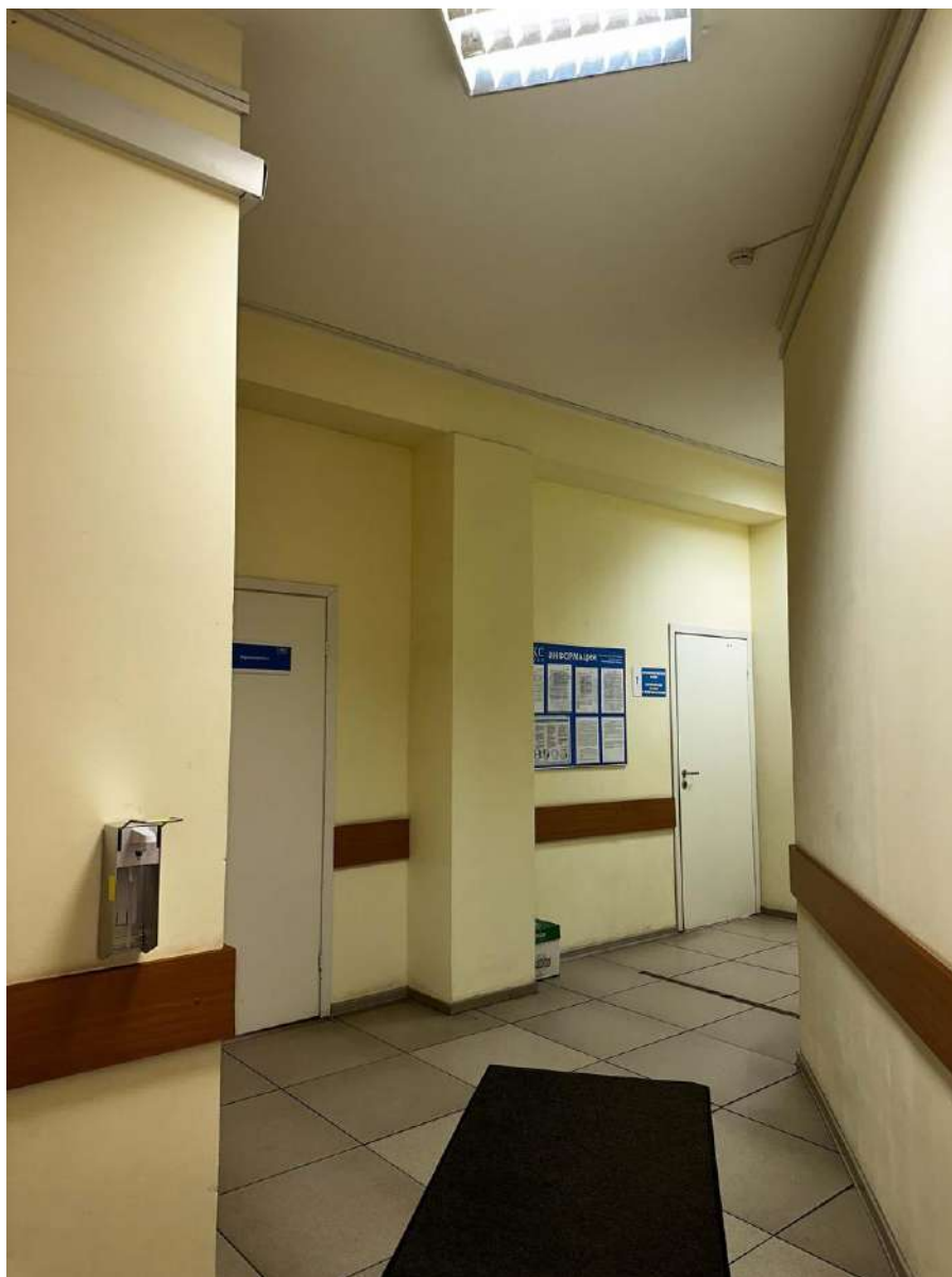
Фото 41. 2-ой этаж. Пом. 2.21. Вид с юга. Северо-восточная часть. Дата съемки: 03.02.2025 г. Автор съемки: Глинская Н.Б.
