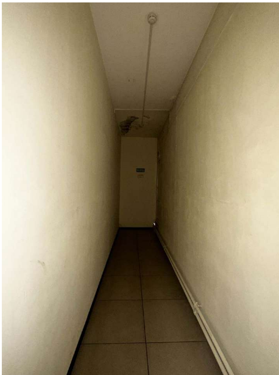
Фото 48. 3-ий этаж. Северо-восточная часть помещения. Вид с юго-востока. Дата съемки: 03.02.2025 г. Автор съемки: Глинская Н.Б.
