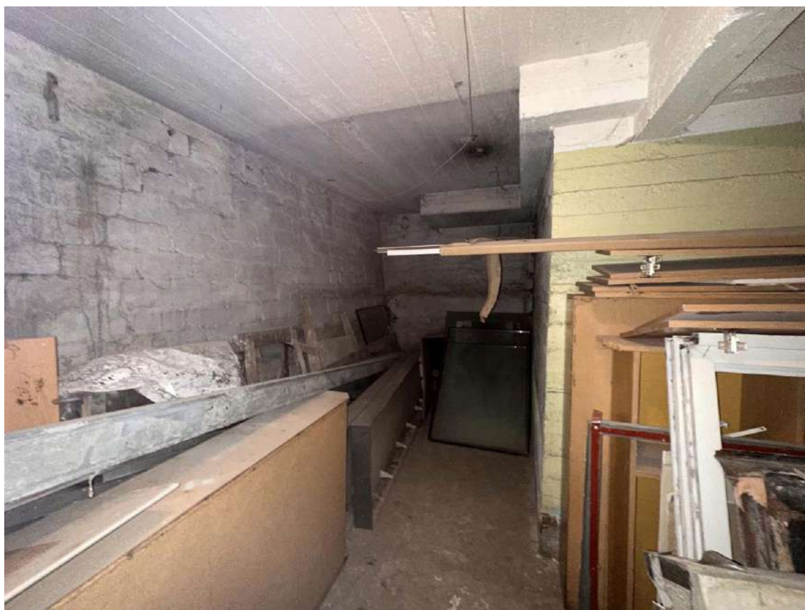
Фото 31. Подвал. Пом.0.36. Вид юго-западной части помещения с юго-запада. Дата съемки: 03.02.2025 г. Автор съемки: Глинская Н.Б.
