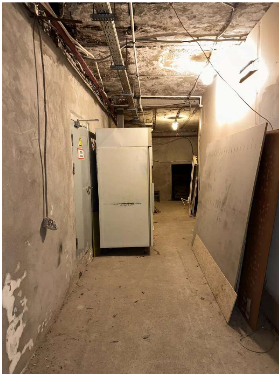
Фото 27. Подвал. Пом. 0.26. Общий вид помещения с юго-запада. Дата съемки: 03.02.2025 г. Автор съемки: Глинская Н.Б.
