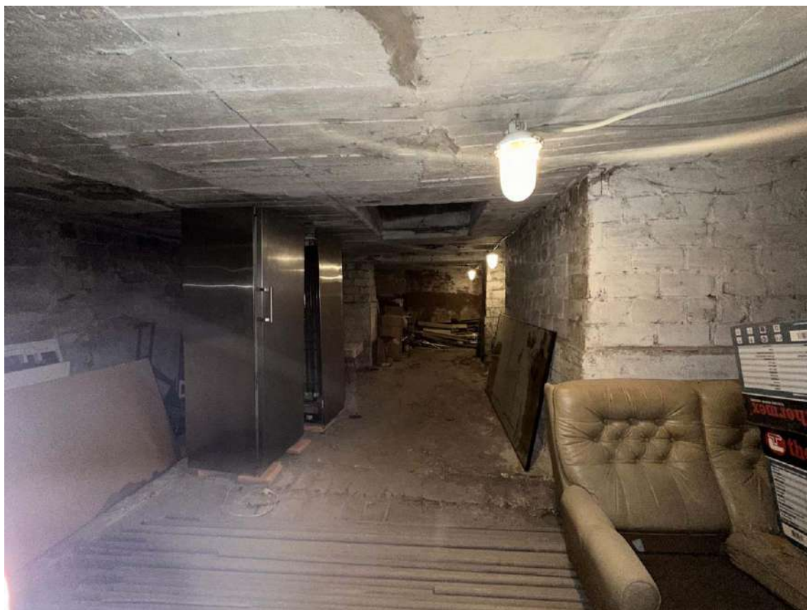
Фото 34. Подвал. Пом. 0.37. Вид на юго-восточную часть помещения. Дата съемки: 03.02.2025 г. Автор съемки: Глинская Н.Б.
