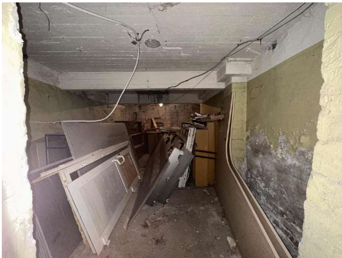
Фото 30. Подвал. Пом. 0.36. Вид на северо-восточную часть помещения с юго-востока. Дата съемки: 03.02.2025 г. Автор съемки: Глинская Н.Б.
