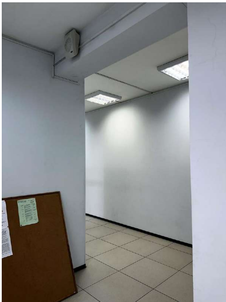
Фото 51. 4-ый этаж. Пом. 4.1. Северо-восточная часть помещения. Фото с востока. Дата съемки: 03.02.2025 г. Автор съемки: Глинская Н.Б.
