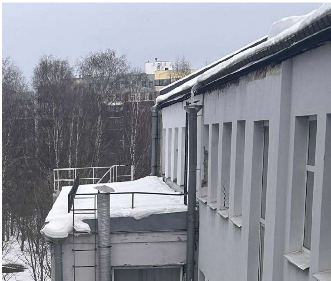
Фото 20. Фрагмент северо-западного фасада дворового корпуса, являющегося неотъемлемой частью объекта культурного наследия регионального значения «Гостиница и контора типографии», г. Выборг, Ленинградский пр., 19 (офиц. адрес: ул. Димитрова, 4). Дата съемки: 07.02.2025 г. Автор съемки: Глинская Н.Б.
