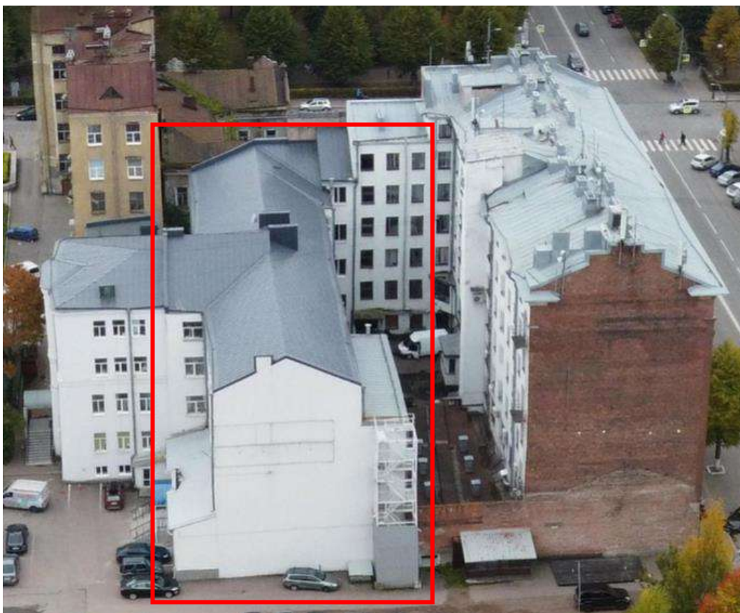
Фото 69. Общий вид крыши объекта культурного наследия регионального значения «Гостиница и контора типографии», Ленинградский пр. 19 (выделен объем дворового корпуса, являющегося неотъемлемой частью объекта культурного наследия). Фото Яндекс-карты. 2023 г.
