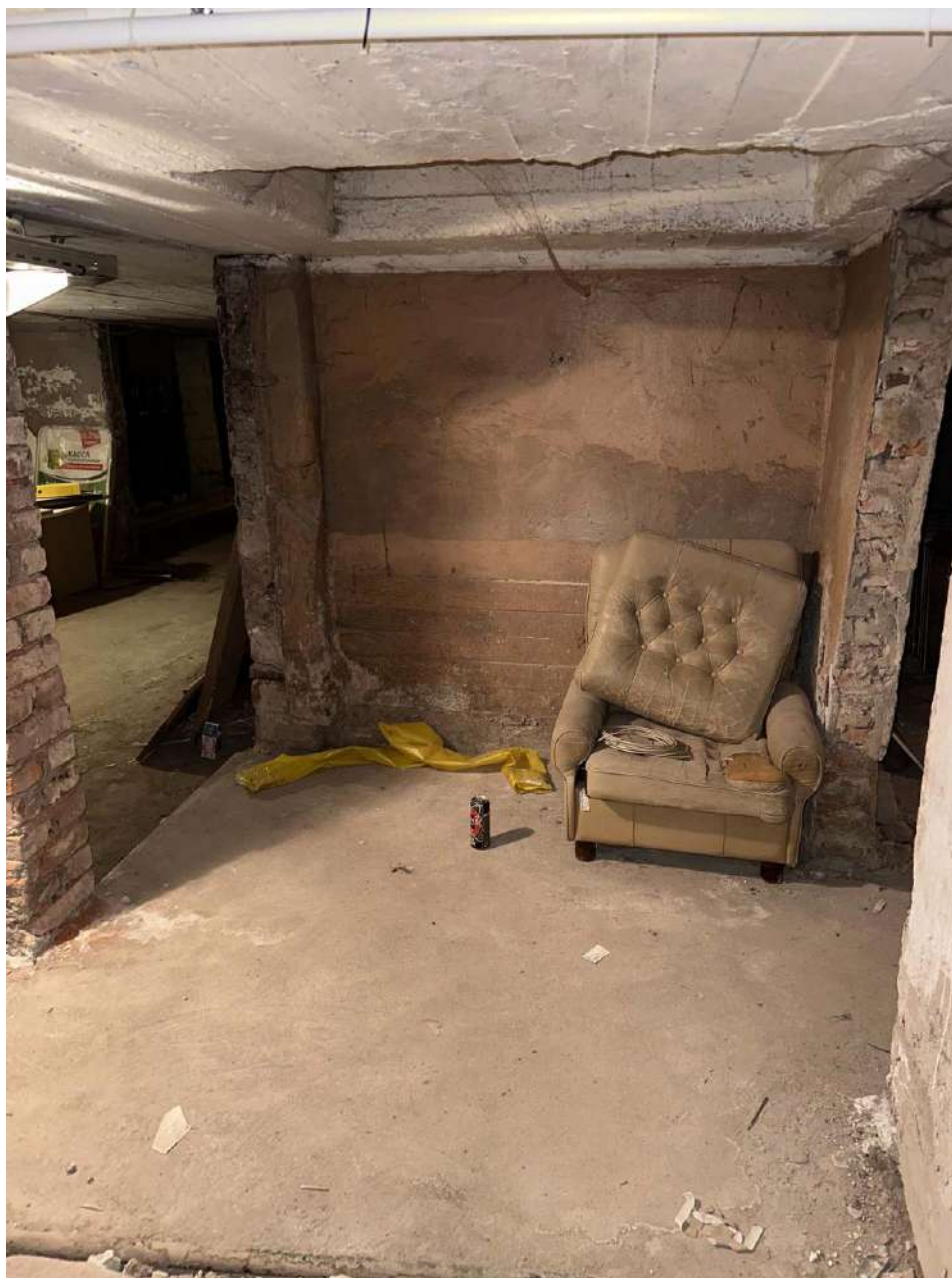
Фото 26. Подвал. Пом. 0.16. Общий вид юго-западной части помещения. Дата съемки: 03.02.2025 г. Автор съемки: Глинская Н.Б.
