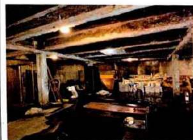
Уличный корпус. Подвал. Пом. 0.51. Монолитное ж/б ребристое пустотное перекрытие (нижняя часть перекрытия утрачена)
