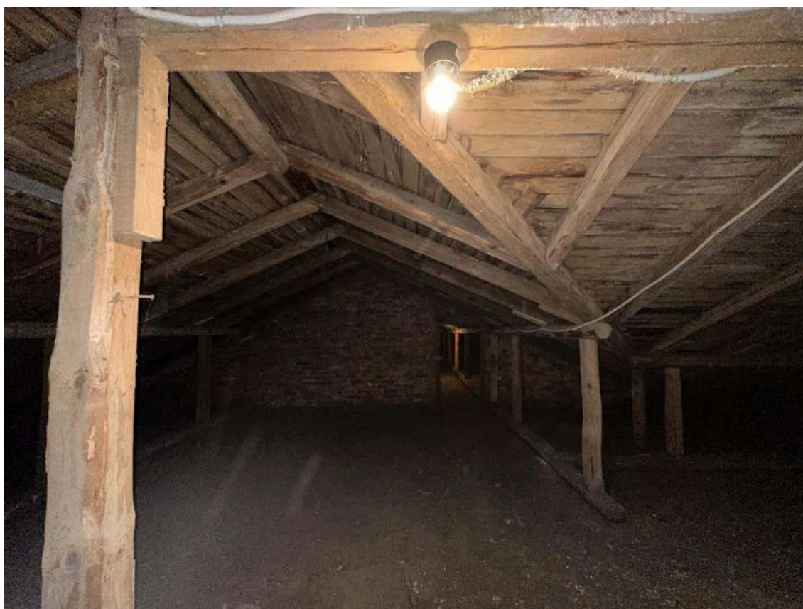
Фото 65. Чердак. Центральная часть помещения. Фото с юго-запада. Дата съемки: 03.02.2025 г. Автор съемки: Глинская Н.Б.
