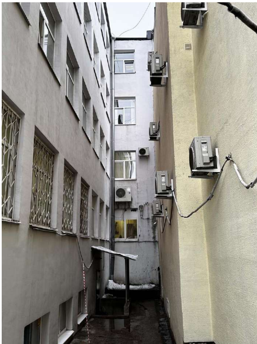
Фото 8. Вид на боковой юго-западный фасад юго-восточного ризалита дворового корпуса, являющегося неотъемлемой частью объекта культурного наследия регионального значения «Гостиница и контора типографии», г. Выборг, Ленинградский пр., 19 (офиц. адрес: ул. Димитрова, 4). Фото с юго-запада. Дата съемки: 07.02.2025 г. Автор съемки: Глинская Н.Б.
