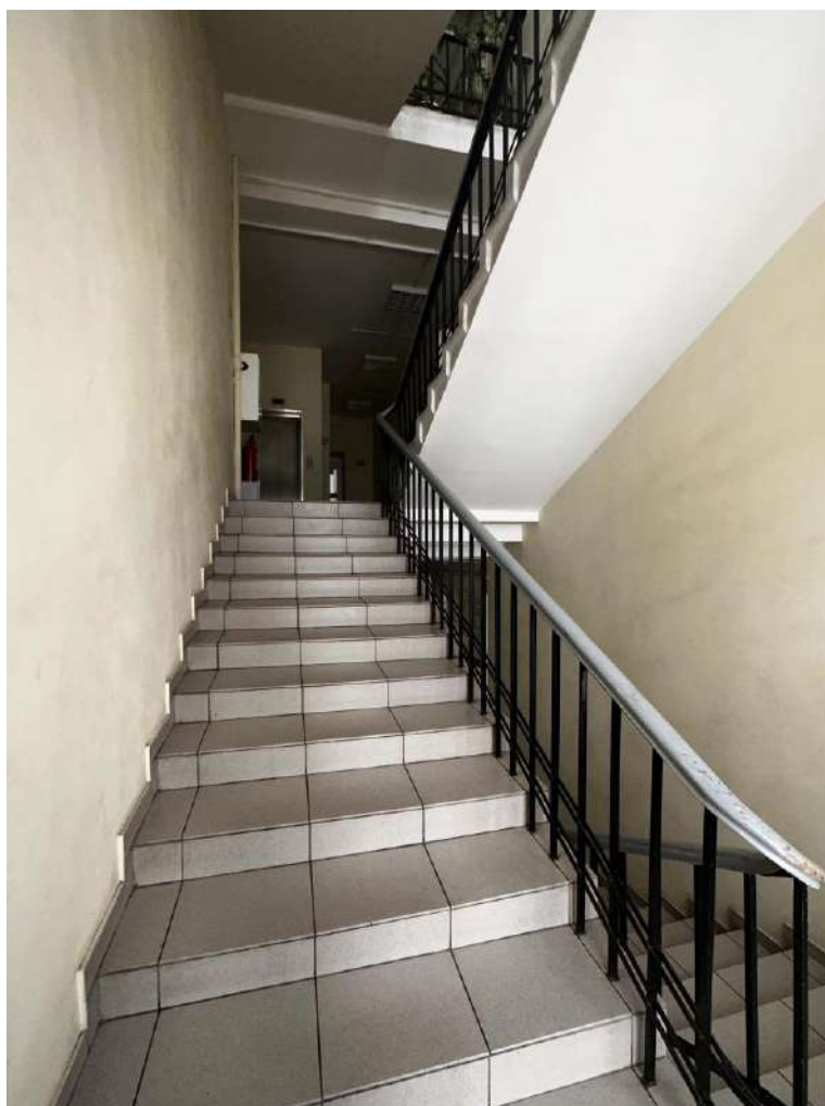
Фото 59. ЛК-1 между 3-им и 4-ым этажами. Фото с северо-запада. Дата съемки: 03.02.2025 г. Автор съемки: Глинская Н.Б.
