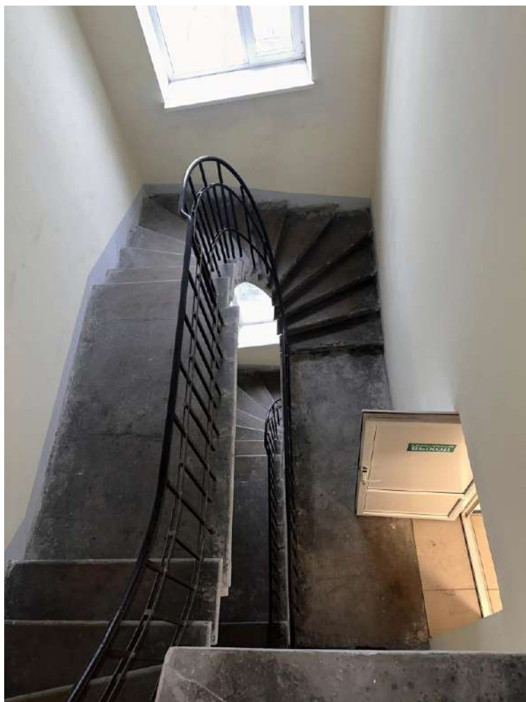
Фото 60. ЛК-2. Общий вид лестницы с 4-го этажа с юго-запада. Дата съемки: 03.02.2025 г. Автор съемки: Глинская Н.Б.
