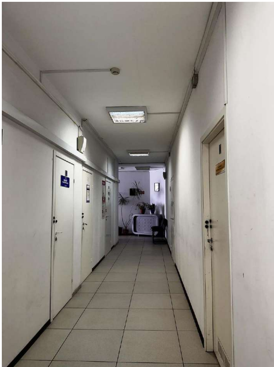
Фото 53. 4-ый этаж. Пом. 4.15. Общий вид помещения с юго-запада. Дата съемки: 03.02.2025 г. Автор съемки: Глинская Н.Б.
