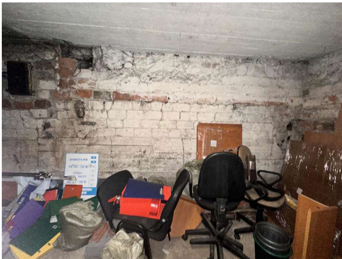
Фото 36. Подвал. Пом. 0.38. Фрагмент северо-западной стены помещения. Дата съемки: 03.02.2025 г. Автор съемки: Глинская Н.Б.
