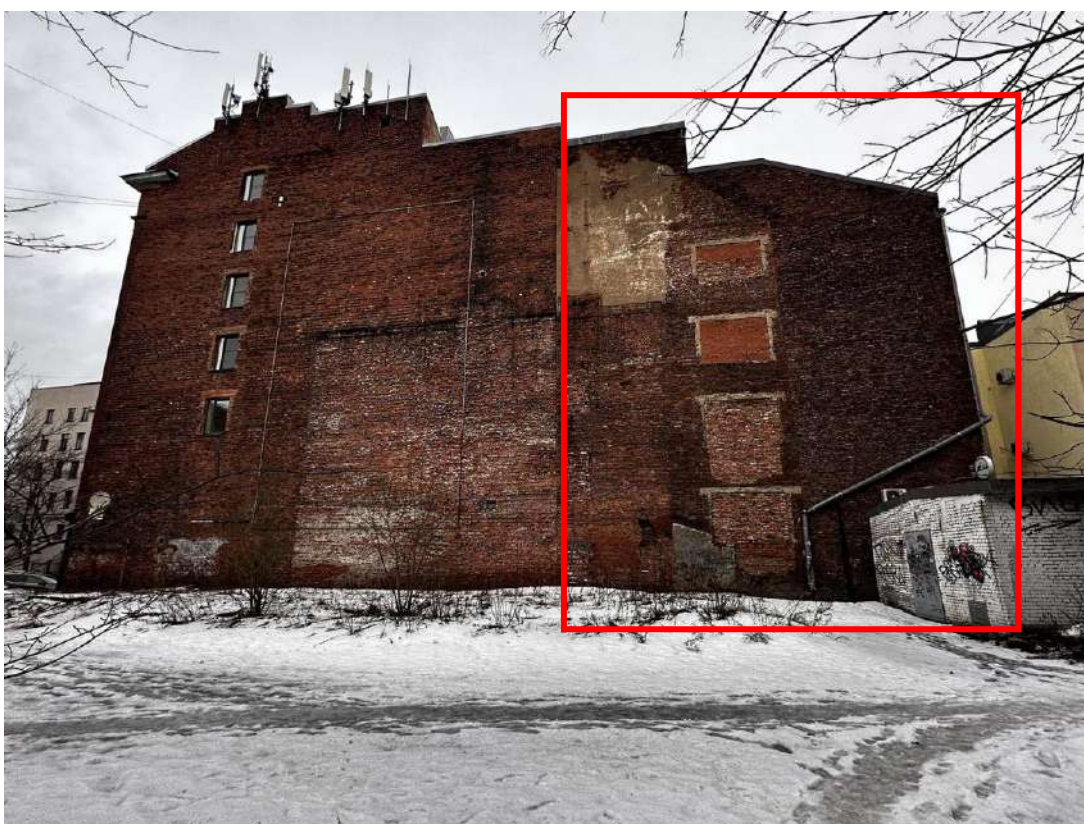
Фото 4. Общий вид юго-западной торцевой стены объекта культурного наследия регионального значения «Гостиница и контора типографии», г. Выборг, Ленинградский пр., 19. Фото с юго-запада (выделен дворовый корпус, являющийся неотъемлемой частью объекта культурного наследия (офиц. адрес: ул. Димитрова, 4). Дата съемки: 03.02.2025 г. Автор съемки: Глинская Н.Б.
