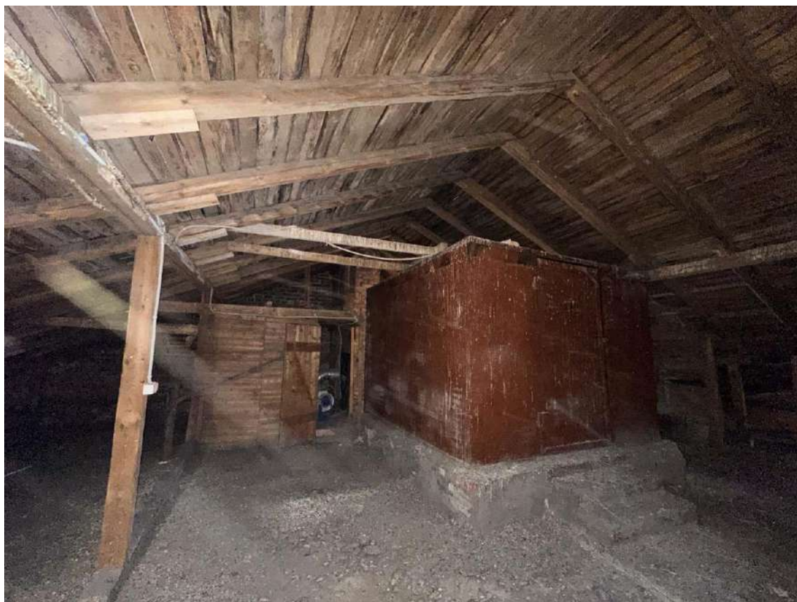
Фото 66. Чердак. Центральная юго-восточная часть помещения. Фото с запада. Дата съемки: 03.02.2025 г. Автор съемки: Глинская Н.Б.
