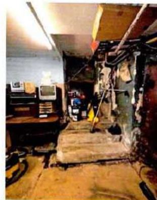
Уличный корпус. Подвал. Пом. 0.6. Бетонная лестница
