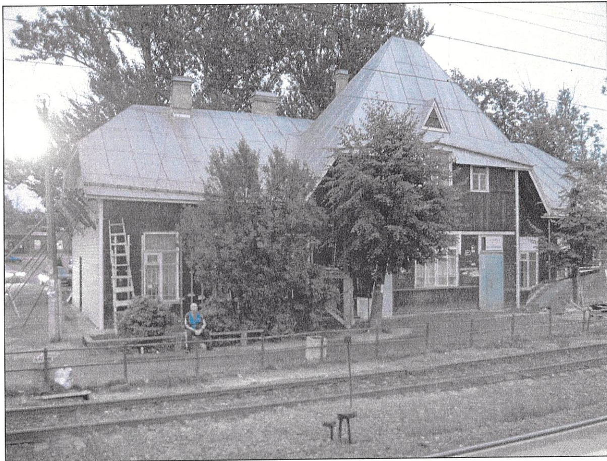
2.1.14. Здание вокзала в процессе обшивки сайдингом, август 2008 г. (фото Сергеева Д.В.)
