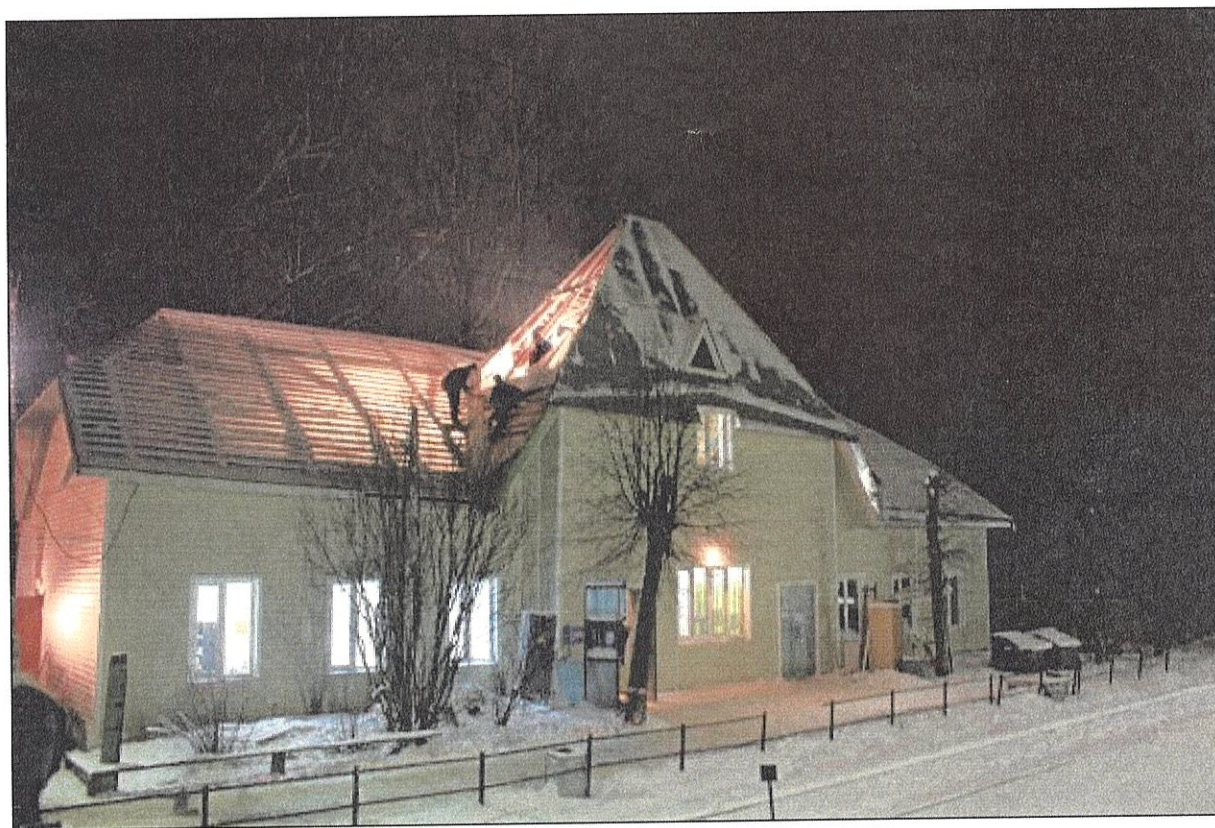
2.1.15. Здание токовского вокзала в процессе перекрытия крыши (после демонтажа верхней части кирпичных печных труб), декабрь 2008 г. (фото Сергеева Д.В.)
