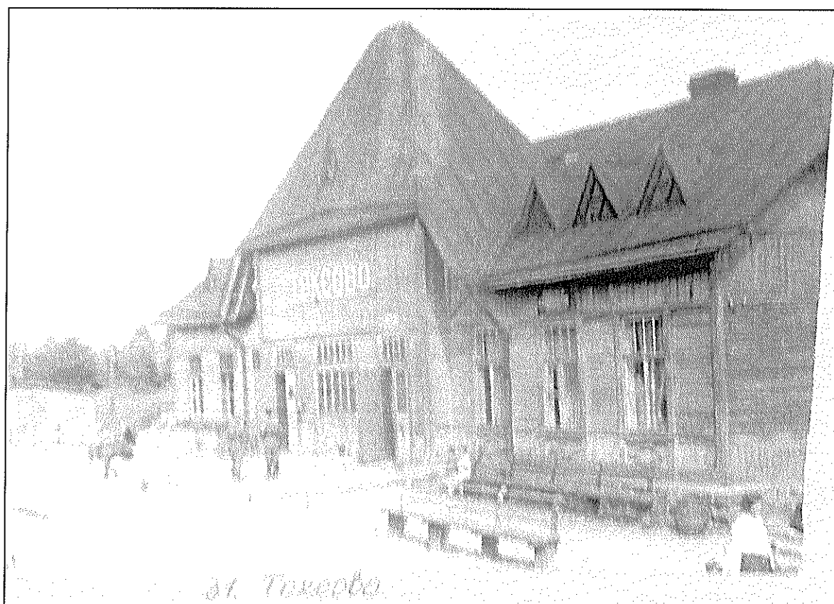
2.1.6. Фото вокзала на станции Токсово 1946 г., лицевой фасад (фонды Дорожного центра научно-технической информации ОЖД; переснято Сергеевым Д.В. с оригинала в альбоме в 2010 г.)
