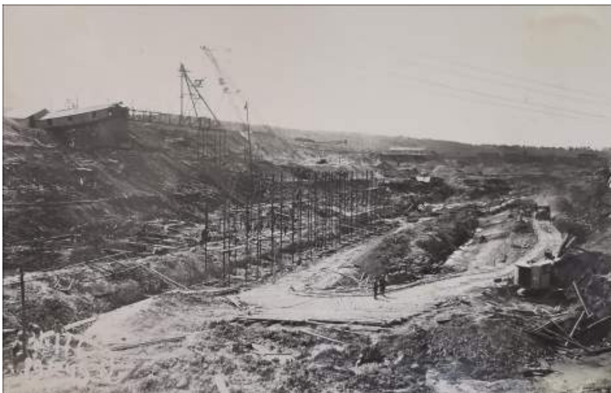
19. Строительство Верхне-Свирского гидроузла. Котлован шлюзовой камеры. Монтаж эстакады и транспортёров для подачи бетона. Фото 12 июня 1949 г. //Технический архив Верхне-Свирского шлюза.
