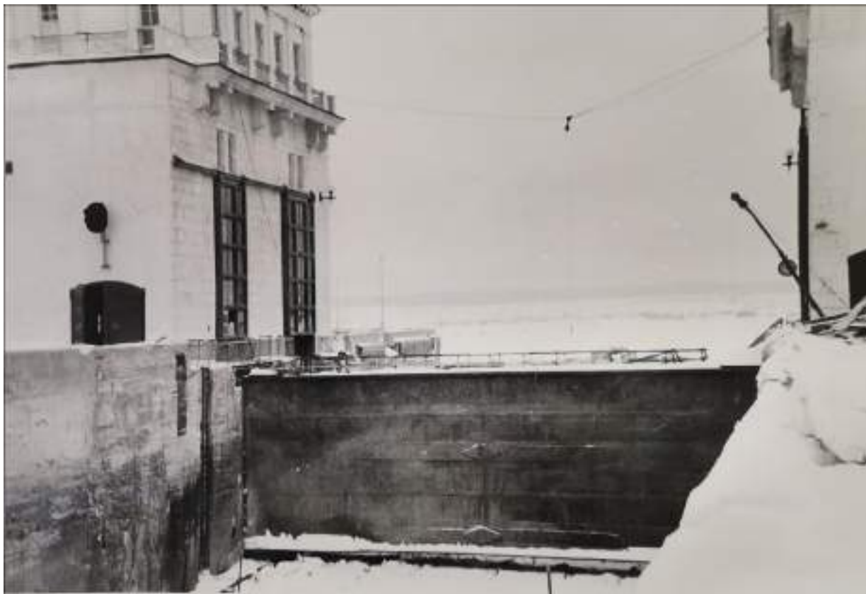
68. Верхне-Свирский гидроузел. Верхняя голова судоходного шлюза. Шлюзовые ворота. Фото февраля 1965 г. //Технический архив Верхне-Свирского шлюза.
