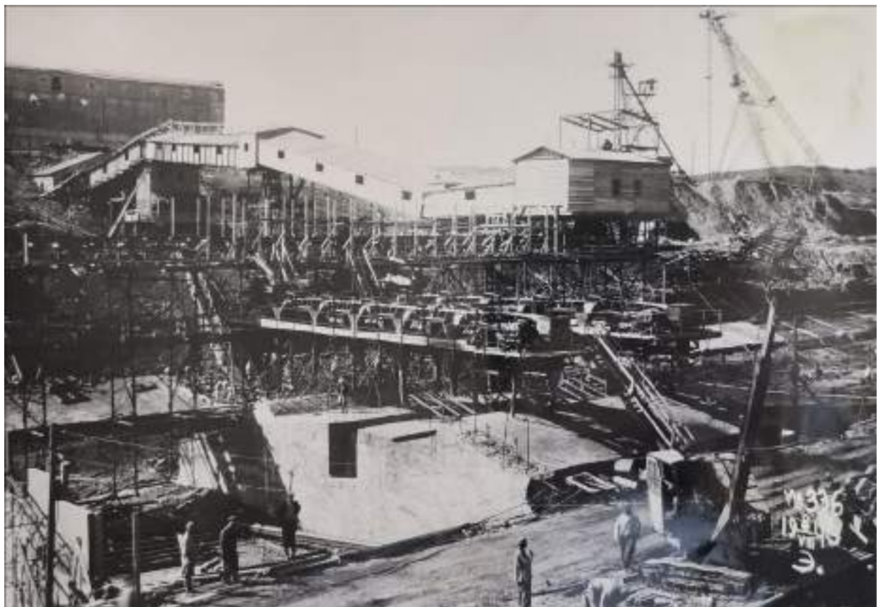
23. Строительство Верхне-Свирского гидроузла. Бетонирование блоков днища шлюзовой камеры. Фото 8 августа 1949 г. //Технический архив Верхне-Свирского шлюза.
