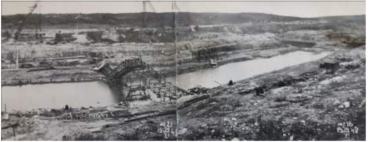
14. Строительство Верхне-Свирского гидроузла. Котлован шлюзовой камеры. Фото 14 июня 1948 г. //Технический архив Верхне-Свирского шлюза.
