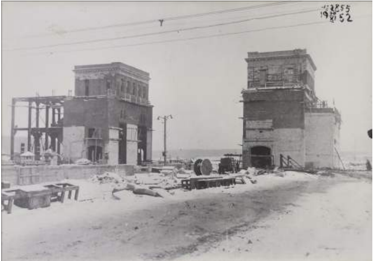
60. Строительство Верхне-Свирского гидроузла. Здания верхней головы шлюза в процессе возведения. Фото 30 ноября 1952 г. //Технический архив Верхне-Свирского шлюза.
