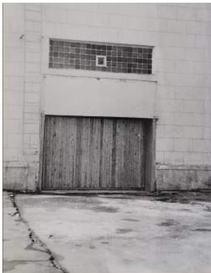
73. Верхне-Свирский гидроузел. Верхняя голова судоходного шлюза. Здание затворов наполнения и механизмов ворот. Северный фасад. Воротной проём после реконструкции. Фото 1981 г. //Технический архив Верхне-Свирского шлюза.
