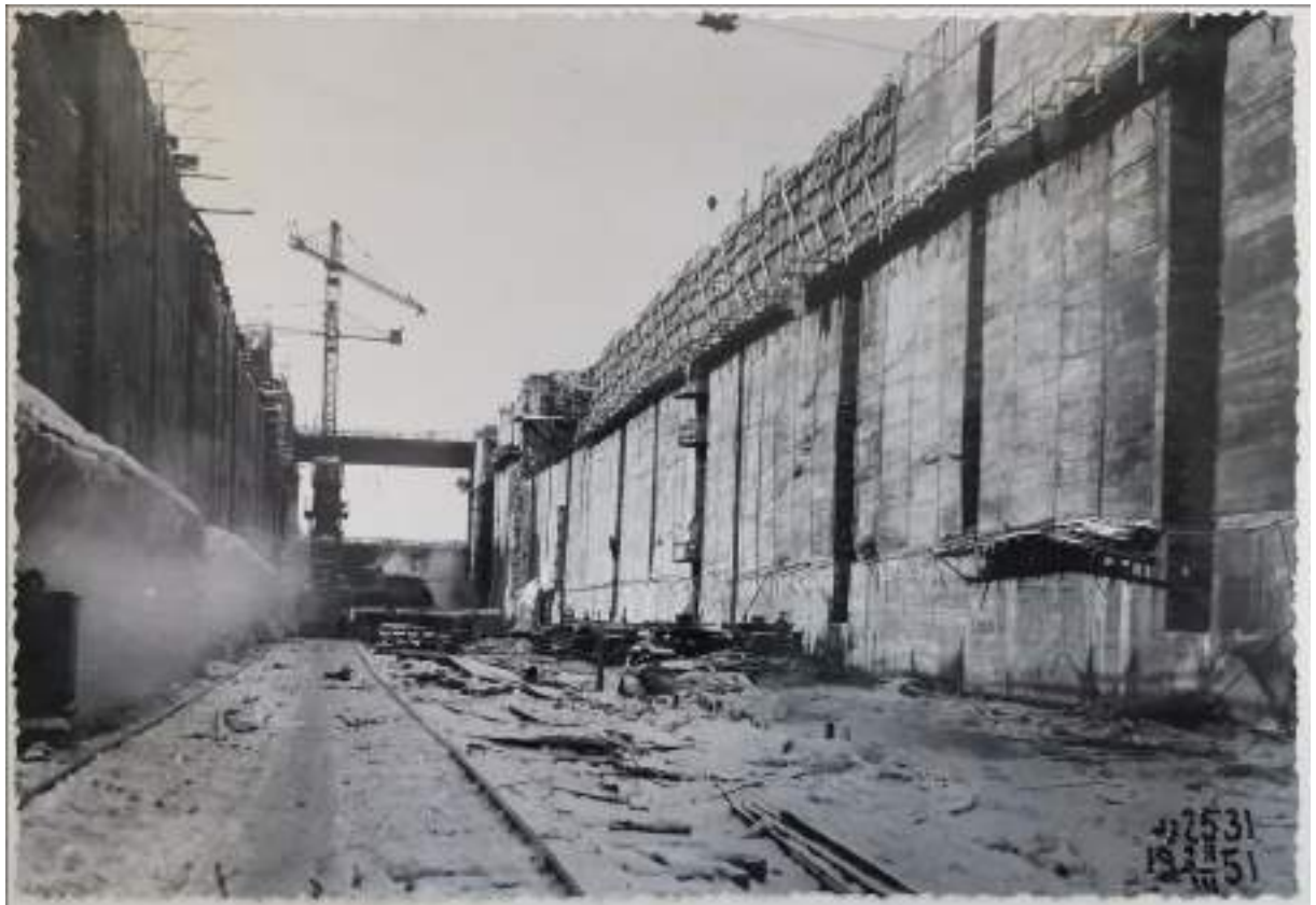
41. Строительство Верхне-Свирского гидроузла. Шлюзовая камера. Фото 28 марта 1951 г. //Технический архив Верхне-Свирского шлюза.
