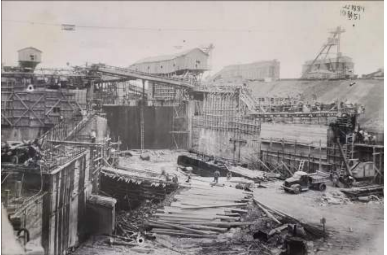
44. Строительство Верхне-Свирского гидроузла. Нижняя голова шлюза. Вид со стороны нижнего подходного канала. Установлен ремонтный затвор. Фото 21 июня 1951 г. //Технический архив Верхне-Свирского шлюза.
