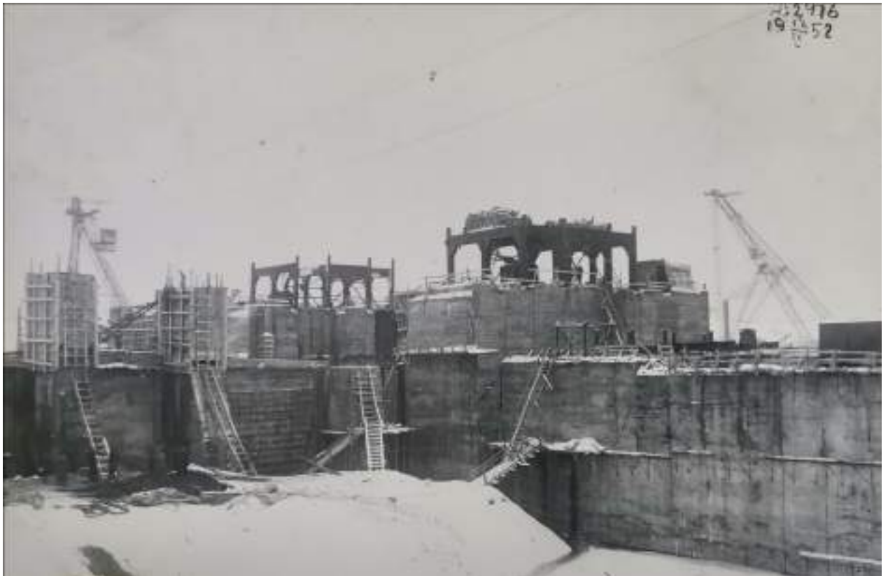
49. Строительство Верхне-Свирского гидроузла. Монтаж металлических эстакад для механизмов верхней головы шлюза. Фото 12 февраля 1952 г. //Технический архив Верхне-Свирского шлюза.
