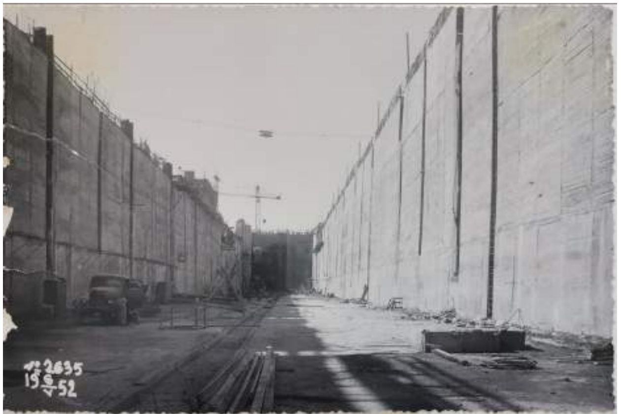
55. Строительство Верхне-Свирского гидроузла. Шлюзовая камера. Фото 6 мая 1952 г. //Технический архив Верхне-Свирского шлюза.
