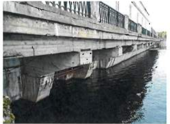
Фото 4. Волосливая бетонная плотина
