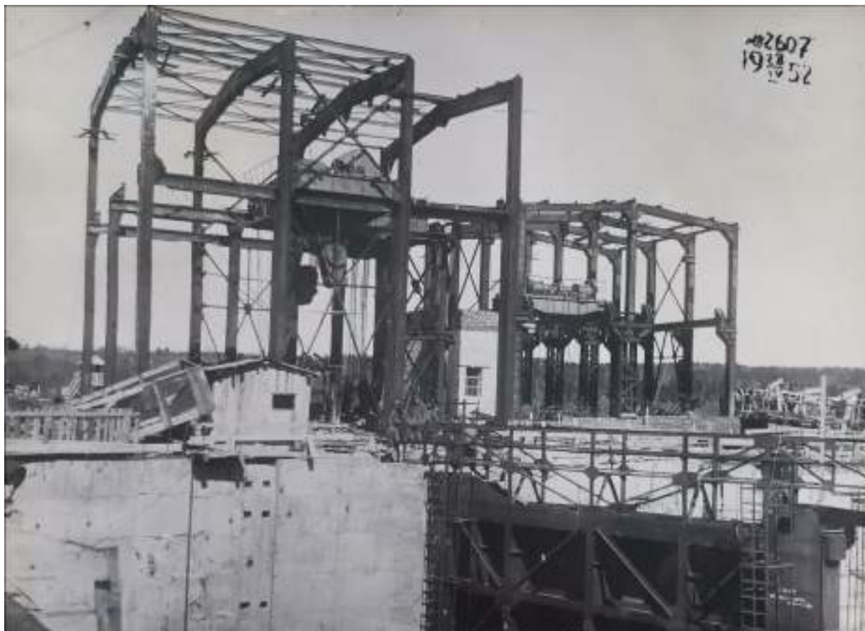
53. Строительство Верхне-Свирского гидроузла. Здание нижней головы шлюза. Фото 28 апреля 1952 г. //Технический архив Верхне-Свирского шлюза.
