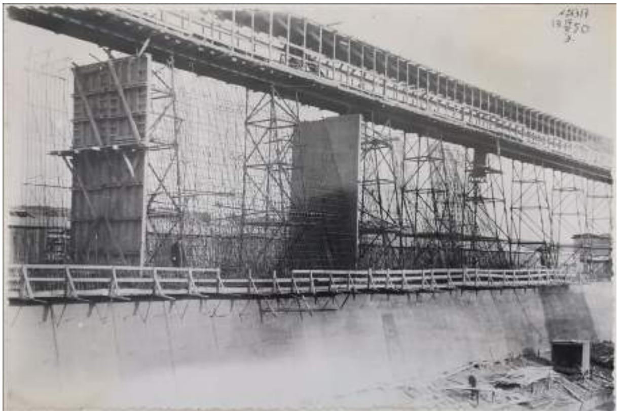
39. Строительство Верхне-Свирского гидроузла. Установка армокаркасов блоков второго и третьего ярусов шлюзовой камеры. Фото 19 октября 1950 г. //Технический архив Верхне-Свирского шлюза.
