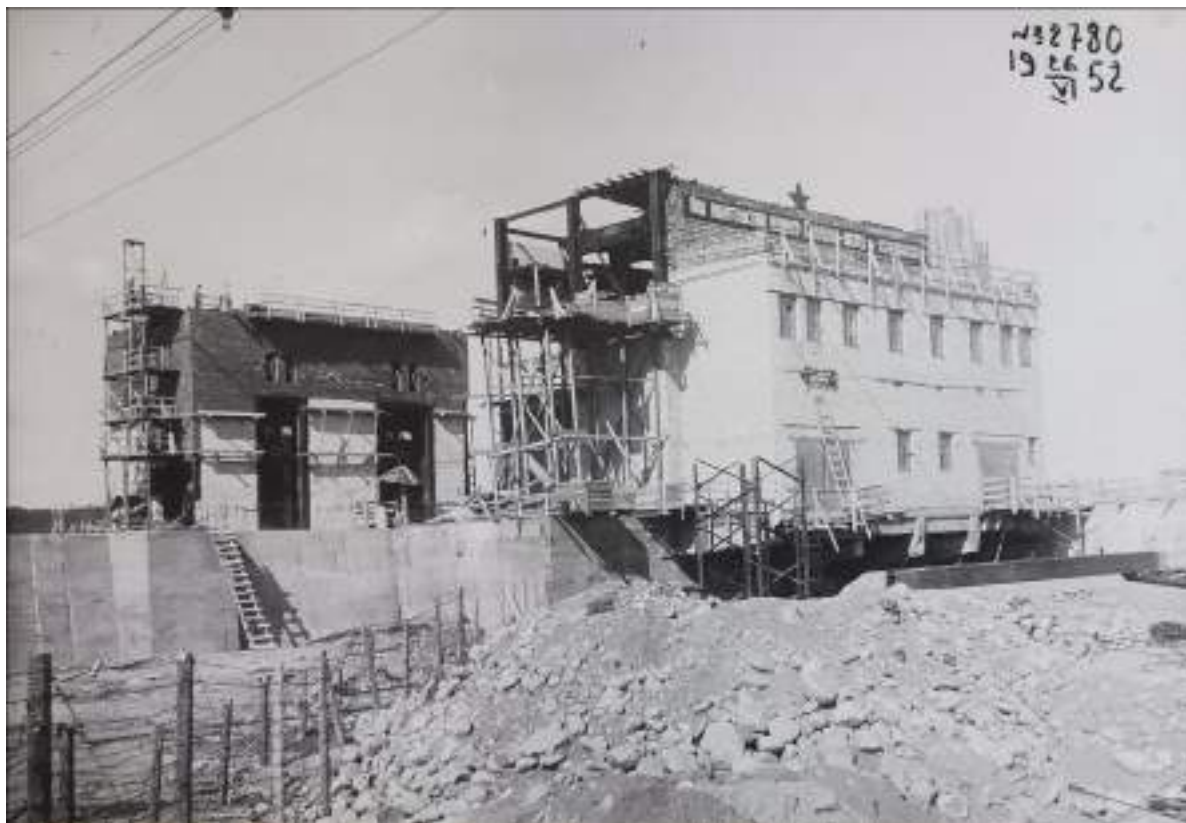
58. Строительство Верхне-Свирского гидроузла. Здания верхней головы шлюза в процессе возведения. Фото 26 июня 1952 г. //Технический архив Верхне-Свирского шлюза.
