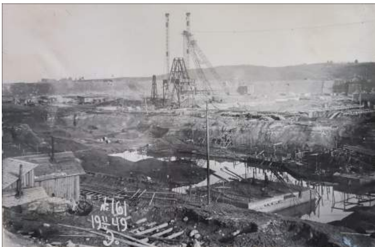
17. Строительство Верхне-Свирского гидроузла. Котлован нижней головы шлюза после откачки воды. Фото 11 мая 1949 г. //Технический архив Верхне-Свирского шлюза.
