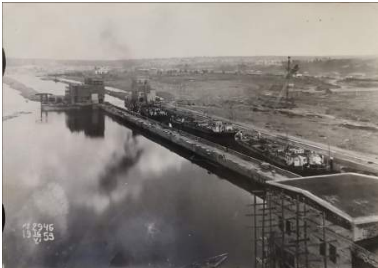
62. Верхне-Свирский гидроузел. Судходный шлюз в период временной эксплуатации. Фото 16 июня 1953 г. //Технический архив Верхне-Свирского шлюза.
