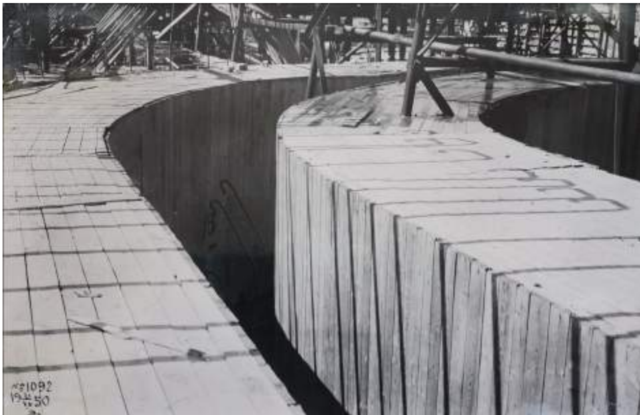
34. Строительство Верхне-Свирского гидроузла. Установка опалубки водопроводных галерей нижней головы шлюза. Фото 31 июля 1950 г. //Технический архив Верхне-Свирского шлюза.
