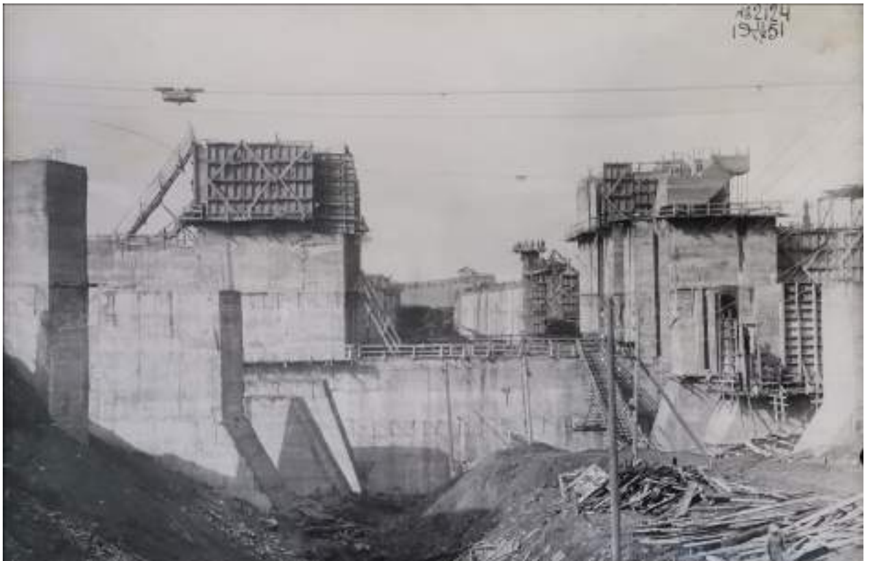
45. Строительство Верхне-Свирского гидроузла. Верхняя голова шлюза. Фото 11 сентября 1951 г. //Технический архив Верхне-Свирского шлюза.
