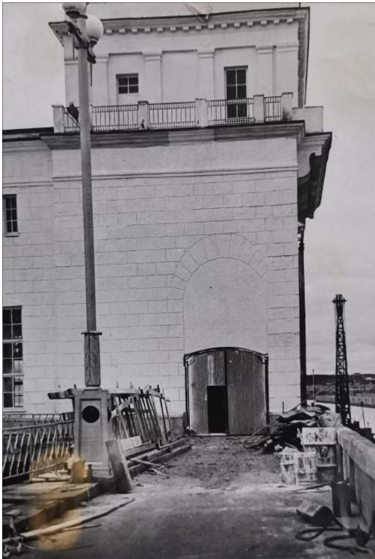
71. Верхне-Свирский гидроузел. Верхняя голова судоходного шлюза. Здание затворов наполнения и механизмов ворот. Западный фасад. Фрагмент. Фото 1967 г. //Технический архив Верхне-Свирского шлюза.
