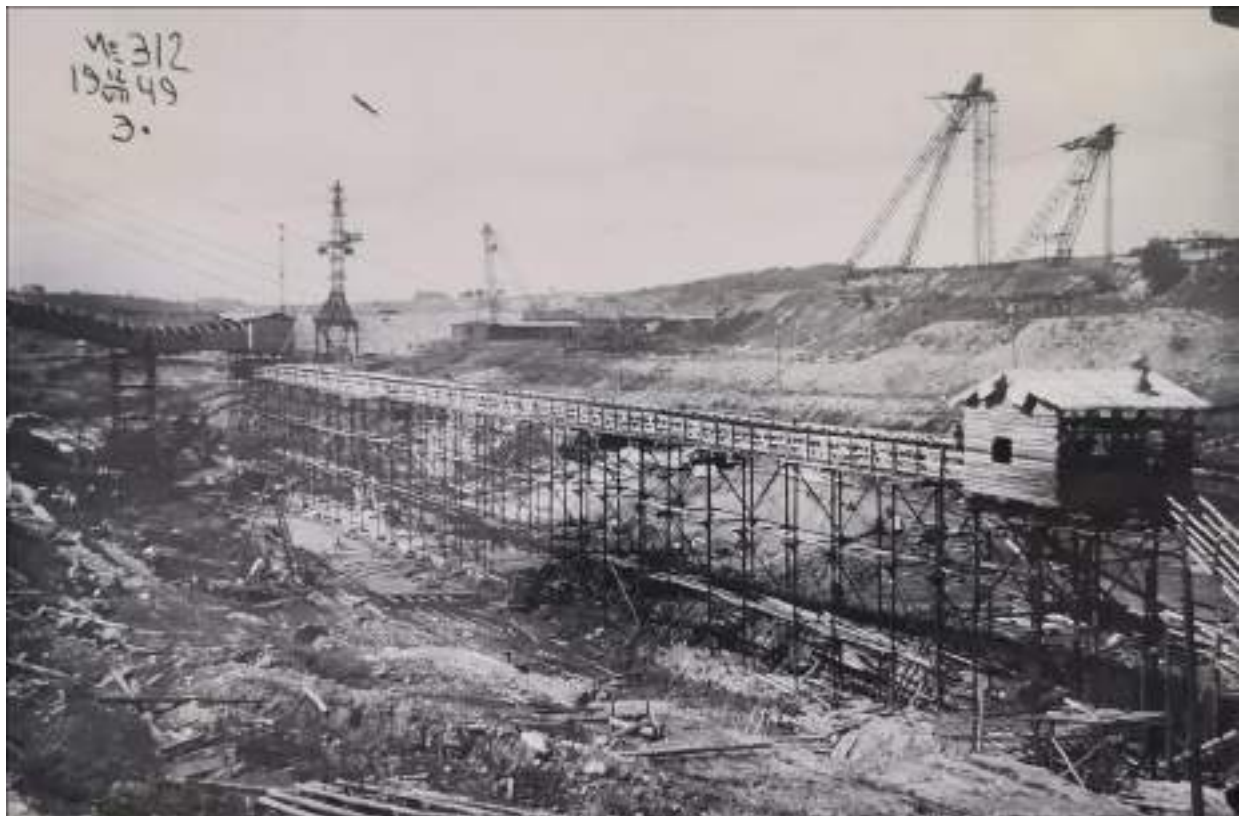
22. Строительство Верхне-Свирского гидроузла. Шлюзовая камера. Монтаж эстакад и транспортёров для подачи бетона. Фото 12 июля 1949 г. //Технический архив Верхне-Свирского шлюза.
