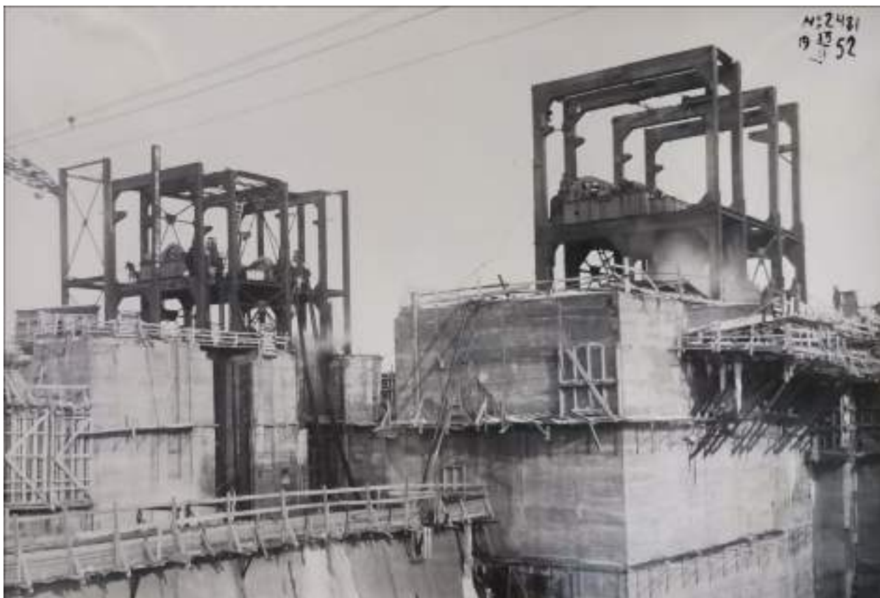
51. Строительство Верхне-Свирского гидроузла. Монтаж металлических эстакад для механизмов верхней головы шлюза. Фото 23 февраля 1952 г. //Технический архив Верхне-Свирского шлюза.
