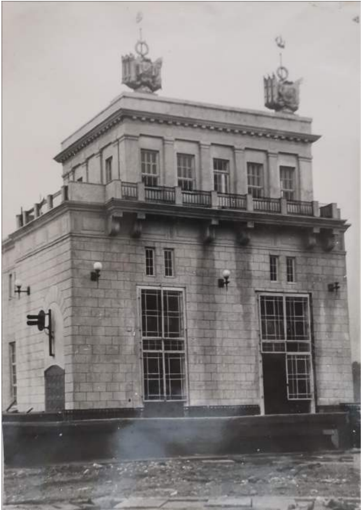
64. Верхне-Свирский гидроузел. Верхняя голова судоходного шлюза. Здание затворов наполнения и механизмов ворот. Южный фасад. Фото 1955 г. //Технический архив Верхне-Свирского шлюза.
