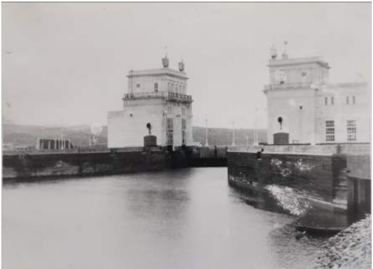
66. Верхне-Свирский гидроузел. Верхняя голова судоходного шлюза. Вид со стороны верхнего бьефа. Фото 1955 г. //Технический архив Верхне-Свирского шлюза.
