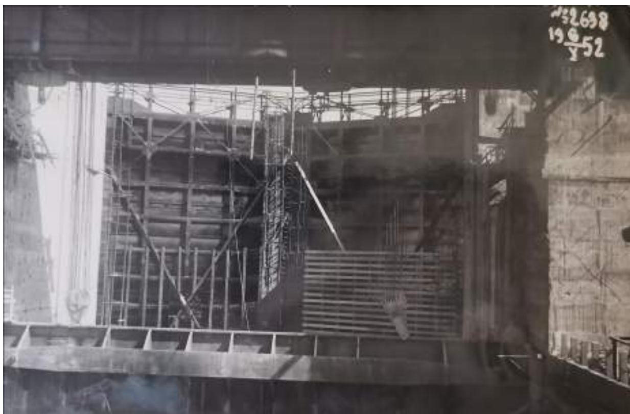
54. Строительство Верхне-Свирского гидроузла. Монтаж двухстворчатых ворот нижней головы. Фото 6 мая 1952 г. //Технический архив Верхне-Свирского шлюза.
