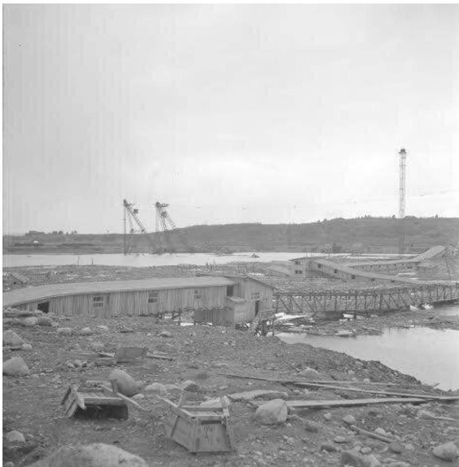
12. Строительная площадка Верхне-Свирского гидроузла. Фото 1941 – 1944. https://vk.com/albums-187089868
