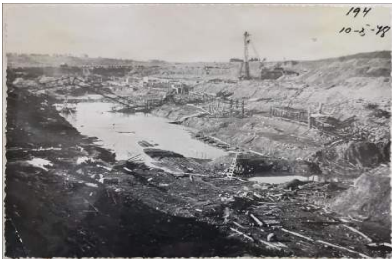
16. Строительство Верхне-Свирского гидроузла. Котлован шлюзовой камеры. Фото 10 октября 1948 г. //Технический архив Верхне-Свирского шлюза.
