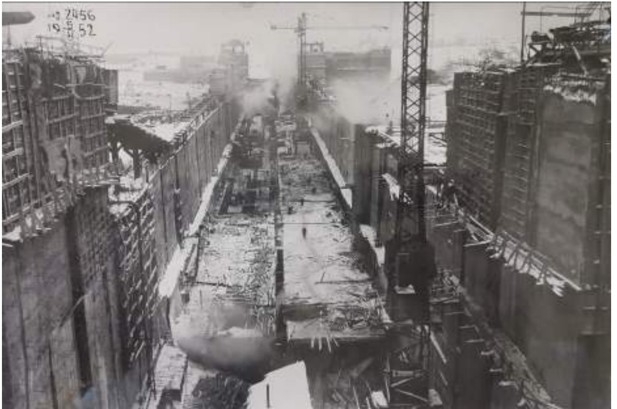
48. Строительство Верхне-Свирского гидроузла. Шлюзовая камера. Фото 5 февраля 1952 г. //Технический архив Верхне-Свирского шлюза.
