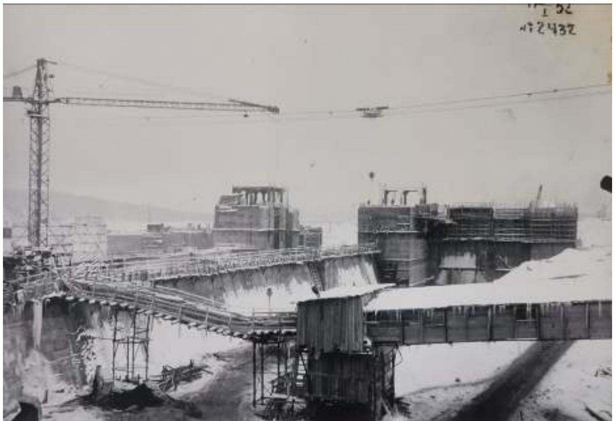
47. Строительство Верхне-Свирского гидроузла. Верхняя голова шлюза и прилегающая часть камеры. Фото 19 января 1952 г. //Технический архив Верхне-Свирского шлюза.
