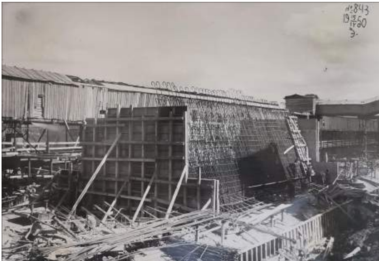
30. Строительство Верхне-Свирского гидроузла. Установка армокаркасов и опалубки для блоков первого яруса стен шлюзовой камеры. Фото 15 апреля 1950 г. //Технический архив Верхне-Свирского шлюза.
