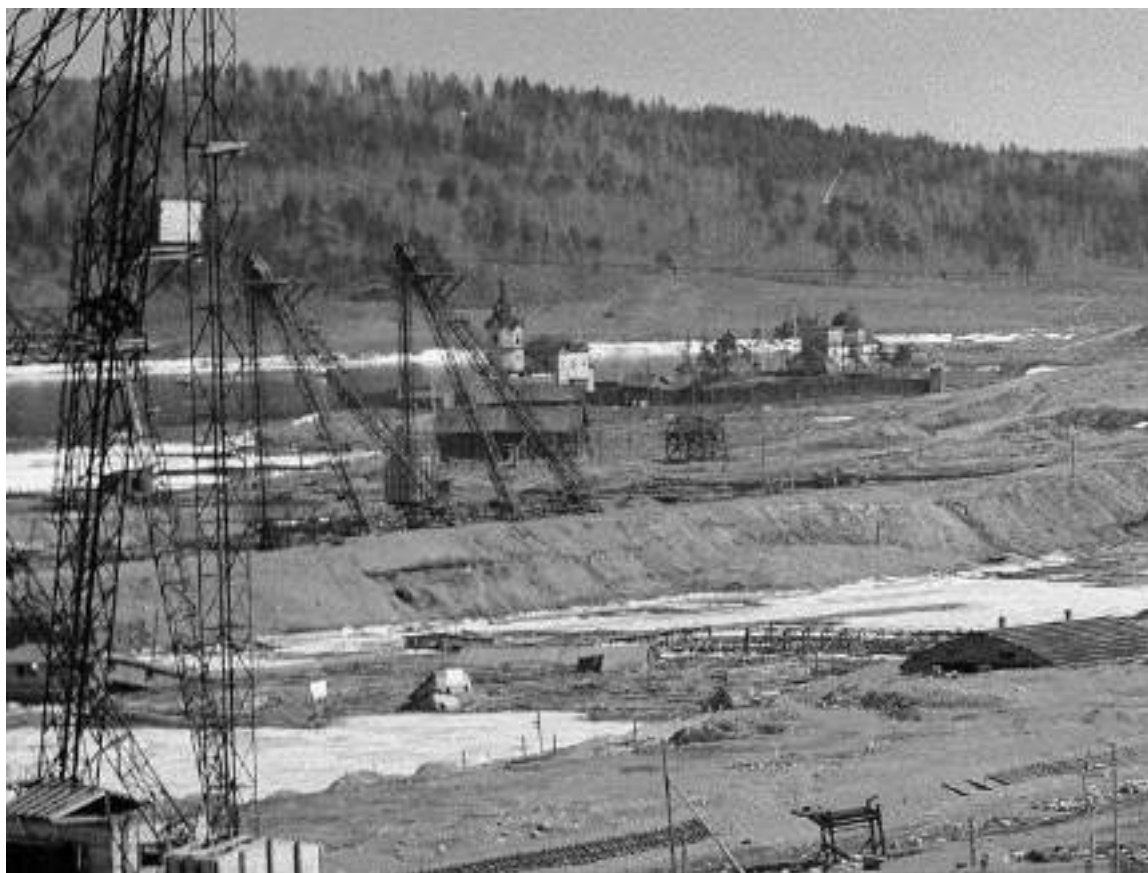
11. Строительная площадка Верхне-Свирского гидроузла. Фото 1941 – 1944. https://vk.com/albums-187089868
