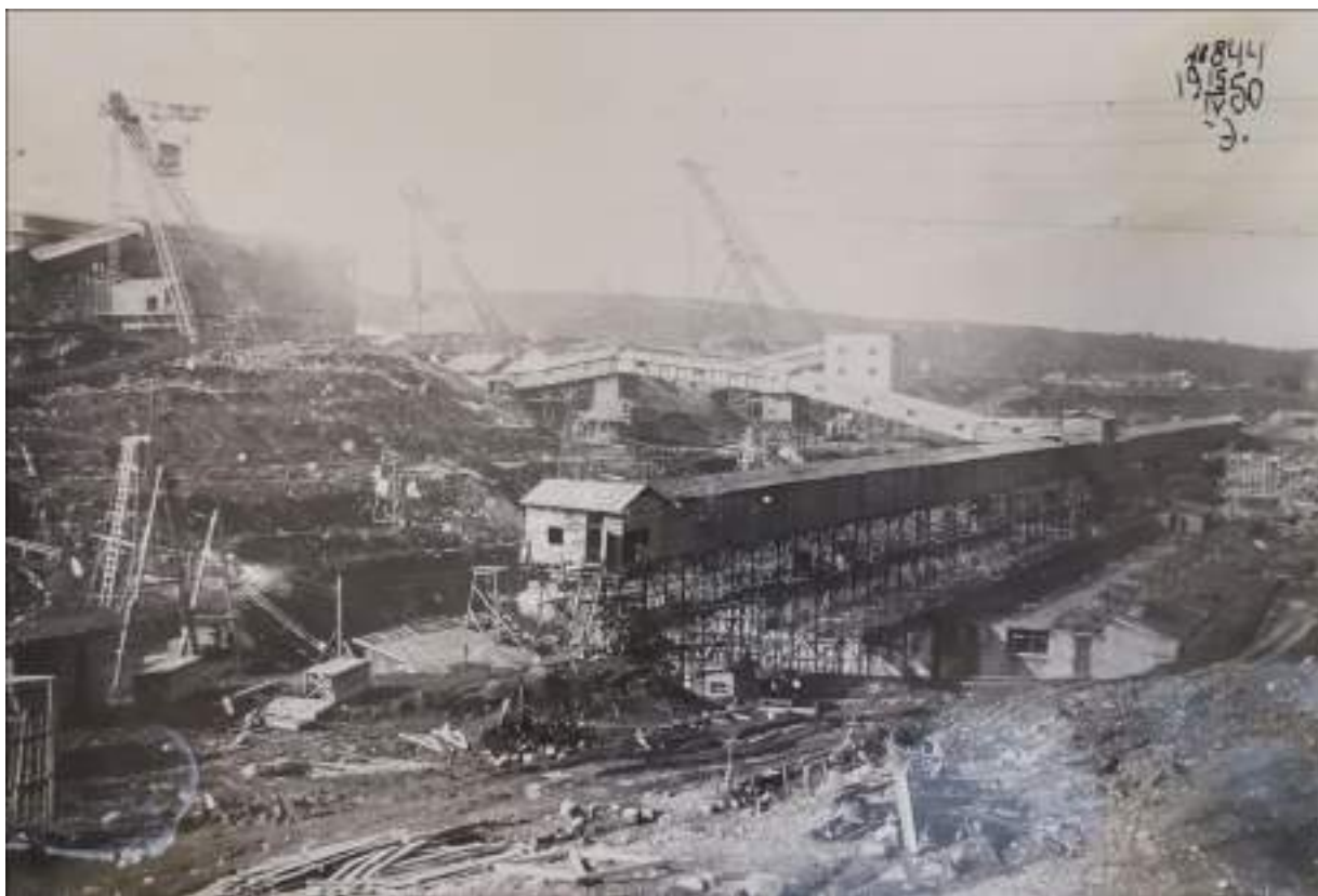
31. Строительство Верхне-Свирского гидроузла. Бетонирование блоков днища шлюзовой камеры. Фото 15 апреля 1950 г. //Технический архив Верхне-Свирского шлюза.
