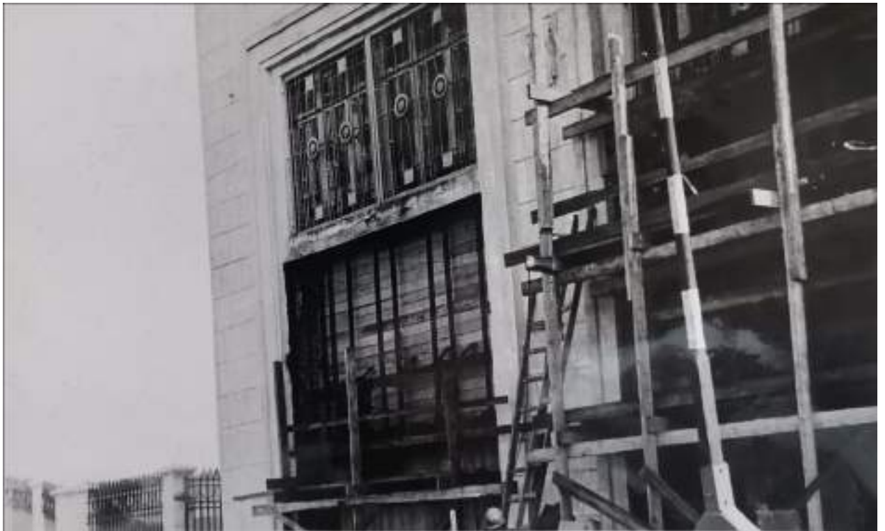
75. Верхне-Свирский гидроузел. Здание нижней головы шлюза. Северный фасад. Реконструкция ворот. Фото 1982 г. //Технический архив Верхне-Свирского шлюза.
