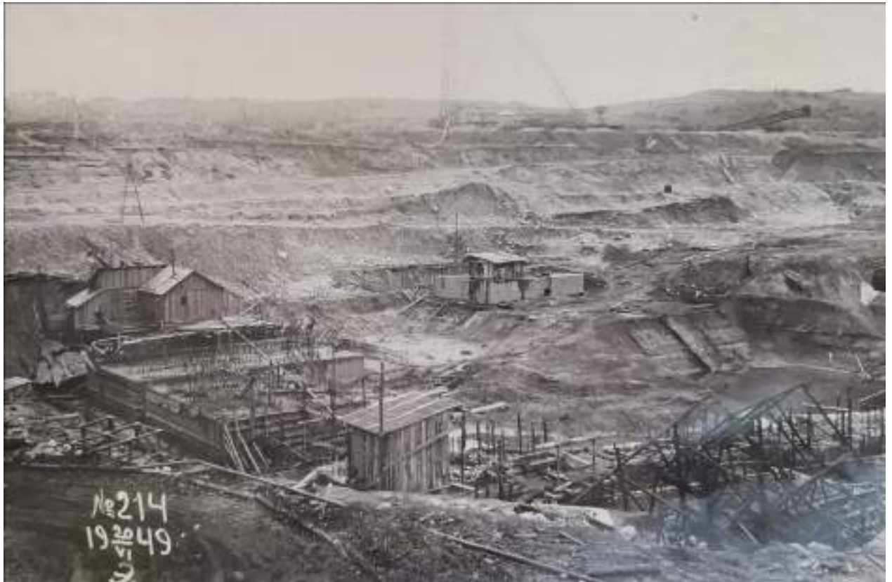
20. Строительство Верхне-Свирского гидроузла. Котлован нижней головы шлюза после откачки воды. Фото 20 июня 1949 г. //Технический архив Верхне-Свирского шлюза.
