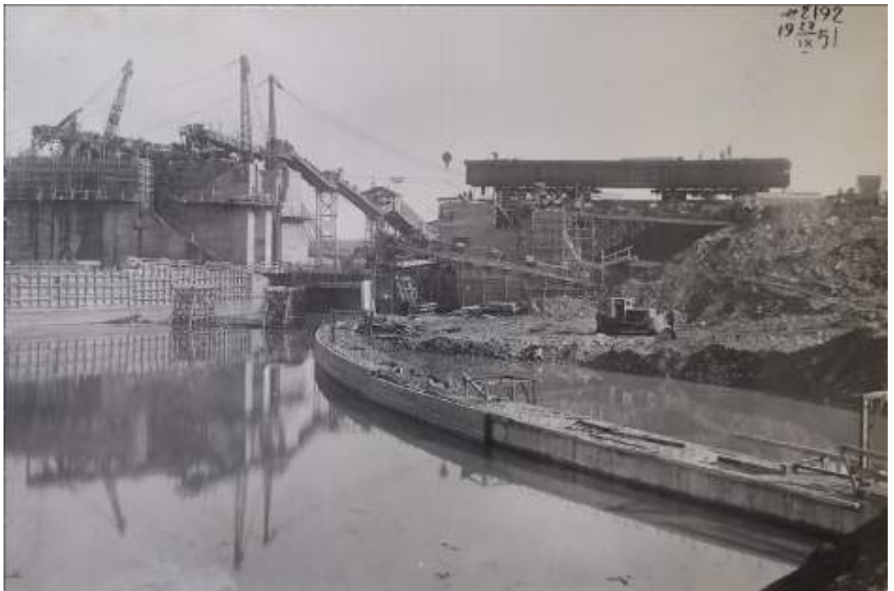
46. Строительство Верхне-Свирского гидроузла. Конструкции моста перед накаткой в пролёт. Фото 27 сентября 1951 г. //Технический архив Верхне-Свирского шлюза.
