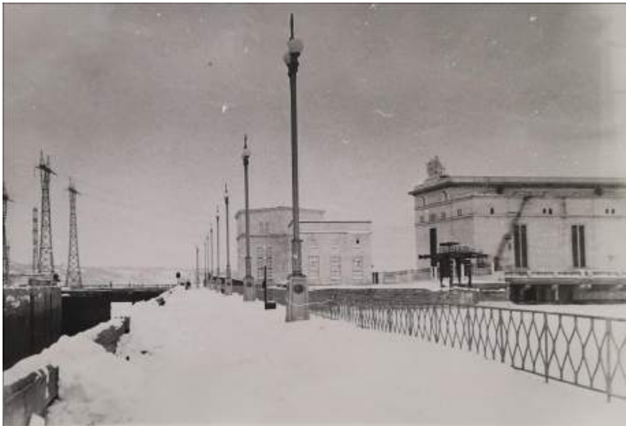
67. Верхне-Свирский гидроузел. Дамба между шлюзовой камерой и руслом Свири. Вид в сторону нижней головы и здания ГЭС. Фото февраля 1965 г. //Технический архив Верхне-Свирского шлюза.
