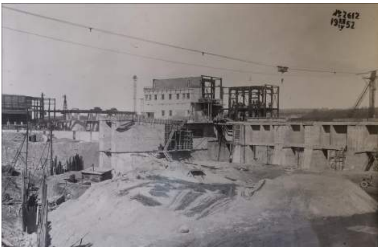
52. Строительство Верхне-Свирского гидроузла. Верхняя голова шлюза. Фото 28 апреля 1952 г. //Технический архив Верхне-Свирского шлюза.
