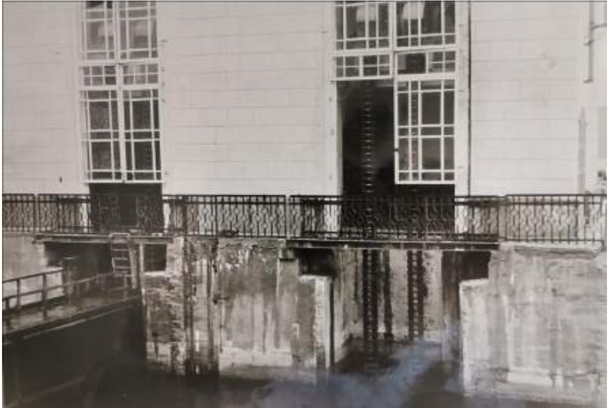
65. Верхне-Свирский гидроузел. Верхняя голова судоходного шлюза. Здание затворов наполнения и механизмов ворот. Южный фасад. Фрагмент. Фото 1955 г. //Технический архив Верхне-Свирского шлюза.
