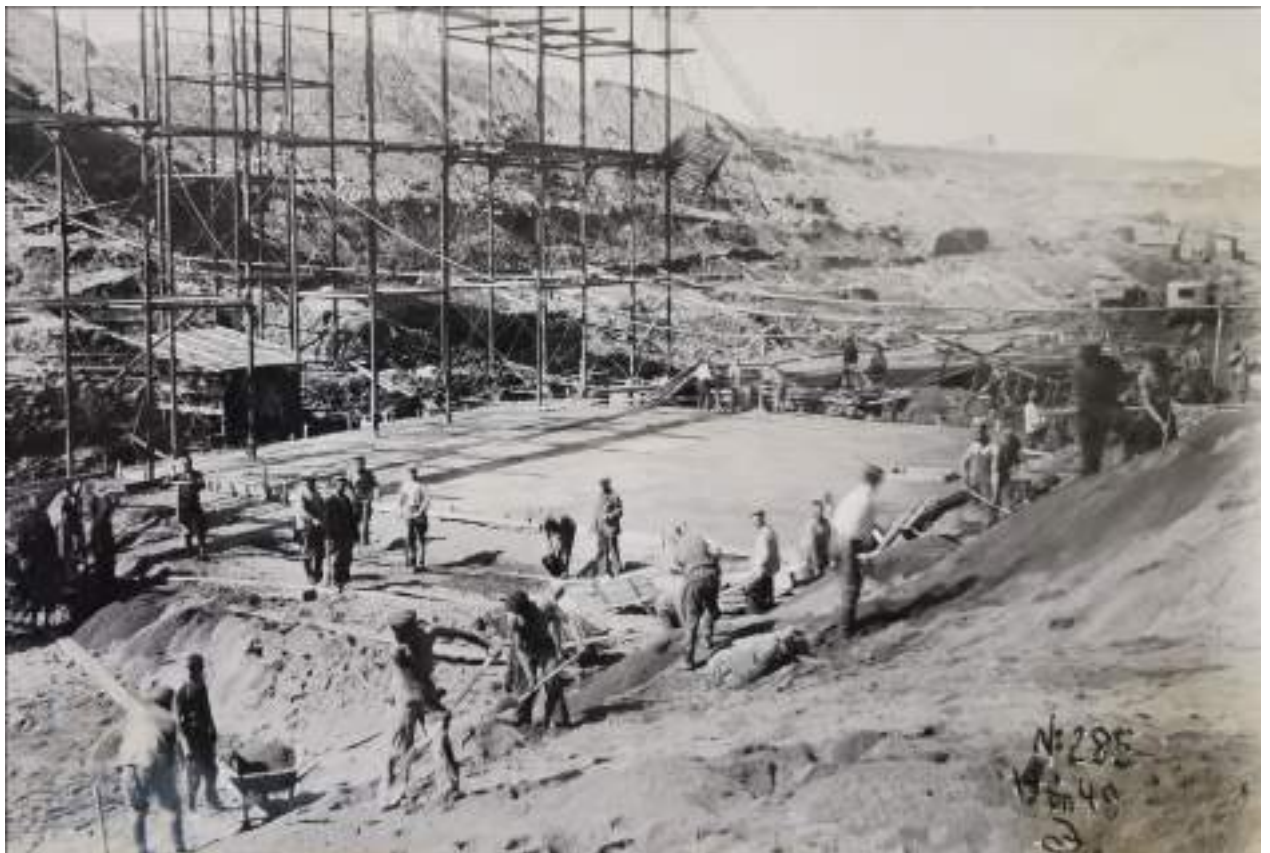
21. Строительство Верхне-Свирского гидроузла. Укладка обратного фильтра под днищем камеры шлюза. Фото 1 июля 1949 г. //Технический архив Верхне-Свирского шлюза.
