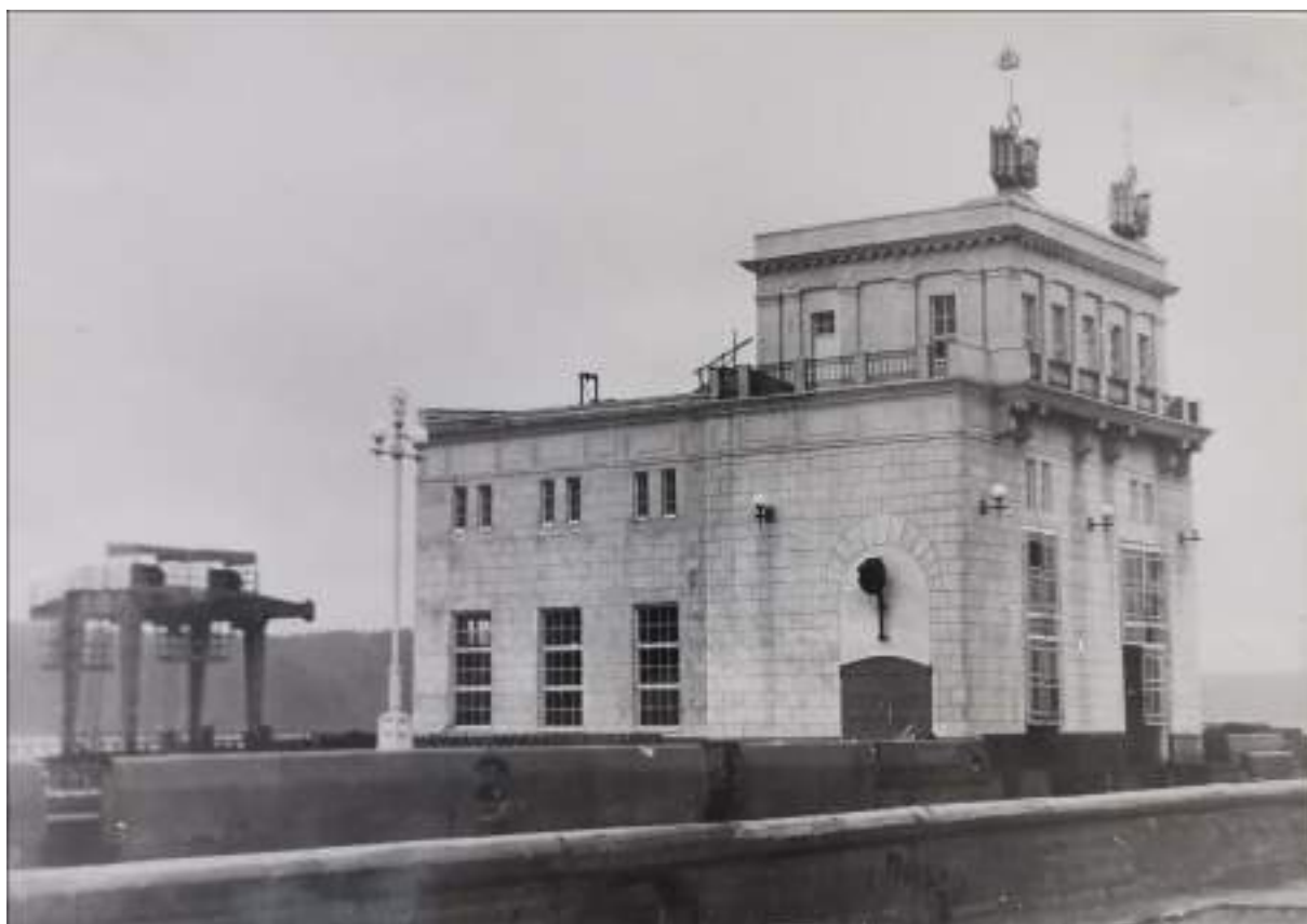
63. Верхне-Свирский гидроузел. Верхняя голова судходного шлюза. Здание затворов наполнения и механизмов ворот. Общий вид. Фото 1955 г. //Технический архив Верхне-Свирского шлюза.
