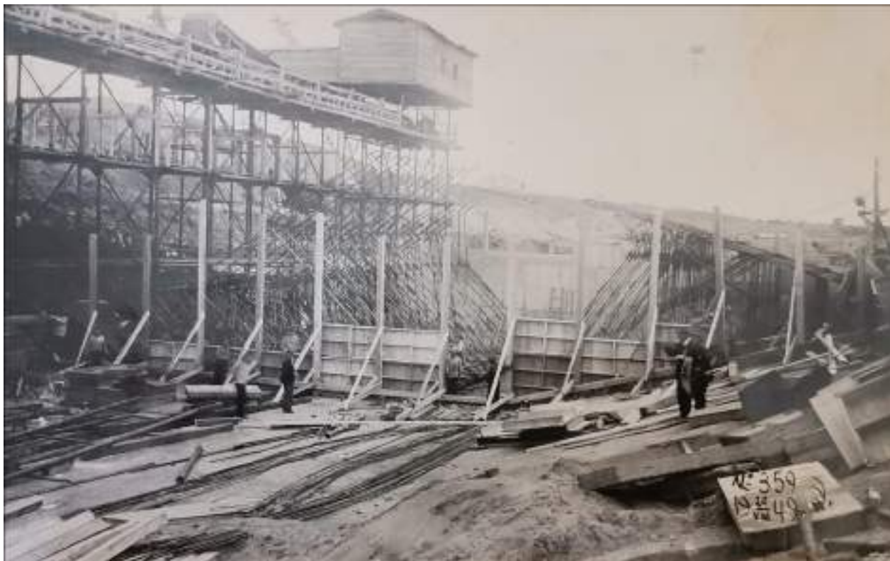
26. Строительство Верхне-Свирского гидроузла. Установка арматуры (армоферм) в блоки днища шлюзовой камеры. Фото 20 августа 1949 г. //Технический архив Верхне-Свирского шлюза.
