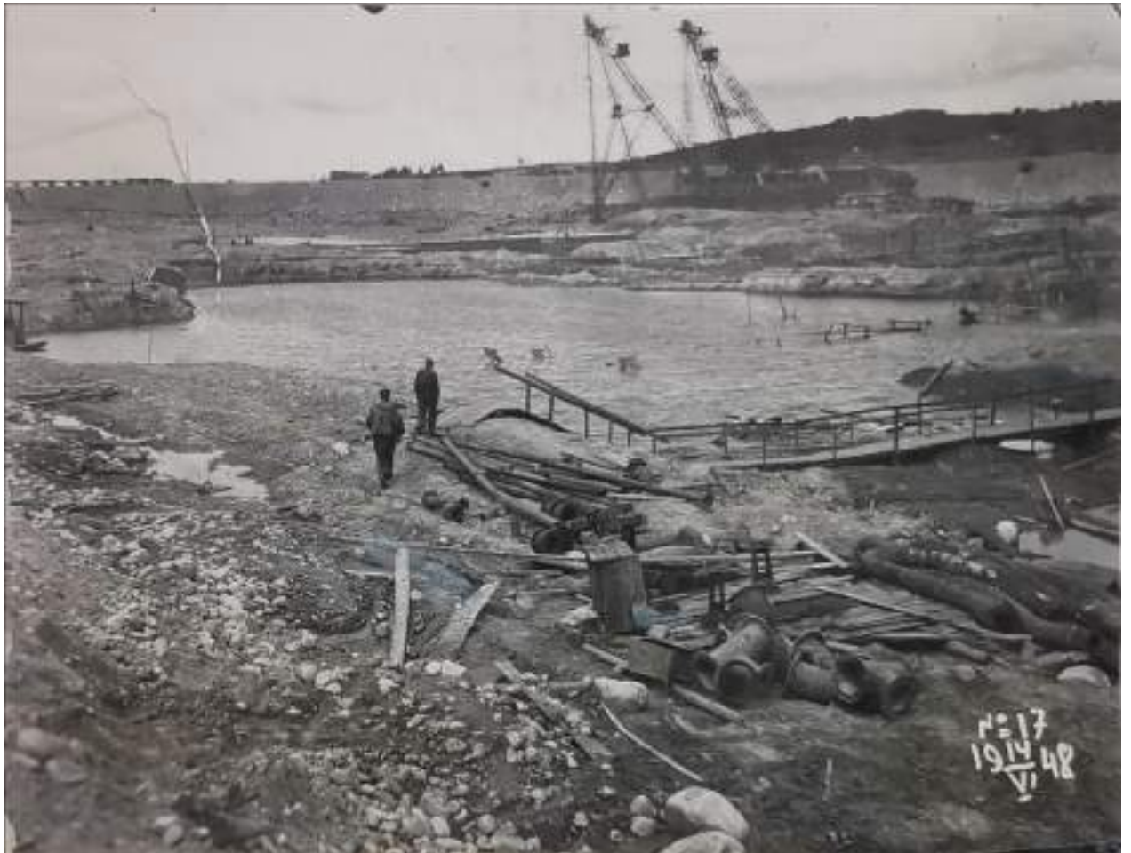
15. Строительство Верхне-Свирского гидроузла. Котлован нижней головы шлюза. Фото 14 июня 1948 г. //Технический архив Верхне-Свирского шлюза.
