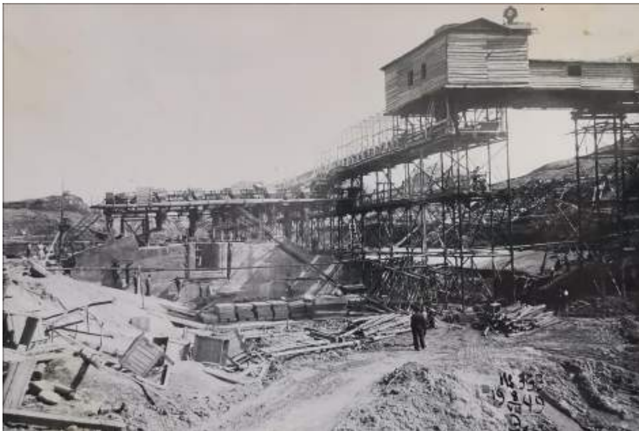
24. Строительство Верхне-Свирского гидроузла. Бетонирование блоков дна шлюзовой камеры. Фото 8 августа 1949 г. //Технический архив Верхне-Свирского шлюза.
