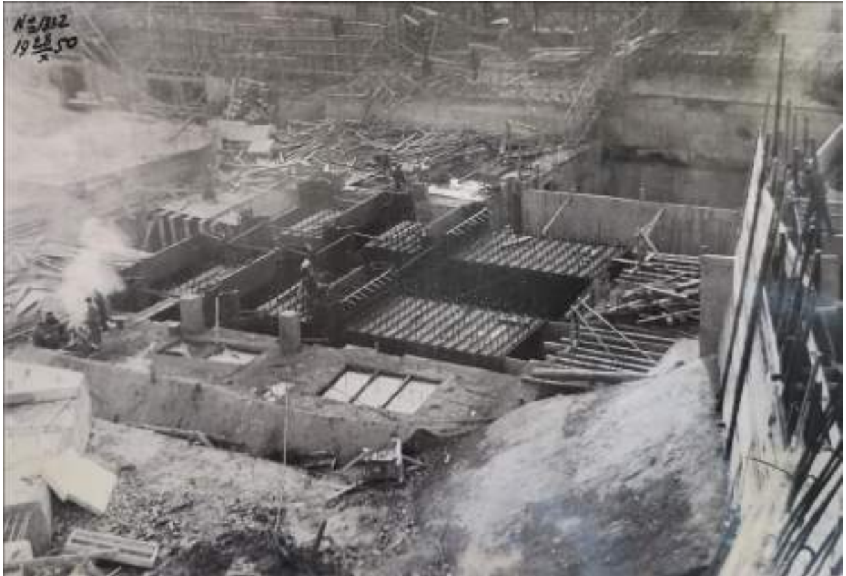
40. Строительство Верхне-Свирского гидроузла. Металлическая облицовка водопроводных галерей нижней головы шлюза. Фото 28 октября 1950 г. //Технический архив Верхне-Свирского шлюза.
