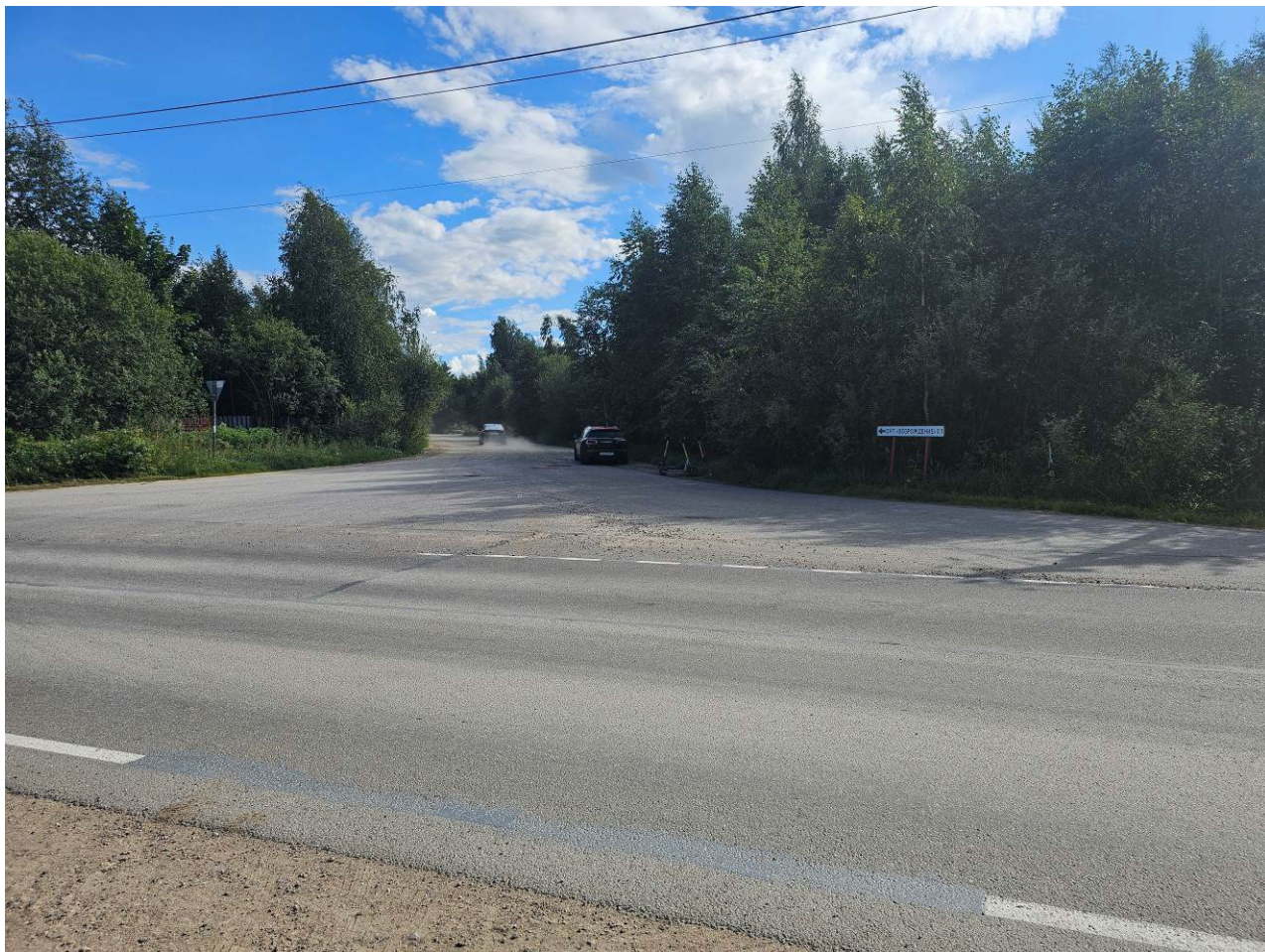
1. Участок проведения работ, частично попадающий в защитную зону объекта культурного наследия федерального значения «Водоподводящая система Петергофа» по адресу: г. Санкт-Петербург, город Петергоф, Ленинградская область, Ломоносовский район. Вид от Санинского шоссе на юго-восток
