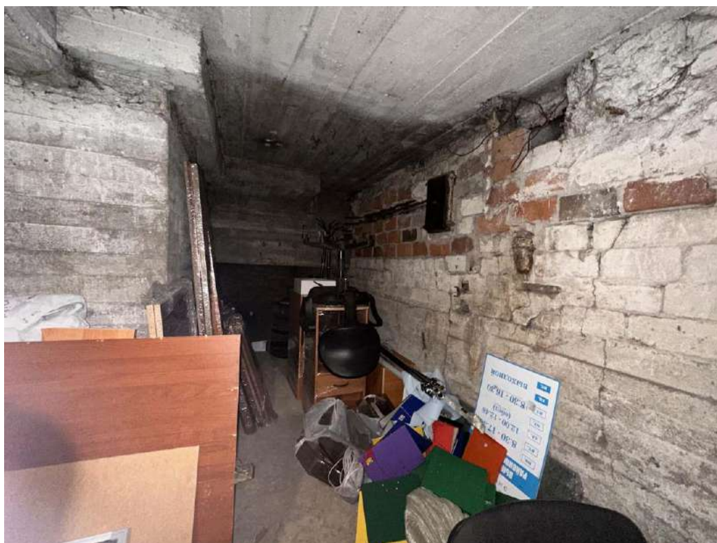
Фото 37. Подвал. Пом.0.38. Вид на юго-западную часть помещения с северо-востока. Дата съемки: 03.02.2025 г. Автор съемки: Глинская Н.Б.
