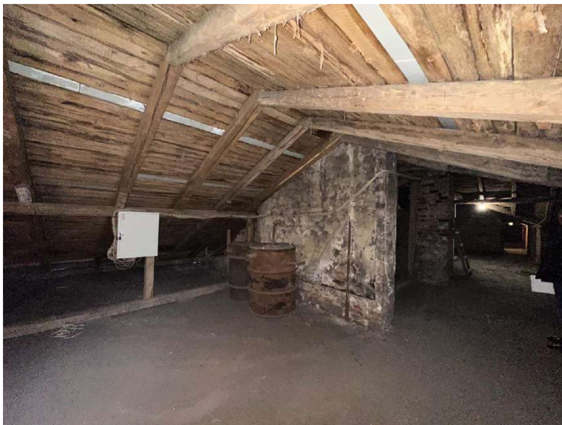
Фото 64. Чердак. Центральная часть помещения. Фото с юга. Дата съемки: 03.02.2025 г. Автор съемки: Глинская Н.Б.
