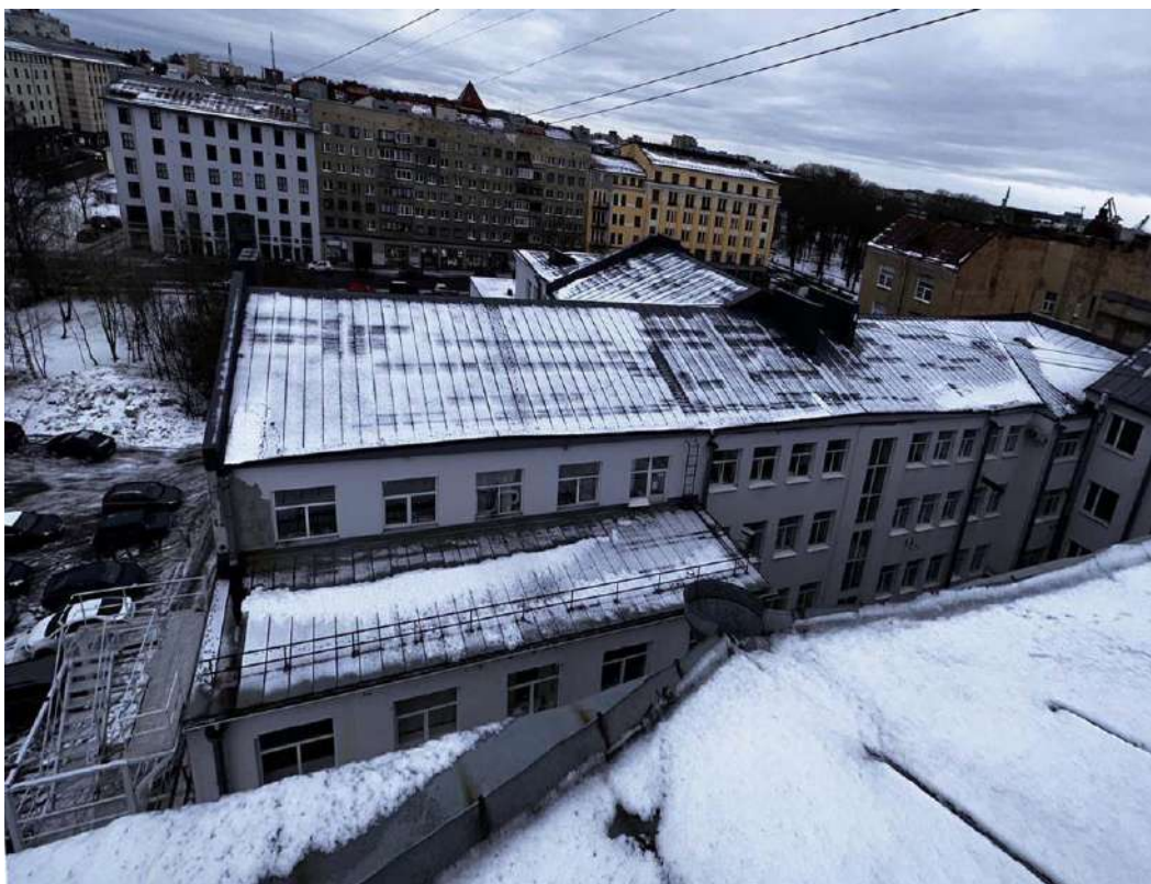
Фото 68. Вид на крышу дворового корпуса объекта культурного наследия регионального значения «Гостиница и контора типографии», Ленинградский пр. 19, являющегося неотъемлемой частью объекта культурного наследия (офиц. адрес: ул. Димитрова, 4). Фото с севера. Дата съемки: 03.02.2025 г. Автор съемки: Глинская Н.Б.
