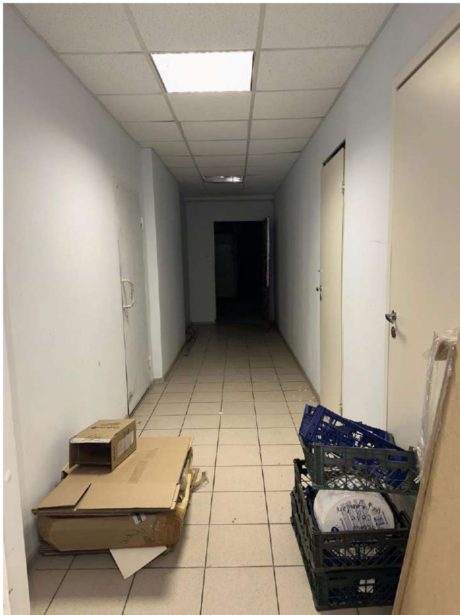
Фото 25. Подвал. Пом. 0.15. Общий вид помещения с юго-запада. Дата съемки: 03.02.2025 г. Автор съемки: Глинская Н.Б.
