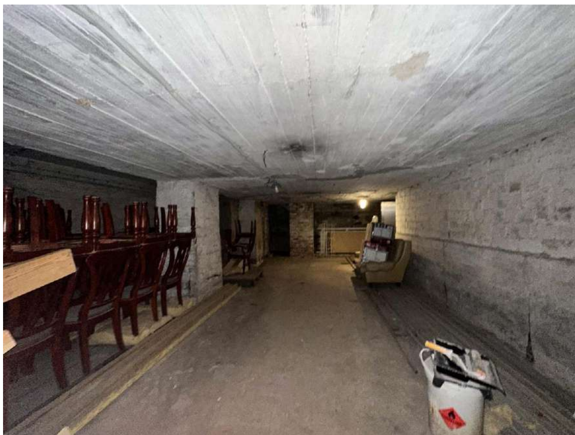
Фото 33. Подвал. Пом. 0.37. Общий вид помещения с юго-запада. Дата съемки: 03.02.2025 г. Автор съемки: Глинская Н.Б.
