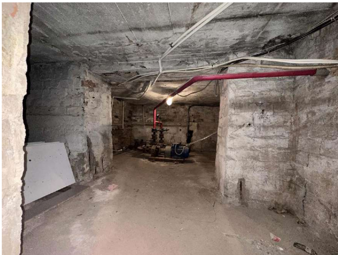
Фото 32. Подвал. Пом. 0.37. Общий вид помещения с северо-востока. Дата съемки: 03.02.2025 г. Автор съемки: Глинская Н.Б.
