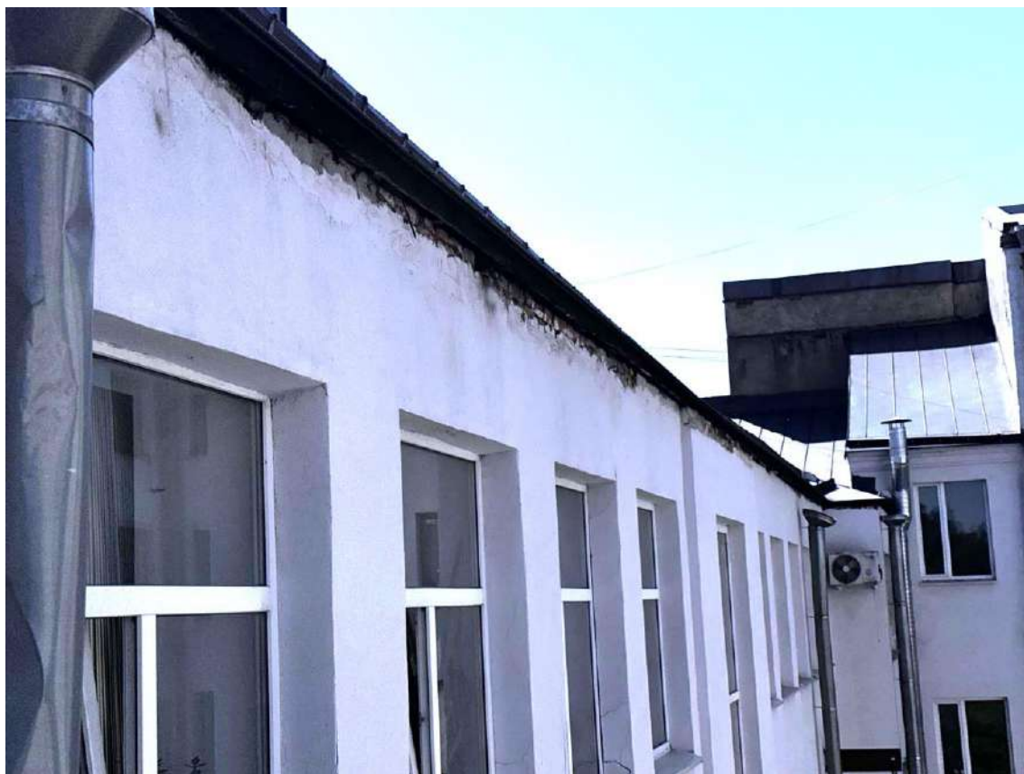
Фото 22. Фрагмент северо-западного фасада дворового корпуса, являющегося неотъемлемой частью объекта культурного наследия регионального значения «Гостиница и контора типографии», г. Выборг, Ленинградский пр., 19 (офиц. адрес: ул. Димитрова, 4). Дата съемки: 07.02.2025 г. Автор съемки: Глинская Н.Б.
