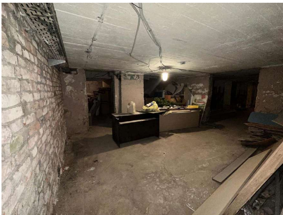
Фото 29. Подвал. Пом. 0.35. Общий вид помещения с юга. Дата съемки: 03.02.2025 г. Автор съемки: Глинская Н.Б.
