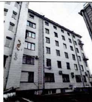
Дворовый Ю-В фасад уличного корпуса. Правая часть
