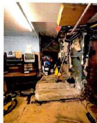
Уличный корпус. Подвал. Пом. 0.6. Бетонная лестница
