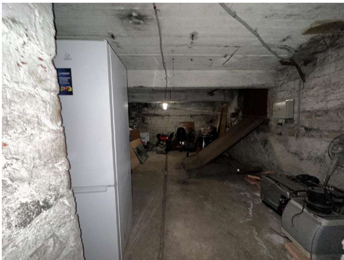
Фото 35. Подвал. Пом. 0.38. Общий вид помещения с юго-востока. Дата съемки: 03.02.2025 г. Автор съемки: Глинская Н.Б.
