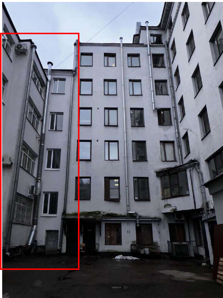
Фото 12. Общий вид северо-восточного дворового фасада объекта культурного наследия регионального значения «Гостиница и контора типографии», г. Выборг, Ленинградский пр., 19 (выделен фрагмент фасада, относящийся к дворовому корпусу, являющемуся неотъемлемой частью объекта культурного наследия (офиц. адрес: ул. Димитрова, 4). Дата съемки: 03.02.2025 г. Автор съемки: Глинская Н.Б.
