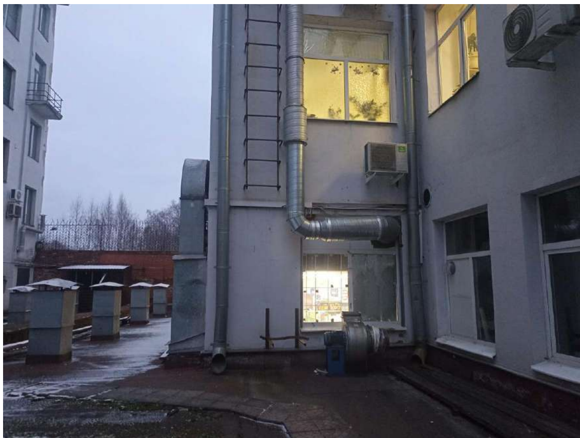
Фото 17. Фрагмент юго-западного фасада дворового ризалита дворового корпуса, являющегося неотъемлемой частью объекта культурного наследия регионального значения «Гостиница и контора типографии», г. Выборг, Ленинградский пр., 19 (офиц. адрес: ул. Димитрова, 4). Дата съемки: 07.02.2025 г. Автор съемки: Глинская Н.Б.
