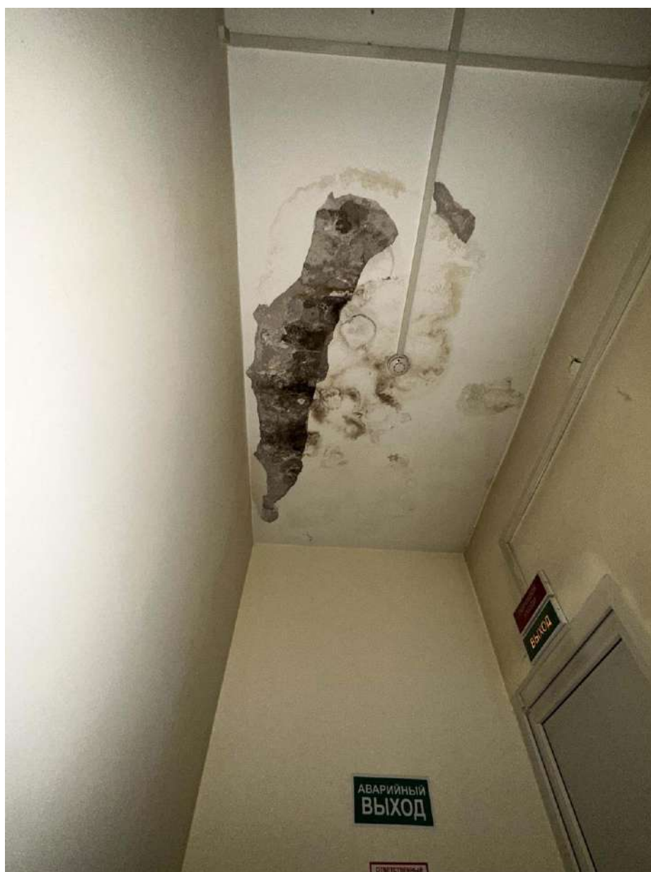
Фото 49. 3-ий этаж. Северо-восточная часть помещения. Перекрытие. Дата съемки: 03.02.2025 г. Автор съемки: Глинская Н.Б.
