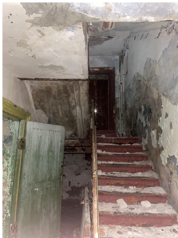
Фото 25. Помещение № 11. Вид на лестницу.
