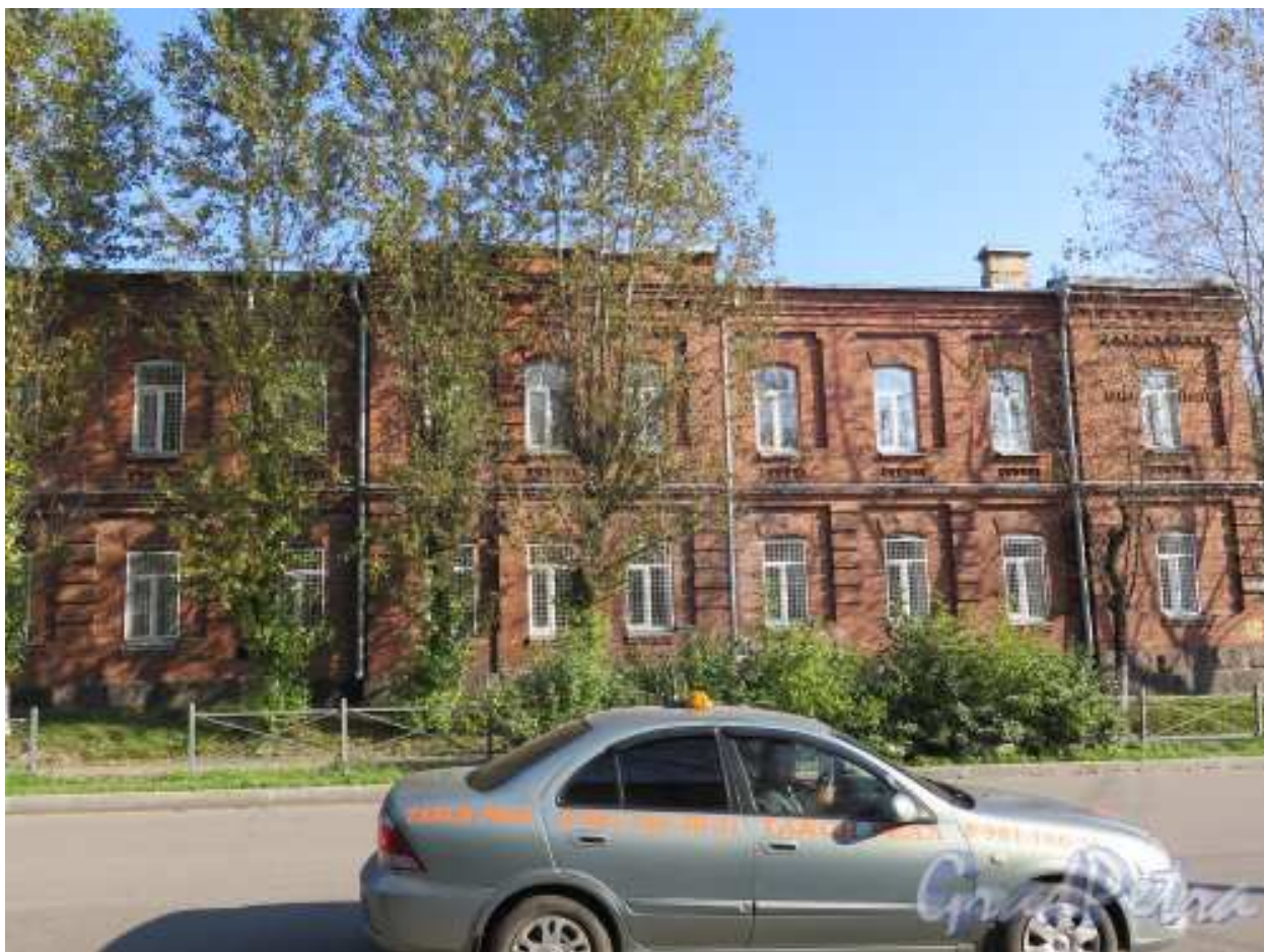
27. Лен. область, город Луга, ул. Тоси Петровой, 15. Здание воинской части. Уличный фасад, 2014 г. [Электронный ресурс] URL: https://upload.gradpetra.net/photo/photo_spb/ulitsa/7/web/60590.jpg
