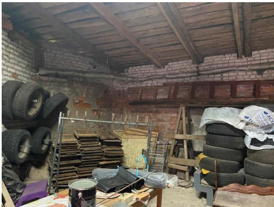
Фото 24. Вид на помещение № 3 в одноэтажной постройке на территории выявленного объекта культурного наследия «Здание железнодорожной школы».
