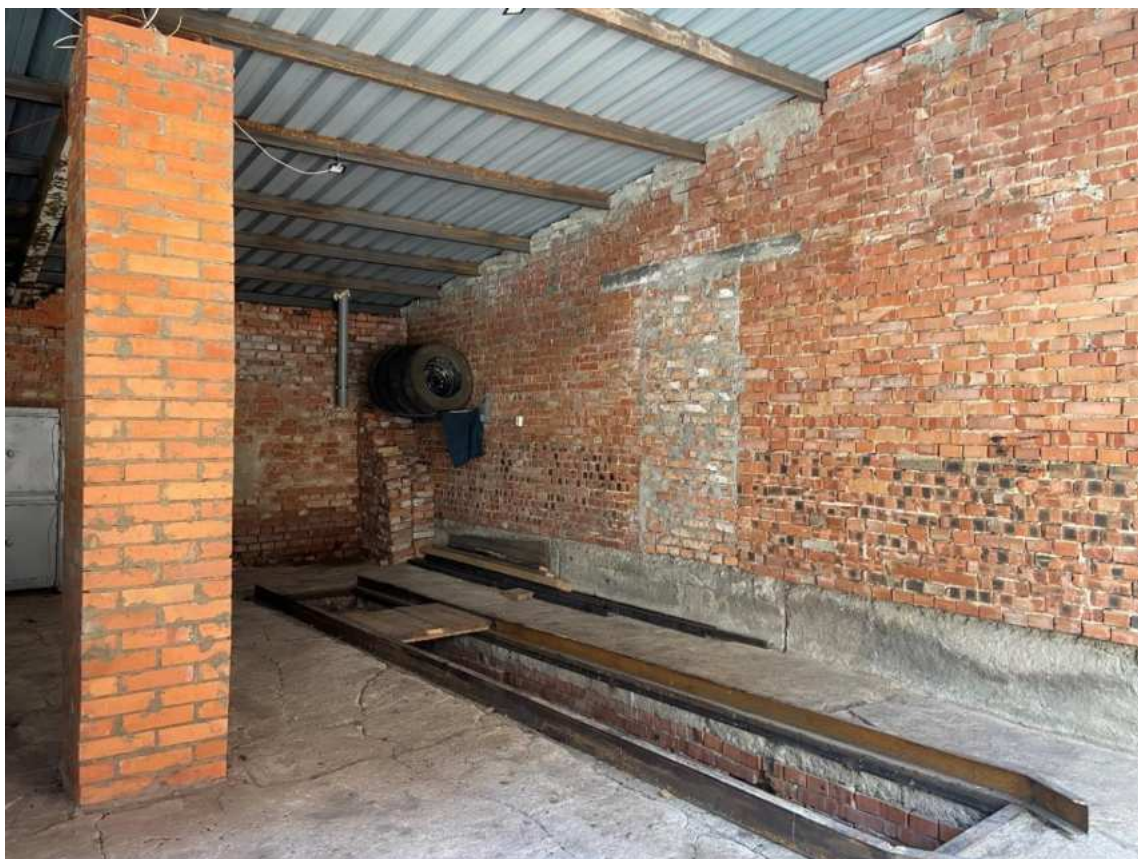
Фото 23. Вид на помещение № 7 в одноэтажной постройке на территории выявленного объекта культурного наследия «Здание железнодорожной школы».
