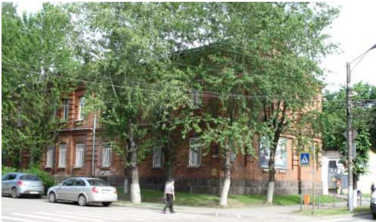
26. Лен. область, город Луга, ул. Тоси Петровой, 15. Здание воинской части. Уличный фасад, 2014 г. [Электронный ресурс] URL: https://upload.gradpetra.net/photo/photo_spb/ulitsa/7/web/60505.jpg
