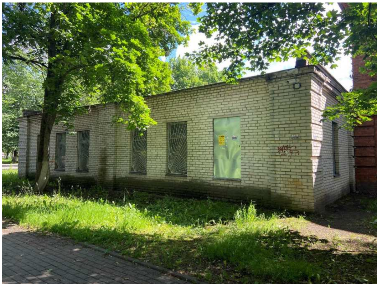
Фото 13. Западный фасад пристройки.
