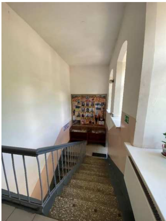
Фото 19. Вид на лестницу в двухэтажном краснокирпичном выявленном объекте культурного наследия «Здание железнодорожной школы».
