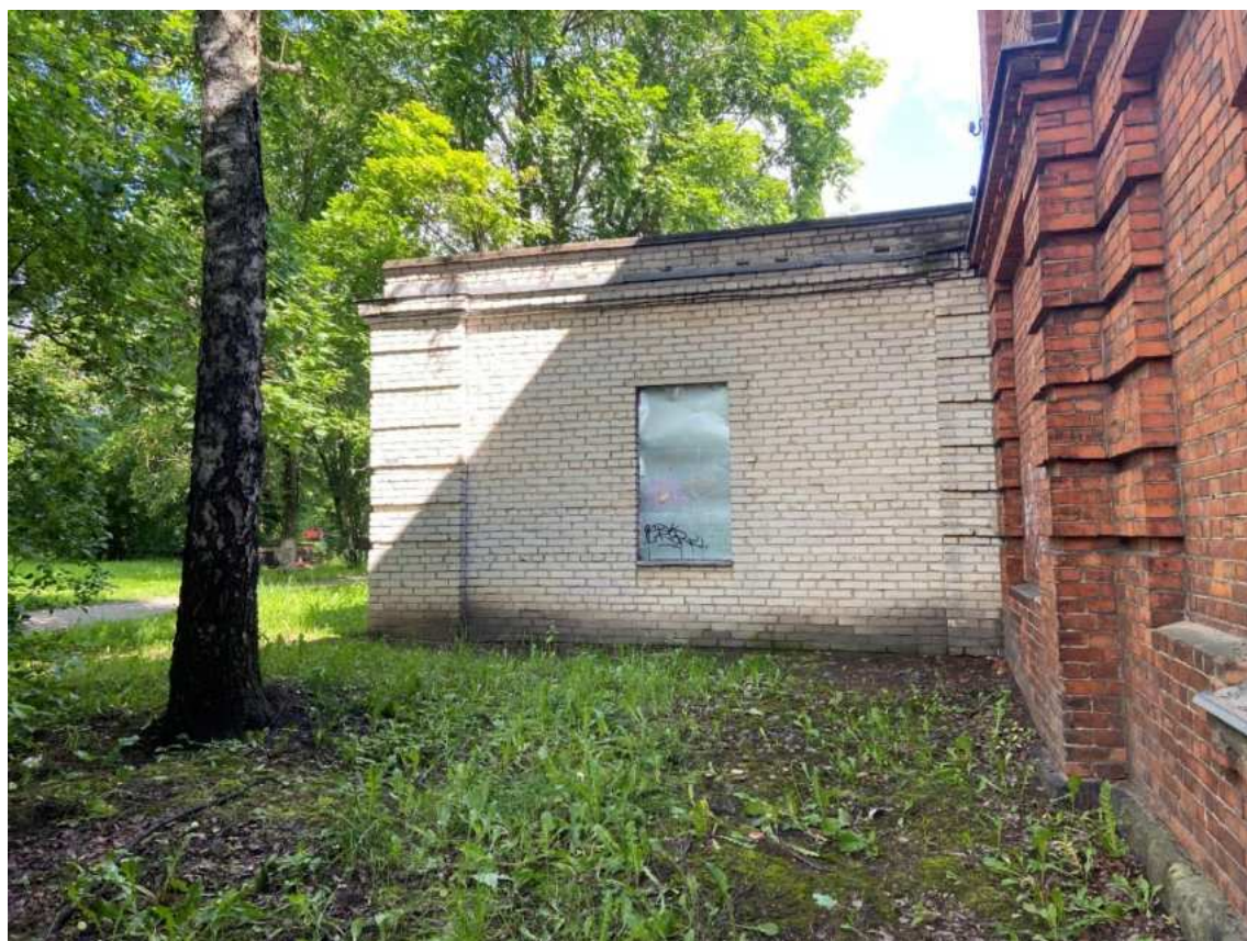
Фото 12. Торцевой юго-западный фасад пристройки.
