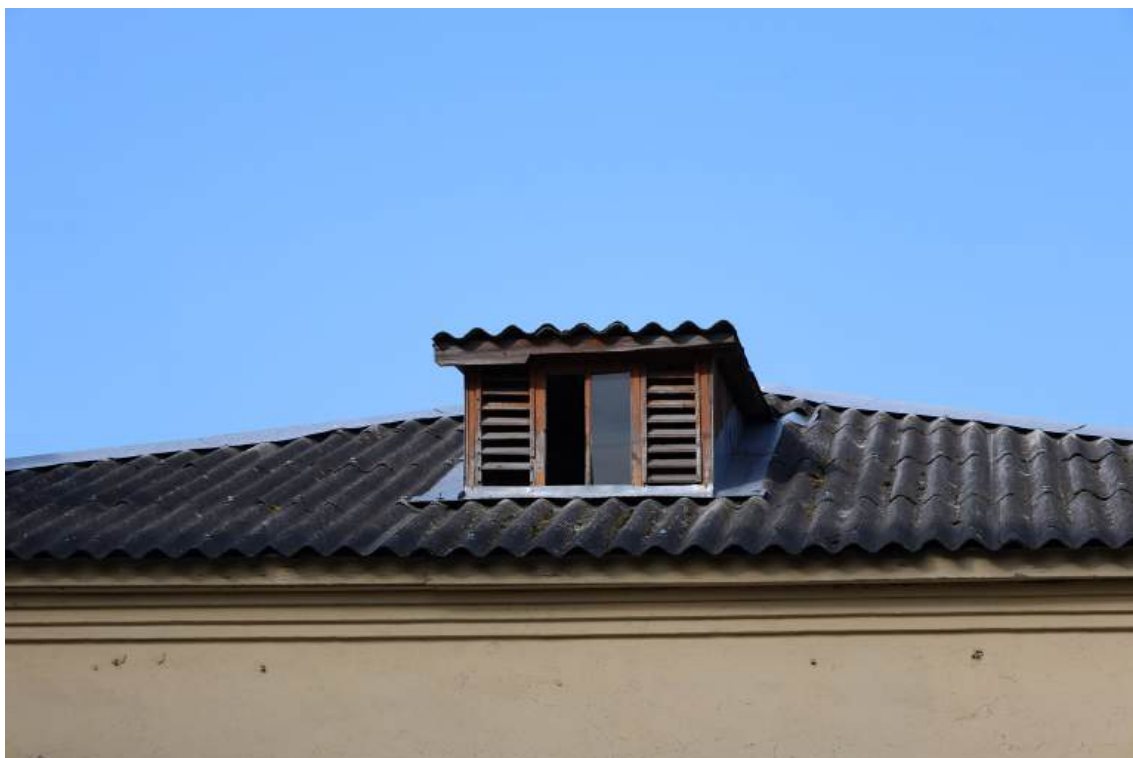
Фото № 4. Слуховое окно в скате крыши со стороны восточного фасада
