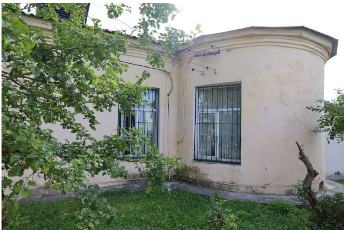
Фото № 8. Общий вид на западный фасад
