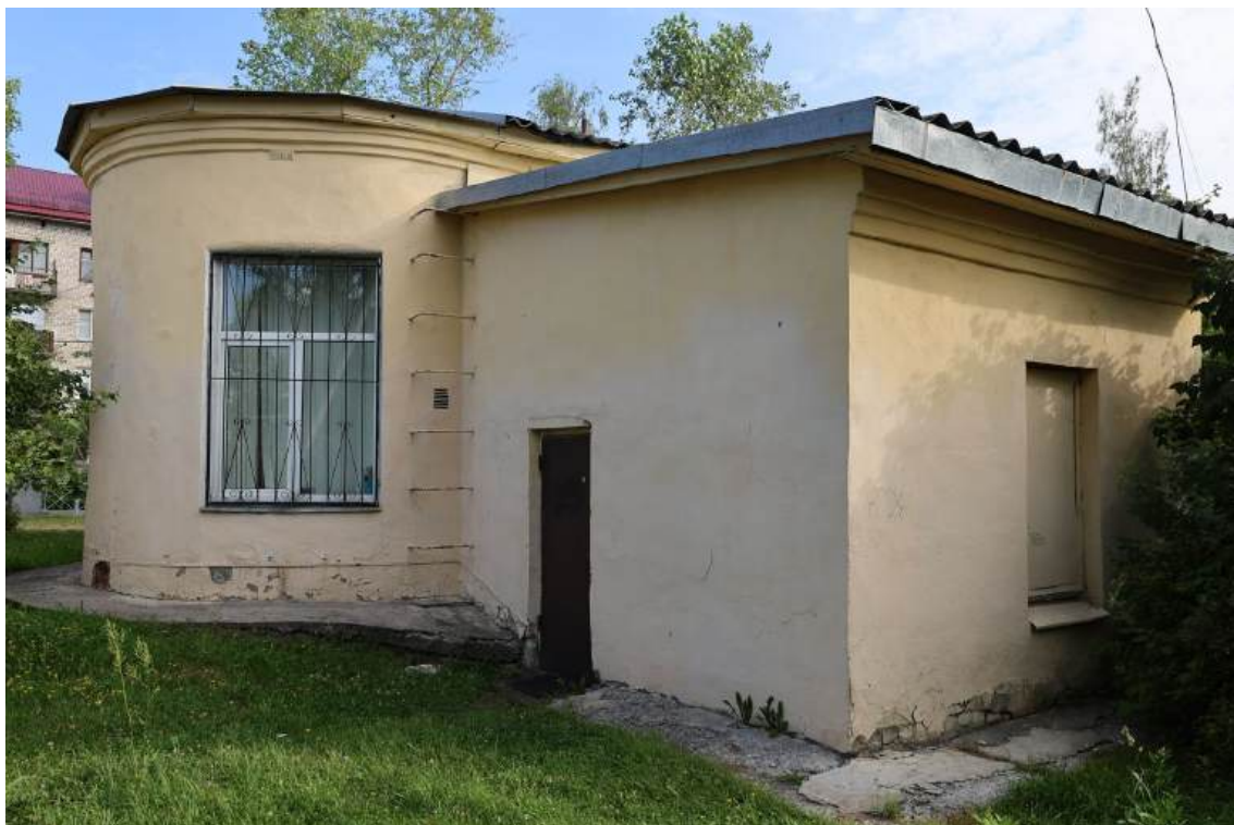
Фото № 9. Общий вид на западный фасад
