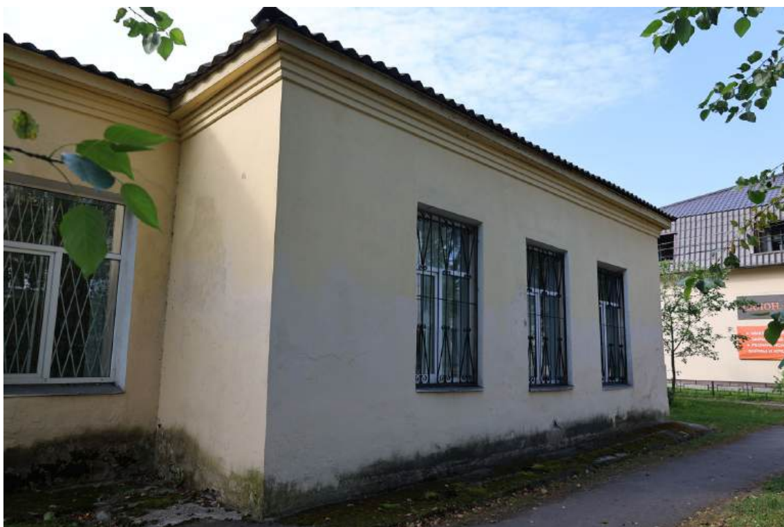
Фото № 6. Фрагмент северного фасада
