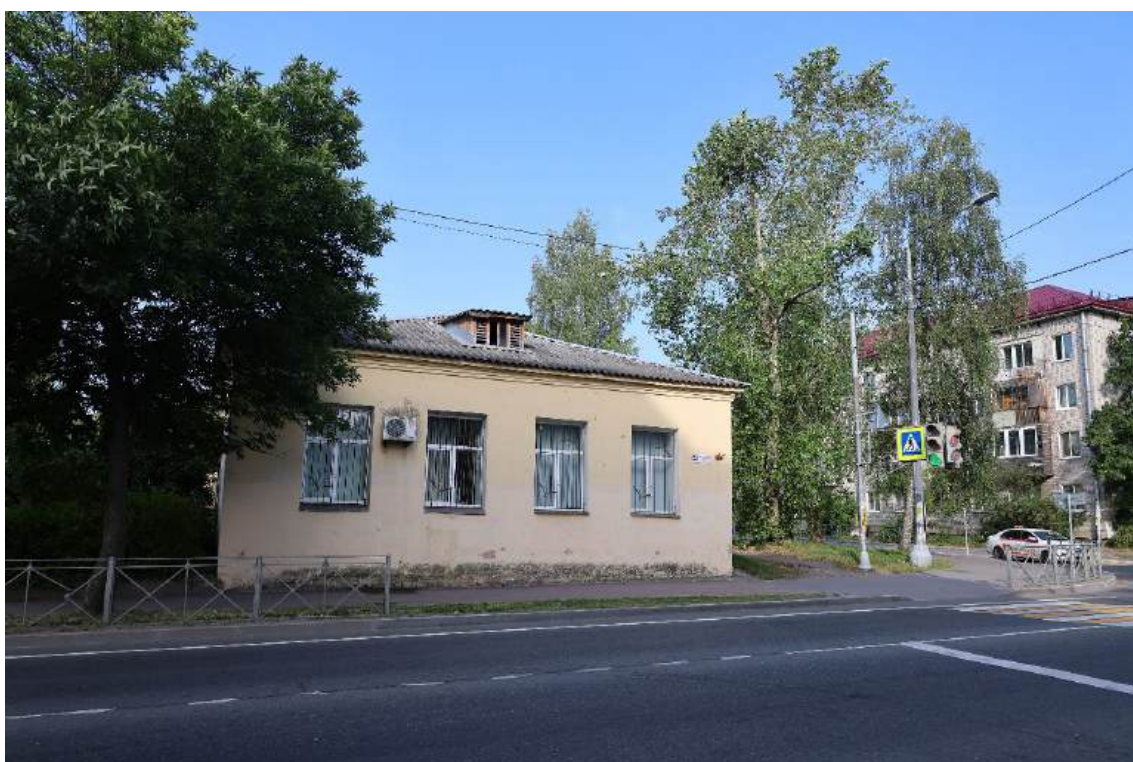
Фото № 2. Общий вид на восточный фасад
