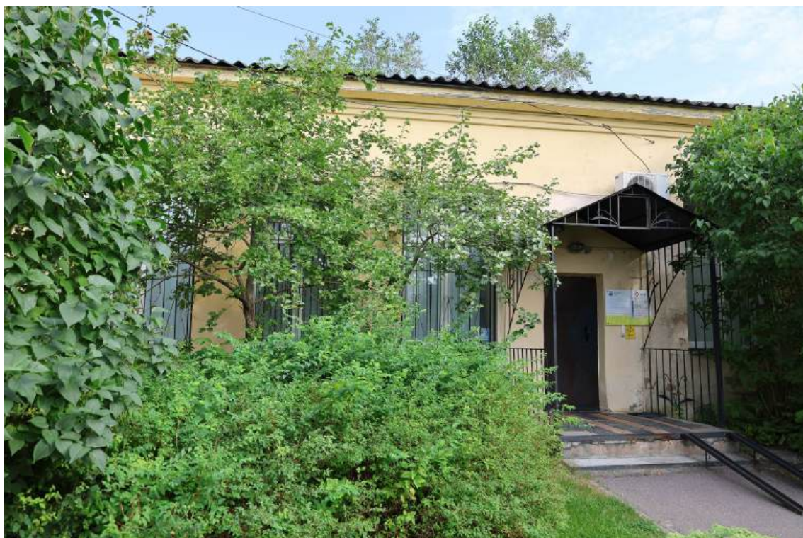
Фото № 12. Общий вид на южный фасад
