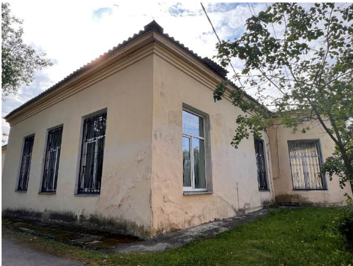
Фото № 7. Фрагмент северного и западного фасадов
