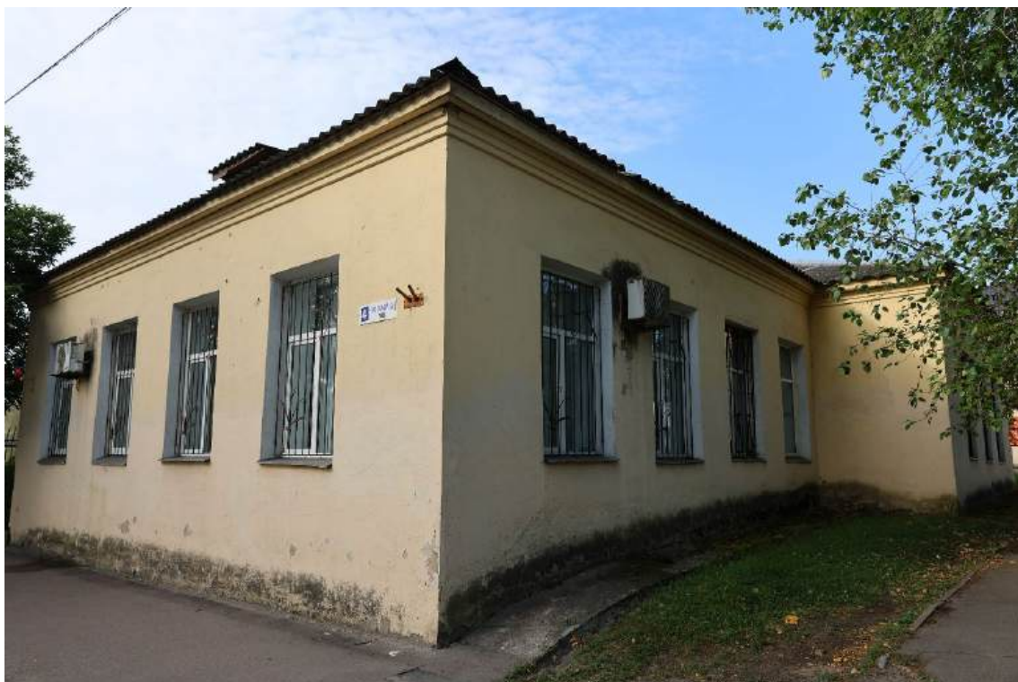
Фото № 5. Общий вид на северный фасад
