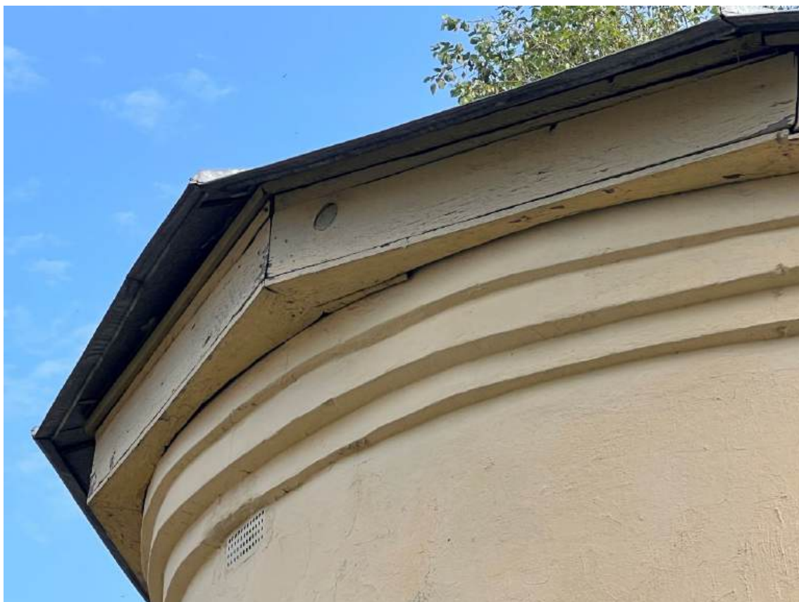
Фото № 11. Ступенчатый венчающий карниз
