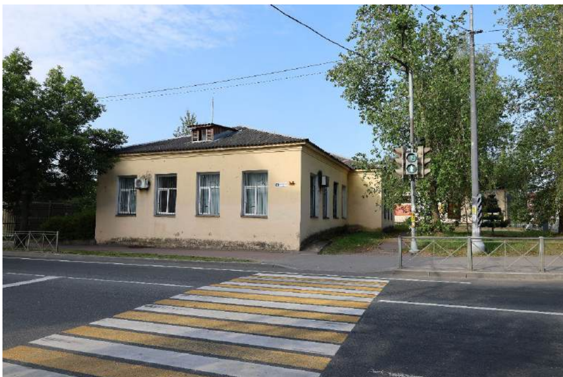
Фото № 1. Общий вид на восточный фасад
