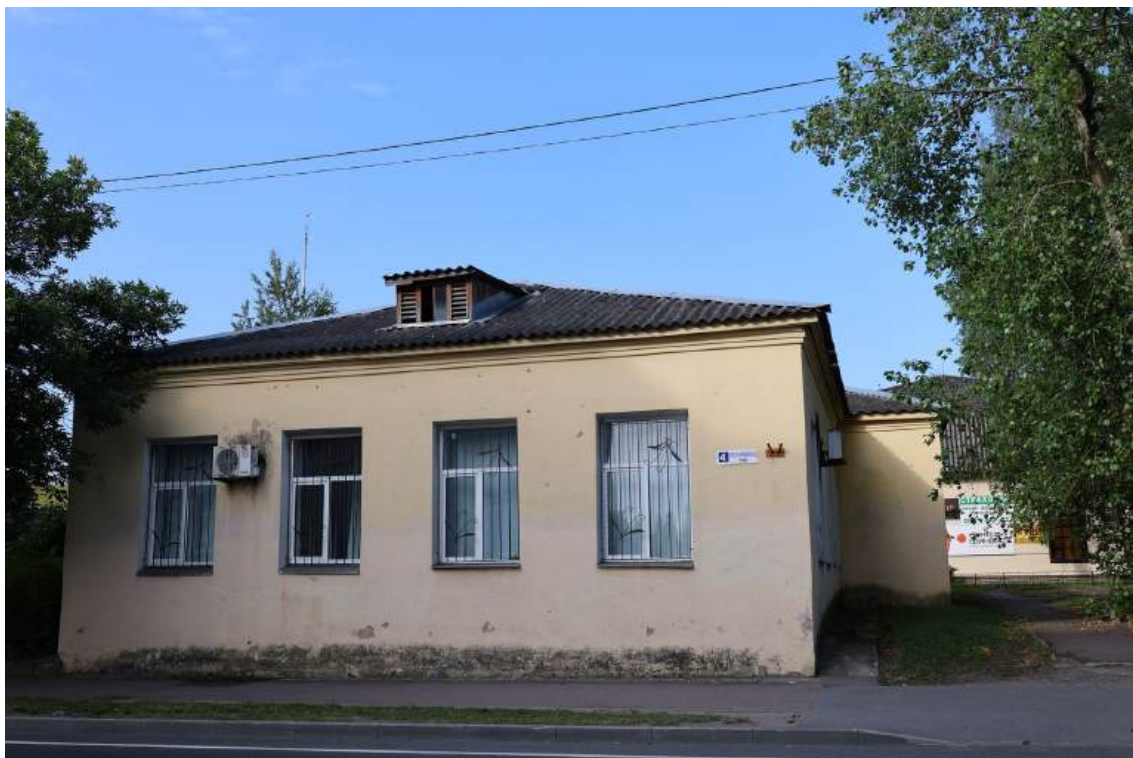
Фото № 3. Общий вид на восточный фасад
