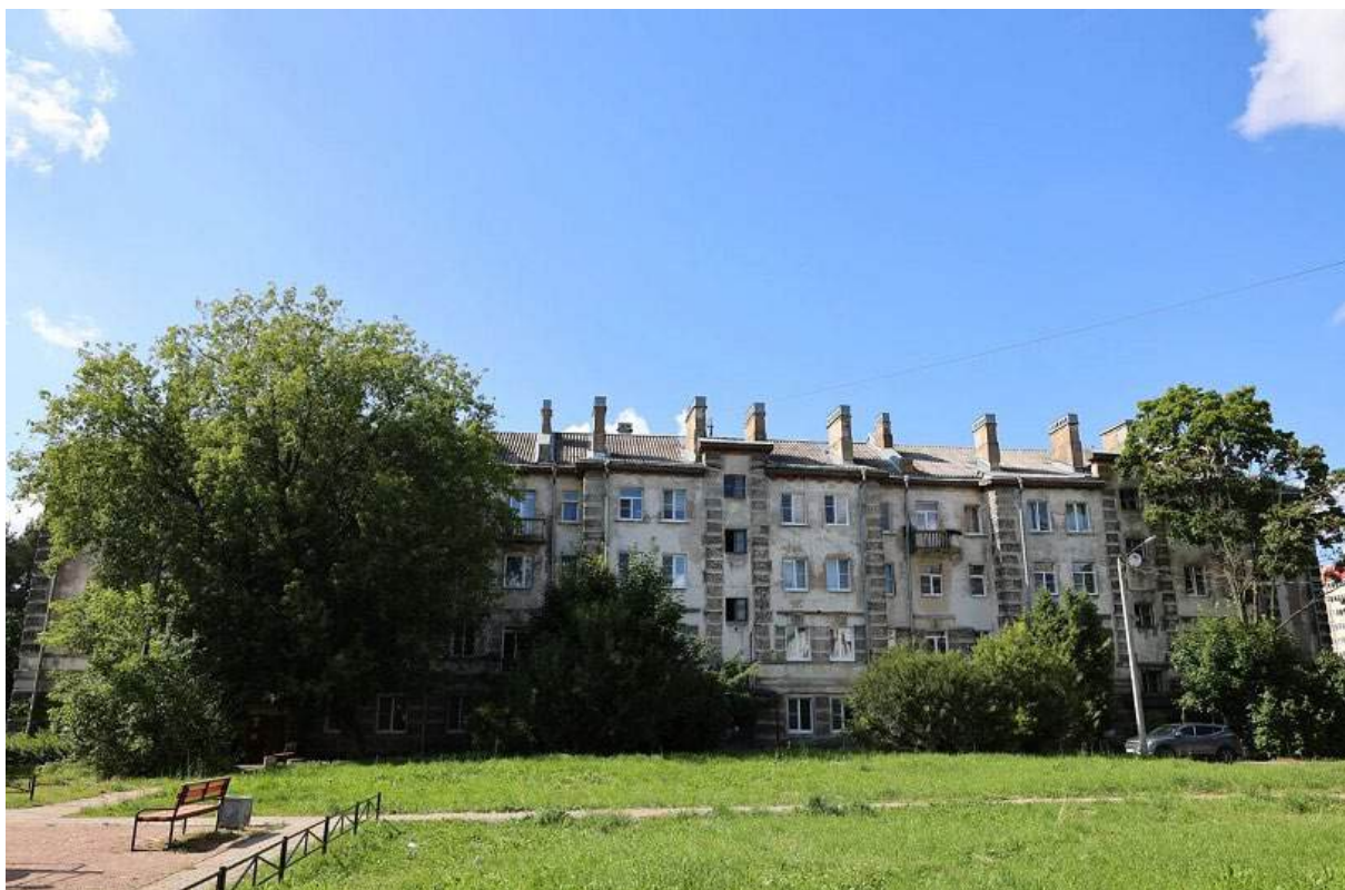
Фото 3. Видовое раскрытие ОКН, западное направление
