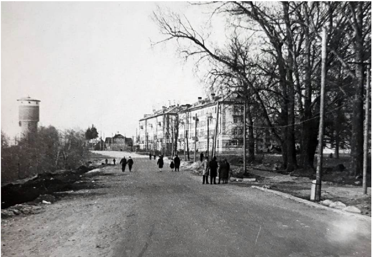
Рис. 2. КЭЧинские дома №12 и 14 и водонапорная башня. (1965 г.)
