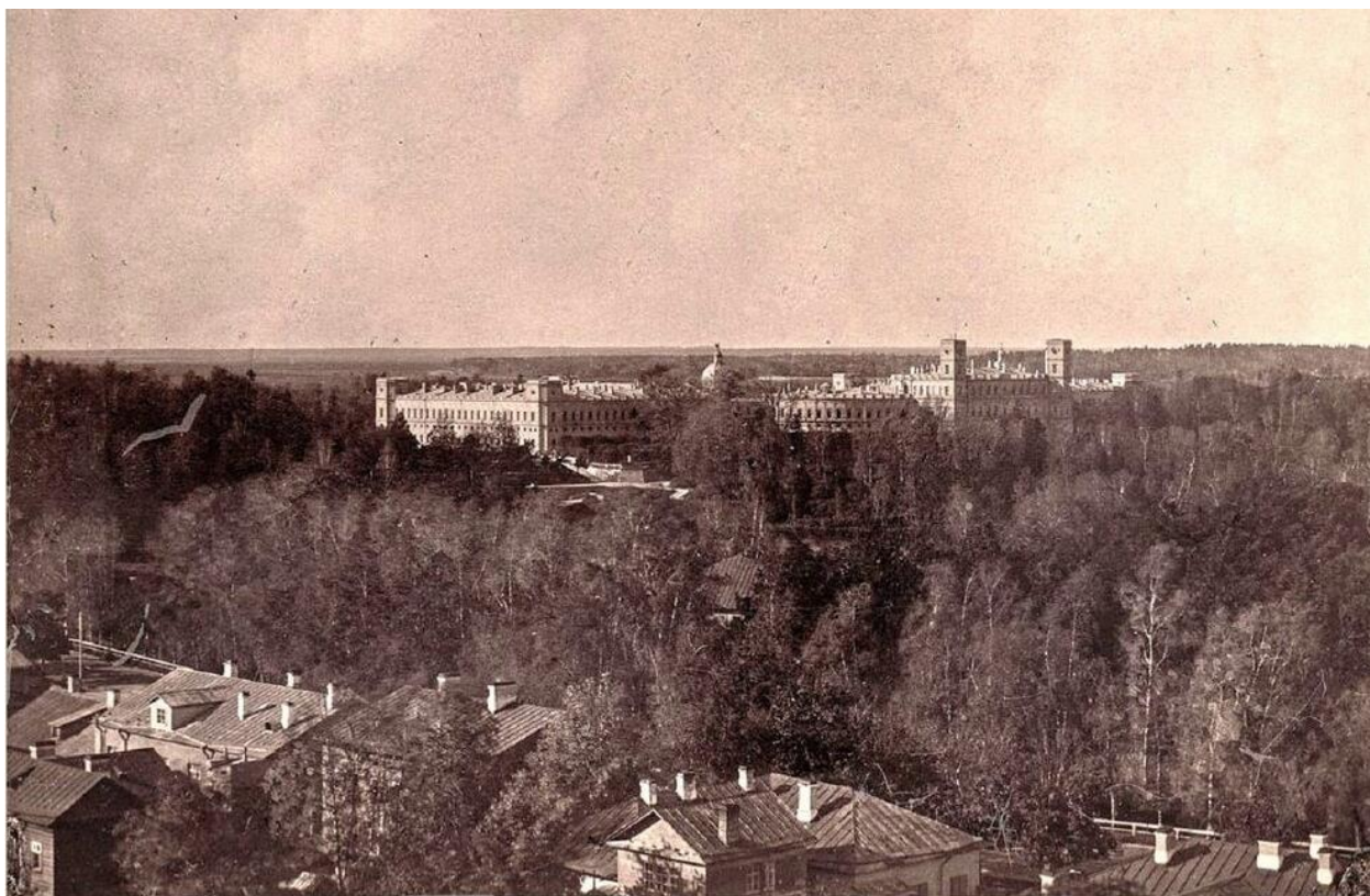
24. Вид на Большой Гатчинский дворец. 1890- 1900. [Электронный ресурс] URL: https://pastvu.com/p/2314172
