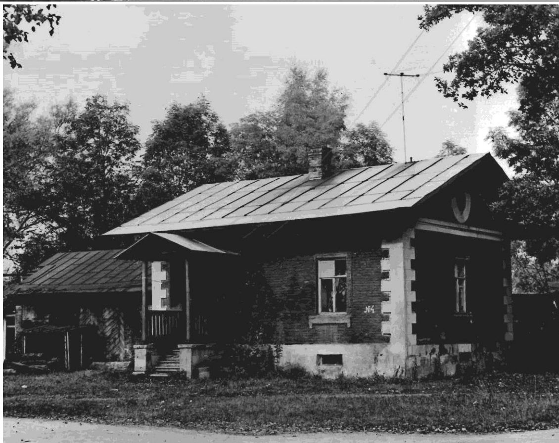
29. Фотографии караульных домов. Из паспорта «Дворцово-парковый ансамбль г. Гатчины», сост. 09.11.1981 г. Архив комитета по сохранению культурного наследия Ленинградской области.
