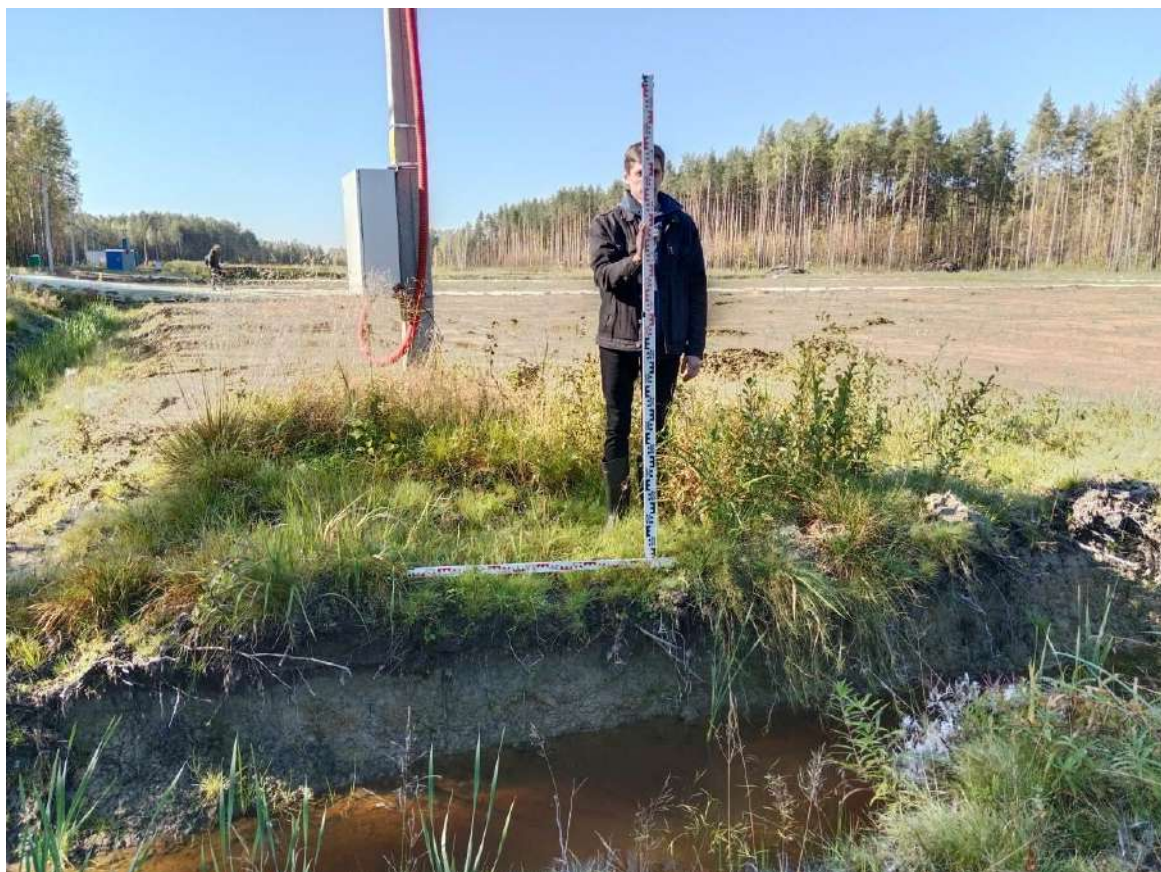
Рис. 29. Зачистка 1. Общий вид места закладки зачистки до начала работ. Вид с юго-востока.
