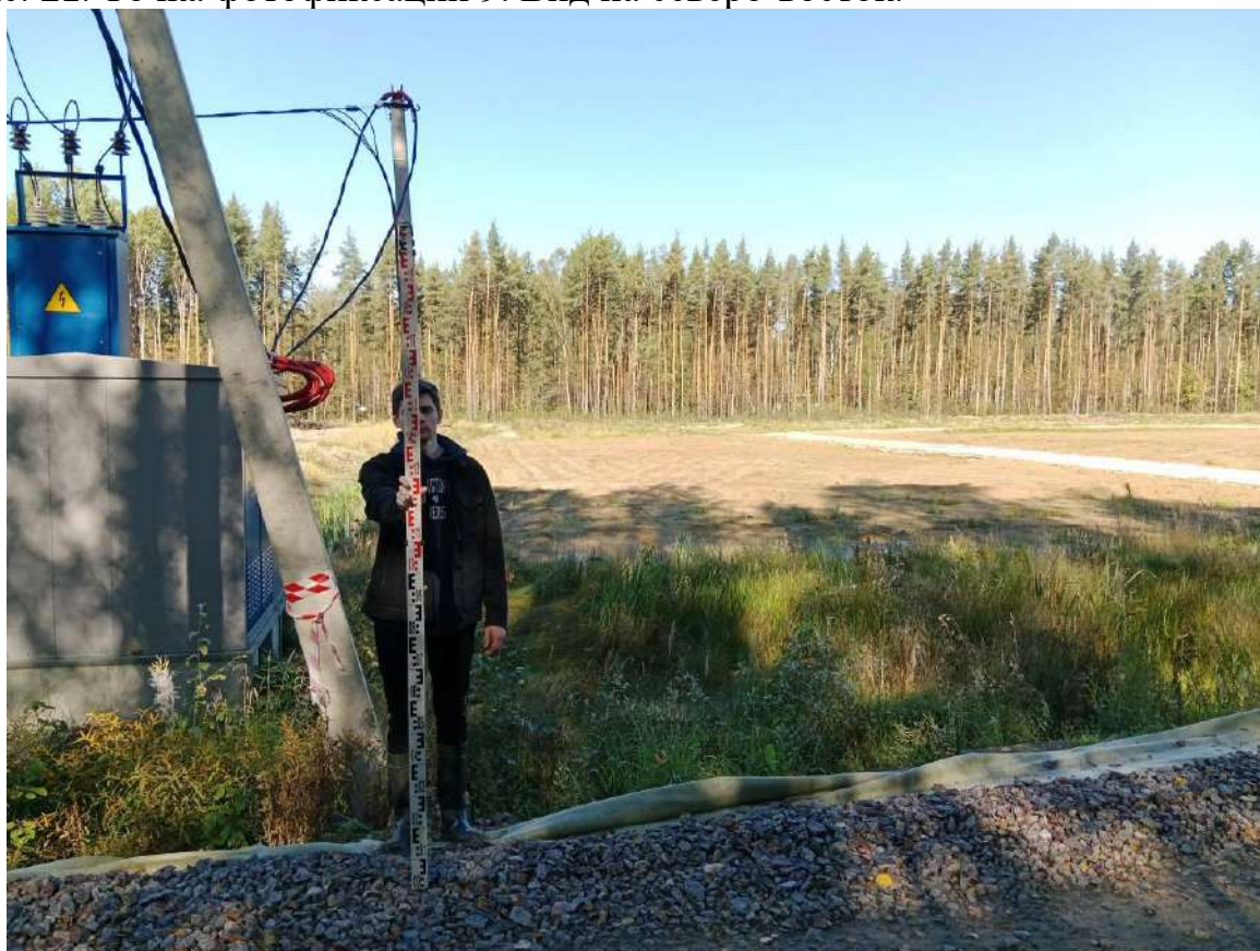
Рис. 22. Точка фотофиксации 10. Вид на северо-запад.
