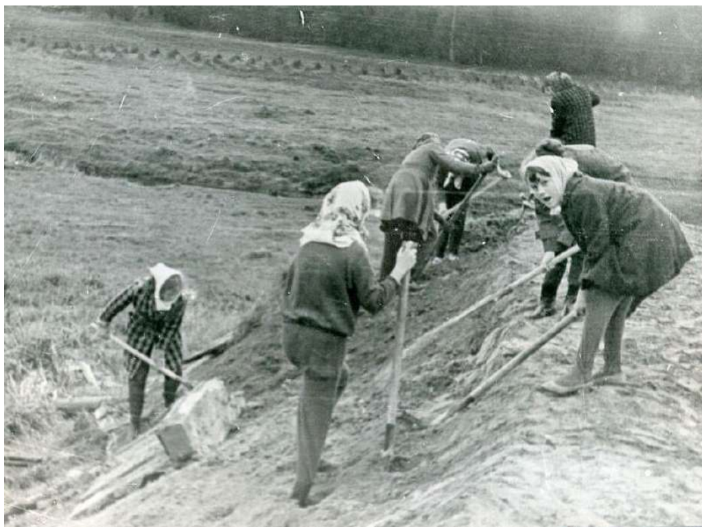
Илл. 18. Строительство мемориала «Цветок жизни». Фотография. Автор фото неизвестен. 1968 г. (источник: https://pastvu.com/p/1898095 ).
