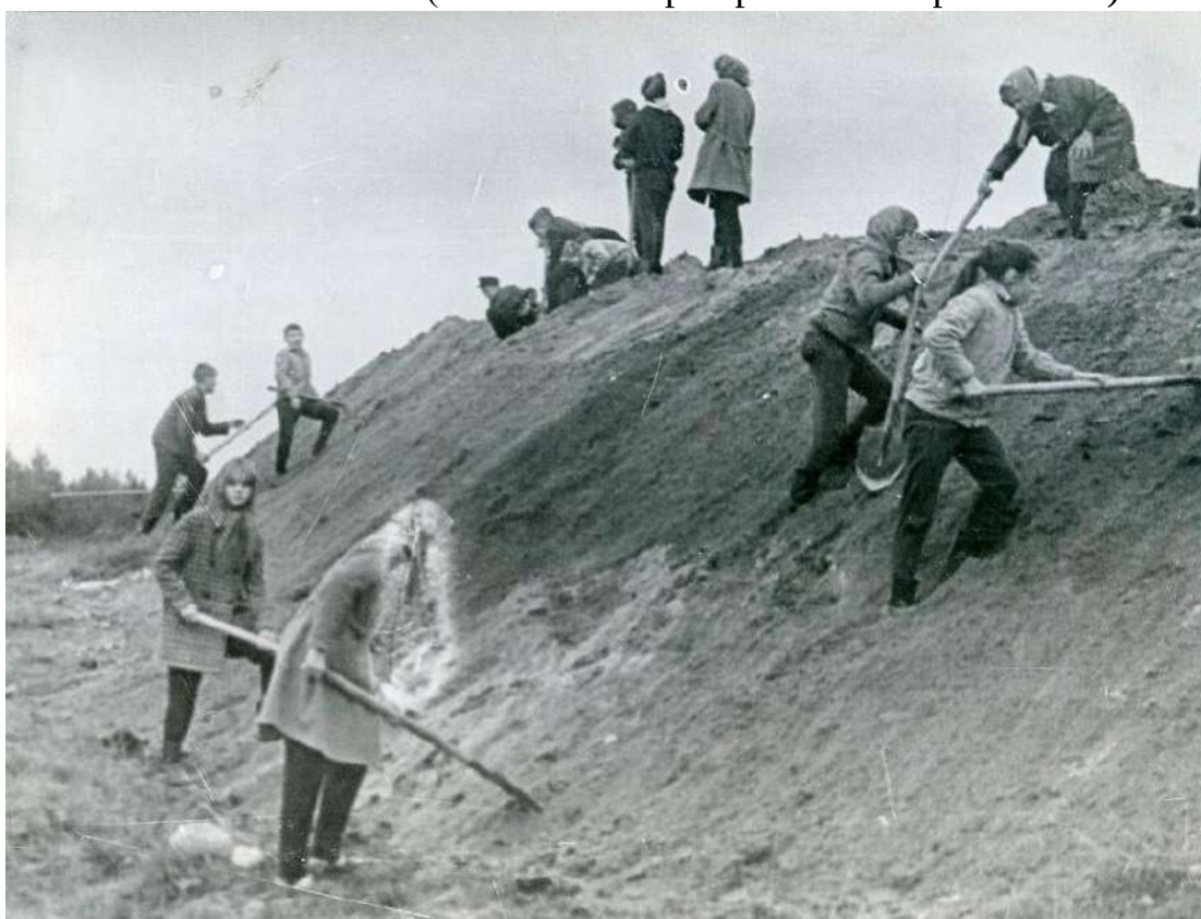
Илл. 19. Строительство мемориала «Цветок жизни». Фотография. Автор фото неизвестен. 1968 г. (источник: https://pastvu.com/p/1898094 ).
