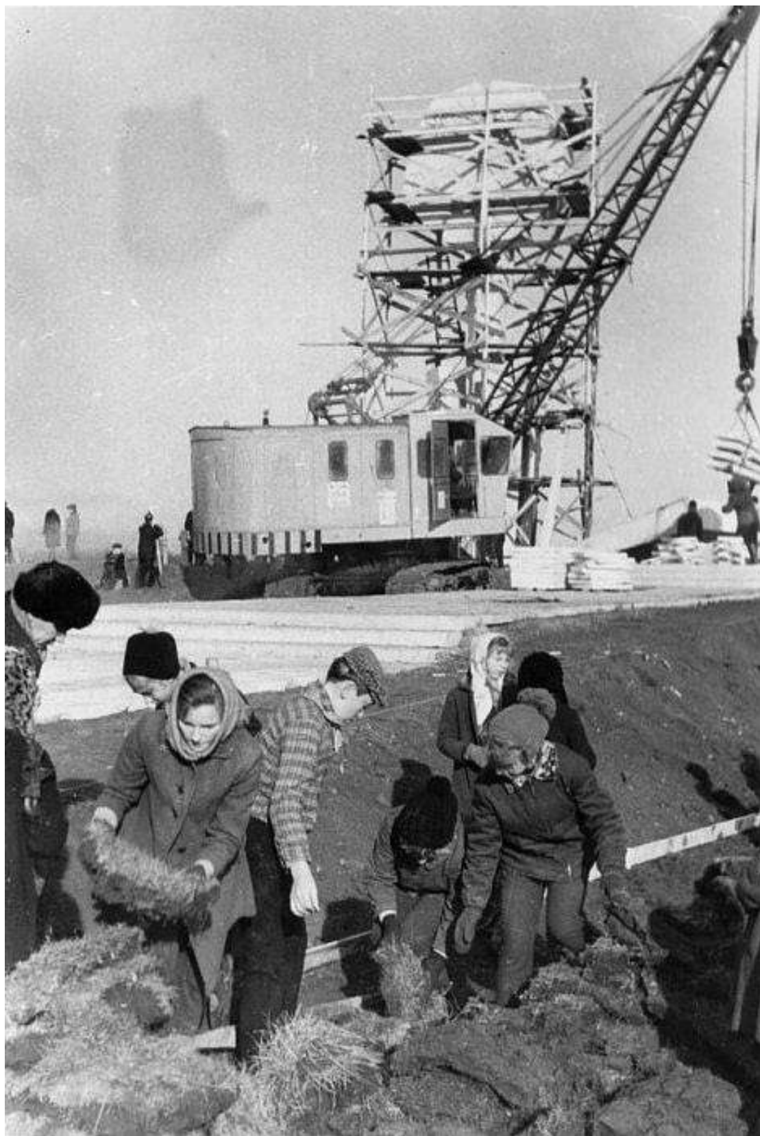
Илл. 12. Пионеры отряда «Пионерстроя» на строительстве памятника «Цветок жизни» на Ледовой дороге жизни. Фотография. Автор фото – Ритов Б. 1967-1968 гг. (источник: https://pastvu.com/p/653825 ).
