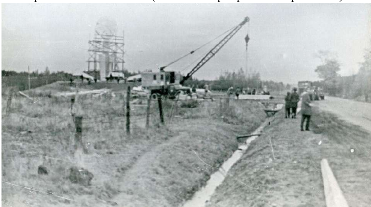
Илл. 11. Строительство монумента «Цветок жизни». Фотография. Автор фото неизвестен. 1968 г. (источник: https://pastvu.com/p/1898093 ).
