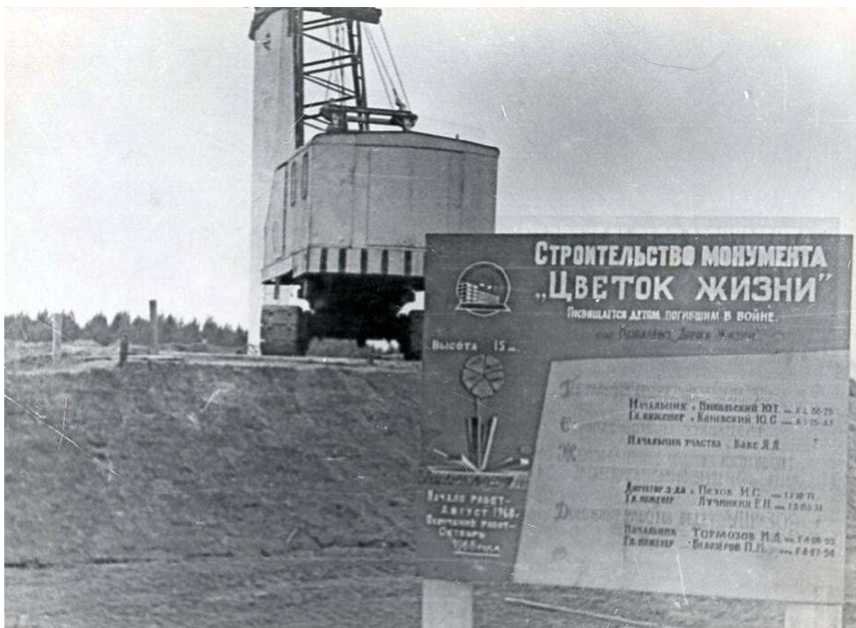
Илл. 16. Строительство монумента «Цветок жизни». Фотография. Автор фото неизвестен. 1968 г. (источник: https://pastvu.com/p/1898090 ).
