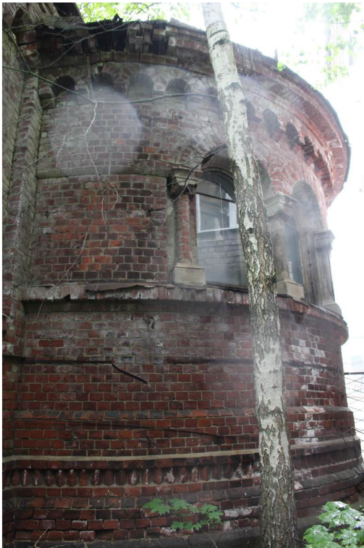
Фото 9. Вид на восточный фасад выявленного объекта культурного наследия «Никольская церковь».
