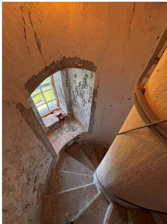
Фото 26. Оконный проем в основном объеме маяка.
