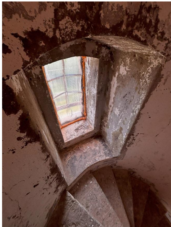
Фото 28. Оконный проем в основном объеме маяка.
