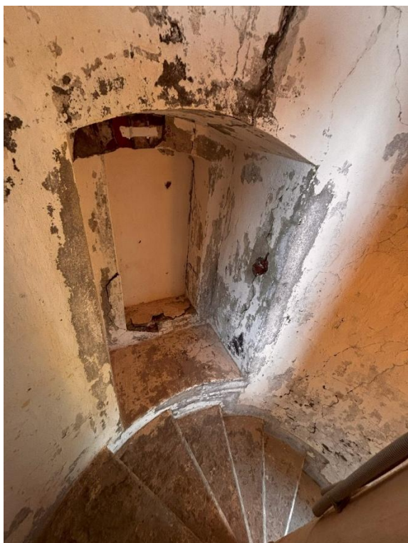
Фото 27. Заложенный оконный проем в основном объеме маяка.
