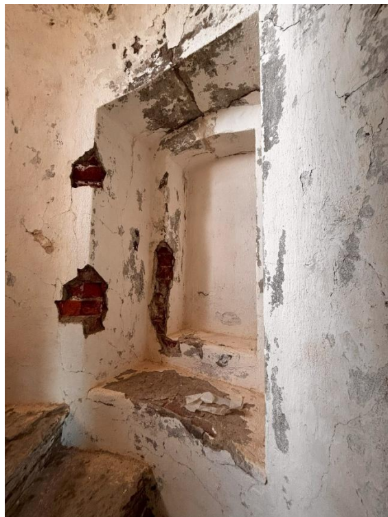
Фото 30. Заложенный оконный проем в основном объеме маяка.
