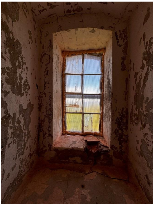
Фото 25. Оконный проем в основном объеме маяка.
