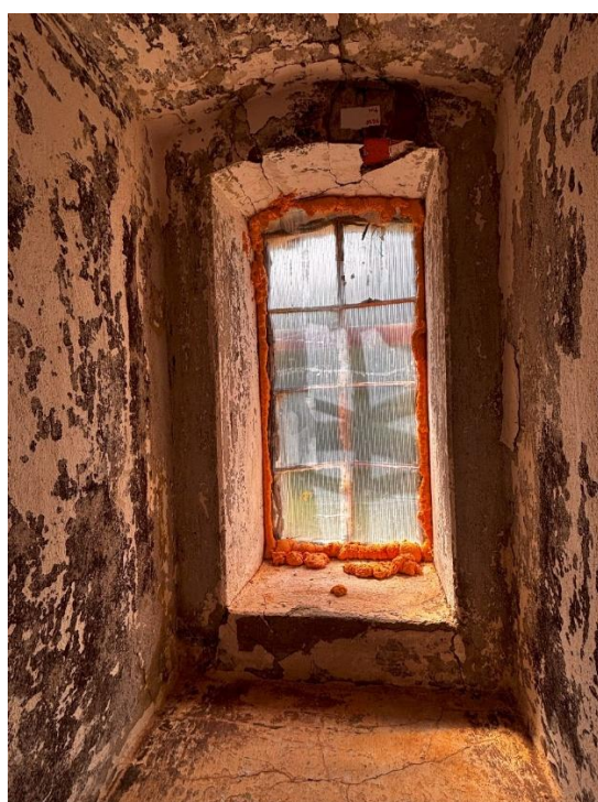
Фото 16. Оконный проем в основном объеме маяка.
