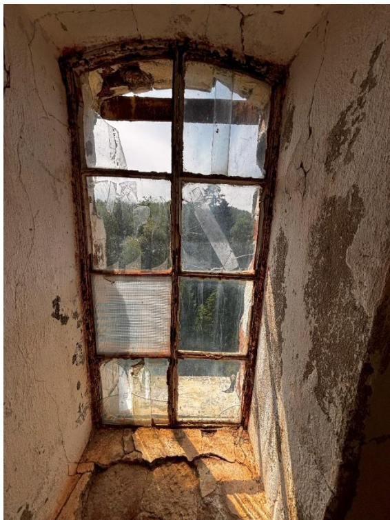
Фото 29. Оконный проем в основном объеме маяка.
