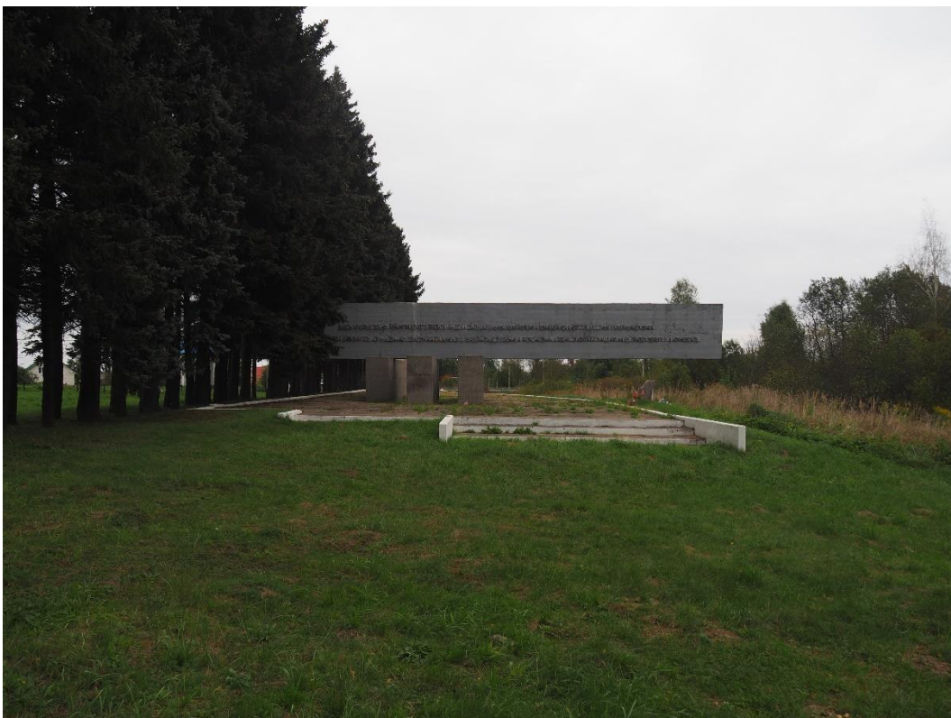
2. «Памятник «Невский порог», 1944г., 1967 г., Ленинградская область, Кировский район, г. Отрадное, Ленинградское шоссе, 100/1. Общий вид с запада. Фото 10.09.2025г.
