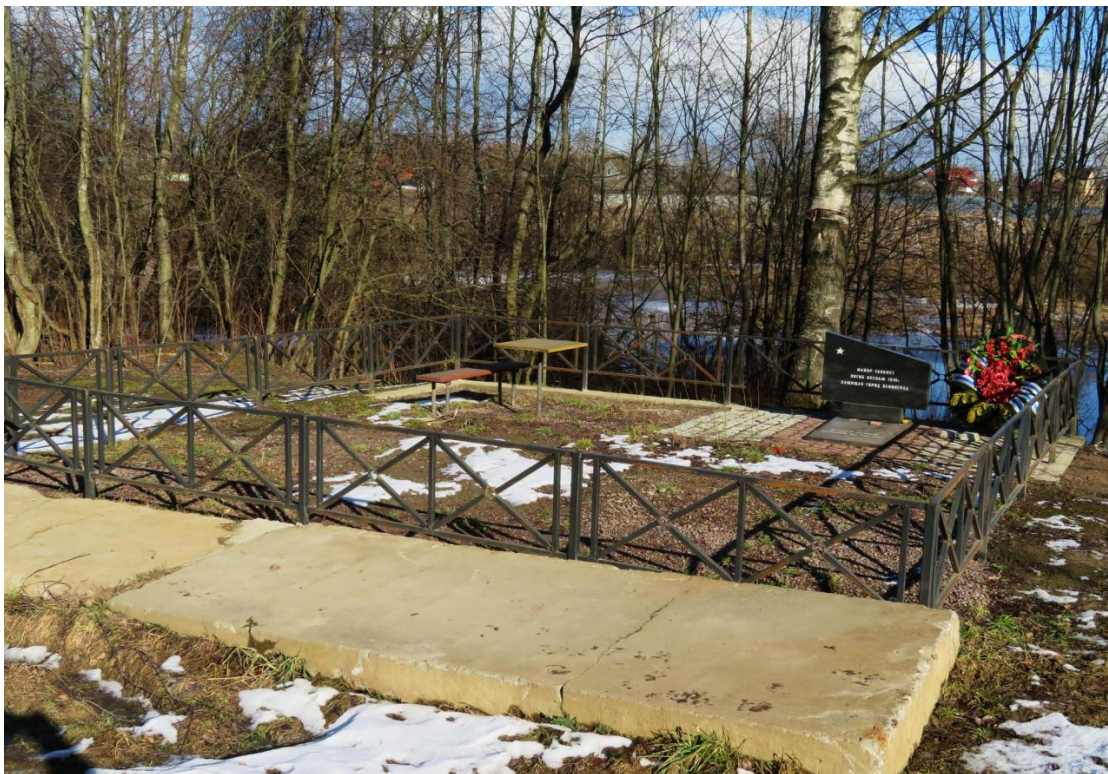
Общий вид Объекта. 2020 г.
