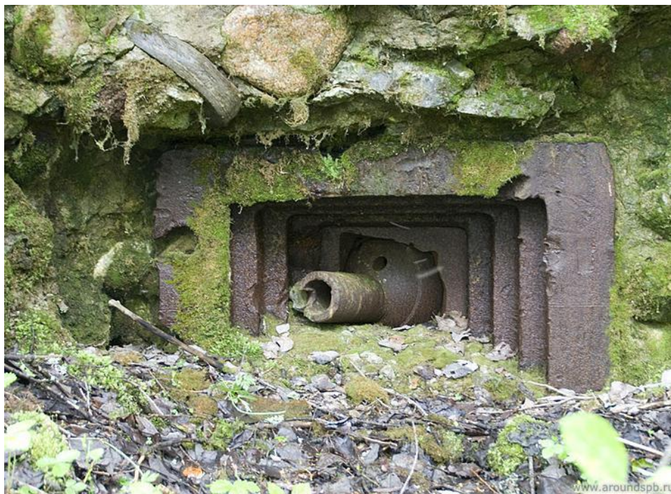
Амбразура ДОТа №07 с боевыми повреждениями. Источник:www.aroundspb.ru
