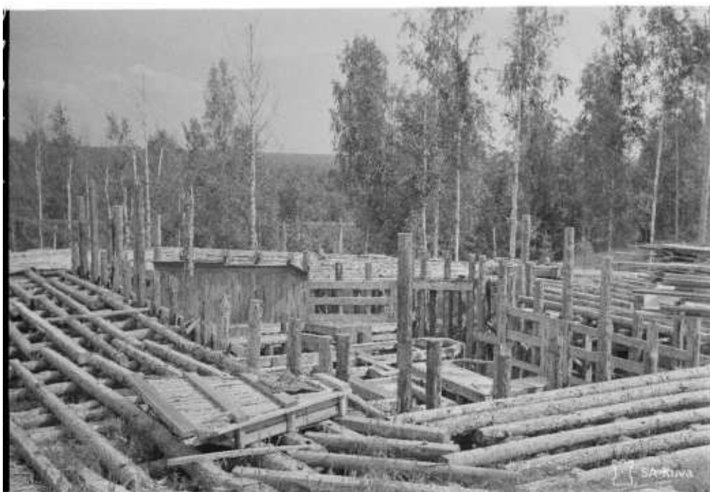
Опалубка советского ДОТа, так и оставшегося недостроенным. Высота Кумури под Сортавалой. Фотография сделана финским военным корреспондентом в 1943 году.
