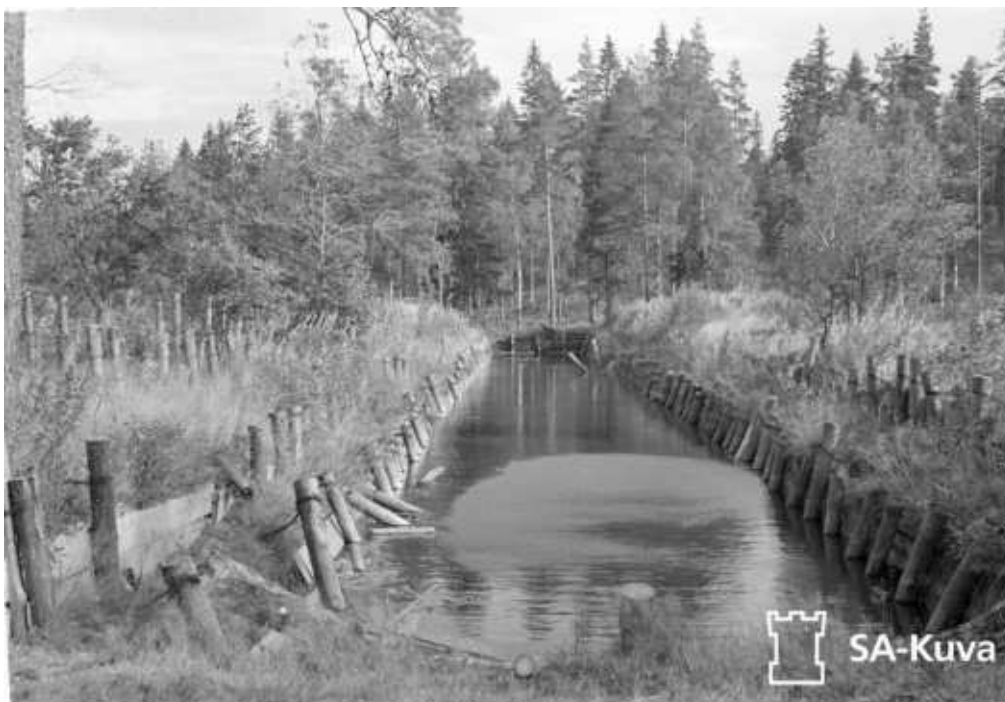
Вариант противотанковой обороны на Карельском перешейке
