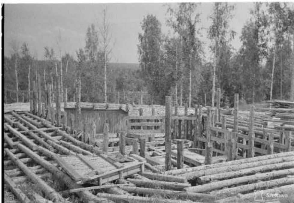
Опалубка советского ДОТа, так и оставшегося недостроенным. Высота Кумури под Сортавалой. Фотография сделана финским военным корреспондентом в 1943 году. sa-kiiva.fi архив фотографий финских оборонительных сил
