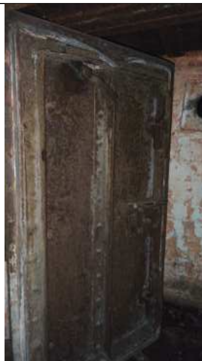
Металлическая клепанная дверь
