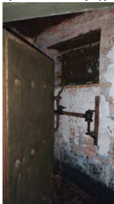
Металлическая клепанная дверь
