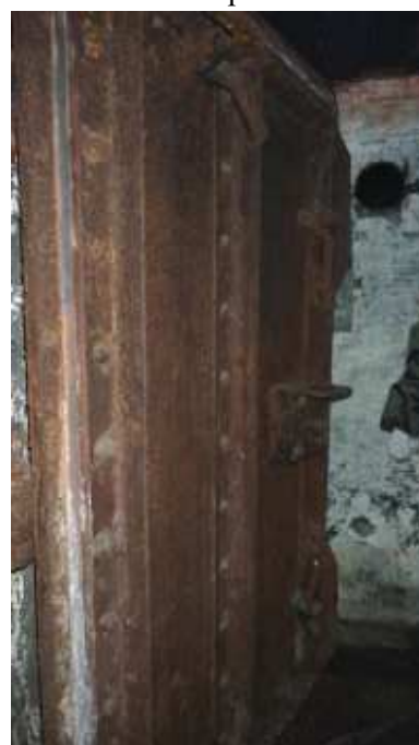
Входная дверь из клепанного металла
