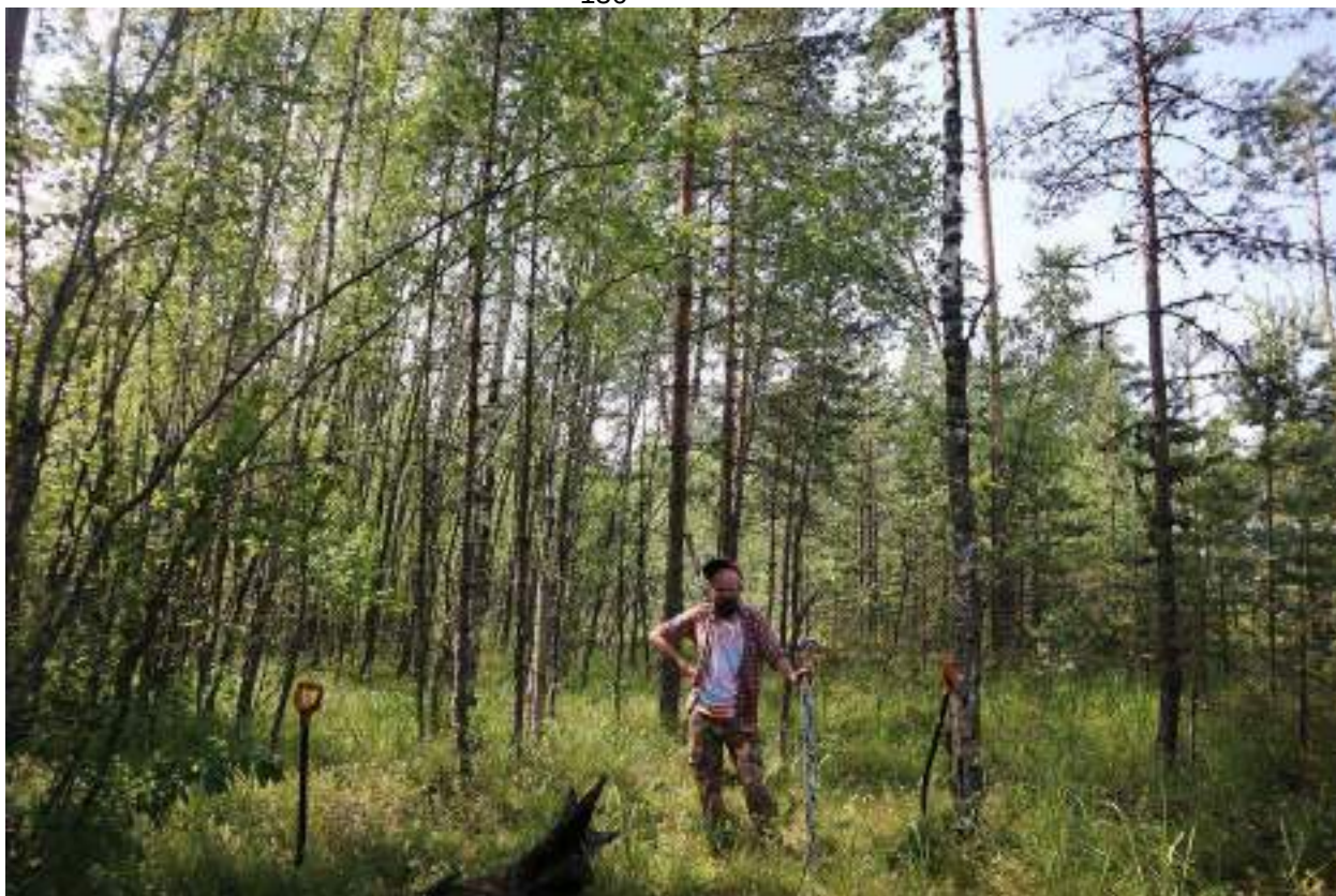
Рис. 58. Ленинградская область, Кингисеппский район. «Строительство газохимического комплекса по производству метанола и карбамида в районе морского порта Усть-Луга». Шурф 12. Общий вид до начала работ. Вид с юга
