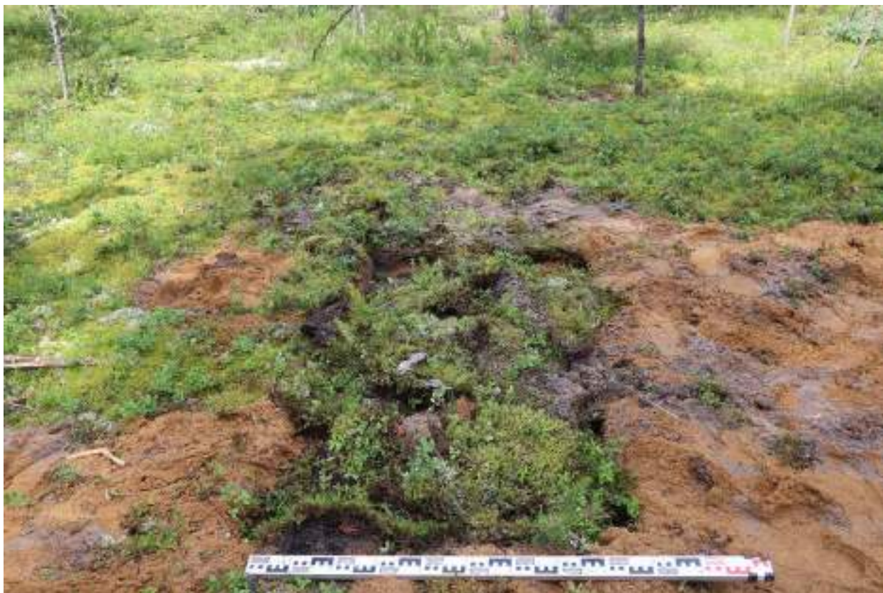
Рис. 93. Ленинградская область, Кингисеппский район. «Строительство газохимического комплекса по производству метанола и карбамида в районе морского порта Усть-Луга». Шурф 20. Рекультивация. Вид с юга
