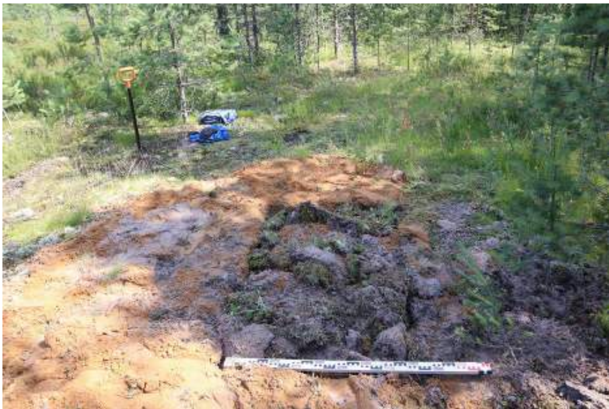
Рис. 49. Ленинградская область, Кингисеппский район. «Строительство газохимического комплекса по производству метанола и карбамида в районе морского порта Усть-Луга». Шурф 9. Рекультивация. Вид с юга
