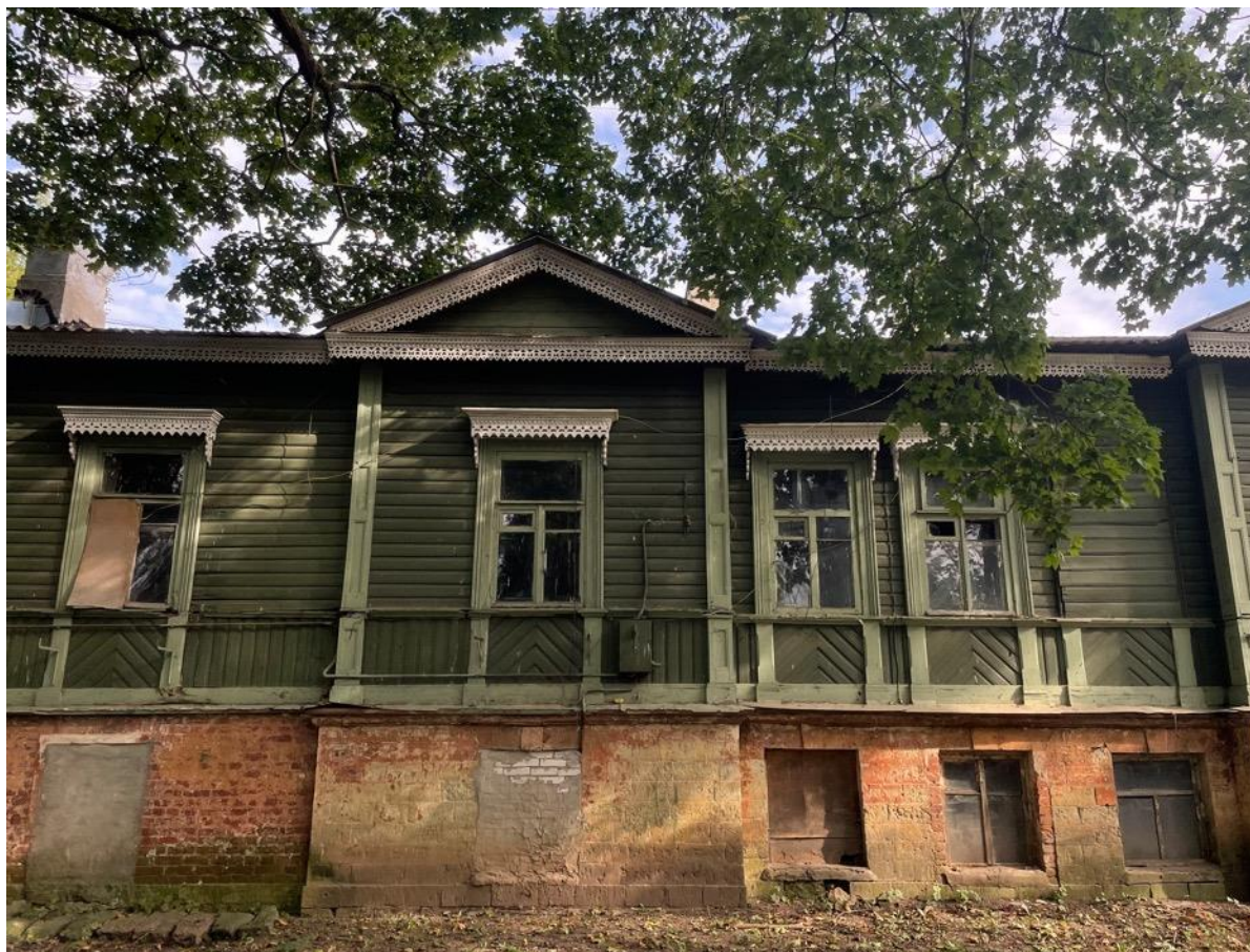
12. Фрагмент лицевого фасада
