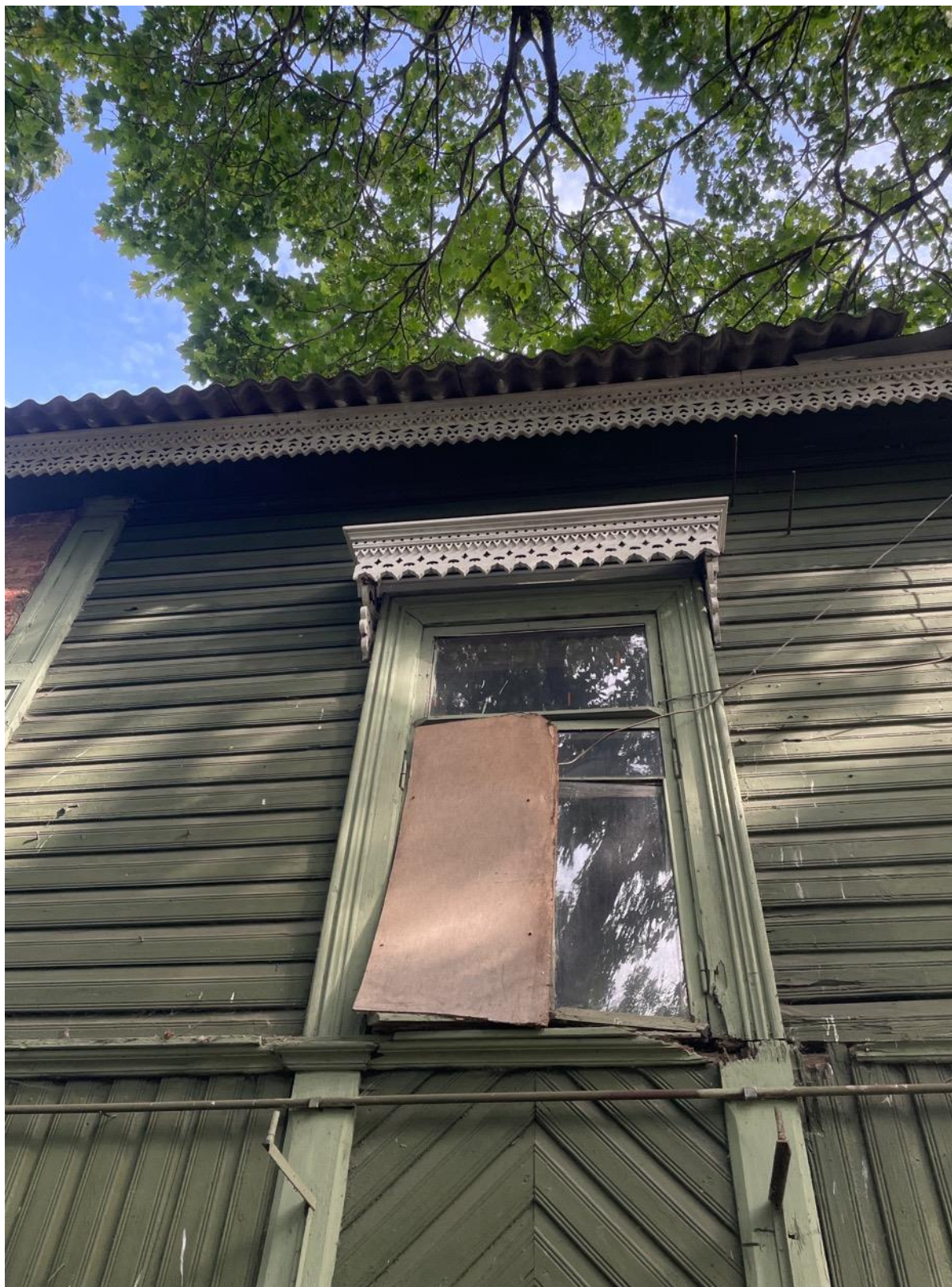
11. Фрагмент лицевого фасада
