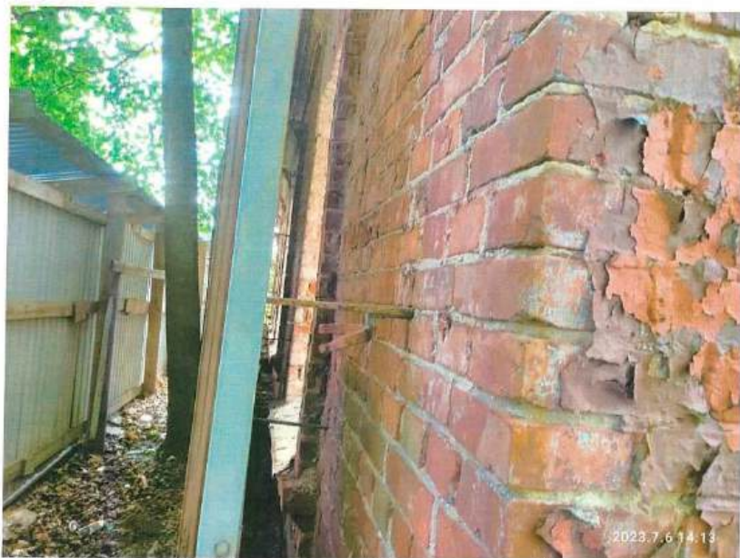
Фото 13. «Дом купца Н.Н. Хомякова, нач. XX в» закрепление баннера к фасаду здания.
