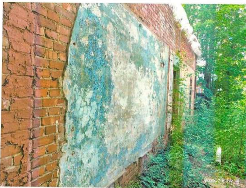
Фото 14. «Дом купца Н.Н. Хомякова, нач. XX в» остатки штукатурного слоя на фасаде здания в месте примыкания с утраченной пристройкой.
