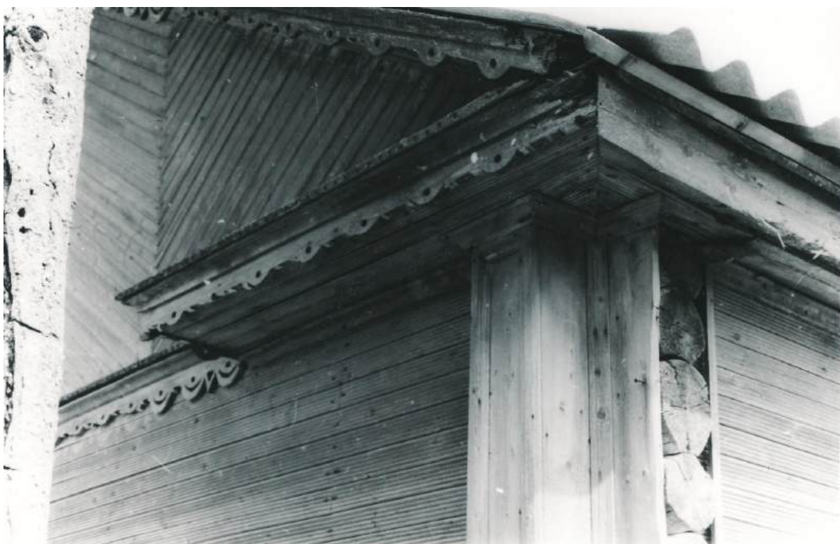
62. Вид части фасада деревянного амбара 18 века, украшенного пропильной резьбой в усадьбе Рерихов. // ЦГАКФФД СПб. Фотодокументы. Опись 1АР-162. Ед.хр.238289. 24 мая 1981 года Автор съёмки: Овчинников К. В.
