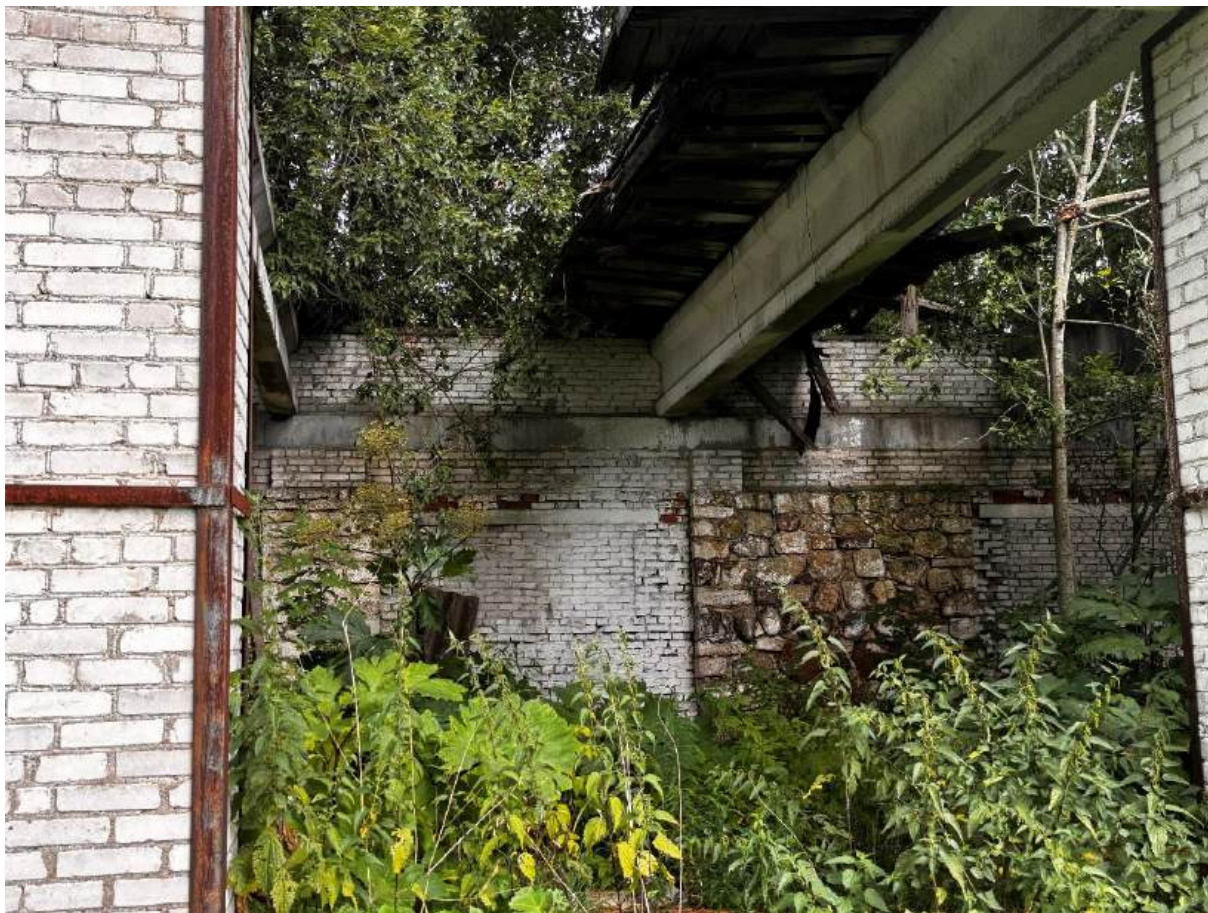
Фото 29. Фрагменты исторической кладки в восточной фасадной стене (вид изнутри).
