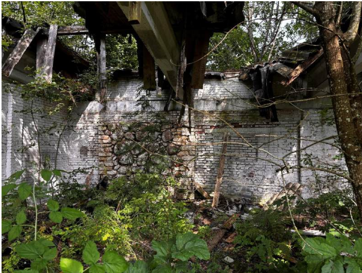
Фото 28. Фрагменты исторической кладки в восточной фасадной стене (вид изнутри).
