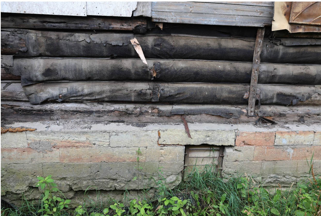
Фото №. 37. Вид на объект в северо-западном направлении; сохранившиеся элементы фасада; каменная кладка подклета, а также утрата части внешней отделки фасада.
