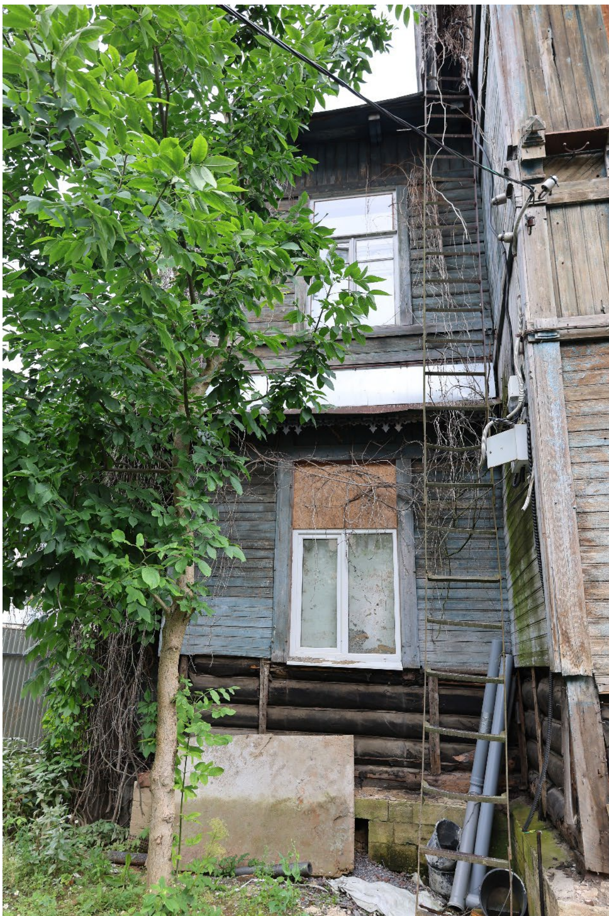
Фото №. 34. Вид на объект в северо-восточном направлении; сохранившиеся элементы фасада; оконный проем и карниз; часть внешней отделки фасада снята.
