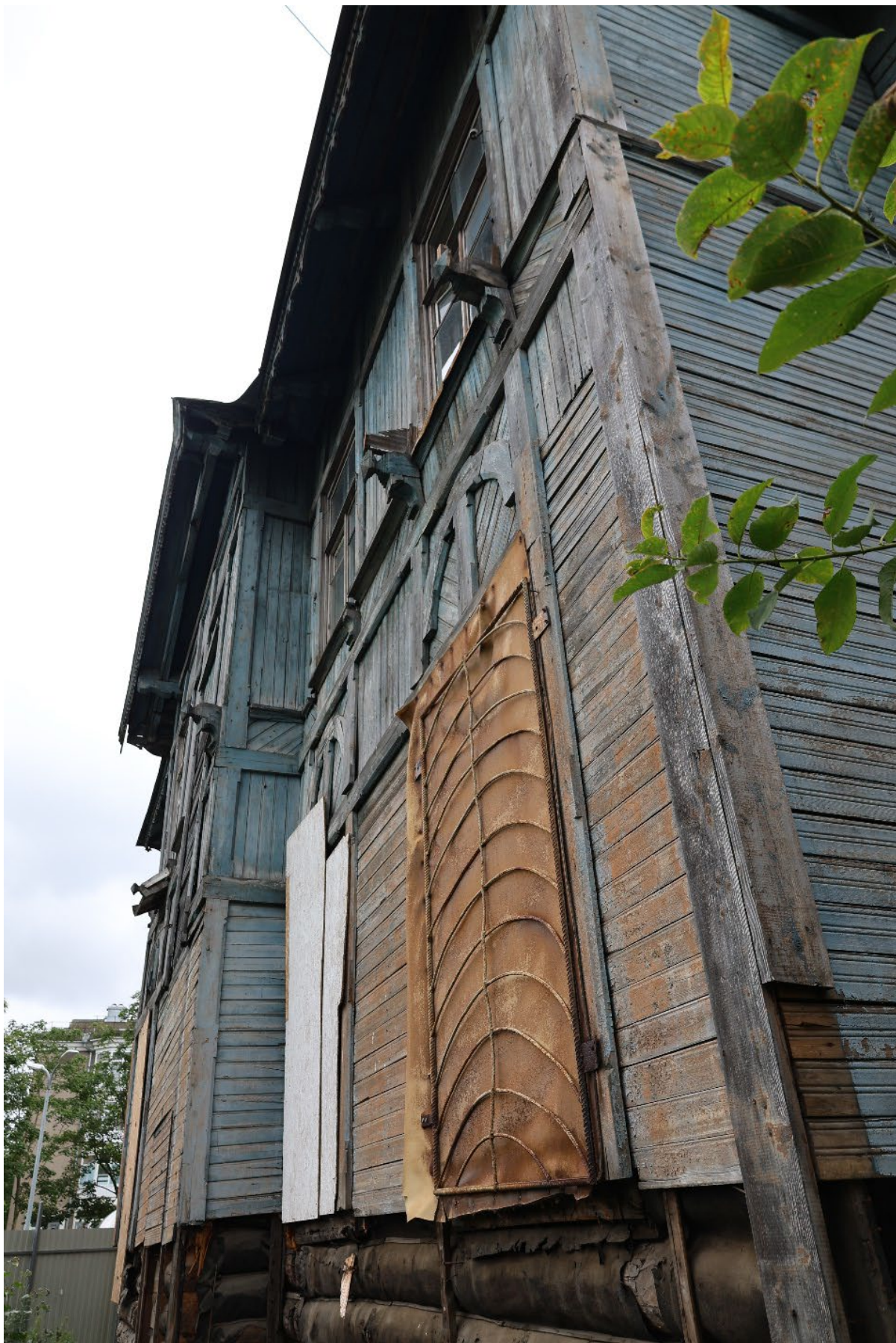
Фото №. 35. Вид на северный фасад здания в северо-западном направлении; сохранившиеся элементы фасада; оконные проемы заложены, часть внешней отделки фасада снято.
