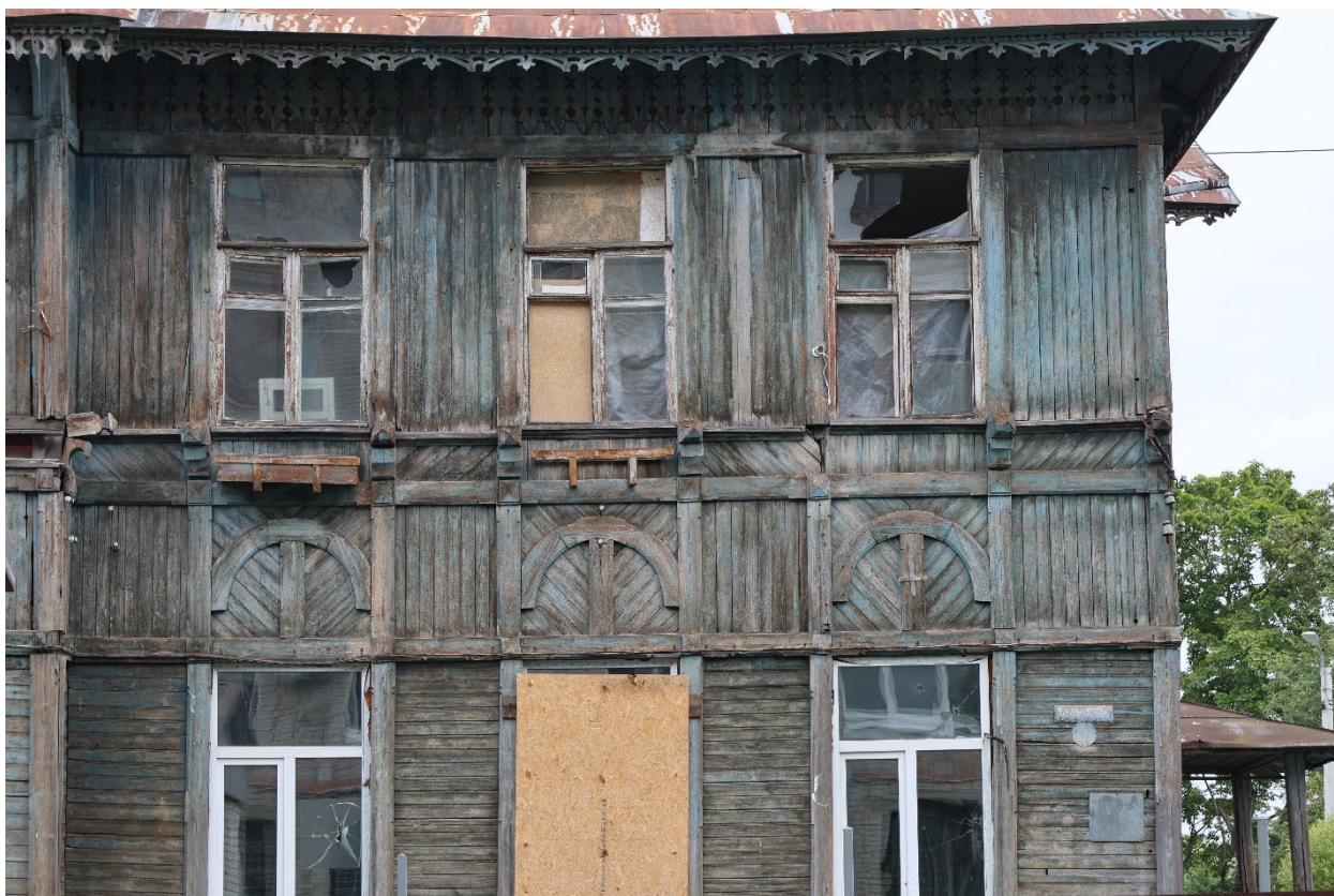
Фото №. 28. Вид восприятия объекта в северо-восточном направлении; сохранившиеся элементы фасада; ряд оконных проемов заложен, два оконных проема первого этажа имеют современный стеклопакет.
