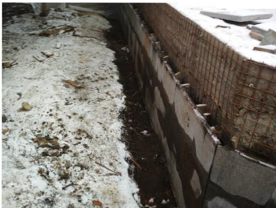
Илл. 13. Монтаж облицовки после ремонта основания и установки арматурной сетки. Фото 2019 г. /Архив Комитета по сохранению культурного наследия Ленинградской области. Д 369/ B24-8.
