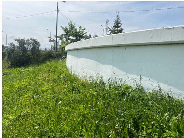
Фото 17 Подпорная стенка. Антропогенные загрязнения, поздние окрасочные наслоения. Дата съемки: июнь 2025. Автор Сидоркина А.А.
