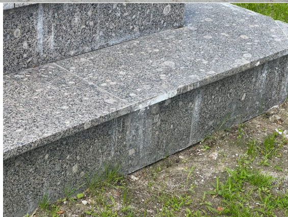
Фото 14 Основание стелы. Высолы, антропогенные загрязнения. Дата съемки: июнь 2025. Автор: Шатунова Л.А.
