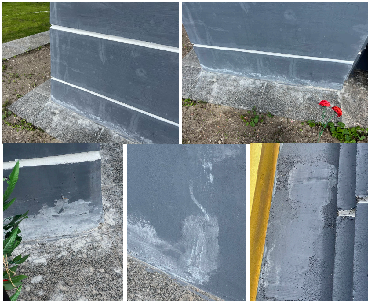
Фото 11 Памятник. Высолы, следы систематического намокания, шелушения красочных слоев. Дата съемки: июнь 2025. Автор: Шатунова Л.А.
