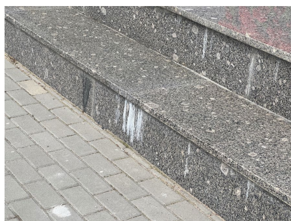
Фото 13 Памятник "Штурм" мемориальный текст. Антропогенные загрязнения, трещина на терразитовой штукатурке, наложение окрасочной и штукатурной отделок на профилированной раме. Дата съемки июнь 2025. Автор: Шатунова Л.А.
