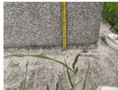
Фото 18 Основание мемориальной плиты. Антропогенные загрязнения, биопоражения. Дата съемки: июнь 2025. Автор: Сидоркина А.А.
