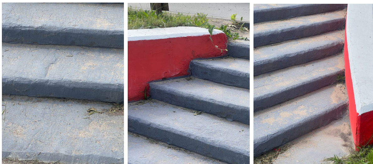
Фото 15 Лестница. Антропогенные загрязнения, поздние окрасочные наслоения. Дата съемки: июнь 2025. Автор Сидоркина А.А.
