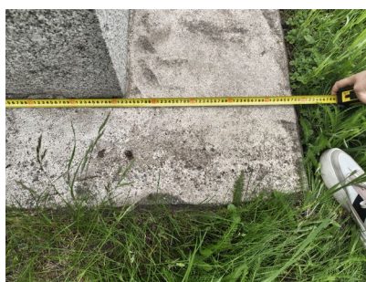
Фото 18 Основание мемориальной плиты. Антропогенные загрязнения, биопоражения. Дата съемки: июнь 2025. Автор: Сидоркина А.А.
