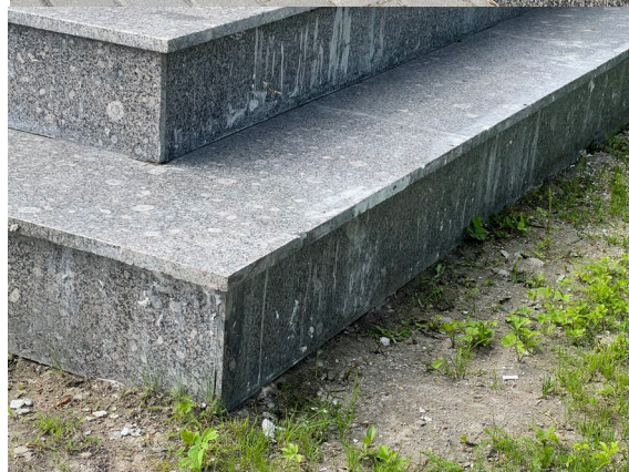
Фото 14 Основание стелы. Высолы, антропогенные загрязнения. Дата съемки: июнь 2025. Автор: Шатунова Л.А.
