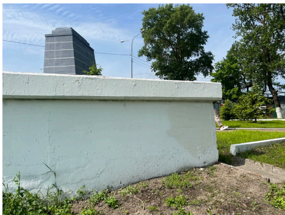
Фото 17 Подпорная стенка. Антропогенные загрязнения, поздние окрасочные наслоения. Дата съемки: июнь 2025. Автор Сидоркина А.А.
