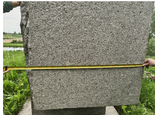
Фото 19 Мемориальная плита. Антропогенные загрязнения, биопоражения. Дата съемки: июнь 2025. Автор: Сидоркина
