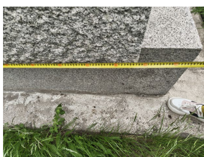
Фото 18 Основание мемориальной плиты. Антропогенные загрязнения, биопоражения. Дата съемки: июнь 2025. Автор: Сидоркина А.А.
