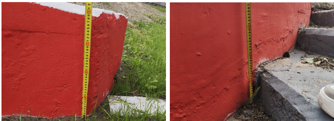
Фото 16 Подпорная стенка. Антропогенные загрязнения, поздние окрасочные наслоения, отклонения от вертикали. Дата съемки: июнь 2025. Автор Сидоркина А.А.
