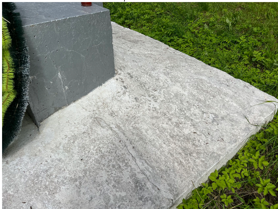
Фото 34. Вид на монумент. Следы поздних ремонтов основания монумента. Дата съемки: июнь 2025. Автор: Козлова Е.М.
