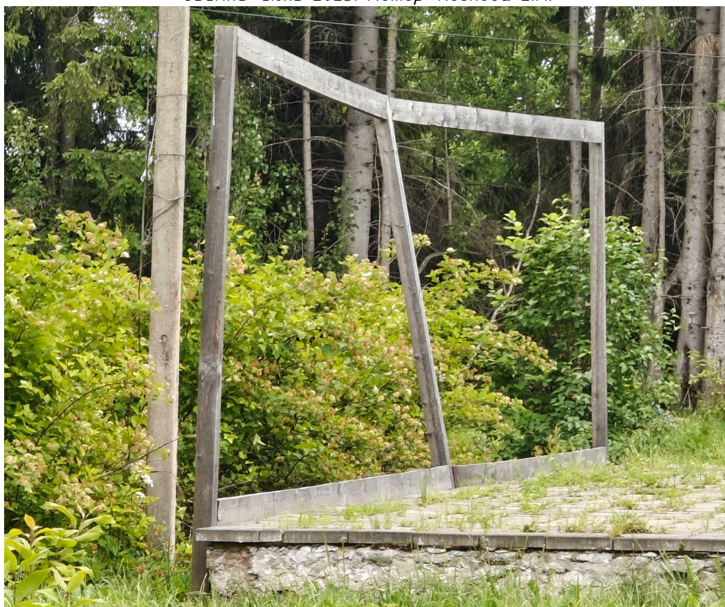
Фото 41. Вид на сцену. Крен деревянных досок. Дата съемки: июнь 2025. Автор: Козлова Е.М.
