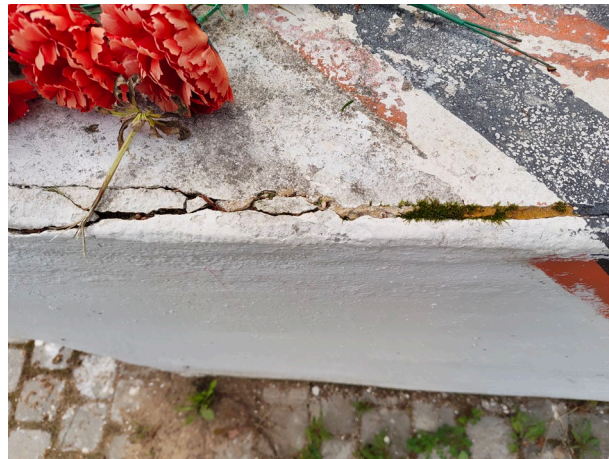
Фото 28. Вид на памятник «Автомашина ЗИС-5». Трещины в штукатурном и красочном слоях. Дата съемки: июнь 2025. Автор: Шатунова Л.А.
