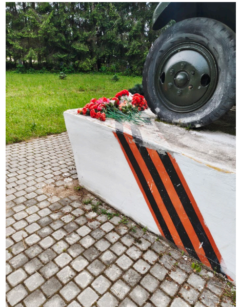
Фото 25. Вид на памятник «Автомашина ЗИС-5». Следы шелушения красочного слоя. Дата съемки: июнь 2025. Автор: Шатунова Л.А.
