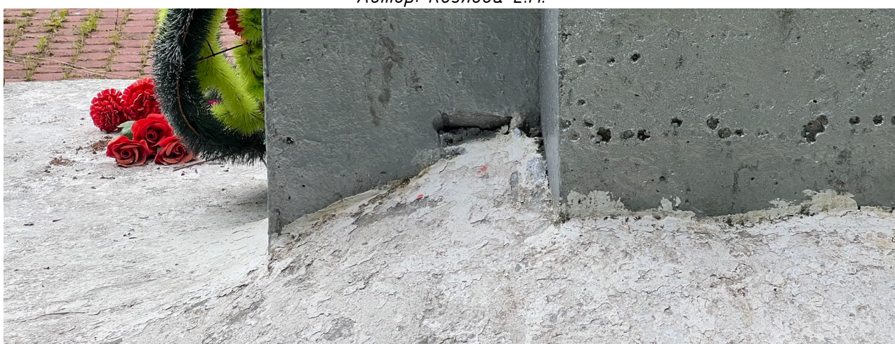
Фото 36. Вид на монумент. Следы механических повреждений монумента. Дата съемки: июнь 2025. Автор: Козлова Е.М.
