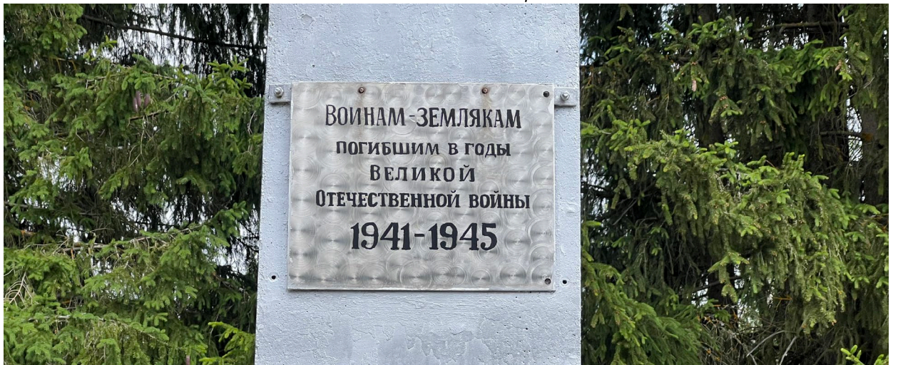
Фото 38. Вид на монумент. Следы антропогенных загрязнений, коррозии металла, шелушения красочного слоя памятной надписи металлической таблички. Дата съемки: июнь 2025. Автор: Козлова Е.М.
