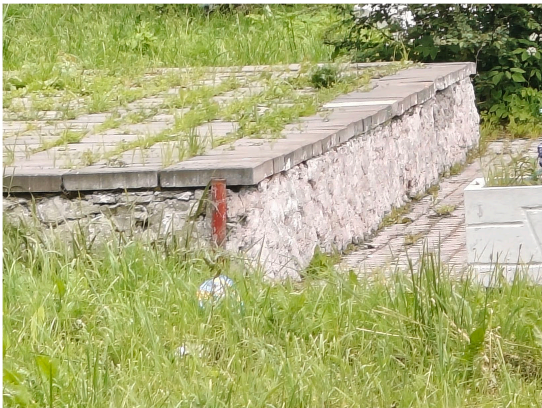
Фото 40. Вид на сцену. Следы антропогенных загрязнений, механических повреждений, биопоражений, поздних ремонтов, отслоения красочного и штукатурного слоев. Дата съемки: июнь 2025. Автор: Козлова Е.М.
