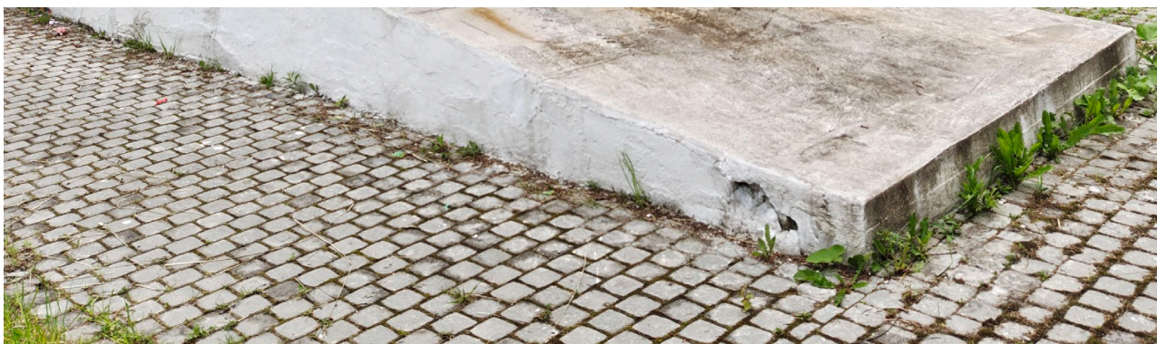
Фото 29. Вид на памятник «Автомашина ЗИС-5». Механические повреждения железобетонной конструкции постамента. Дата съемки: июнь 2025. Автор: Шатунова Л.А.
