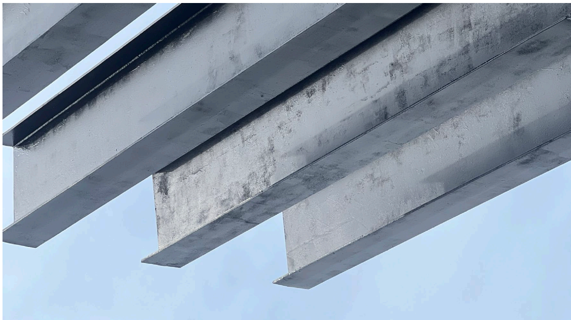
Фото 15. Фрагмент металлических двутавров, вид с юга. Наблюдаются множественные красочные наслоения. Дата съемки: июль 2025 г. Автор: Шатунова Л.А.
