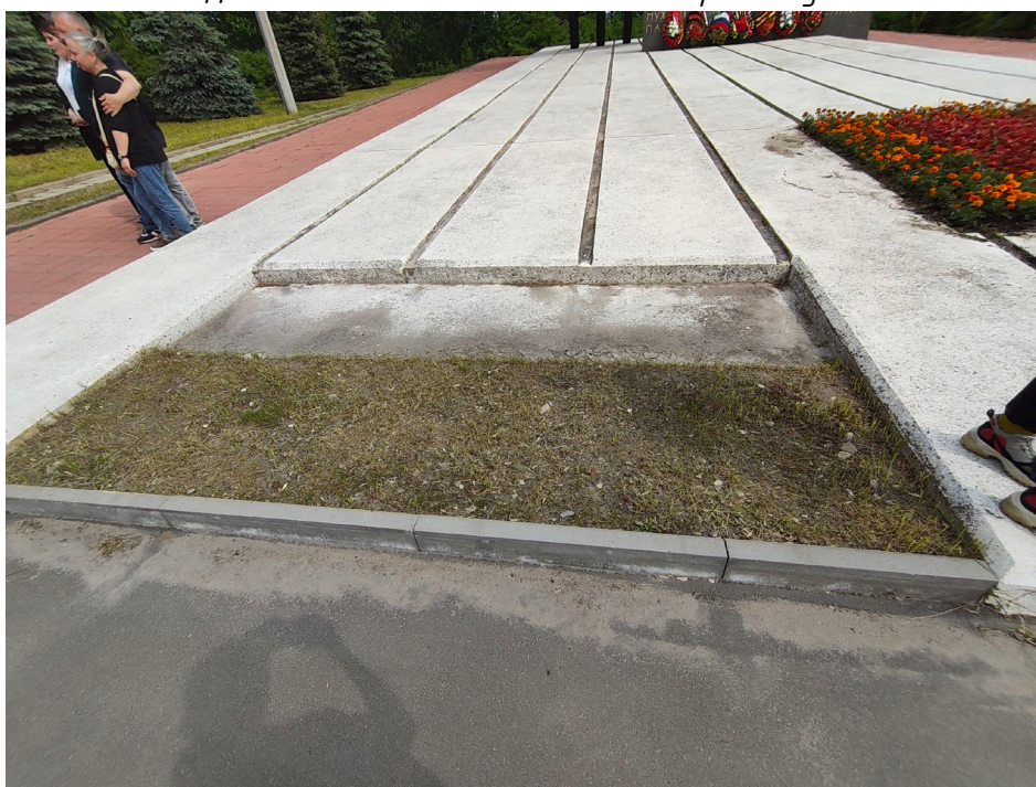
Фото 6. Ступени стилобата, вид с запада. На месте первой ступени клумба с проплешинами, потемнениями. На второй ступени следы замачивания, мелкие сколы и локальные утраты верхнего слоя бетона. Дата съемки: июль 2025 г. Автор: Шатунова Л.А.
