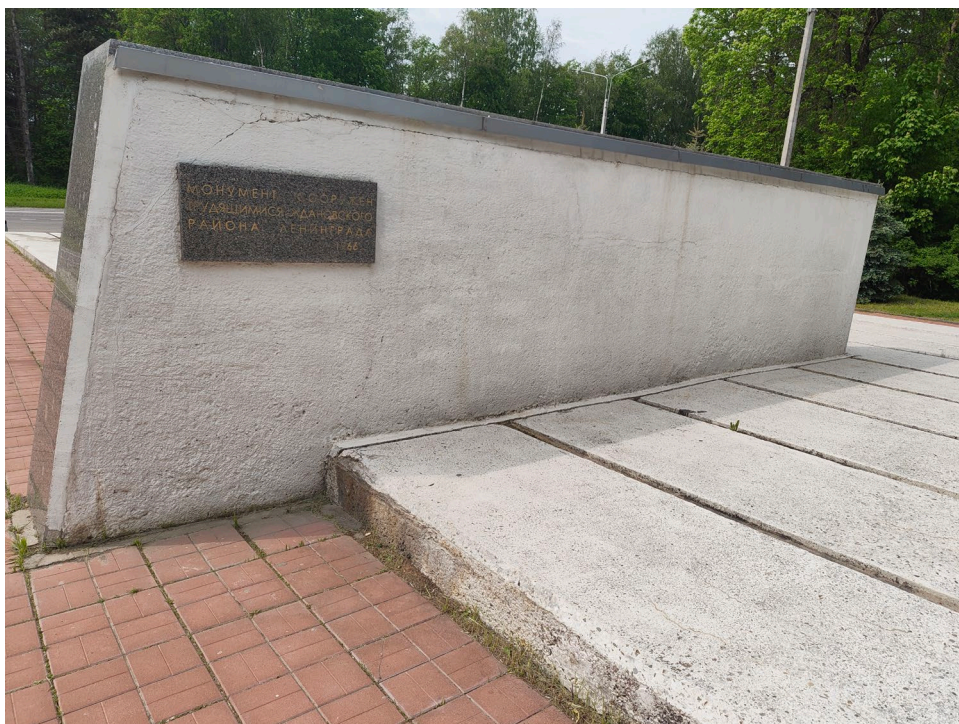
Фото 5. Обратная сторона мемориальной плиты с табличкой. Плита оштукатурена и побелена. Заметны трещины в отделке, локальные утраты штукатурки у основания плиты, подтеки Дата съемки: июль 2025 г. Автор: Шатунова Л.А.
