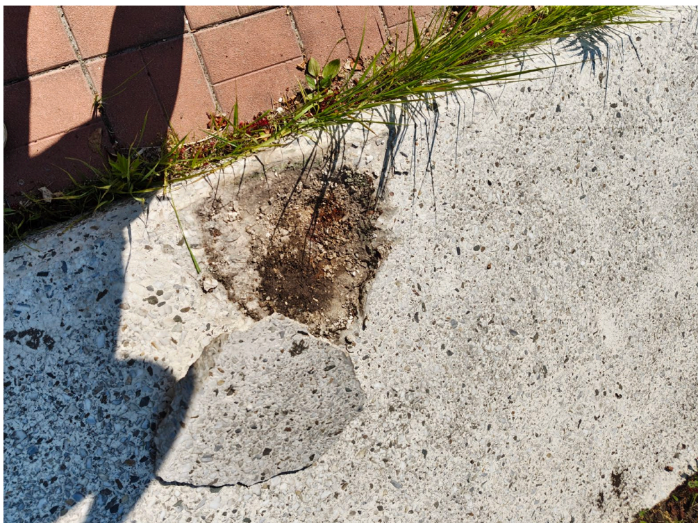
Фото 7. Фрагмент бетонной плиты стилобата с покрытием «терраццо» (с юга). Крупная скол в плите. Дата съемки: июль 2025 г. Автор: Шатунова Л.А.
