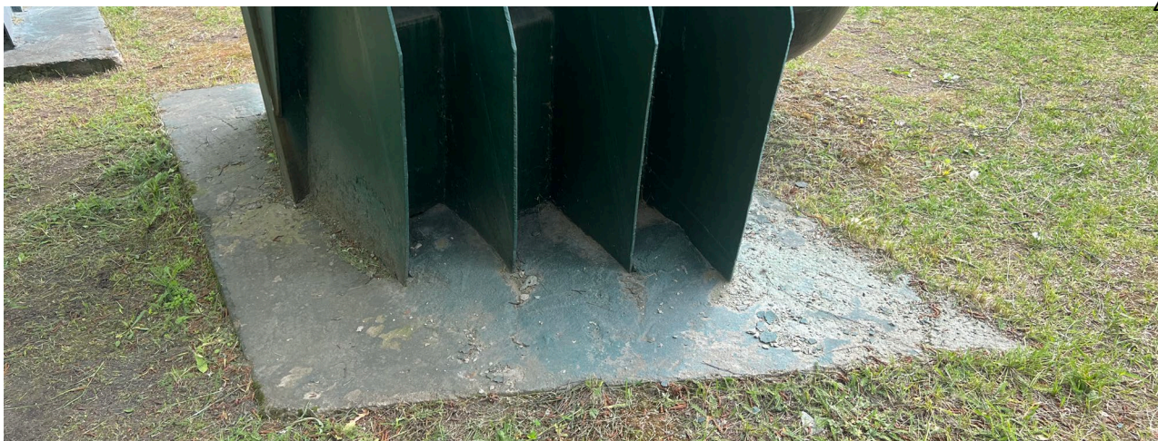
Фото 25. Вид на дубовый лист. Следы дипоражений на железобетонном основании. Дата съемки: июнь 2025. Автор: Шатунова Л.А.
