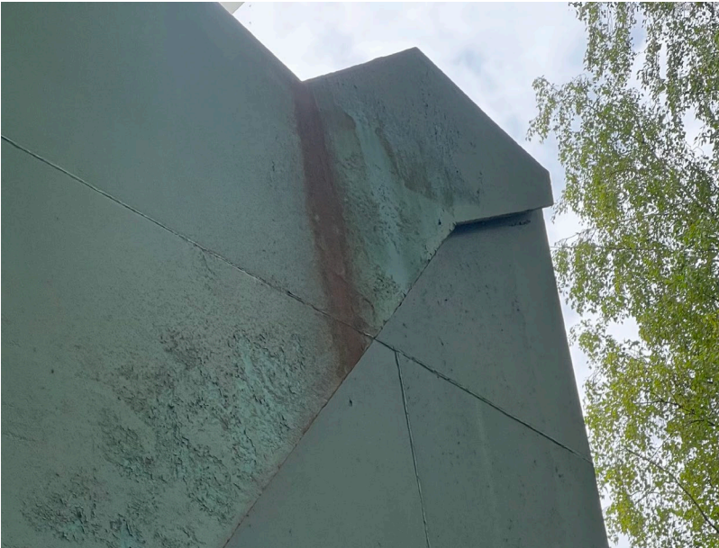
Фото 27. Вид на дубовый лист. Следы коррозии металла. Дата съемки: июнь 2025. Автор: Шатунова Л.А.
