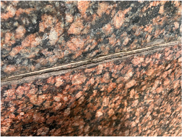
Фото 32. Вид на мемориальную плиту. Выветривание шовного раствора. Дата съемки: июнь 2025. Автор: Шатунова Л.А.
