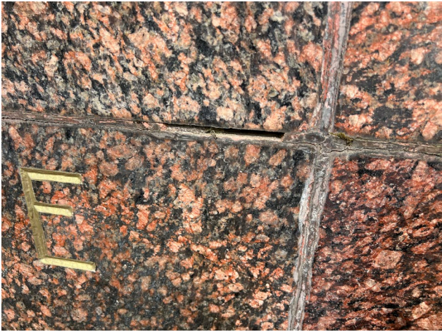
Фото 32. Вид на мемориальную плиту. Выветривание шовного раствора. Дата съемки: июнь 2025. Автор: Шатунова Л.А.
