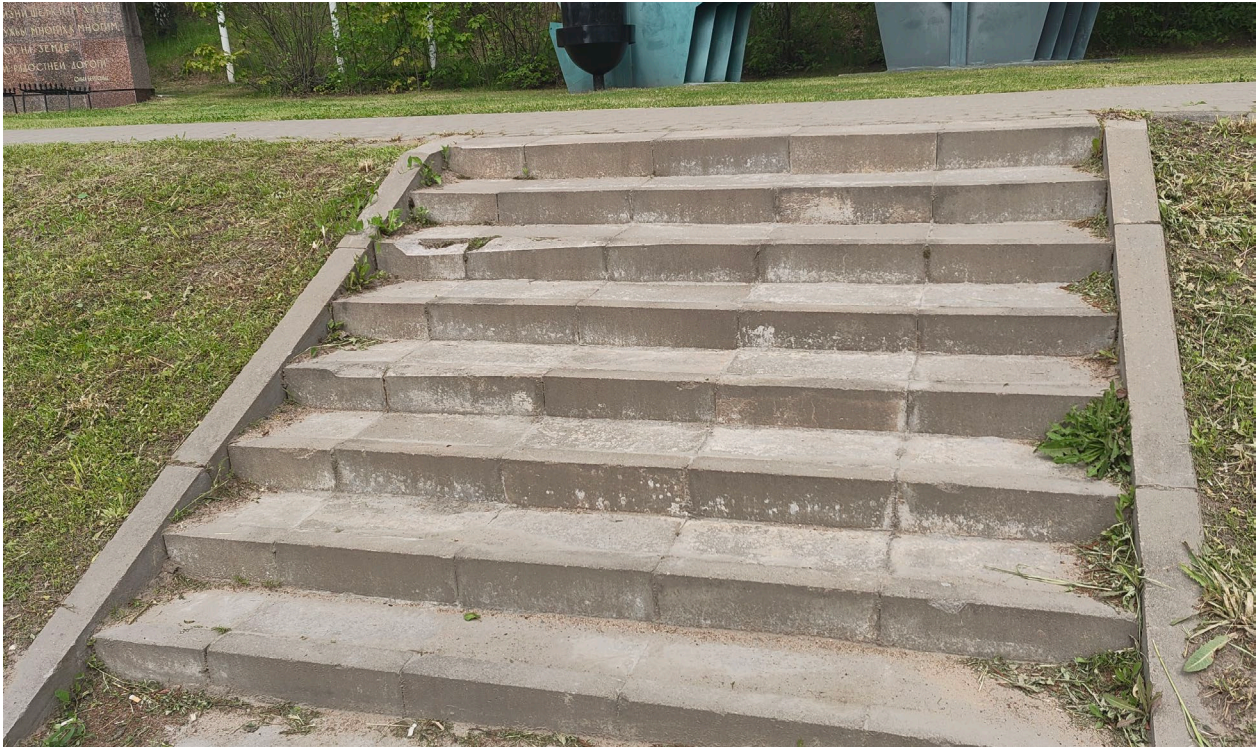
Фото 37. Вид на восточную лестницу. Следы антропогенных загрязнений, выветривание шовного раствора, высолы. Дата съемки: июнь 2025. Автор: Шатунова Л.А.
