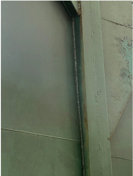
Фото 27. Вид на дубовый лист. Следы коррозии металла. Дата съемки: июнь 2025. Автор: Шатунова Л.А.
