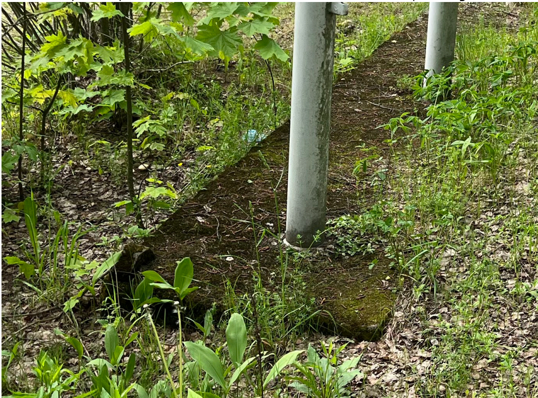
Фото 40. Вид на флагштоки. Следы биопоражений, сколы железобетонного основания, следы коррозии металла трубы флагштока. Дата съемки: июнь 2025. Автор: Шатунова Л.А.
