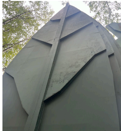
Фото 21. Вид на лавровый лист. Следы шелушения красочного слоя на металле и основании. Дата съемки: июнь 2025. Автор: Шатунова Л.А.
