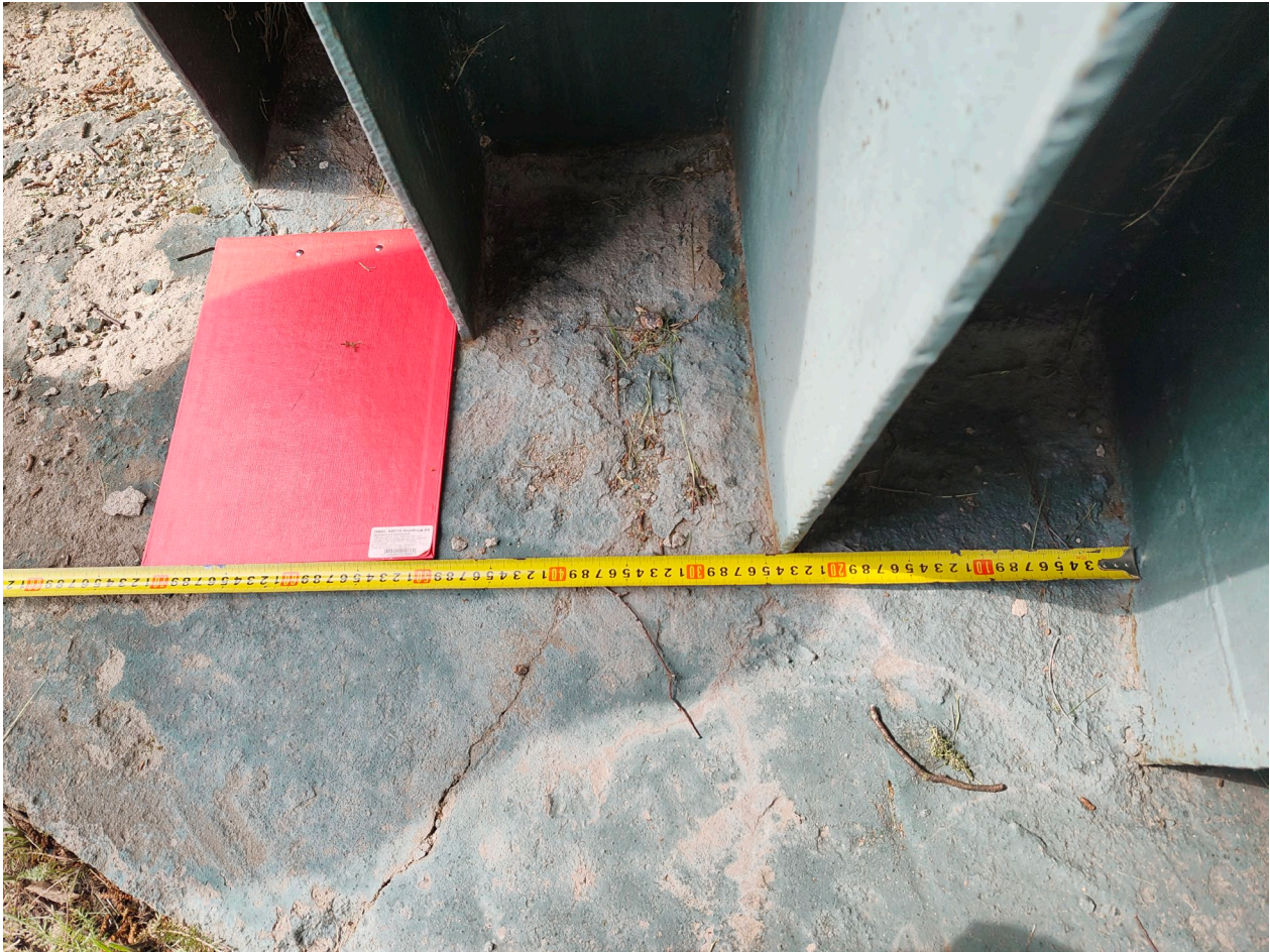
Фото 28. Вид на дубовый лист. Трещина на железобетонном основании. Дата съемки: июнь 2025. Автор: Шатунова Л.А.
