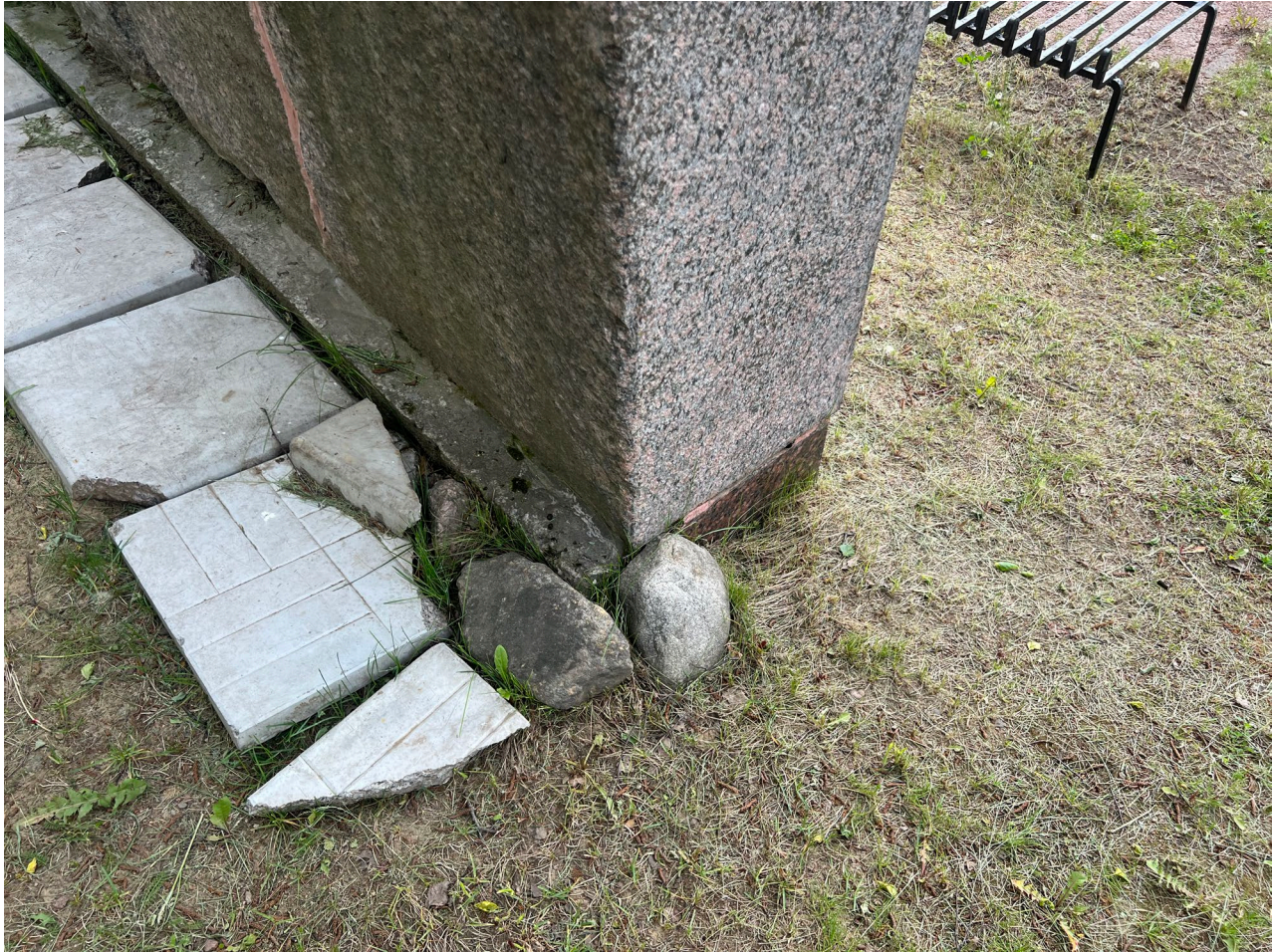
Фото 36. Вид на мемориальную плиту. Многочисленные сколы тротуарной плитки отмостки. Дата съемки: июнь 2025. Автор: Шатунова Л.А.
