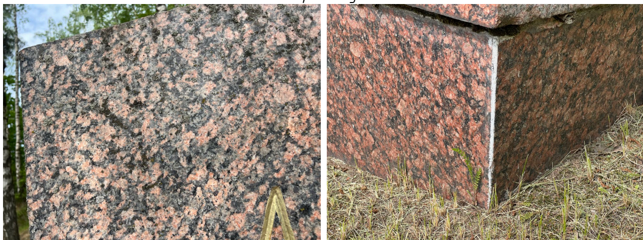
Фото 34. Вид на мемориальную плиту. Следы биопоражений. Дата съемки: июнь 2025. Автор: Шатунова Л.А.
