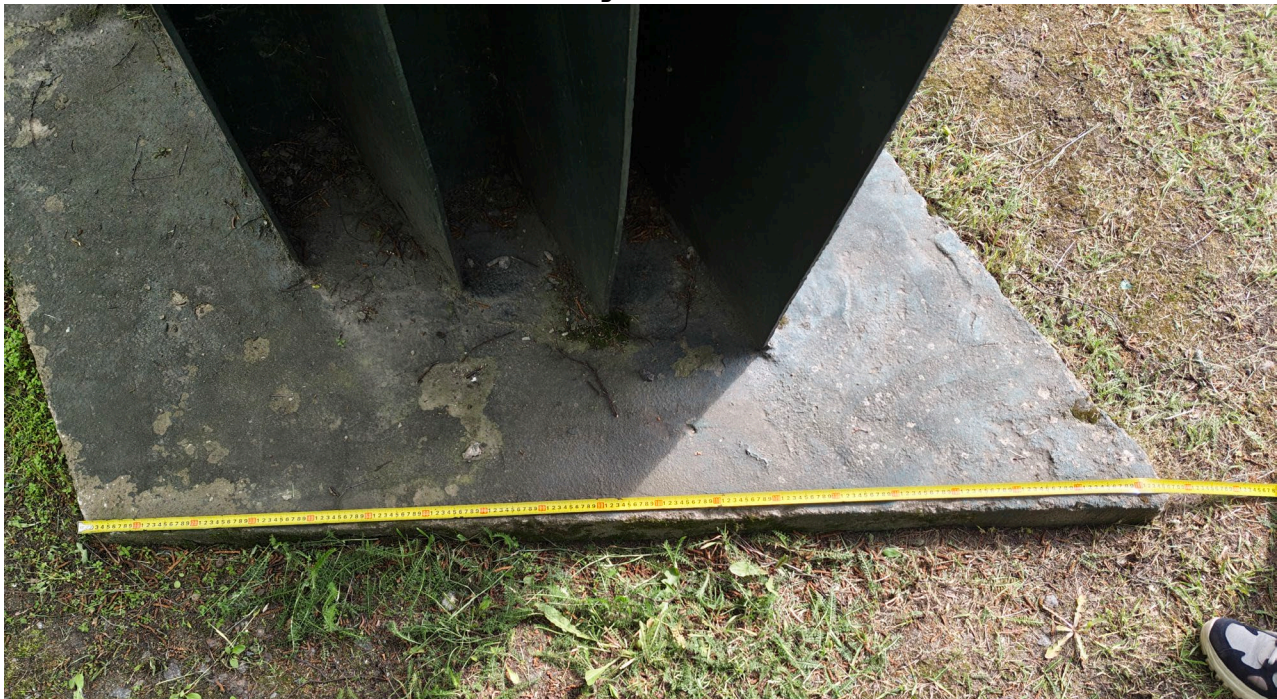
Фото 23. Вид на лавровый лист. Мелкие сколы железобетонного основания. Дата съемки: июнь 2025. Автор: Шатунова Л.А.
