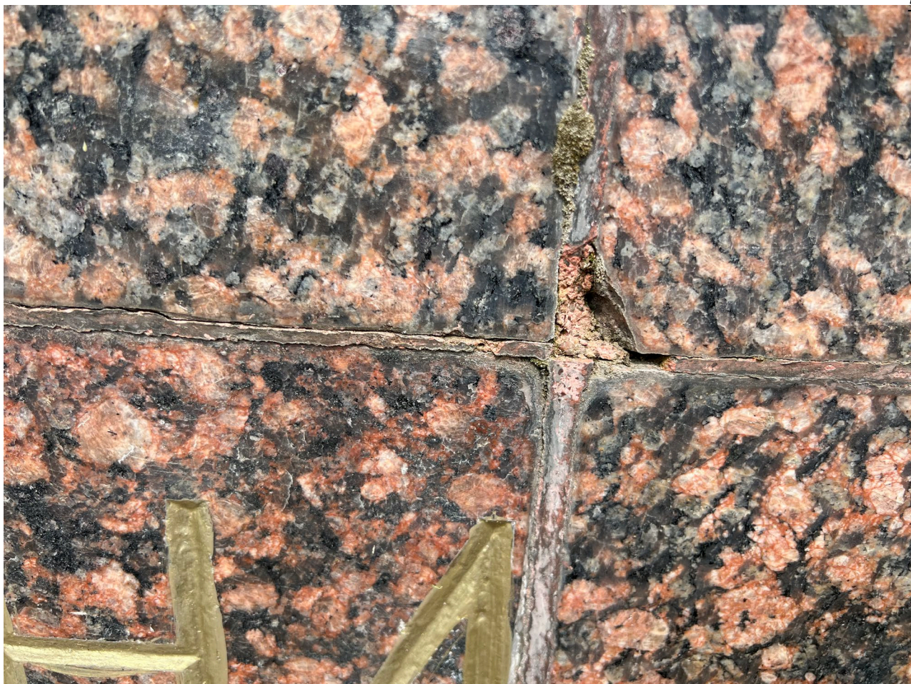
Фото 33. Вид на мемориальную плиту. Мелкие сколы гранитного блока. Дата съемки: июнь 2025. Автор: Шатунова Л.А.
