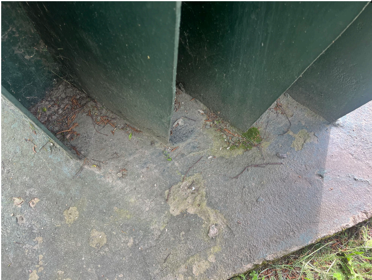
Фото 20. Вид на лавровый лист. Следы биопоражений на железобетонном основании. Дата съемки: июнь 2025. Автор: Шатунова Л.А.
