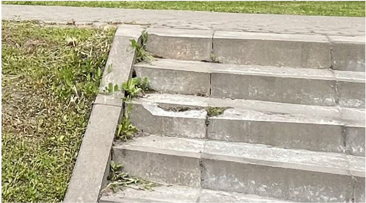
Фото 38. Вид на восточную лестницу. Сколы бетонных бордюров. Дата съемки: июнь 2025. Автор: Шатунова Л.А.
