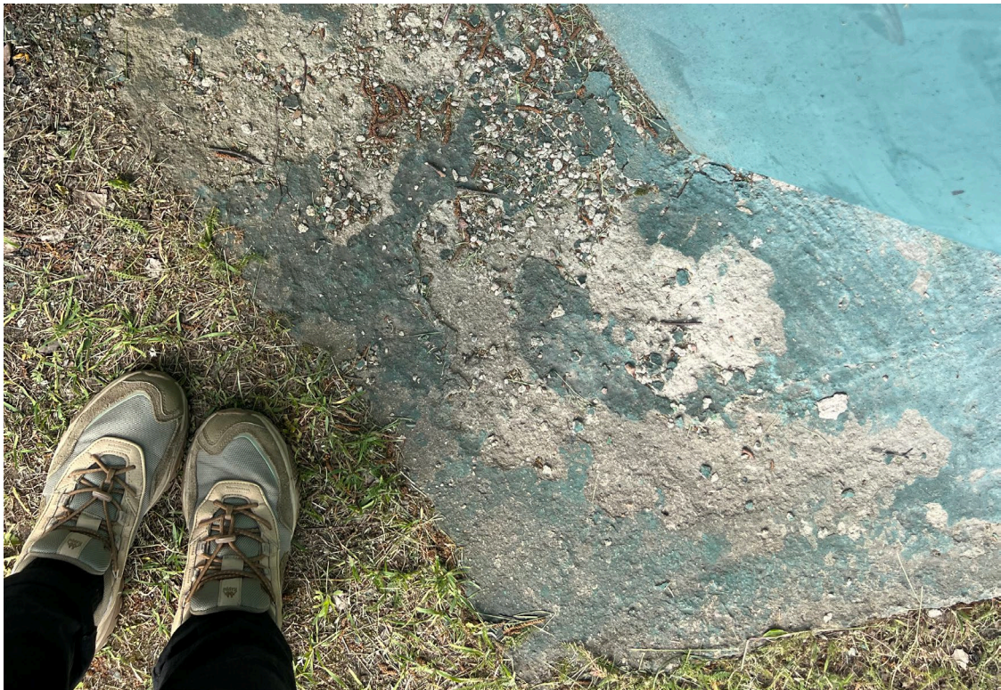
Фото 29. Вид на дубовый лист. Мелкие сколы железобетонного основания. Дата съемки: июнь 2025. Автор: Шатунова Л.А.
