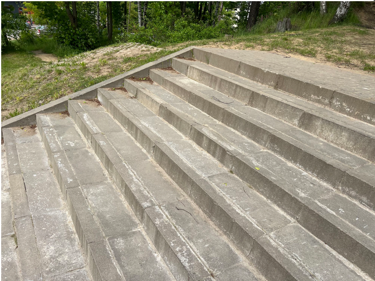
Фото 39. Вид на западную лестницу. Следы антропогенных загрязнений, выветривание шовного раствора, высолы. Дата съемки: июнь 2025. Автор: Шатунова Л.А.
