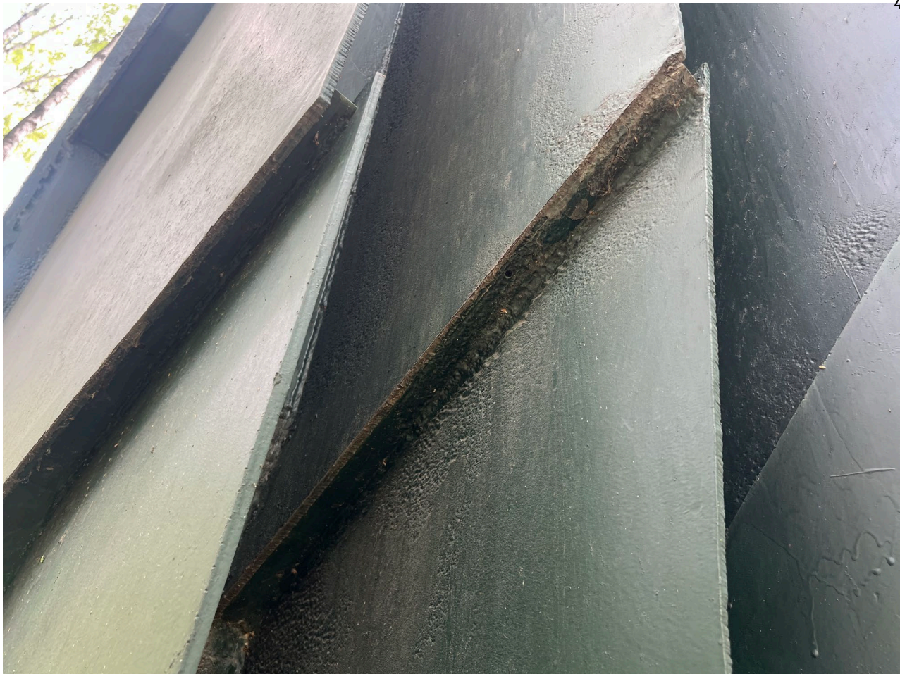
Фото 22. Вид на лавровый лист. Следы коррозии металла. Дата съемки: июнь 2025. Автор: Шатунова Л.А.
