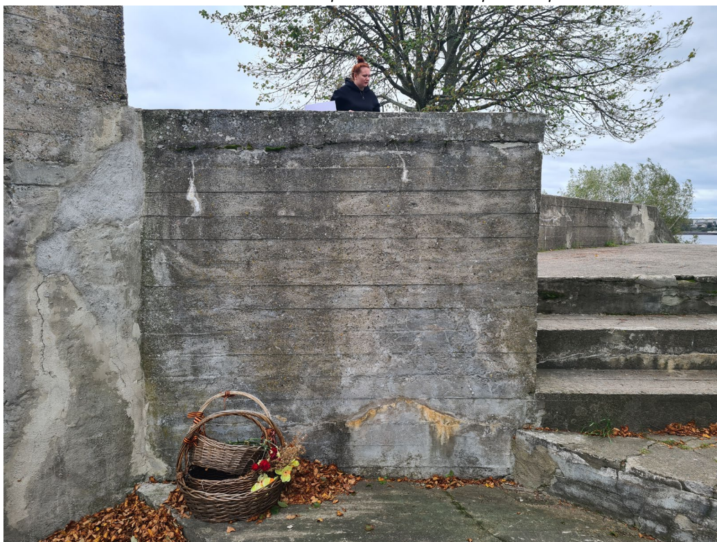
Фото 2.6. Угол северной и северо-восточной стен первой смотровой площадки. Горизонтальные и вертикальные трещины в стенах, шириной раскрытия более 3 мм; заделаны поздними цементными составами. Присутствуют грязевые и ржавые подтеки, биопоражения, высолы. Дата съемки: сентябрь 2025 г. Автор: Ведерникова В.В.
