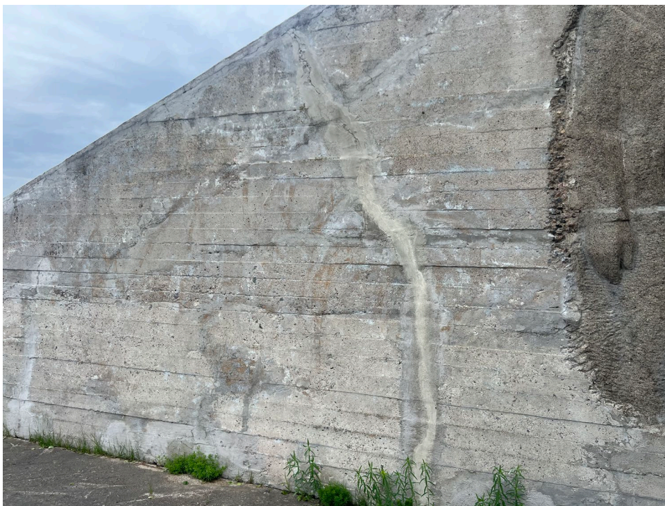
Фото 2.3. Северо-восточная стена на первой смотровой площадке. Вертикальные и горизонтальные трещины в стене, заделанные цементными растворами разных оттенков и толщины слоя. Присутствуют грязевые подтеки, сетки мелких трещин; поверхность бетона в раковинах и высолах. Дата съемки: сентябрь 2025 г. Автор: Ведерникова В.В.
