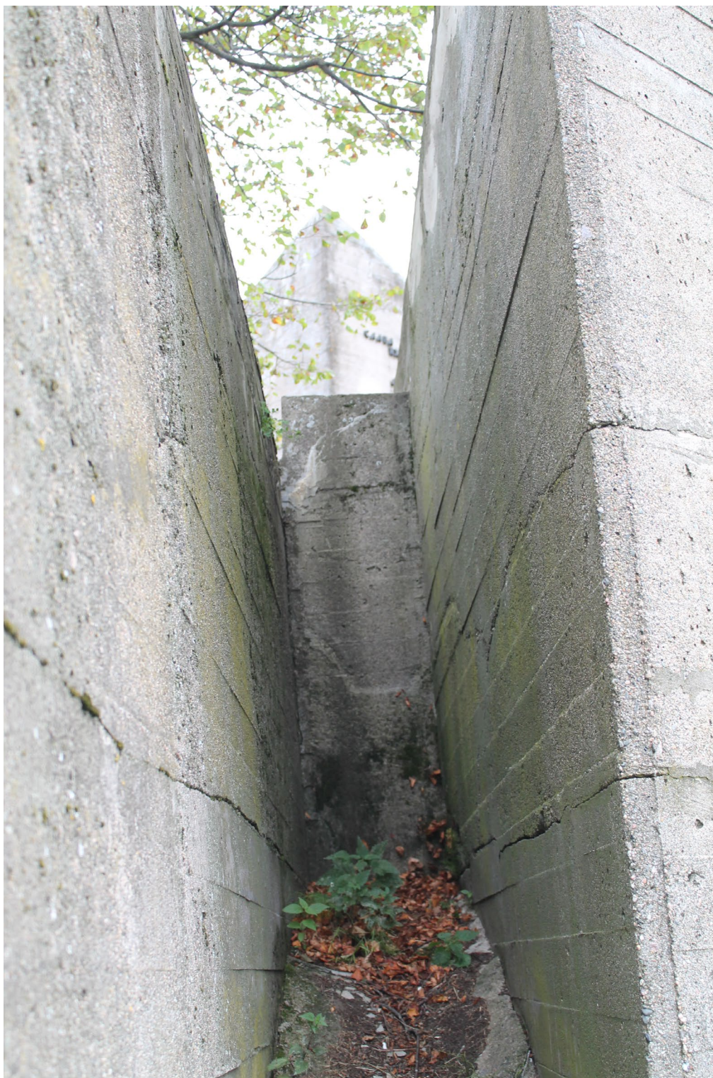
Фото 2.11. Участок между стенами второй и третьей смотровых площадок. Трещины в бетоне, шириной раскрытия более 3 мм, вдоль опалубки. Поверхность имеет биопоражения, пылевые загрязнения, раковины. По земле залита бетонная подливка с уклоном для стока воды. Засорена сухой листвой, поросла самосевом, на поверхности также присутствуют биопоражения и следы систематического намокания. Дата съемки: сентябрь 2025 г. Автор: Ведерникова В.В.
