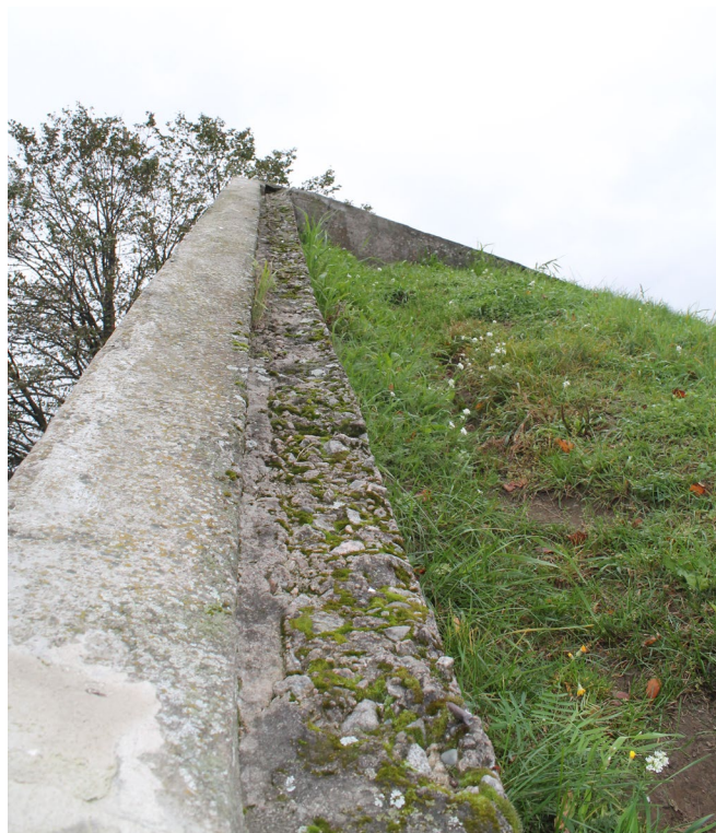
Фото 2.7. Фрагмент верхней грани южной стены на первой смотровой площадке. Поверхность бетона деструктивирована, имеет раковины, оголение крупного заполнителя, биопоражение и порастание мхом. Дата съемки: сентябрь 2025 г. Автор: Ведерникова В.В.
