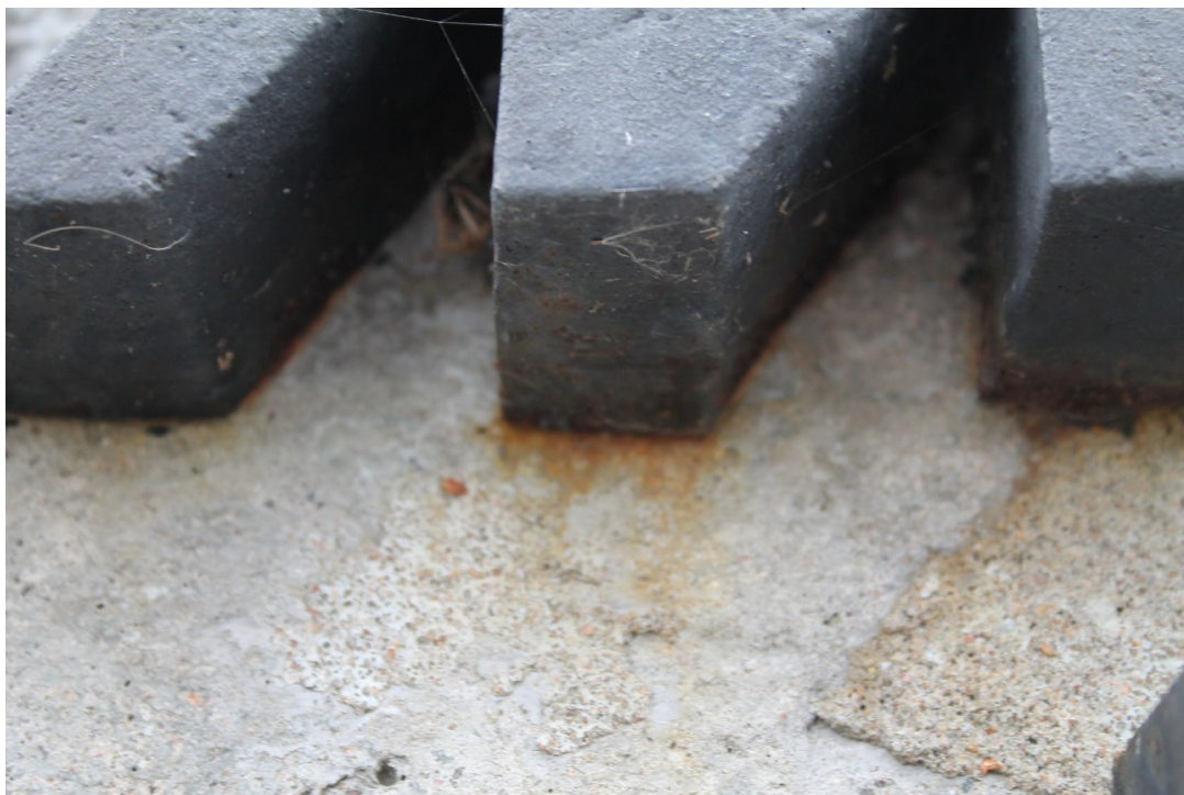
Фото 2.21. Фрагмент надписи на стене четвертой смотровой площадки. Подтеки ржавчины в местах примыкания металлических букв и бетонной поверхности. Дата съемки: сентябрь 2025 г. Автор: Ведерникова В.В.
