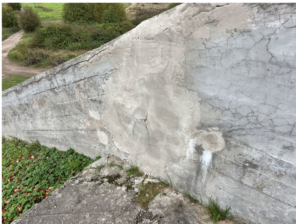
Фото 2.4. Фрагмент северо-восточной стены на первой смотровой площадке. Вспучивание поздней цементной домасチックовки, трещина вдоль верхней кромки стены, шириной раскрытия более 5 мм. Растрескивание бетонного покрытия, биопоражение и порастание самосевом; потемнение бетонного покрытия. Дата съемки: сентябрь 2025 г. Автор: Ведерникова В.В.
