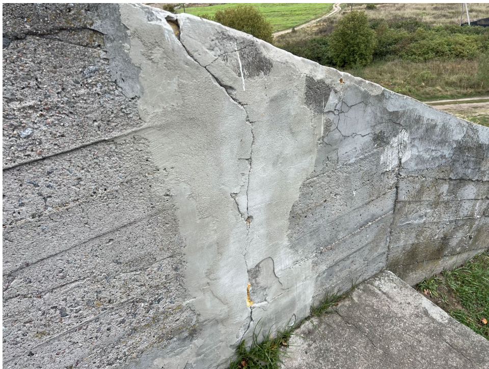
Фото 2.23. Фрагмент северо-западной стены-ребра четвертой смотровой площадки. Крупная вертикальная трещина в стене и трещина вдоль верхней грани заделаны цементными составами разных цветов. В месте сквозного разрыва вертикальная трещина заделана монтажной пеной. На поверхности бетона также присутствуют раковины, выступает крупный заполнитель. Дата съемки: сентябрь 2025 г. Автор: Ведерникова В.В.
