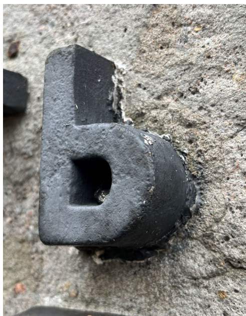
Фото 2.19 (слева) и 2.20 (справа). Буквы из надписи на стене четвертой смотровой площадки. Буквы металлические поздние; окрашены в несколько слоев черной краской. Красочное покрытие неравномерное с кратерами, имеет плохое отверждение, из-за чего на поверхности остаются следы кисти, а краска легко соскабливается. Дата съемки: сентябрь 2025 г. Автор: Ведерникова В.В.
