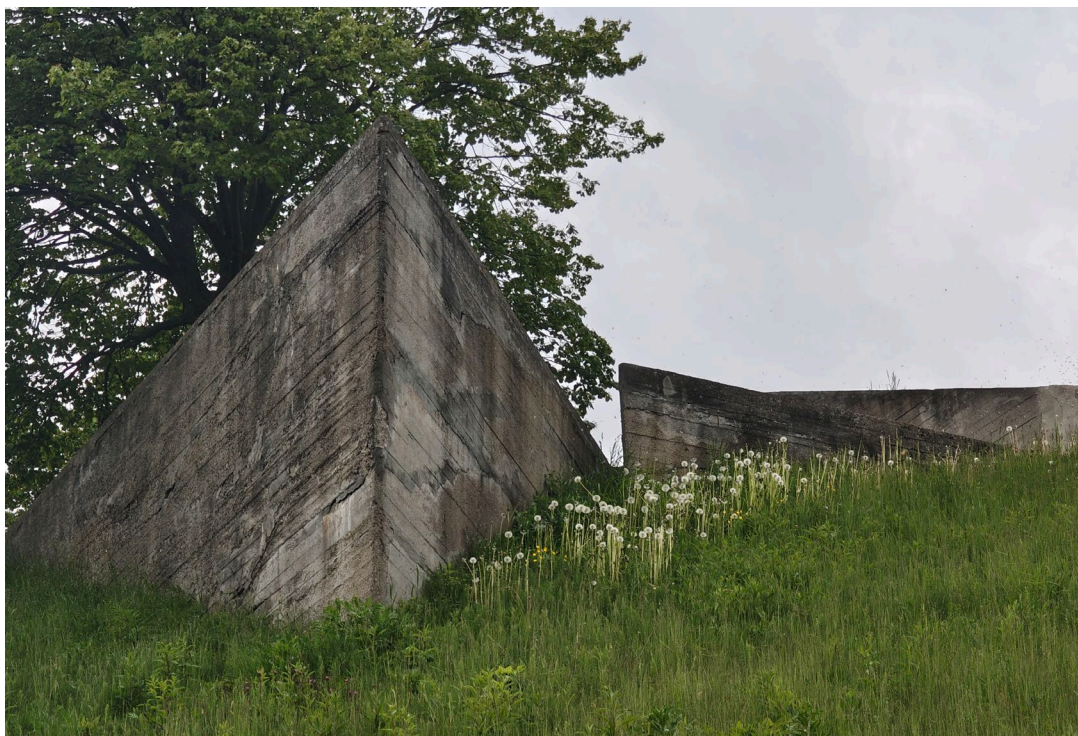
Фото 2.26. Внешние стенки второй смотровой площадки. Поверхность бетона сильно загрязнена, неоднородна по цвету, имеет продольные трещины и деструкцию защитного слоя бетона. Дата съемки: сентябрь 2025 г. Автор: Ведерникова В.В.
