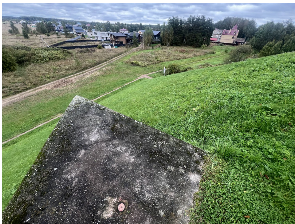
Фото 2.24. Небольшого бетонного уступа на северной грани пирамиды. Поверхность бетона сильно загрязнена, поражена мхами и плесенью, наблюдаются сетка мелких трещин, сколы по ребрам и высолы на поверхности. Дата съемки: сентябрь 2025 г. Автор: Ведерникова В.В.
