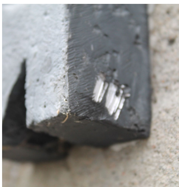
Фото 2.19 (слева) и 2.20 (справа). Буквы из надписи на стене четвертой смотровой площадки. Буквы металлические поздние; окрашены в несколько слоев черной краской. Красочное покрытие неравномерное с кратерами, имеет плохое отверждение, из-за чего на поверхности остаются следы кисти, а краска легко соскабливается. Дата съемки: сентябрь 2025 г. Автор: Ведерникова В.В.
