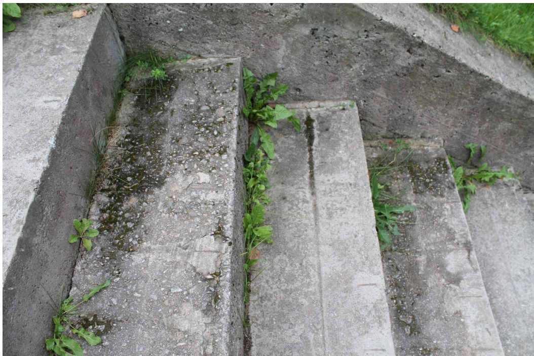
Фото 2.29. Фрагмент главной лестницы: ступени в верхней части марша. Деструкция защитного слоя бетона с оголением корродированной арматуры, биопоражения на поверхности бетона, порастание самосевом. Расхождение сопряжения деталей и образование щелей. На поверхности подпорной стенки присутствуют раковины, биопоражения и высолы. Дата съемки: сентябрь 2025 г. Автор: Ведерникова В.В.
