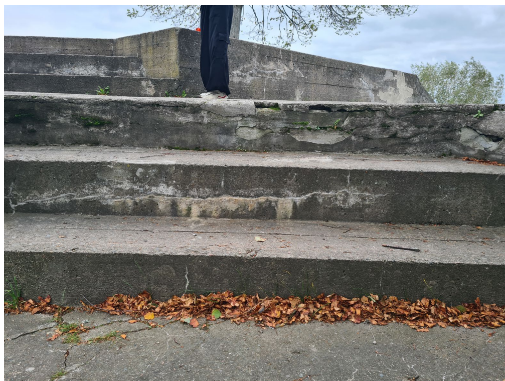
Фото 2.8. Фрагмент лестницы на третью смотровую площадку. Деструкция и отслоение защитного слоя бетона, горизонтальные трещины, потемнение поверхности. Присутствуют поздние цементные домастиковки, порастание трещин самосевом, высолы. Дата съемки: сентябрь 2025 г. Автор: Ведерникова В.В.
