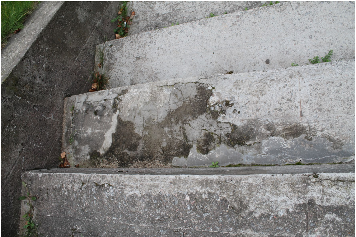
Фото 2.28. Фрагмент главной лестницы: ступени в средней части марша. Растрескивание и истощение защитного слоя бетона с оголением арматуры. Поверхностные биопоражения, сколы на ребрах ступеней. Поздние цементные домаestikовки в швах, трещинах и на ребрах ступеней, порастание самосевом Дата съемки: сентябрь 2025 г. Автор: Ведерникова В.В.
