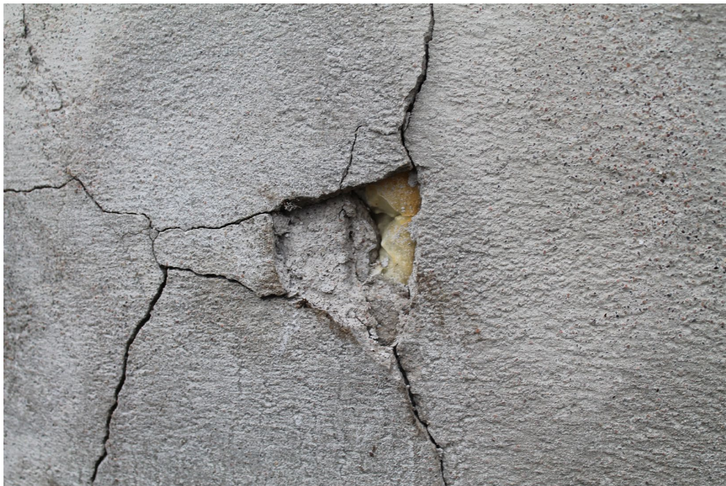
Фото 2.5. Фрагмент домастиковочного слоя северной стены на первой смотровой площадке. Вспучивание поздней цементной домастиковки поверх сквозной трещины в стене; трещина заполнена монтажной пеной.
