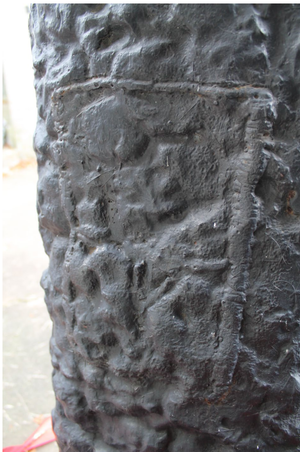
Фото 2.33 (слева). Фрагмент ствола бронзовой скульптуры. Прямоугольная металлическая заплатка с толстым сварным швом в нижней части ствола. Дата съемки: сентябрь 2025 г. Автор: Ведерникова В.В.
