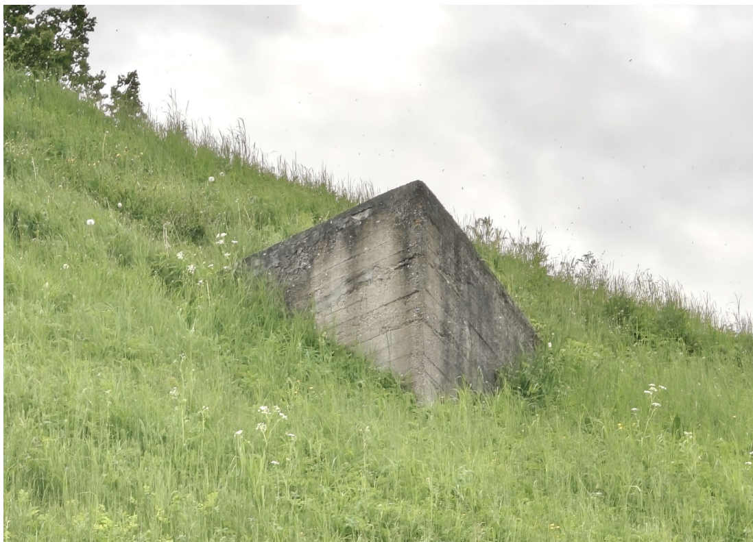
Фото 2.25. Стенки небольшого бетонного уступа на северной грани пирамиды. Поверхность бетона сильно загрязнена, имеет биопоражения и продольные трещины. Дата съемки: сентябрь 2025 г. Автор: Ведерникова В.В.
