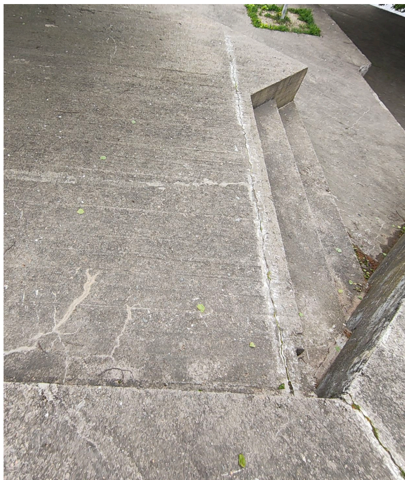
Фото 2.16. Фрагмент четвертой смотровой площадки. Вдоль лестничного марша крупная трещина. Растрескивание защитного слоя бетона. Дата съемки: сентябрь 2025 г. Автор: Ведерникова В.В.
