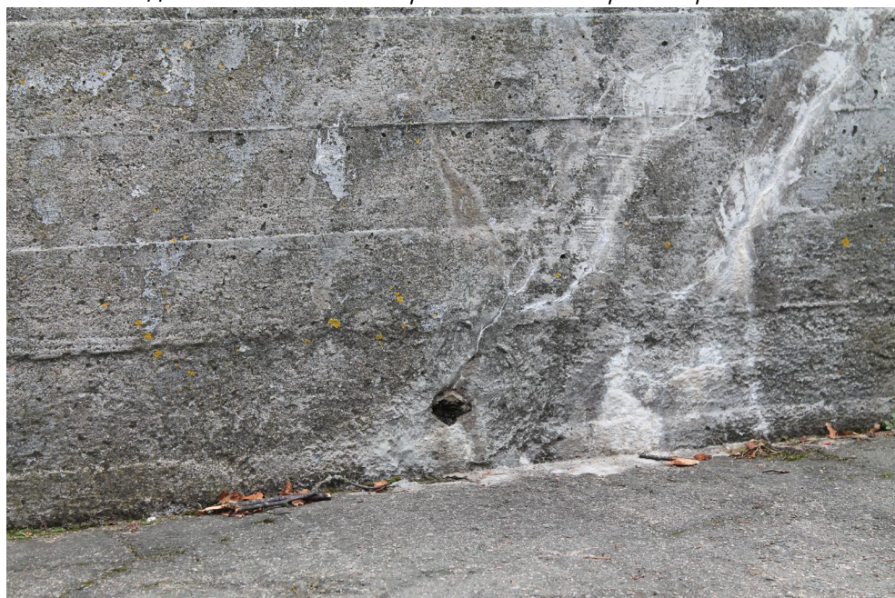
Фото 2.17. Фрагмент стенки четвертой смотровой площадки. Заделка трещин в бетоне цементным молочком. Также на поверхности присутствуют биопоражения, пылевые загрязнения и подтеки цементного молочка. Дата съемки: сентябрь 2025 г. Автор: Ведерникова В.В.
